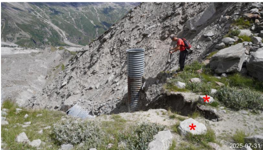
Figura 77 – Arretramento dell'orlo della scarpata di frana che interessa il fianco esterno della morena delle Locce in corrispondenza dello scaricatore artificiale dell'omonimo lago, confronto 2024-2025.
