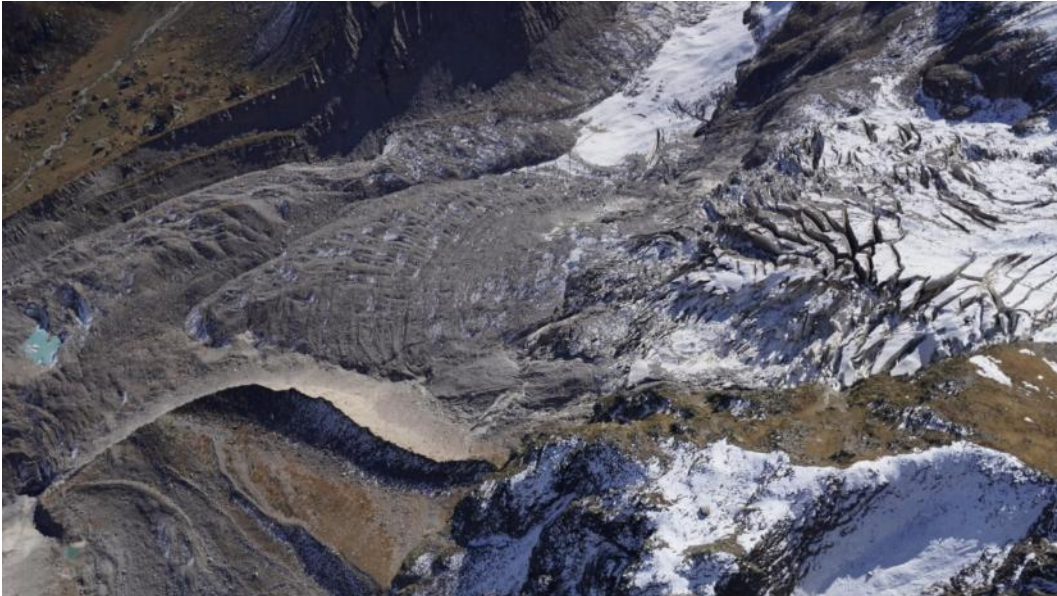
Figura 89 – Zona di confluenza del ghiacciaio del Monte Rosa nel sottostante ghiacciaio del Belvedere, ripresa da elicottero il 10/10/2025: si osserva la spiccata crepacciatura in corrispondenza del superamento della barra rocciosa a quota 2200/2300 m s.l.m. e la sottostante morfologia ad ogive, indicatrice di una spinta attiva nella depressione che aveva ospitato il lago effimero (foto W. Alberto, L. Lanteri).
