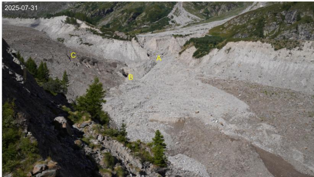
Figura 103 – Vista dal Belvedere della breccia (A) prodotta dal T. Castelfranco nel corso dell'evento del 27 agosto 2023 e poi riutilizzata anche dal T. del Piccolo Fillar nel corso degli eventi del 2024 (29 giugno e 5 settembre); (B) inghiottitoio; (C) crepacci e scarpate ad andamento semicircolare concentrico generati dal collasso del ghiaccio verso la cavità dell'inghiottitoio.
