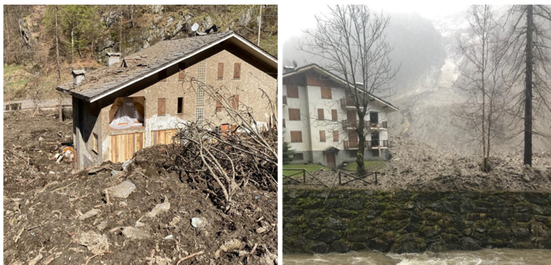
Figura 4.12: Due foto del condominio danneggiato dalla valanga di “Fontanetta”. Nella Foto di sinistra del 23 aprile sono visibili i danni sul lato posteriore della struttura, inoltre è ben visibile la grande componente detritica inglobata dalla valanga, mentre la massa nevosa è meno apprezzabile in quanto fusa in superficie. Sulla destra un'immagine dello stesso condominio la mattina di giovedì 17 aprile, (Foto Arpa Piemonte)
