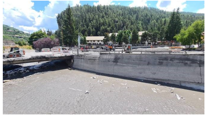
Figura 27 – Ponte della stazione, a sinistra completamente ingombro dal materiale detritico grossolano del 2023; a destra dopo il passaggio della colata del 30 giugno 2025.
