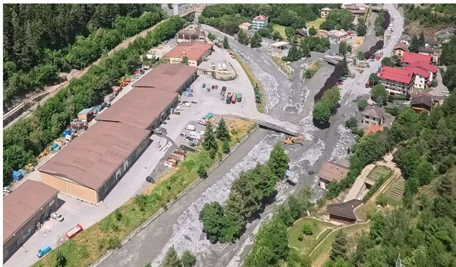
Figura 33 - Panoramica verso monte dall'attraversamento della caserma dei VVFF, con la SS 335 invasa dai depositi della colata
