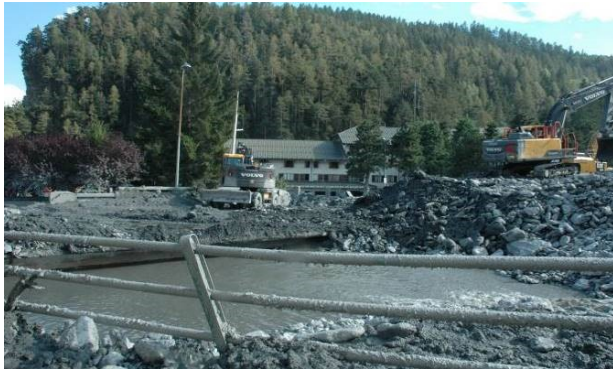
Figura 27 – Ponte della stazione, a sinistra completamente ingombro dal materiale detritico grossolano del 2023; a destra dopo il passaggio della colata del 30 giugno 2025.
