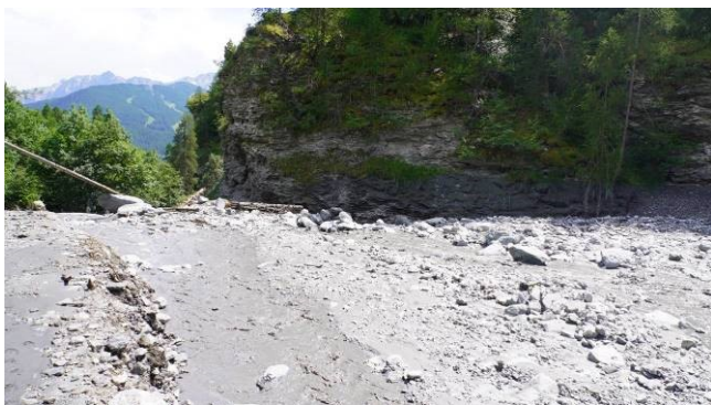
Figura 20 – A sinistra, vista verso valle della briglia selettiva completamente riempita dai detriti della colata; a destra, risulta ben visibile il livello raggiunto dal passaggio della colata nell'area immediatamente a monte della briglia.
