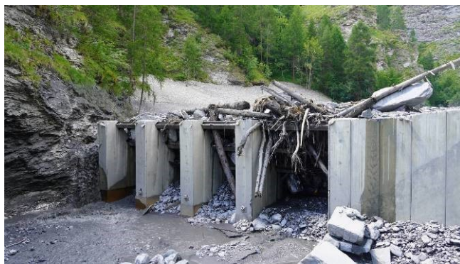
Figura 19 – A sinistra, la briglia selettiva alcuni giorni prima dell'evento del 30 giugno (foto: Consorzio Forestale Alta Valle Susa) e, a destra, la stessa completamente colmata dal passaggio della colata detritica.
