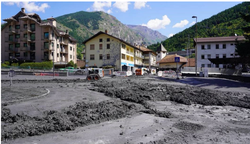
Figura 28 – Ponte della stazione, lavori di sgombero del materiale depositato dalla colata.
