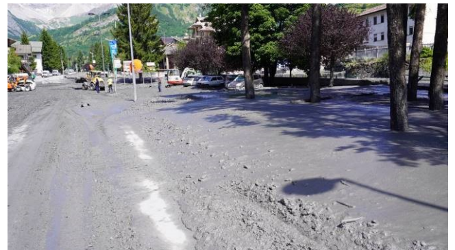
Figura 29 – Nel tratto di strada a valle della rotonda di via Torino è presente un deposito di materiale fangoso di circa 50 cm di spessore.
