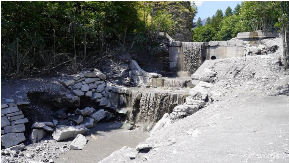
Figura 17 - Erosioni di sponda in destra idrografica. Si notano anche le tracce del passaggio della colata e il deposito sopra l'argine in sinistra idrografica.
