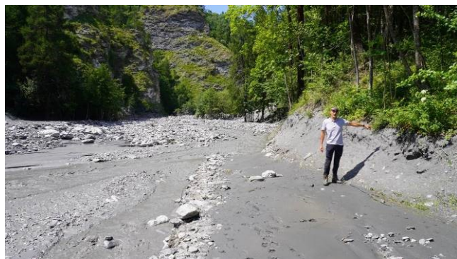
Figura 20 – A sinistra, vista verso valle della briglia selettiva completamente riempita dai detriti della colata; a destra, risulta ben visibile il livello raggiunto dal passaggio della colata nell'area immediatamente a monte della briglia.
