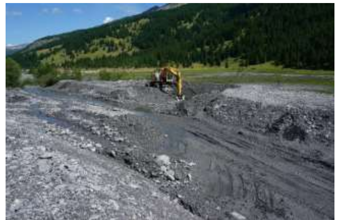
Figura 36 – A sinistra: deposizione di deposito fine in corrispondenza del ponte sul Rio Grand Adreil. A destra, sull'attraversamento del Rio Micosse, rimozione del materiale detritico accumulato all'interno delle trincee scavate nell'accumulo dell'evento di agosto 2023.
