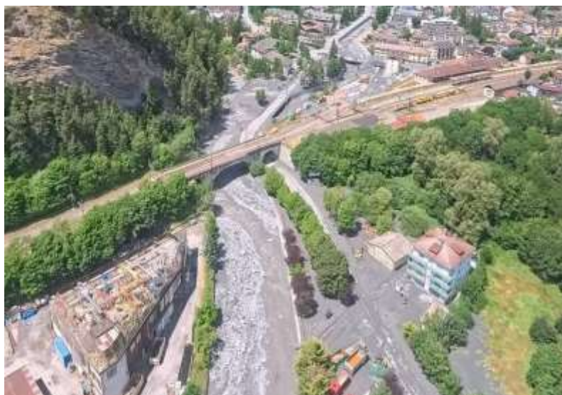
Figura 30 – Vista dall'alto della zona a valle del ponte ferroviario, gli edifici in sinistra della strada e il distributore sono stati interessati dai depositi della colata.
