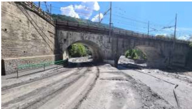
Figura 29 – Nel tratto di strada a valle della rotonda di via Torino è presente un deposito di materiale fangoso di circa 50 cm di spessore.
