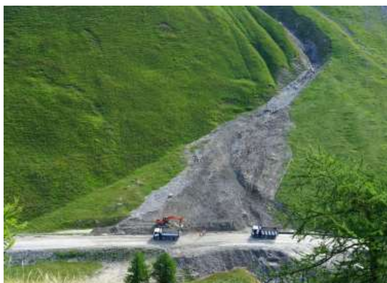
Figura 38 – colamenti detritici più significativi che hanno interessato la SS28 in valle Stura. Riprese fotografiche effettuate il 3 luglio.
