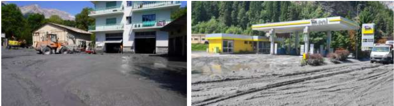
Figura 31 - Edifici interessati dal passaggio della colata detritica nel tratto di via Torino immediatamente a valle del ponte ferroviario.
