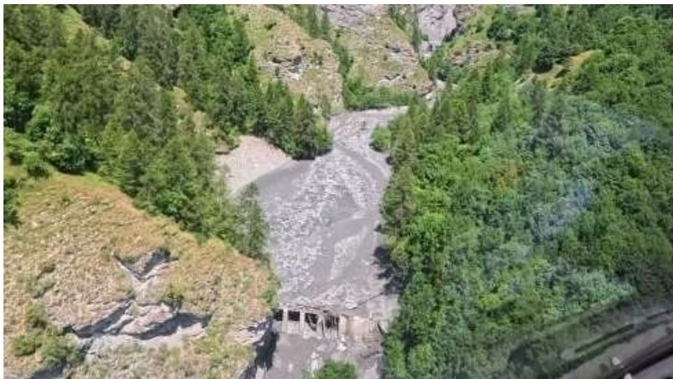
Figura 21 – Vista dall'alto della piazza di deposito a monte della briglia selettiva a quota 1380m.
