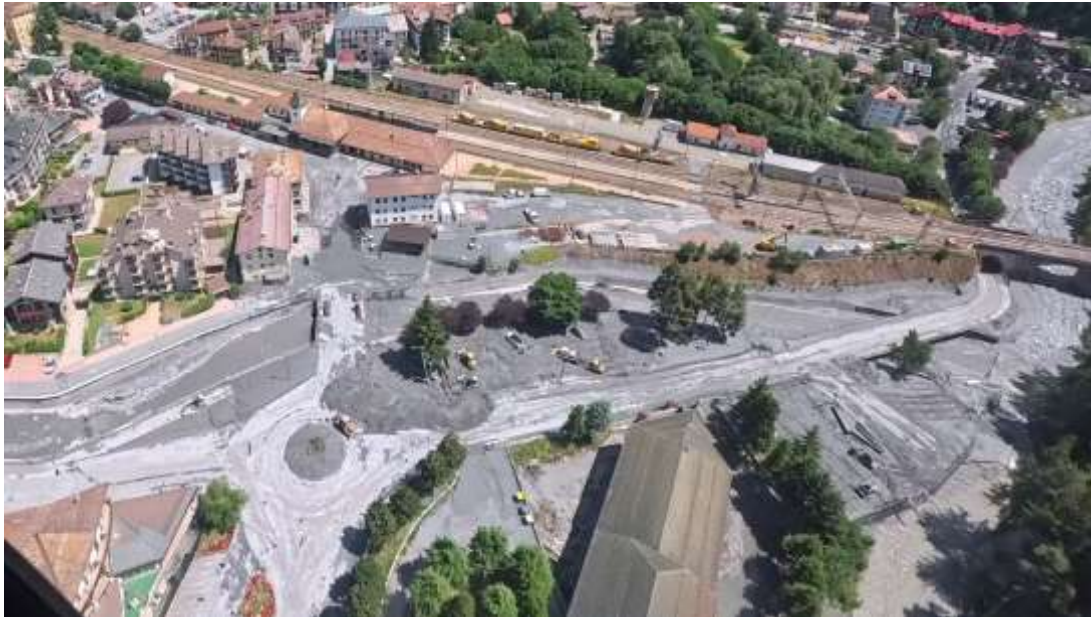
Figura 25 – vista dall’alto della zona in corrispondenza della rotonda di via Torino che, analogamente agli eventi passati, è risultata quella dove sono stati registrati i danni più ingenti.
