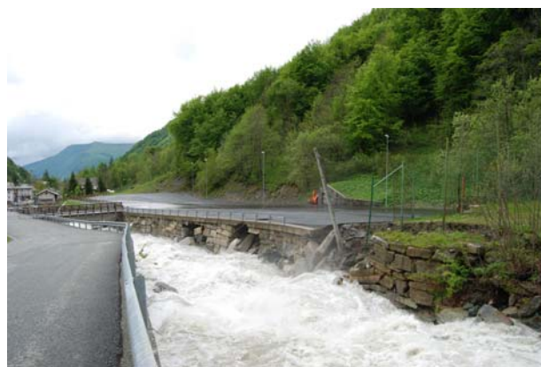
Danni alle scogliere, alla linea elettrica e al parcheggio in località Villa nel comune di Crissolo
