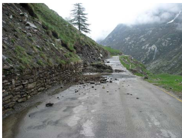
Diffusi crolli e scivolamenti di materiale lapideo sulla S.P. 32 in località Malciaussia nel comune di Usseglio
