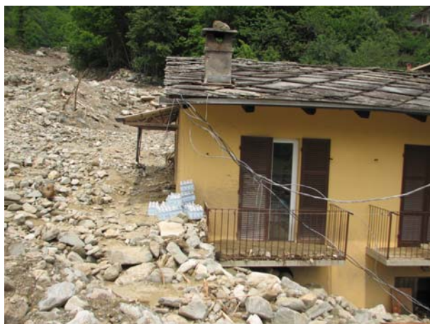
Comune di Villar Pellice, località Garin. Edificio lesionato e parzialmente sommerso dalla colata detritica con 3 m circa di spessore (a sinistra); zona in cui era presente l'edificio completamente distrutto all'interno del quale si trovavano tre delle quattro vittime (a destra)
