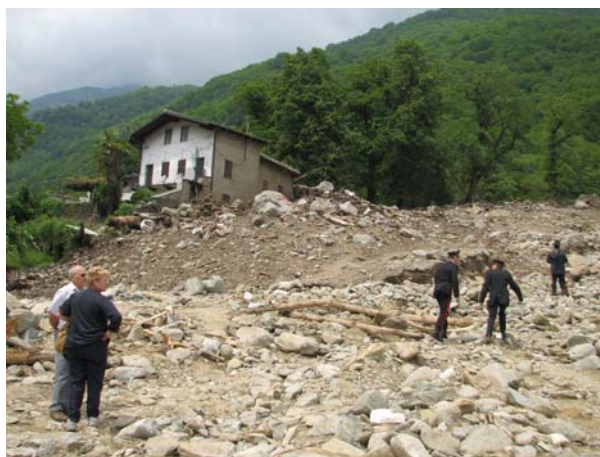
Comune di Villar Pellice, località Garin. Edificio lesionato e parzialmente sommerso dalla colata detritica con 3 m circa di spessore (a sinistra); zona in cui era presente l'edificio completamente distrutto all'interno del quale si trovavano tre delle quattro vittime (a destra)
