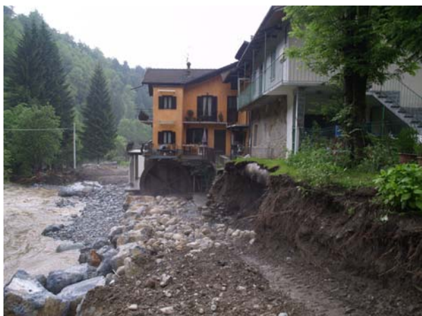
Erosione in sponda destra provocata dal Torrente Bedale in località Villa San Pietro nel comune di Monterosso Grana
