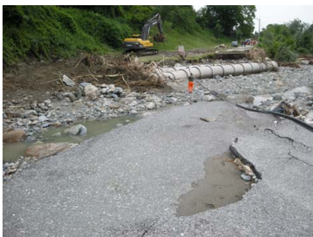
Canale del Torrente Pellice riattivato in sponda sinistra con asportazione del rilevato d'accesso del Ponte Albertenga a Torre Pellice (ripresa da monte)
