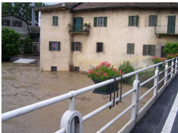
Ponte sul Torrente Grana-Mellea di via Ottavio Moreno a Savigliano
