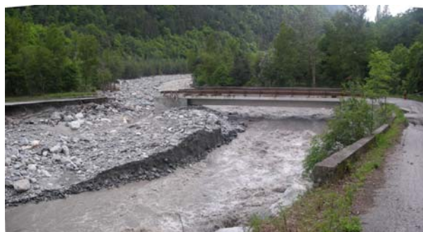
Ponte delle Fucine sul Fiume Dora Riparia in comune di Exilles
