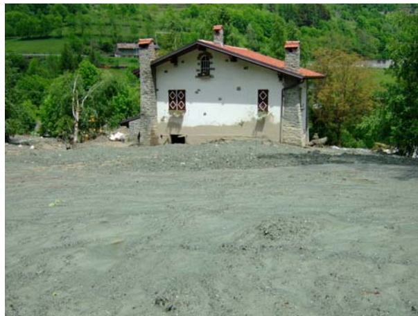
Alluvionamento di edificio residenziale in Borgata Granges nel comune di Fenestrelle. Il materiale detritico ha quasi raggiunto il primo piano sul retro dell'abitazione
