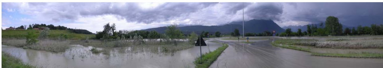
Viabilità e campi allagati dal Rio della Terra Rossa nel comune di Fiorano C.se, a monte della confluenza in Dora Baltea, per fenomeno di rigurgito
