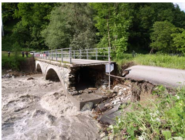
Distruzione della spalla destra del Ponte dei Cros nel comune di Frassinio
