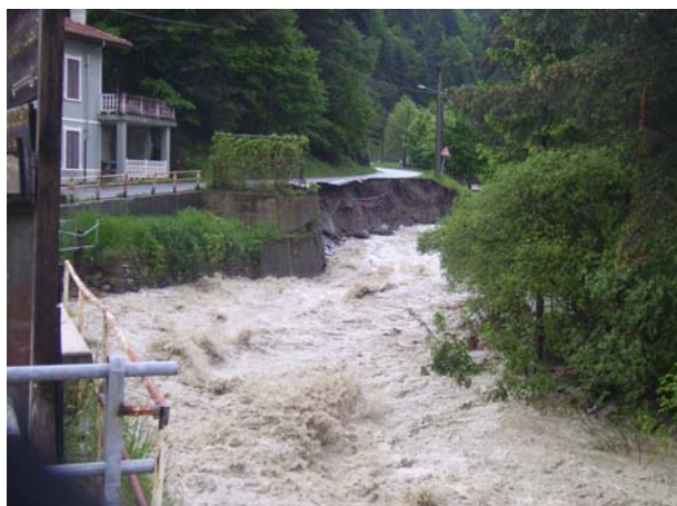
Il Rio Marmora in corrispondenza del ponte nel comune di Marmora
