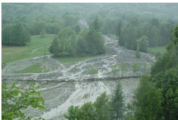
Panoramica sul conoide del Rio Corbiera che al suo margine destro (a sinistra) ha interessato il parco giochi della frazione Granges nel comune di Fenestrelle
