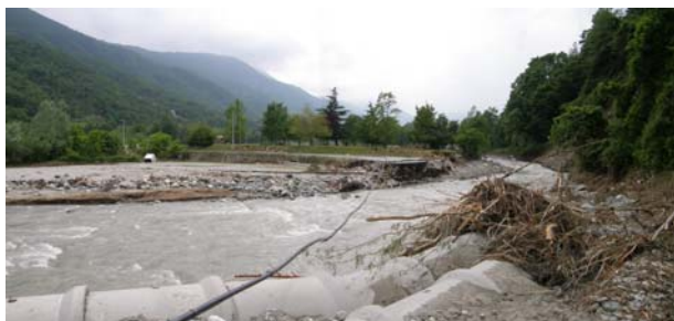
Asportazione della strada di accesso alla spalla sinistra del Ponte Albertenga a Torre Pellice. Distrutte anche tubature di impianti fognari ed acquedottistici. Il danno è stato causato dall'attivazione di un ramo sinistro del Torrente Pellice, visibile a destra
