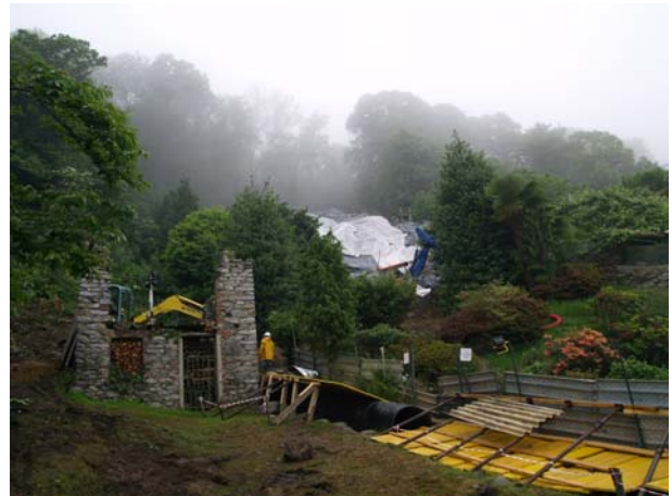
Colamento rapido di materiale sciolto dal Monte S. Salvatore nel comune di Massino Visconti. Il corpo di frana è stato ricoperto con teloni da mezzi meccanici in opera per l'installazione di tubi drenanti
