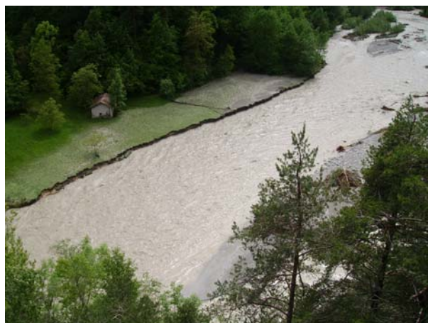
Profonda erosione da parte del Torrente Maira in località Garino nel comune di Macra
