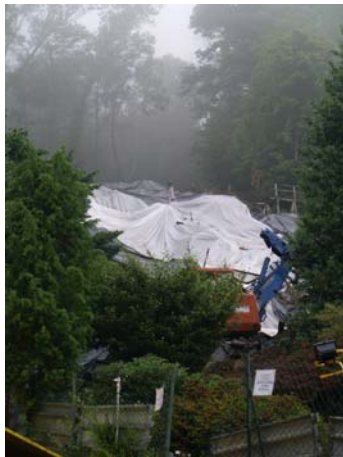
Colamento rapido di materiale sciolto dal Monte S. Salvatore nel comune di Massino Visconti. Il corpo di frana è stato ricoperto con teloni da mezzi meccanici in opera per l'installazione di tubi drenanti
