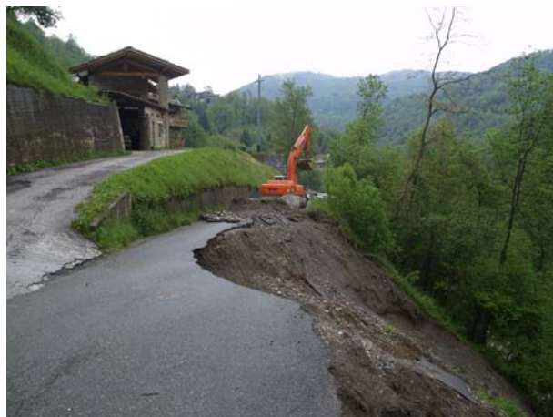
Strada distrutta a causa di uno scivolamento rotazionale in località Santa Lucia nel comune di Monterosso Grana
