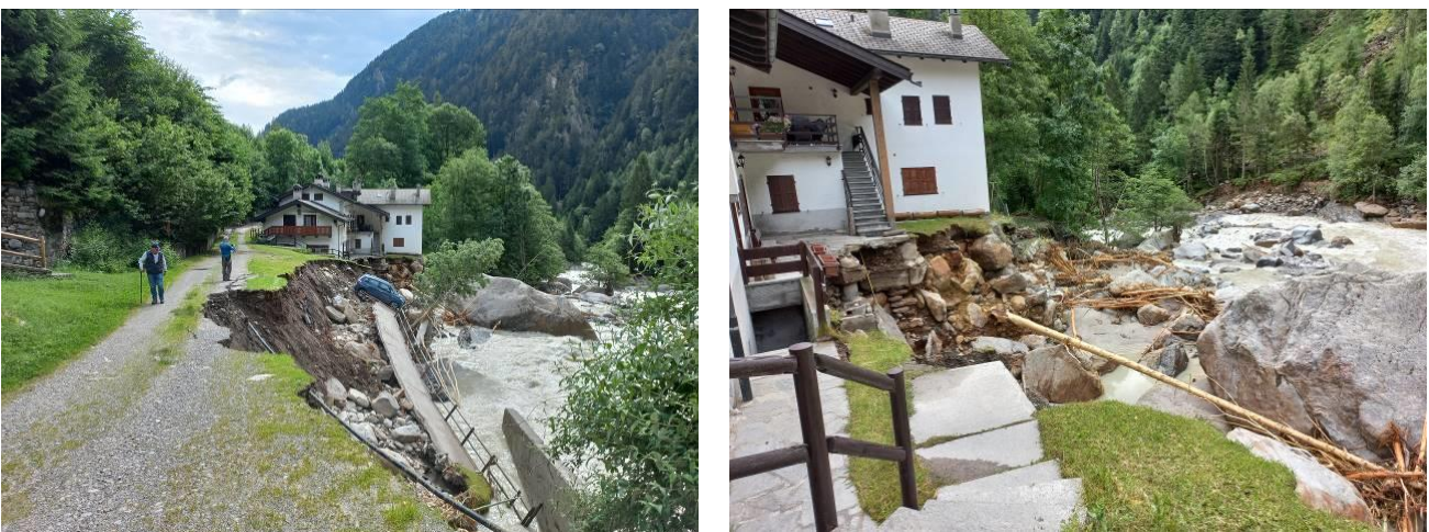
Figura 43 - Erosione di sponda in loc. Pestarena che ha coinvolto un tratto di strada e alcune abitazioni.
