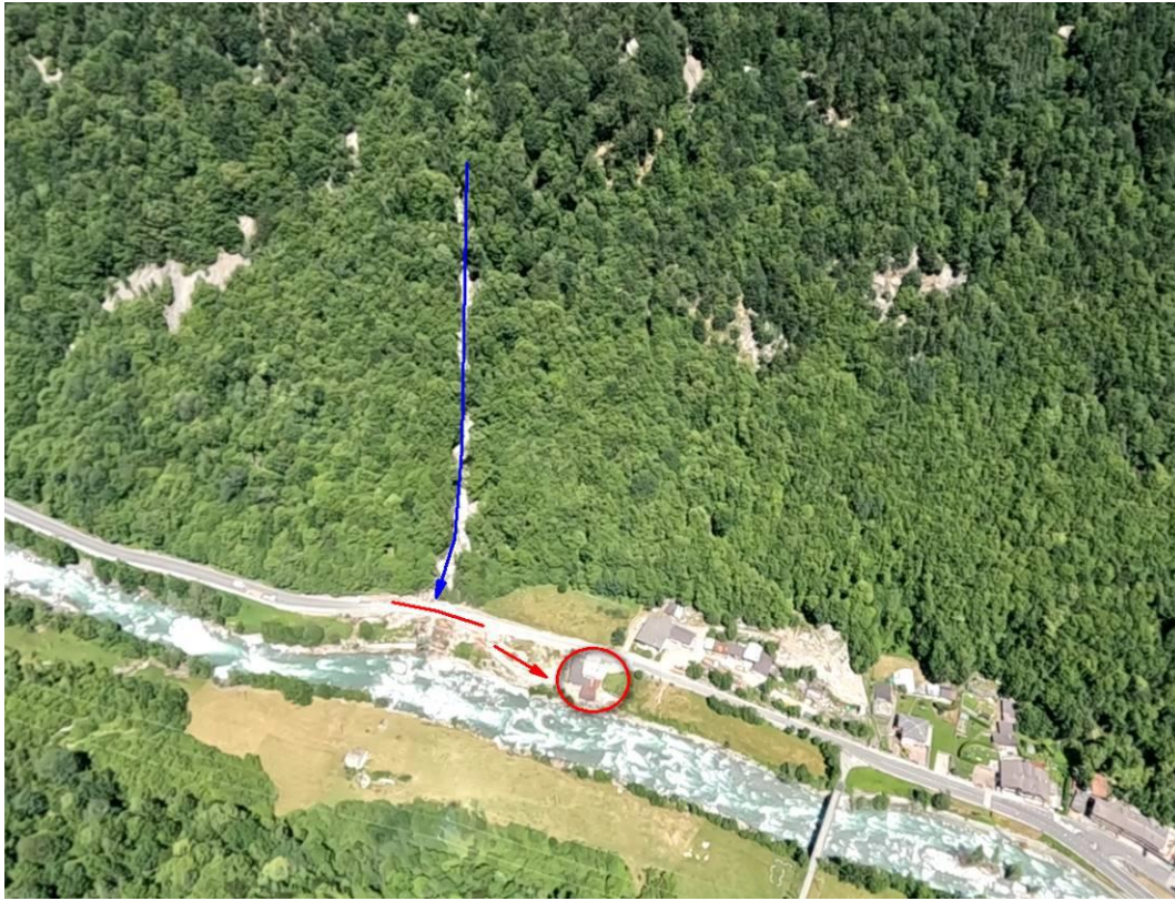
Figura 33 - Vista dall'alto della zona interessata dalla colata detritica. In blu, tratto di alveo su cui si è verificato il trasporto di materiale; in rosso, indicazione del tratto di strada e dell'abitazione interessate dalla colata.
