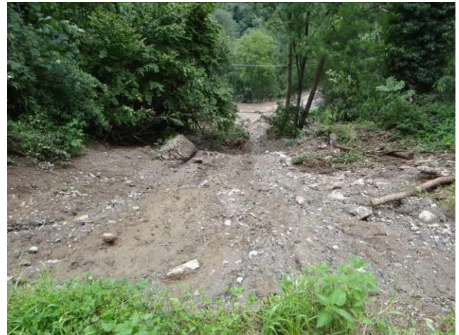
Figura 26 - A sinistra, zona di distacco della frana poco al di sotto della strada comunale per Ingria; a destra zona di scorrimento del materiale detritico, che ha invaso la sottostante sede stradale della comunale e della provinciale.
