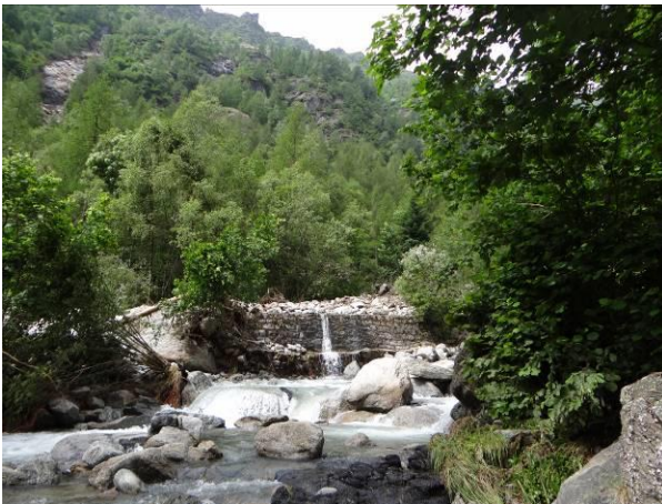
Figura 35 - A sinistra, la colata ha completamente riempito l'alveo del Piantonetto, che prima scorreva oltre il muro in pietra; a destra, poco a valle del tratto asportato la sede stradale si presenta danneggiata in modo lieve.
