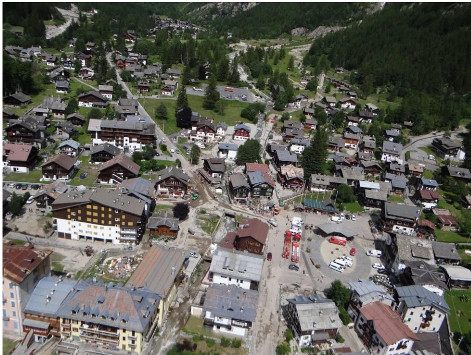
Figura 39 - Vista dall'alto del centro di Macugnaga, pesantemente interessata dal trasporto solido del T. Tambach.
