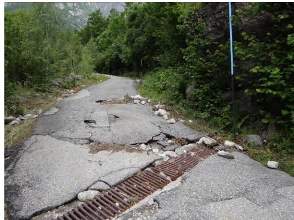
Figura 35 - A sinistra, la colata ha completamente riempito l'alveo del Piantonetto, che prima scorreva oltre il muro in pietra; a destra, poco a valle del tratto asportato la sede stradale si presenta danneggiata in modo lieve.
