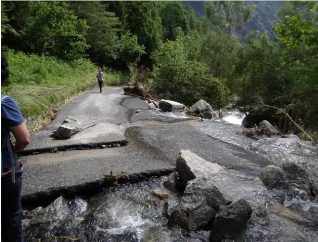
Figura 34 - Tratto di strada completamente asportato dall'erosione di sponda causata dalla deviazione dell'alveo del Piantonetto. A sinistra, vista verso monte; a destra, vista verso valle.
