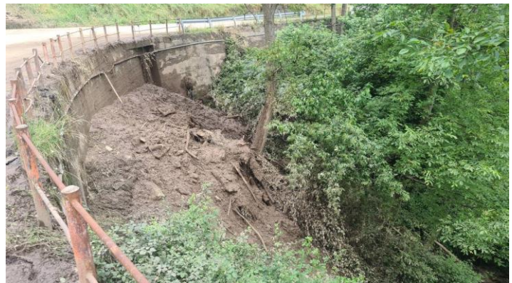
Figura 27 - A sinistra, accumulo di materiale in corrispondenza della strada provinciale. A destra, parte del materiale è proseguito al di sotto della sede stradale, arrestandosi qualche decina di metri dopo.
