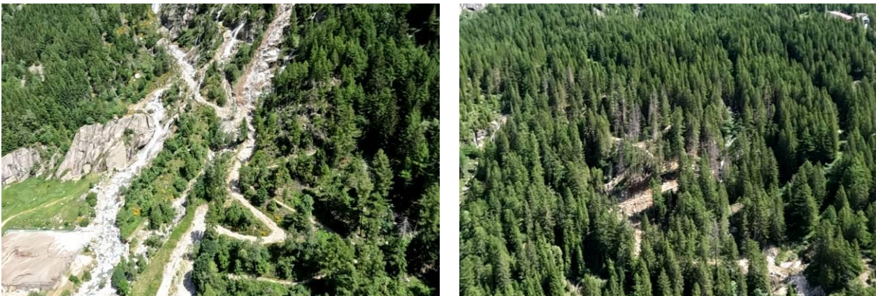
Figura 41 - Fenomeni di erosione concentrata con asportazione di diverse porzioni della pista cicloturistica Macugnaga-Monte Moro: A sinistra, zona bassa in corrispondenza della sponda destra del T. Tambach; a destra, zona sommitale.
