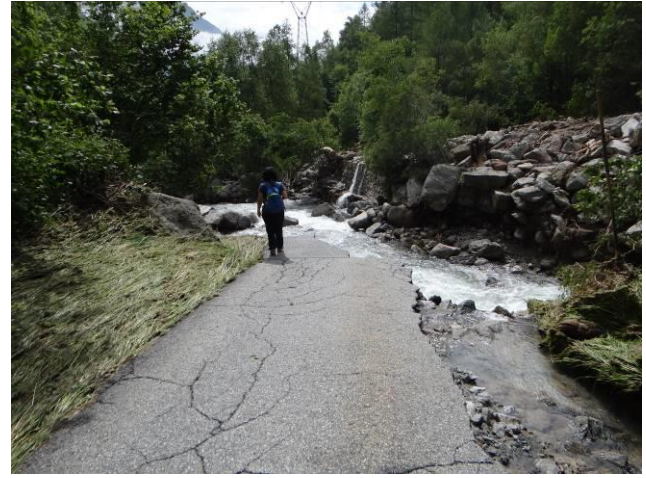
Figura 34 - Tratto di strada completamente asportato dall'erosione di sponda causata dalla deviazione dell'alveo del Piantonetto. A sinistra, vista verso monte; a destra, vista verso valle.
