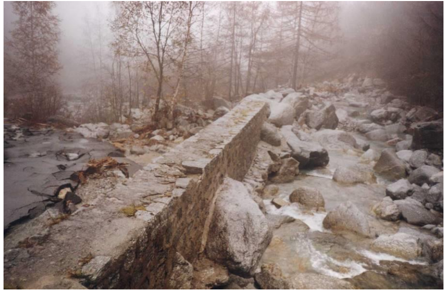
Figura 37 - dall'Archivio della banca dati di Arpa Piemonte si evince che lo stesso tratto di strada era già stato danneggiato in occasione dell'evento del 13 ottobre 2000. Nella foto di destra si vede l'alveo che scorre nella sede originaria, a destra del muro in pietra.
