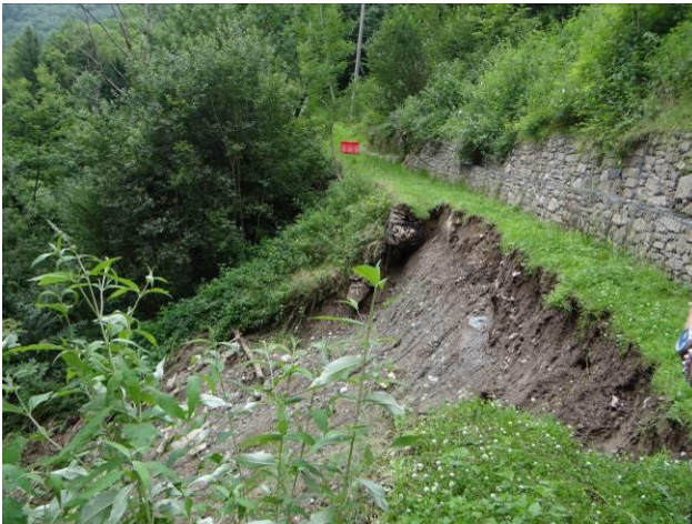
Figura 26 - A sinistra, zona di distacco della frana poco al di sotto della strada comunale per Ingria; a destra zona di scorrimento del materiale detritico, che ha invaso la sottostante sede stradale della comunale e della provinciale.
