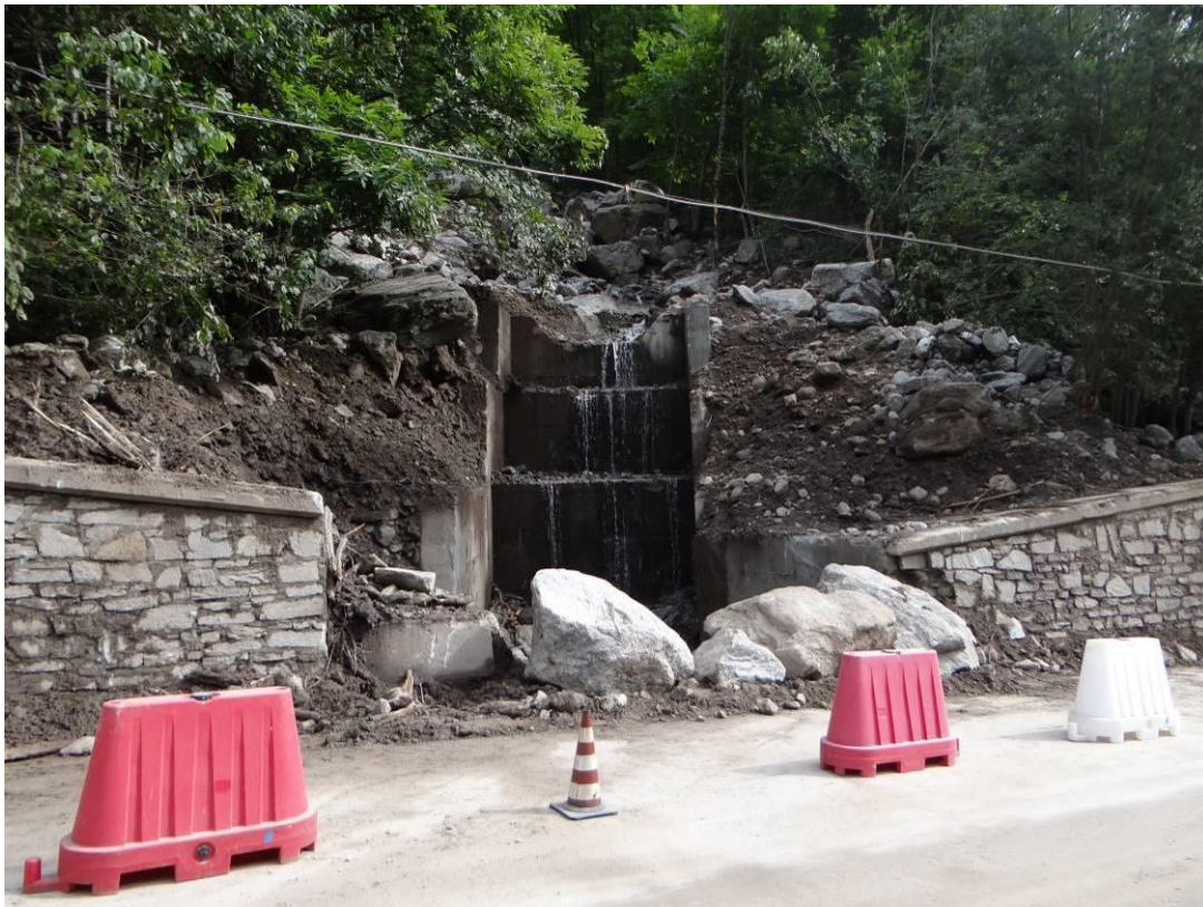
Figura 31 - Intersezione del tributario secondario del T. Orco con la strada provinciale.
