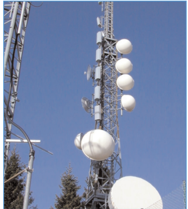
Fig. 4 Ponti radio (parabole) e antenne per trasmissione televisiva (pannelli rettangolari).
