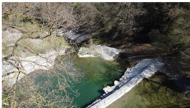
Traversa all'inizio del tratto
