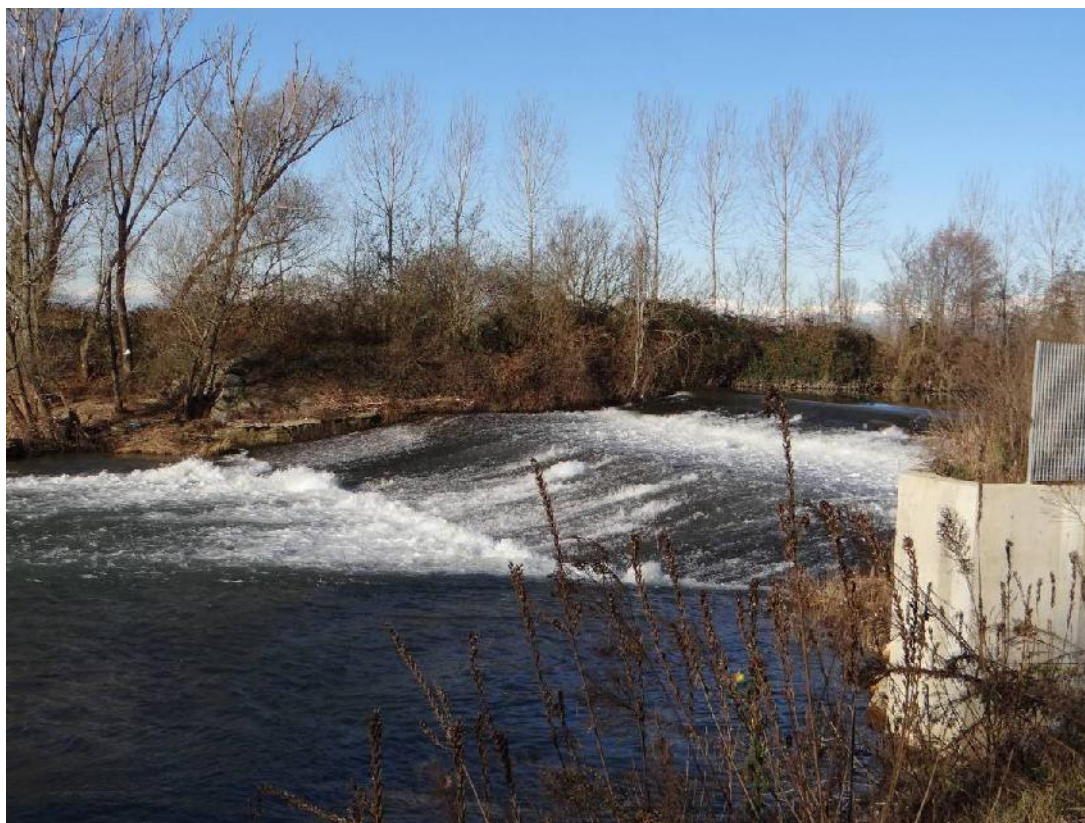
Traversa di derivazione, Chiusa di Nicorvo.
