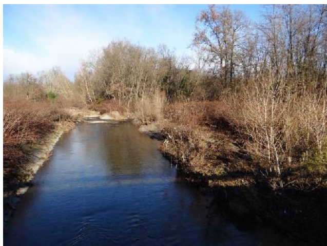
Alveo a monte del ponte della S.P. 22.
