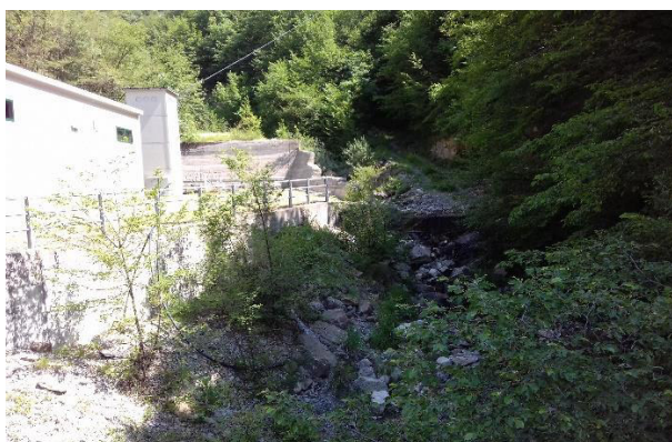
Alveo a monte del ponte sulla SP 140
