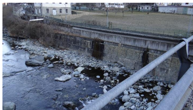
Difese in sponda sinistra al ponte di Mezenile.
