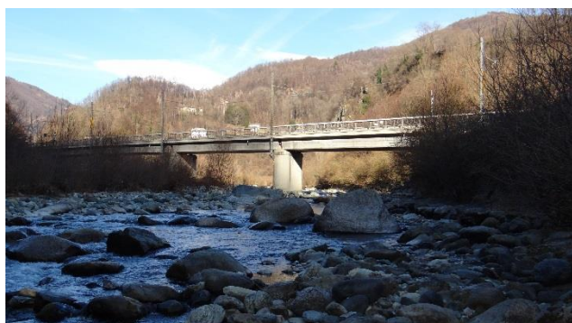
Alveo in corrispondenza di Pessinetto Fuori. Vista verso monte, ponte ferroviario con pile in alveo.
