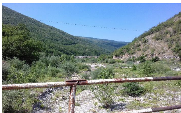
Alveo a valle del ponte sulla strada comunale per fraz. Daglio
