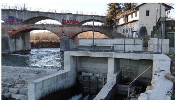
Opera di presa dell' impianto idroelettrico Carrù
