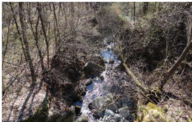
Particolare alveo a valle della presa
