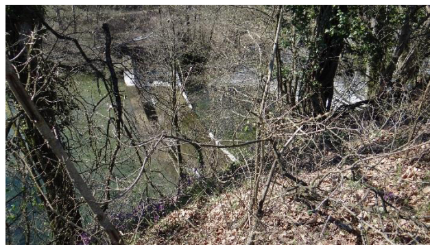
Soglia in corrispondenza di Quattro Pilastri
