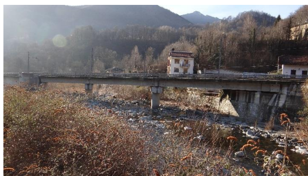
Ponte ferroviario a Pessinetto.
