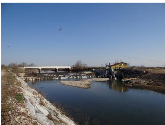
Traversa di derivazione continuazione della Roggia Mora.
