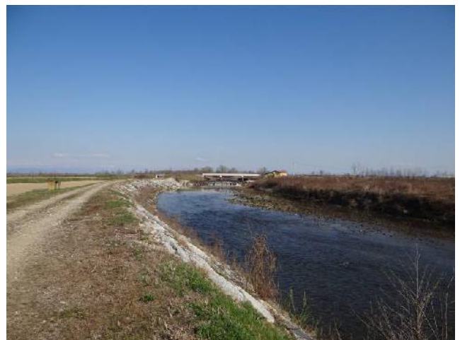
Argine in sponda destra.
