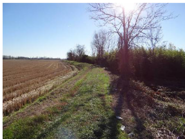
Argine in sponda sinistra.
