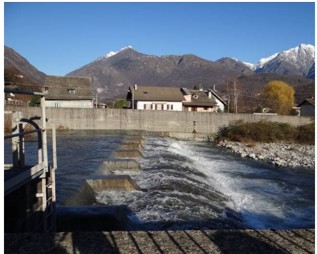
Particolare che mostra il fondo alveo
