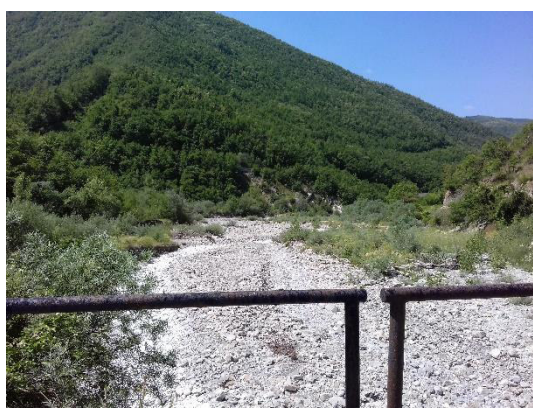
Alveo a valle del ponte sulla strada comunale per fraz. Daglio
