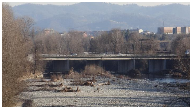
Ponte di Strada dell'Aeroporto.
