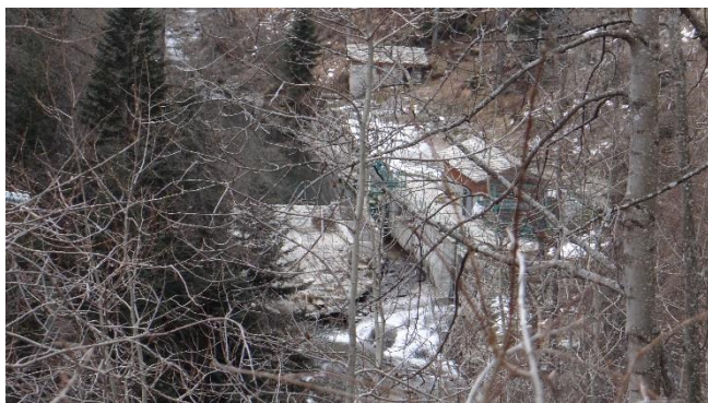
Traversa per uso idroelettrico a monte dell'Ecomuseo delle miniere.
