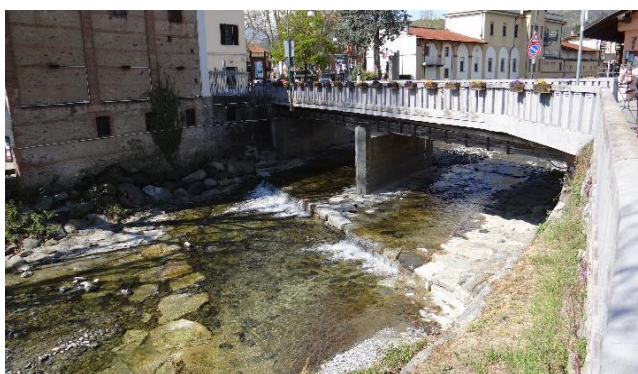
Ponte interferente, soglia e lastricatura del fondo in comune di Almese
