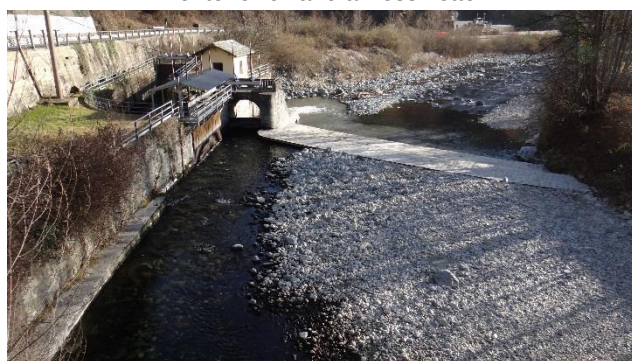
Traversa a valle di Pessinetto.
