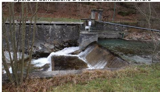
Opera di derivazione in corrispondenza di Cassas
