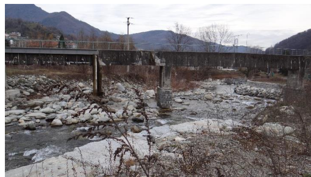
Ponte canale all'estremità finale del tratto.
