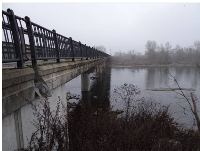
Ponte della SP 94.
