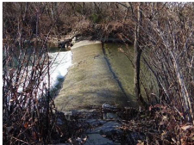
Traversa di derivazione presso C.na Rinalda.
