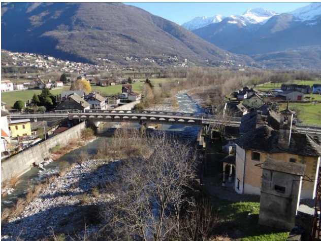
Ponte della SP 17.
