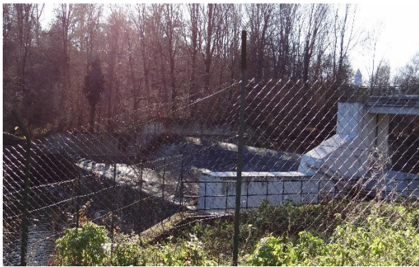
Presa di Crava 1, in comune di Morozzo
