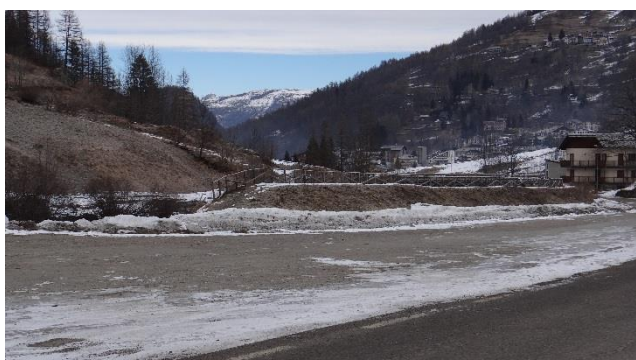
Piccolo argine in sponda destra in corrispondenza di Orgiere
