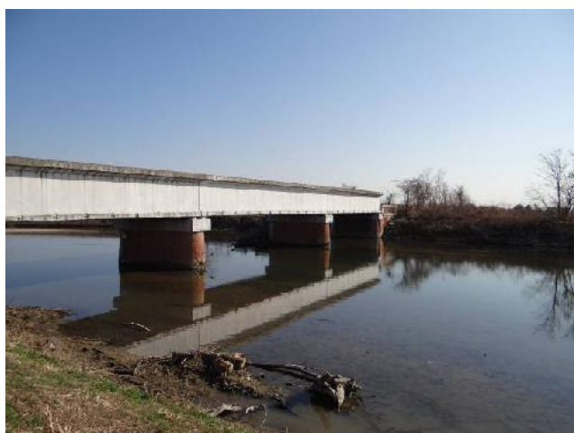
Ponte ferroviario ex linea Varallo-Novara.
