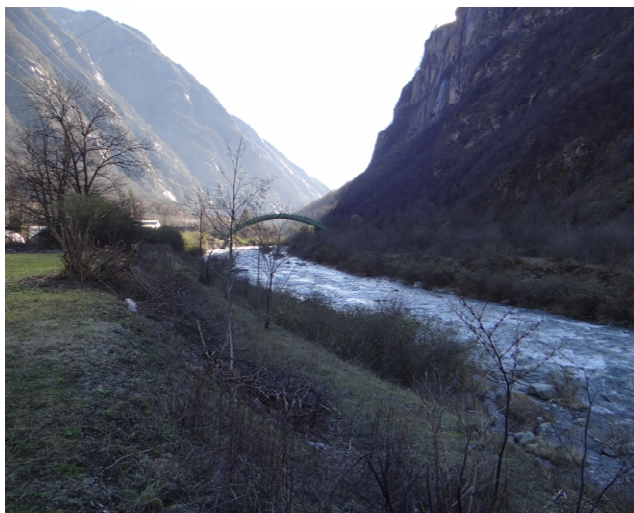
In primo piano, in sinistra idrografica, la difesa spondale e in secondo piano il sifone di attraversamento del canale di derivazione del t. Diveria che convoglia le acque sino alla centrale di Crevoladossola.
