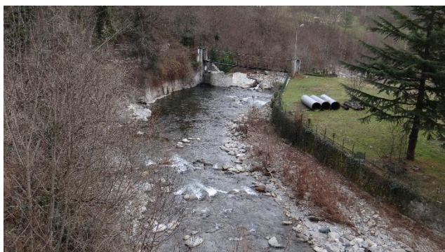
Traversa all'inizio del tratto, vista da monte.
