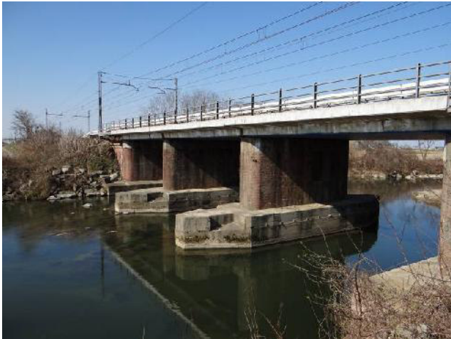
Il ponte ferroviario linea Vercelli-Novara.
