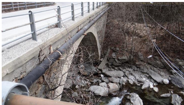
Ponte con luce ridotta all'ingresso della Miniera Rororetto
