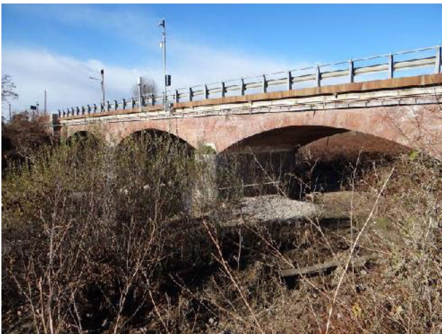
Ponte della SP 17.
