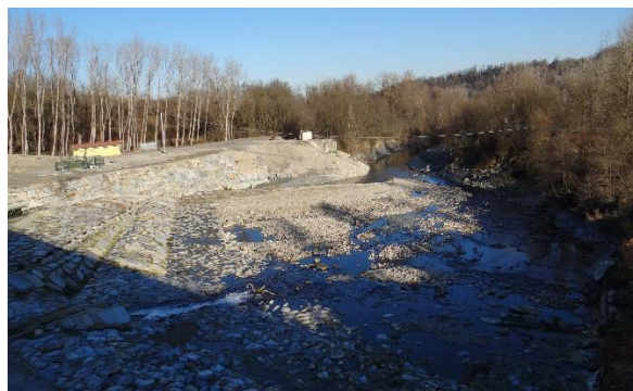
Opere di sistemazione alveo e sponde, in corrispondenza del ponte sulla SS 28
