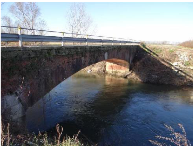
Ponte della SP N.78.
