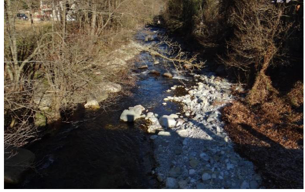
Particolare alveo a valle del ponte
