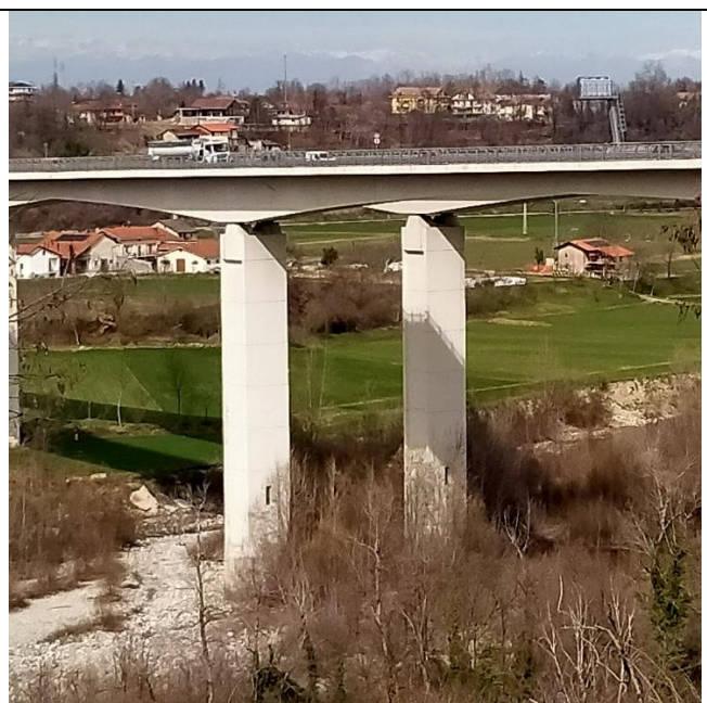
Viadotto Adolfo Sarti
