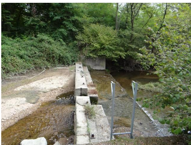
Figura 5 Traversa di derivazione e opera di captazione a monte presente nel penultimo tratto.
