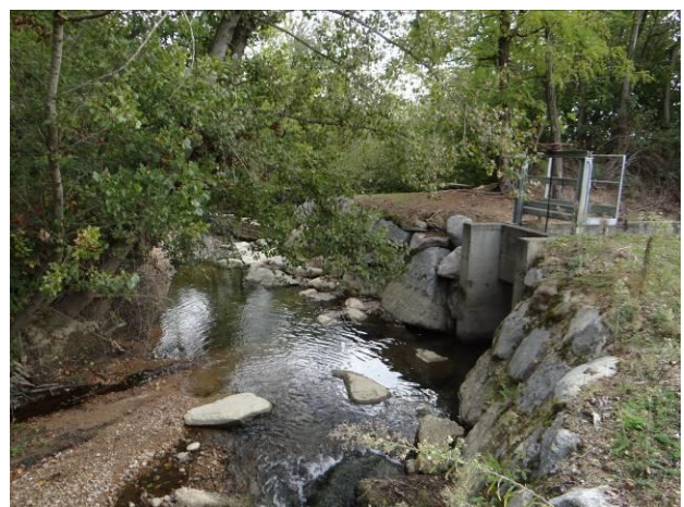
Figura 5 Traversa di derivazione e opera di captazione a monte presente nel penultimo tratto.
