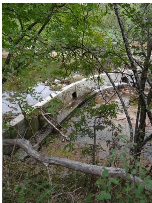
Figura 2 Soglia nella porzione finale del secondo tratto; fondo alveo in roccia.
