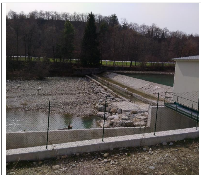
Traversa di canale Morra
