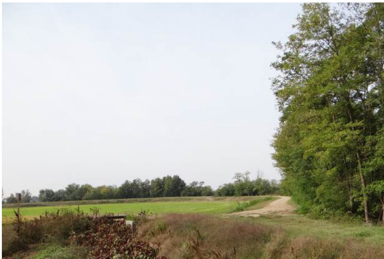
Figura 5 Sullo sfondo argine in terra nei pressi della confluenza con il torrente Cervo in comune di Collobiano.
