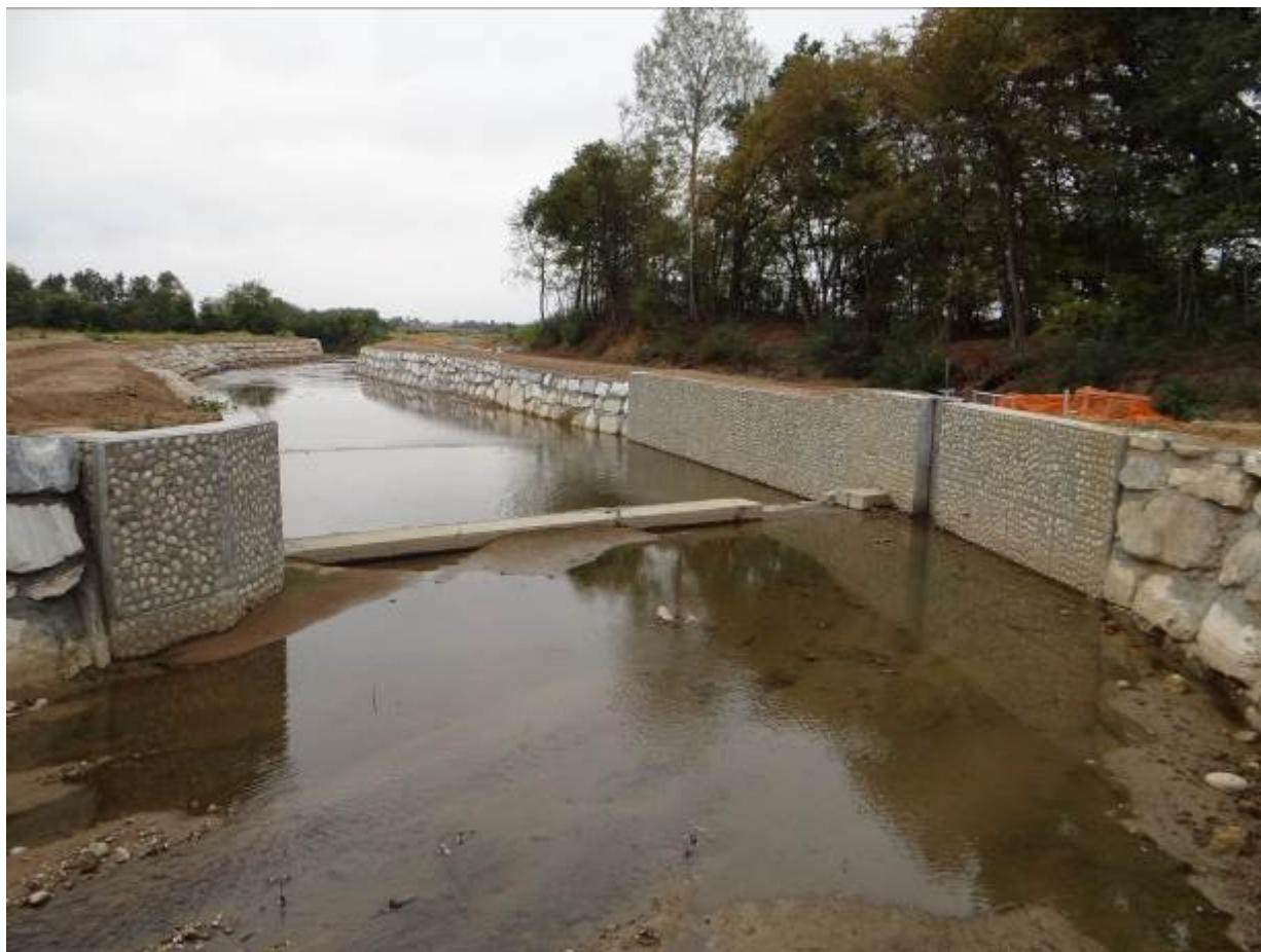
Figura 1 Lavori di ripristino nel tratto con rifacimento dell'opera di derivazione e rivestimento in massi delle sponde.
