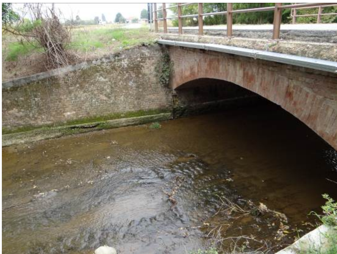
Figura 2 Ponte sulla SP 61; in primo piano l'ampio rivestimento del fondo a protezione dell'opera viaria che caratterizza tutti i ponti lungo l'asta.
