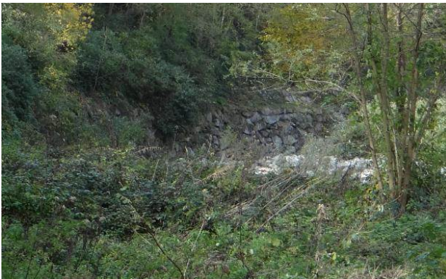
Particolare delle difese in sponda destra nel tratto 4.
