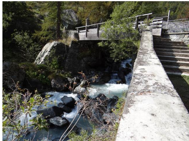
Passerella pedonale in corrispondenza di Bogone
