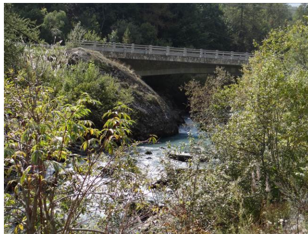
Ponte a monte di Fraz. Chialambertetto
