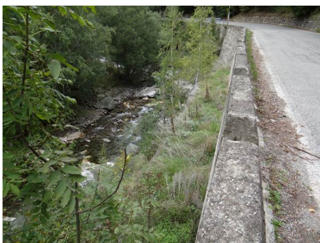
Difese di sponda e muro di sostegno della strada SP170.
