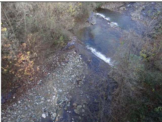
Figura 2. Soglie a protezione del ponte della SP 419 per la Valle d'Aosta, tratto 6.
