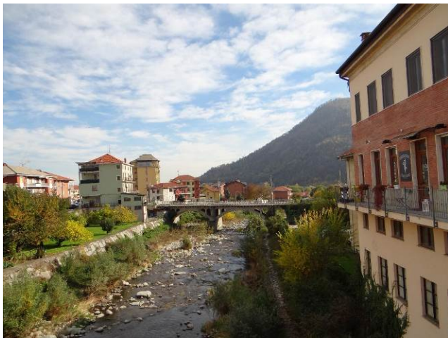
Il ponte della ferrovia.
