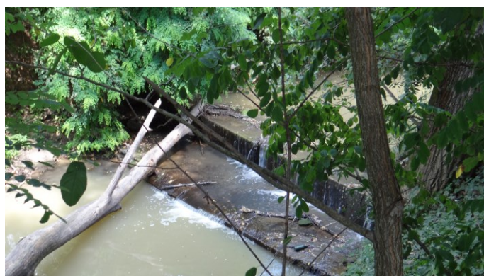
Soglia a valle del ponte di Strada del Tamagnone dove si riconosce un tronco in alveo, ma la foto è del 14/8/2018.
