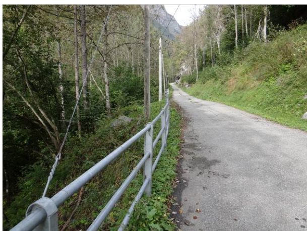
Strada che unisce le frazioni di Balsiglia e Gros Passet e che limita parzialmente la continuità tra versante e corso d'acqua
