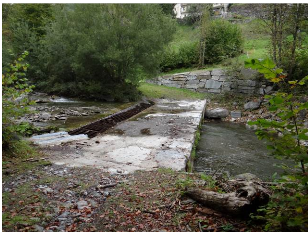
Guado in corrispondenza dell'abitato di Reynaud
