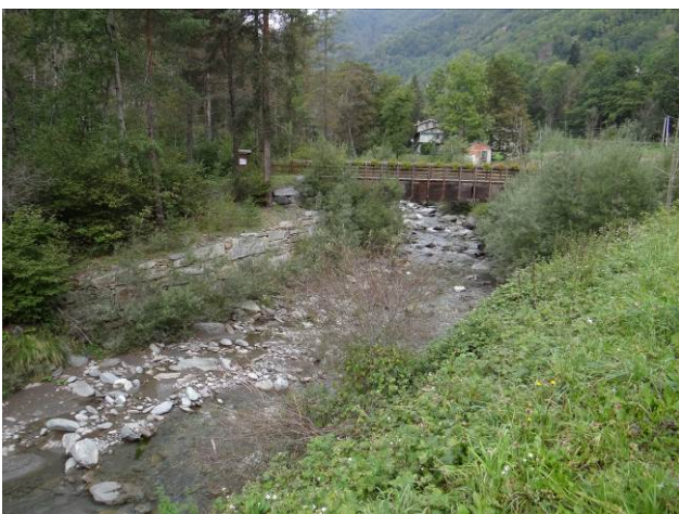
Ponte a monte della Foresteria
