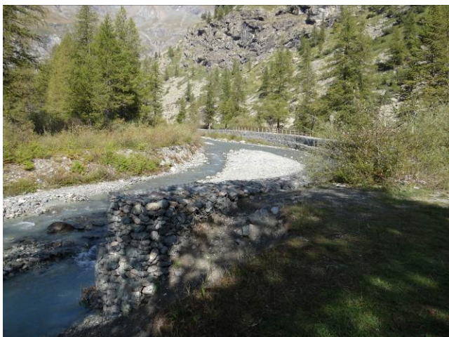
Argine in sponda sinistra presso località Ghiaiarone
