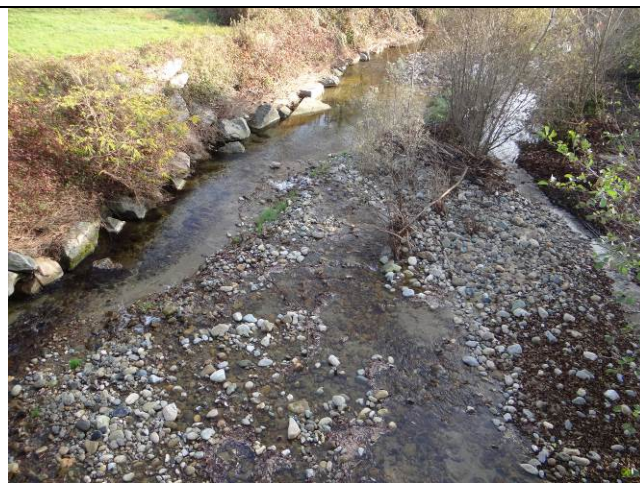
Figura 3. Particolare del fondo alveo e difese in sponda sinistra a valle del ponte su via per Cerrione a Mongrando.
