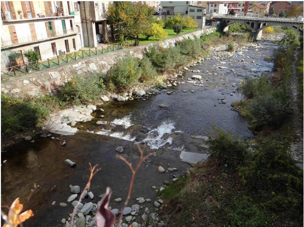
Difese di sponda, soglia e ponte.
