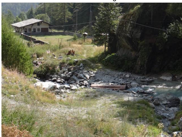
Guado a monte dell'abitato di Balme
