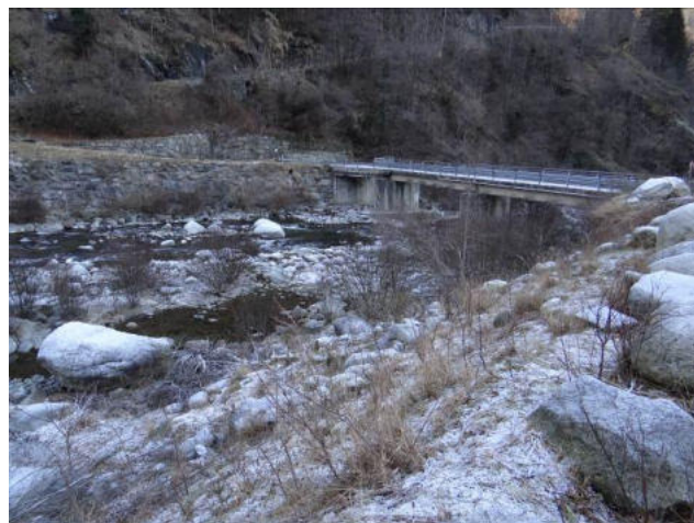
Alveo a monte di Villanuova e ponte con pile in alveo
