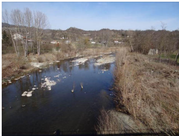
Alveo a valle del ponte di Merana.
