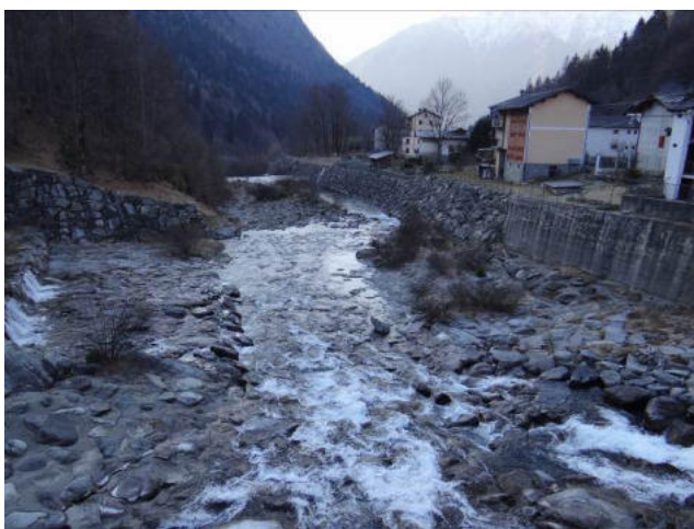
Difese in sponda destra in corrispondenza dell'immissione del Rio di Scandosio in sinistra.
