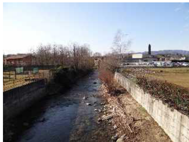
Il ponte della S.P.22.
