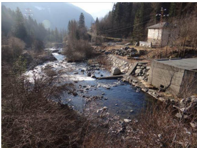
Briglia e difese in sponda destra a valle del ponte per Località Zurlera
