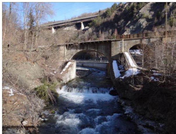
Attraversamento della linea ferroviaria e traversa
