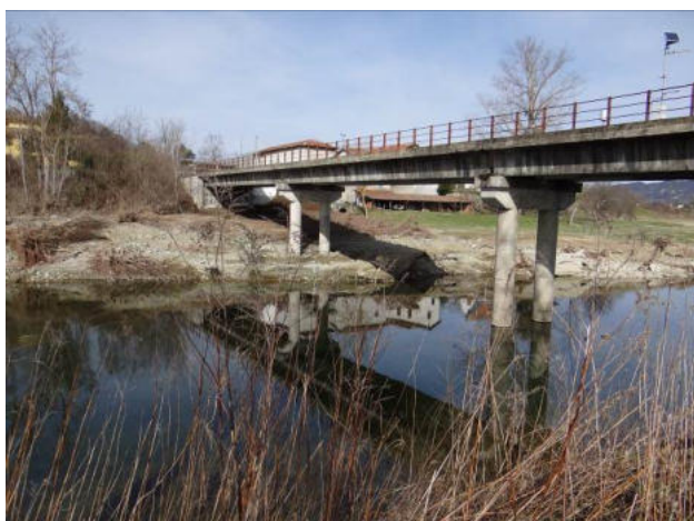
Ponte a Mombaldone.
