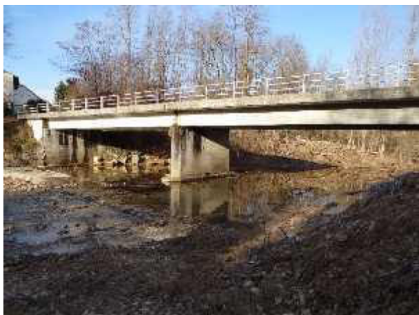
Ponte della Spa San Marco- evidenti tracce di movimentazione depositi per pulizia alveo.
