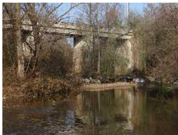
Ponte ferroviario direzione Novara con soglia
