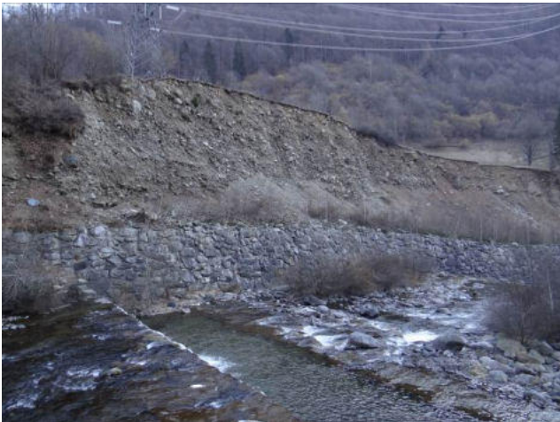
Soglie e difese di sponda a valle del ponte per Scandosio.
