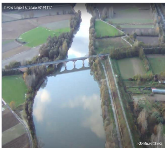
Castello di Annone: ponte della SP 39.
