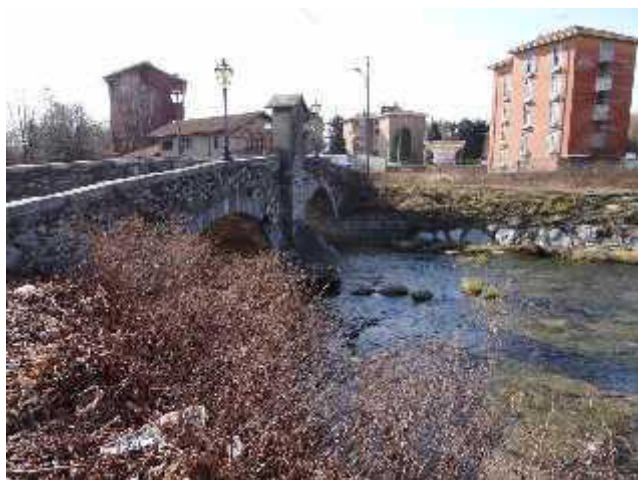
Ponte storico di via Cureggio.
