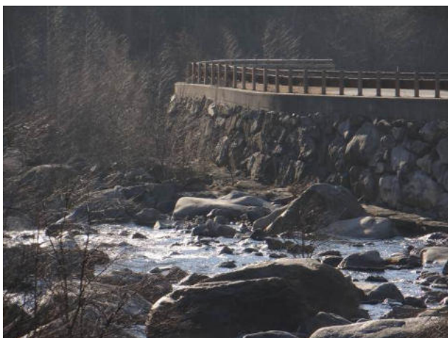
Difese di sponda a protezione della strada
