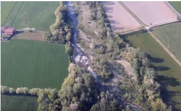
Lungo argine in sponda destra.
