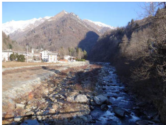
Difese di sponda a valle dell'abitato di Valprato Soana.
