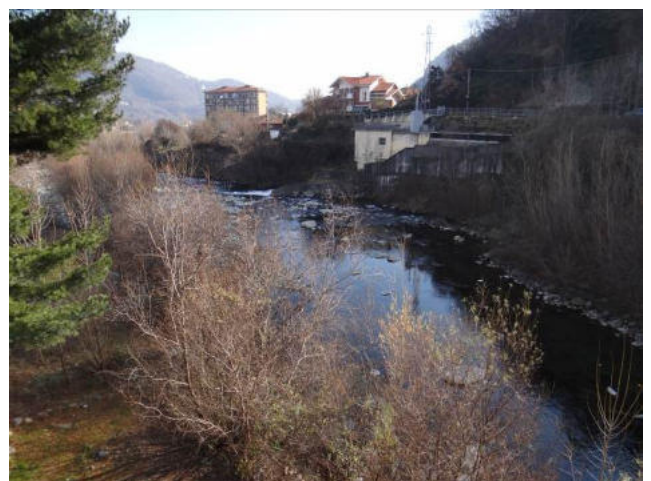
Difese in sponda destra a valle del ponte di Via Ospedale.
