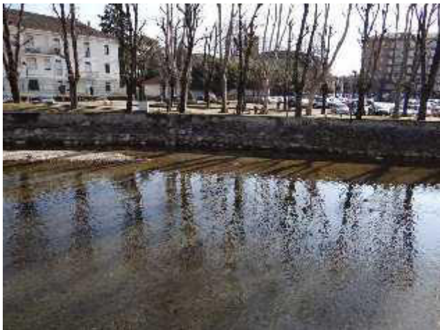
Muro argine a difesa della sponda a Borgomanero.
