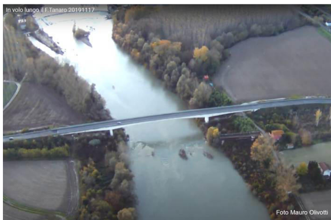
Felizzano-Masio: ponte della SP77.
