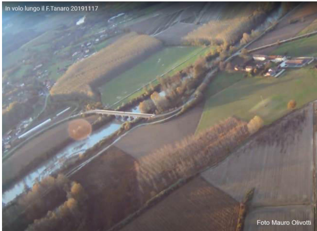
Rocchetta Tanaro: ponte della SP27.
