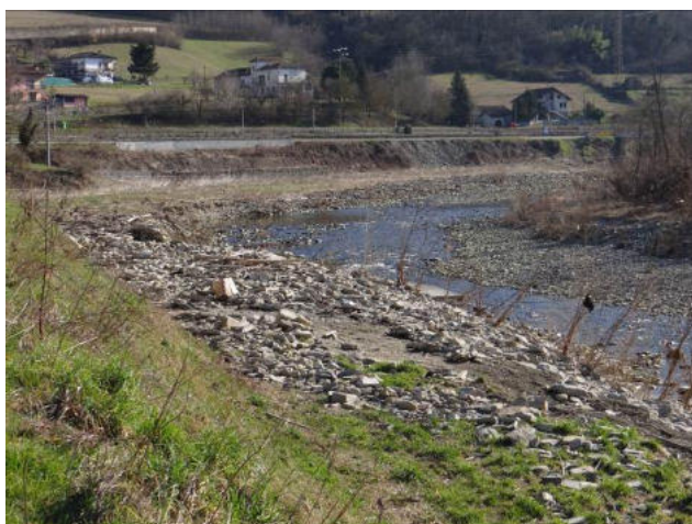
Alveo a monte di Ponti. Sponda erosa presumibilmente durante l'evento ottobre 2019
