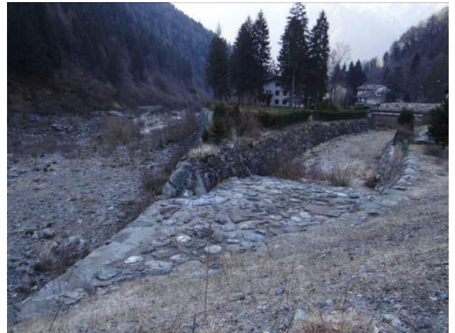
Canale scolmatore e isolotto edificato in destra a monte dell'abitato di Ronco.
