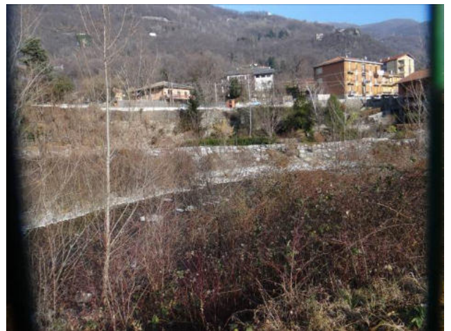
Sponda sinistra con opera di difesa nella porzione centrale del tratto
