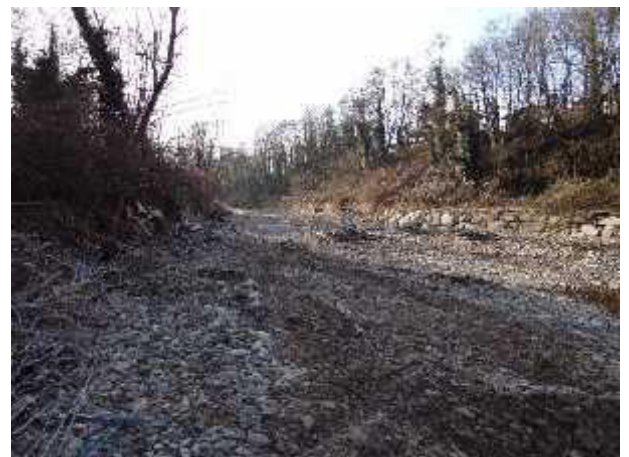
Alveo a valle del ponte con difesa spondale in destra idr.
