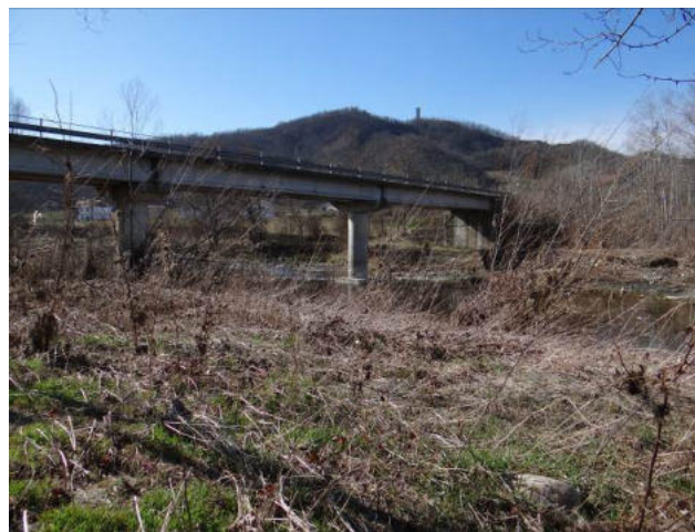
Ponte con pile in alveo a Merana .
