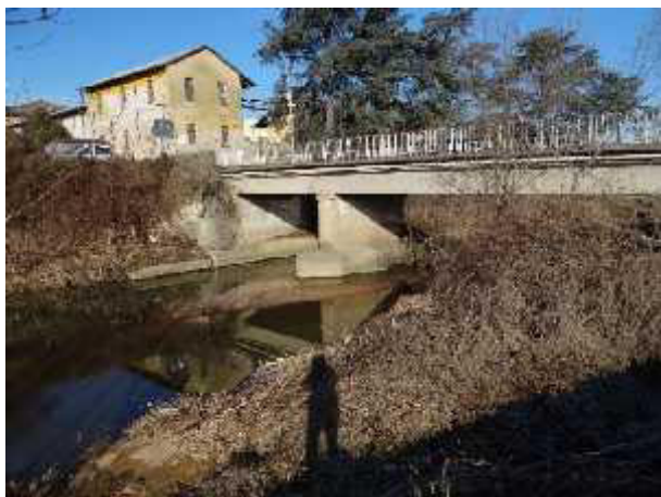
Ponte della SP57 a Villarboit
