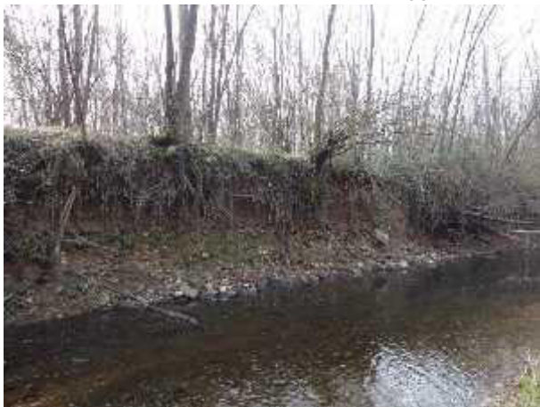
Erosione sponda in corrispondenza anse dell'alveo
