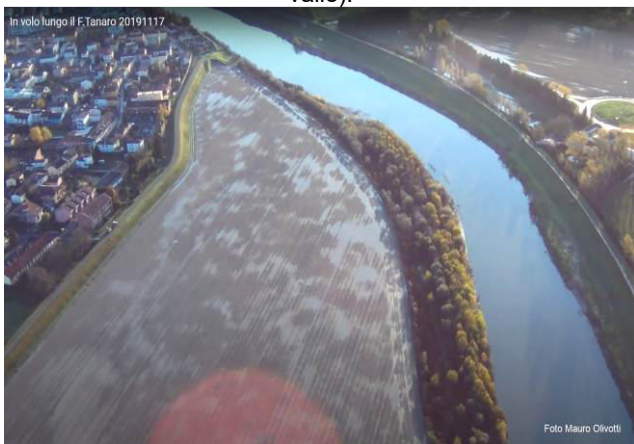
Alessandria: dettaglio argini a contatto e esterni.
