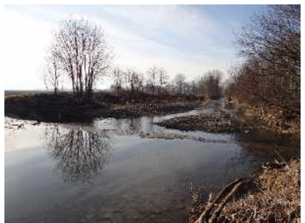
Trasversa di derivazione prima della confluenza della roggia Druma; vegetazione sulle sponde senza continuità
