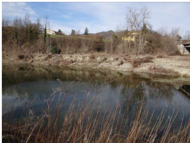
Sponda sinistra a Mombaldone
