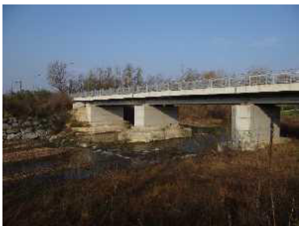
Ponte della SP3 a Rovasenda con soglia e difese spondali
