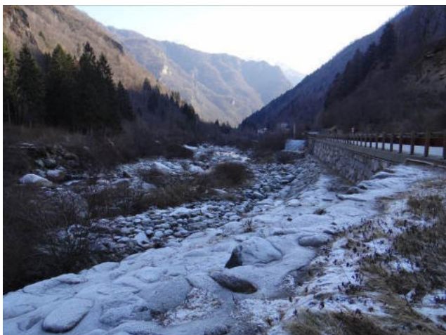
Difese in corrispondenza di Località San Rocco.
