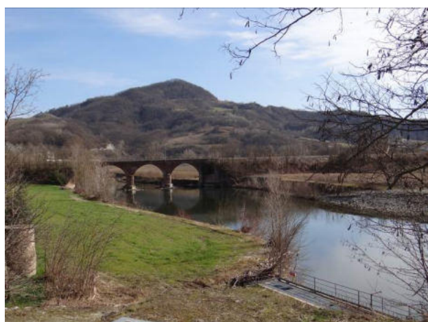
Ponte ferroviario nella parte terminale del tratto.
