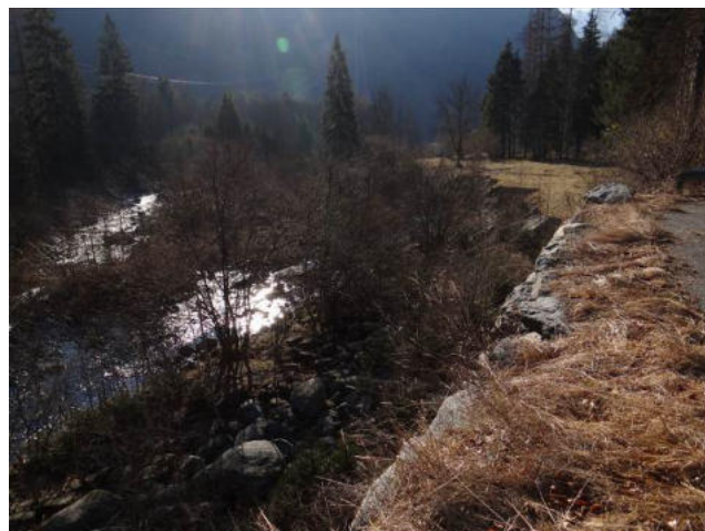
Difese di sponda a protezione della strada
