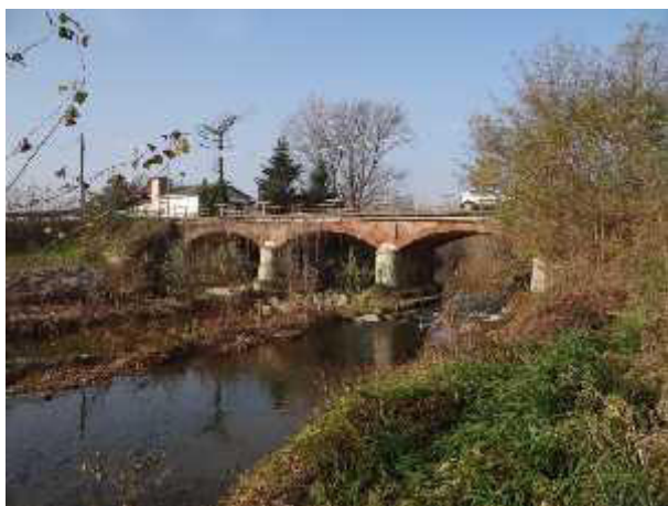
Ponte della SP61 a San Giacomo V.se interferente con il corridoio fluviale.
