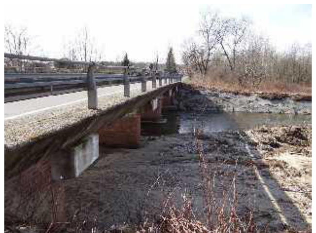
Il ponte della S.P. 22 che segna la fine del CI.
