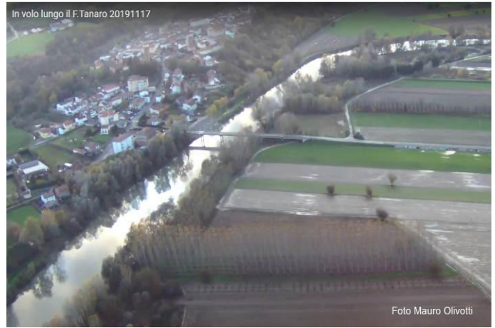
Masio: ponte della SP 247 .
