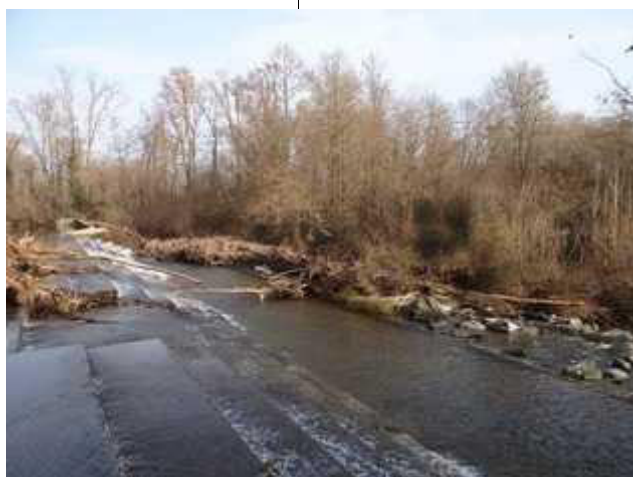
Depositi legnosi lasciati dall'ultima piena del Rovasenda sulla traversa di derivazione (VC00027).
