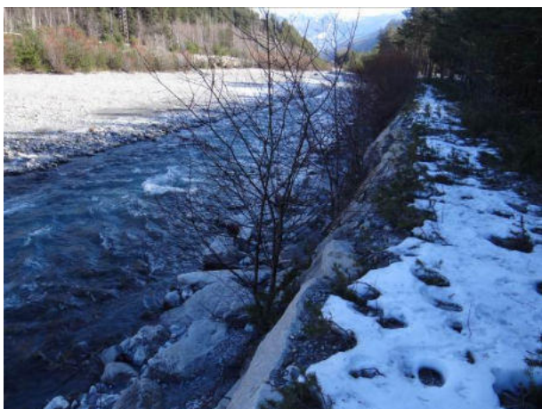
Difesa in massi cementati, sponda destra all'inizio del tratto
