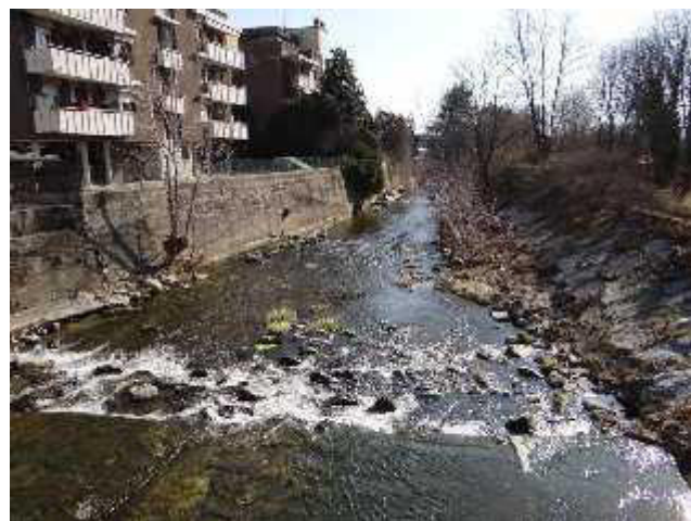
Particolare che mostra la soglia e le difese spondali a valle dell'opera.
