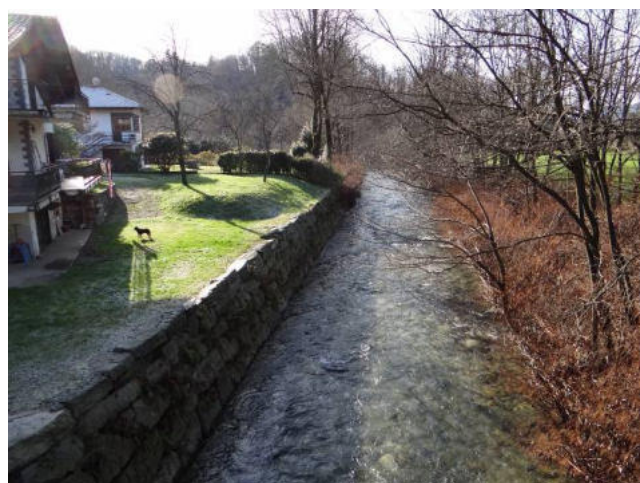
Difese spondali in sinistra a valle del ponte per Pisogno.
