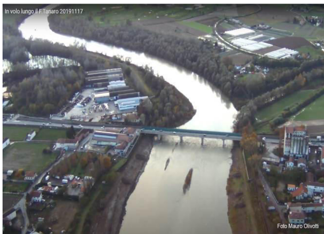
Asti ponte stradale di Corso Savona.
