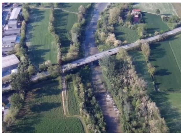
Ponte della SPexSS10 con pile interferenti.
