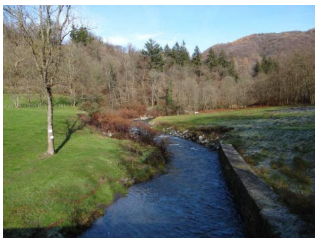
Alveo a monte del ponte della S.P. 22.
