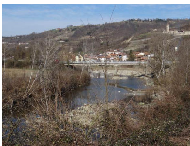
Atraversamento a monte di Ponti.
