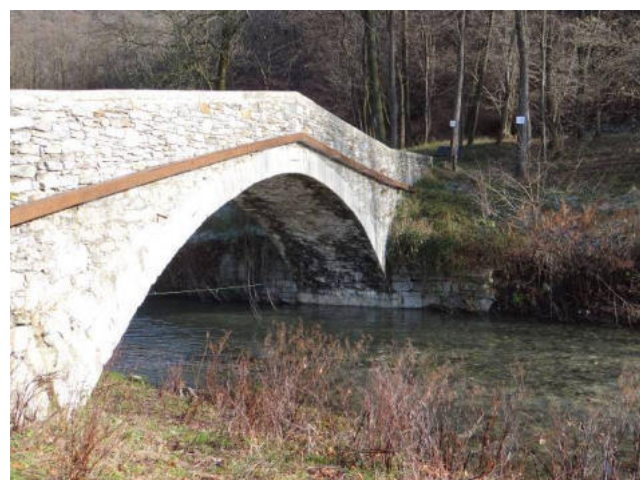
Il ponte della S.P.22.
