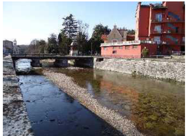
Particolare che mostra il fondo alveo rivestito da massi.
