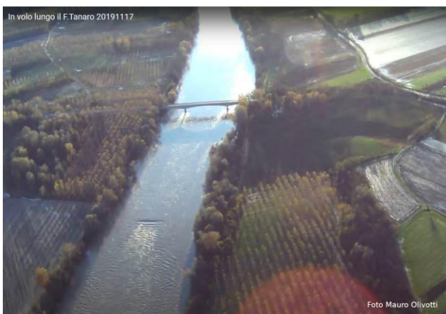
Bassignana: ponte della SP 80
