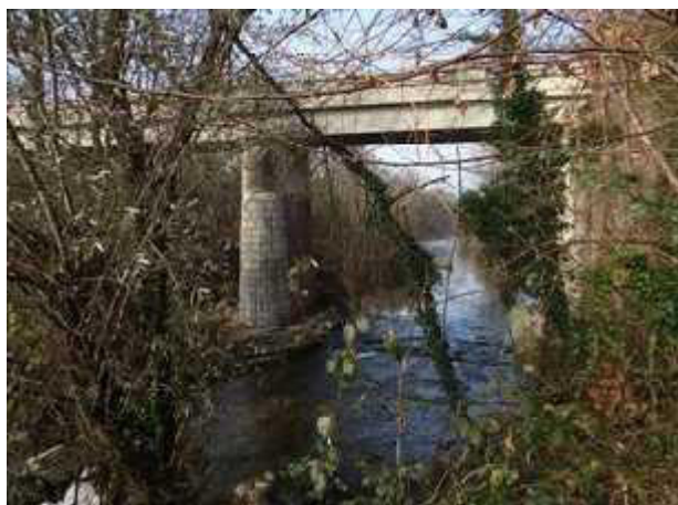
Ponte ferroviario direzione Buronzo con soglia
