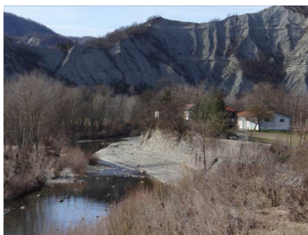
Difese in sponda destra all'inizio del tratto.
