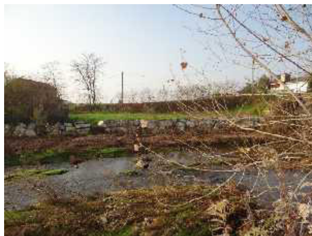
Difese in sponda destra a valle del ponte
