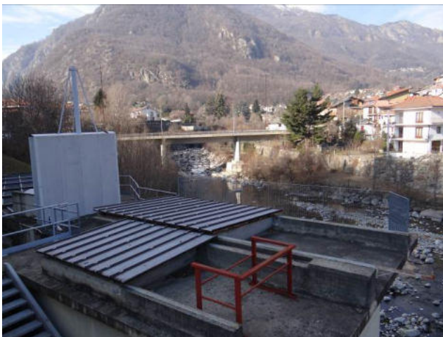
Ponte di Via Ospedale e canale di derivazione presso punto di restituzione
