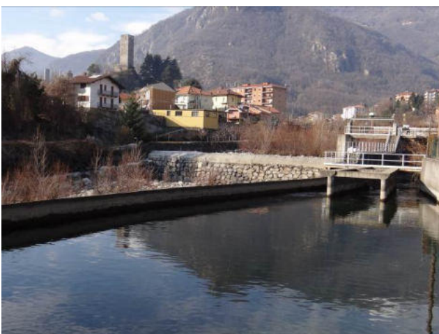
Traversa e canale dell'opera di derivazione nella porzione finale del tratto
