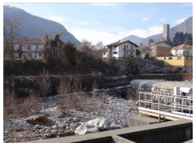
Alveo asciutto a valle della traversa dell'opera di derivazione
