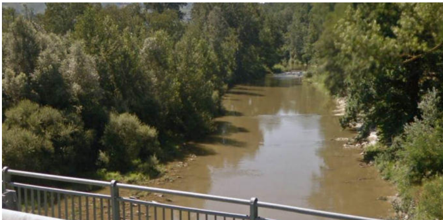
Alveo dal ponte della SP56a.
