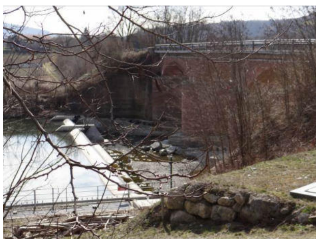
Traversa a monte del Ponte della SS30.
