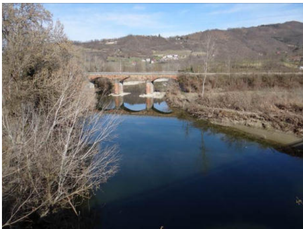
Ponte ferroviario a valle di Piani, nella parte iniziale del tratto.
