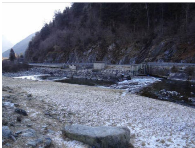
Traversa di derivazione della presa di Località Frailino.
