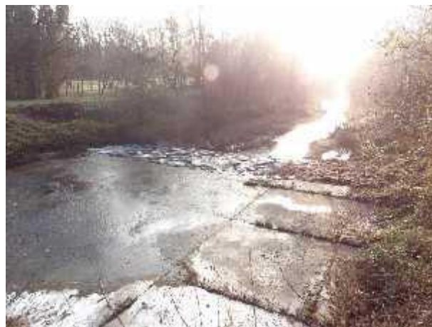
Soglia a valle del ponte
