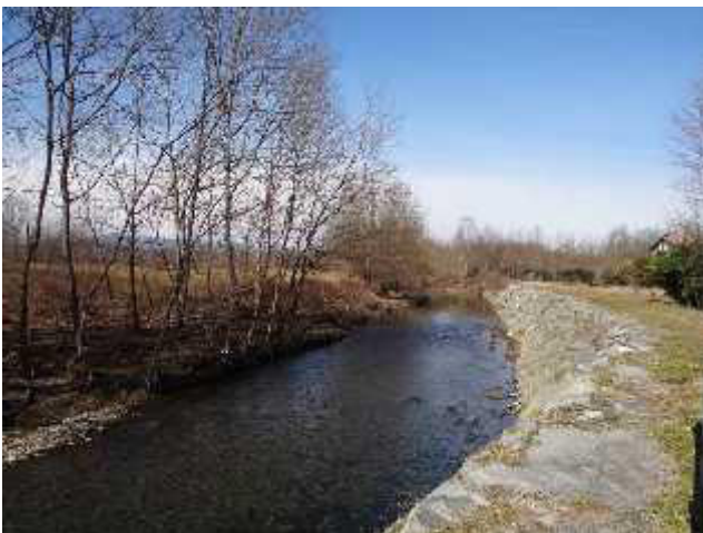
Difese spondali in sinistra nei pressi di San Martino.
