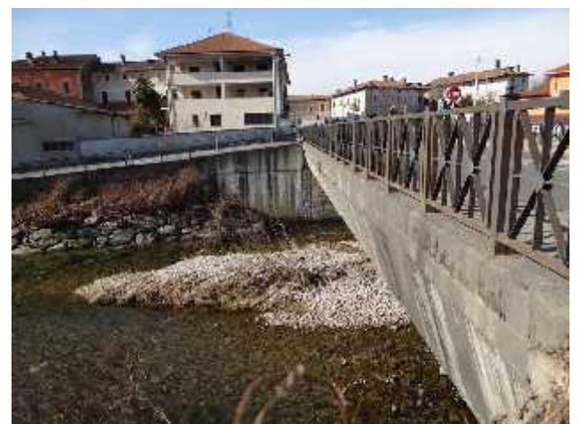
Ponte sul corso d'acqua a Fontaneto d'Agogna.
