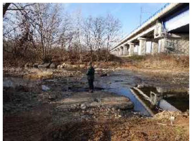
Guado e difese spondali a valle del ponte autostradale
