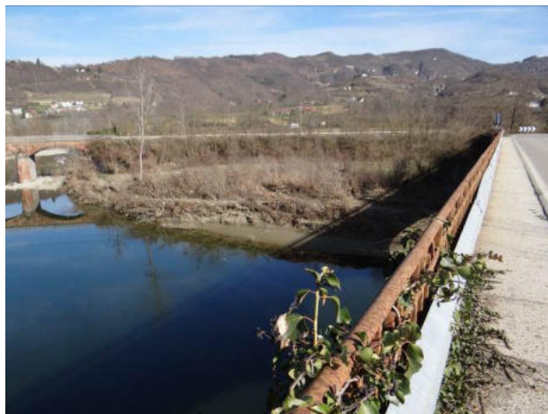
Ponte della SP221 poco a monte del ponte ferroviario a valle di Piani
