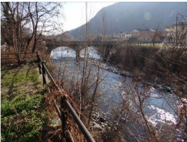
Ponte di Via Roma
