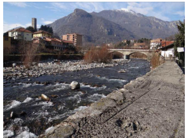
Sponda sinistra con argine a valle del Ponte di Via Roma
