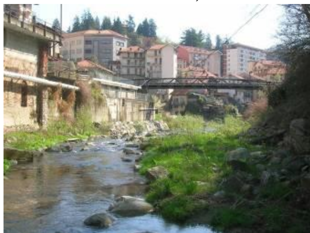
Muri in sponda sinistra - fabbricato Botto Luigi
