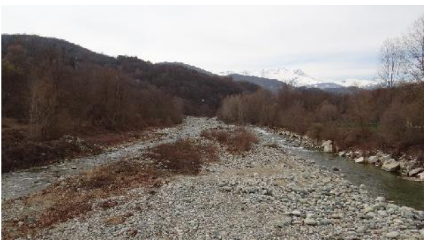
Particolare alveo e difese spondali in sponda sinistra.
