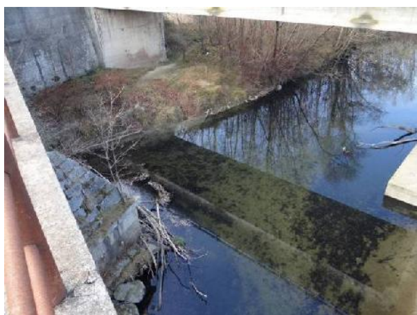
Particolare del fondo alveo.
