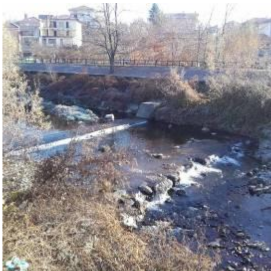
Soglia e argine in sinistra idrografica
