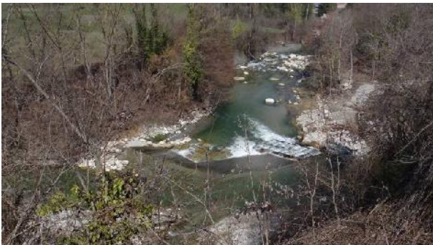
Traversa all'estremità a monte del tratto
