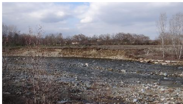
Particolare erosione spondale (evento 11/2016).
