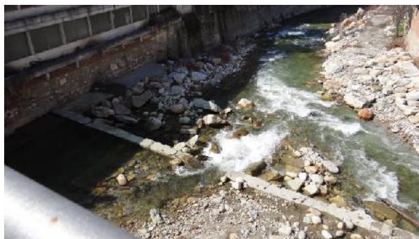
Soglia a valle del ponte di via Perotti
