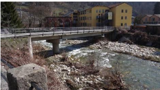
Ponte di Via Curazza
