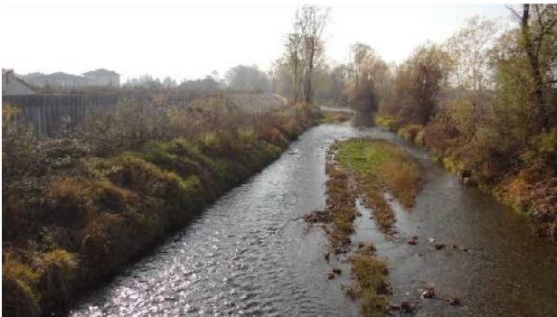
Argine in sponda destra a Centallo. Vista verso monte dal ponte della SP169
