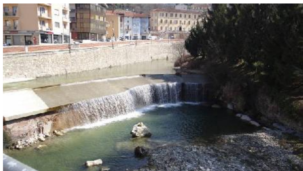
Traversa di derivazione all'inizio del tratto
