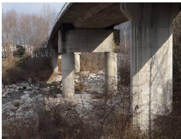
Il nuovo viadotto dell SS 229.
