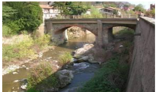
Ponte via Francesco Cesone (Studio Mello Rella & Associati)
