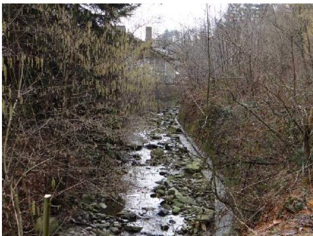
Muro di contenimento in sponda sinistra presso la fabbrica Global Service.
