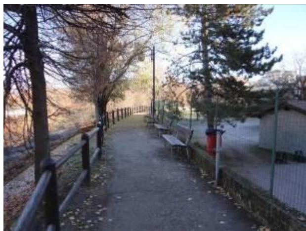
Argine in sponda sinistra a monte ponte via Mazzini
