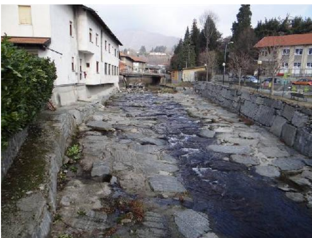
Tratto di alveo canalizzato anche al fondo.
