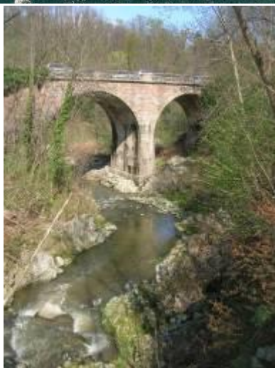
Ponte SS Cossato Vallemosso (Studio Mello Rella & Associati)
