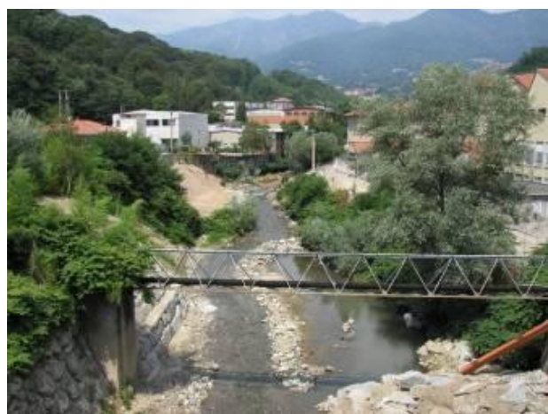
Lavori di ricostruzione difese spondali
