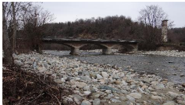
Particolare alveo e ponte interferente.
