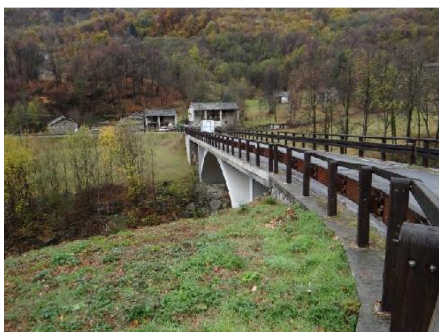
Il ponte Prella.
