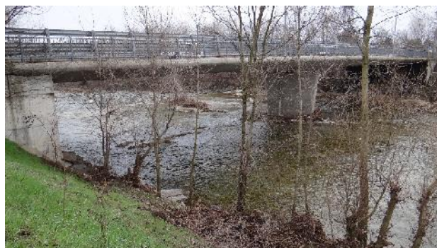
Particolare alveo e ponte interferente.
