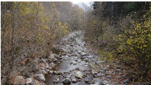
Dettaglio alveo e sedimenti.
