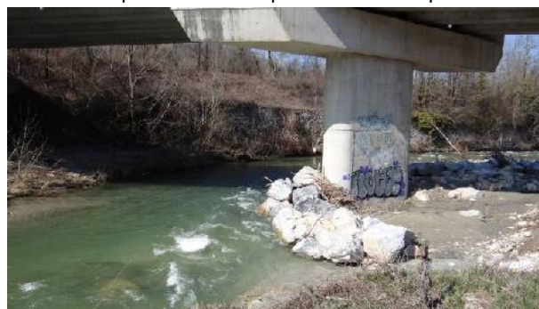
Pilone del ponte di Strada Gavazza Picchi protetto con una barriera in massi da fenomeni di scalzamento.
