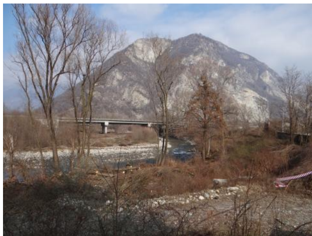
Il ponte dell'autostrada A 26 vista da monte.
