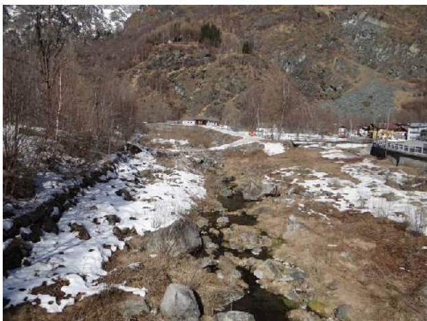
Difese spondali in destra e sinistra e guado in secondo piano
