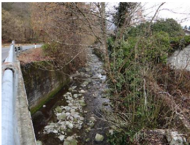
Difesa spondale nei pressi del ponte di via Pella.
