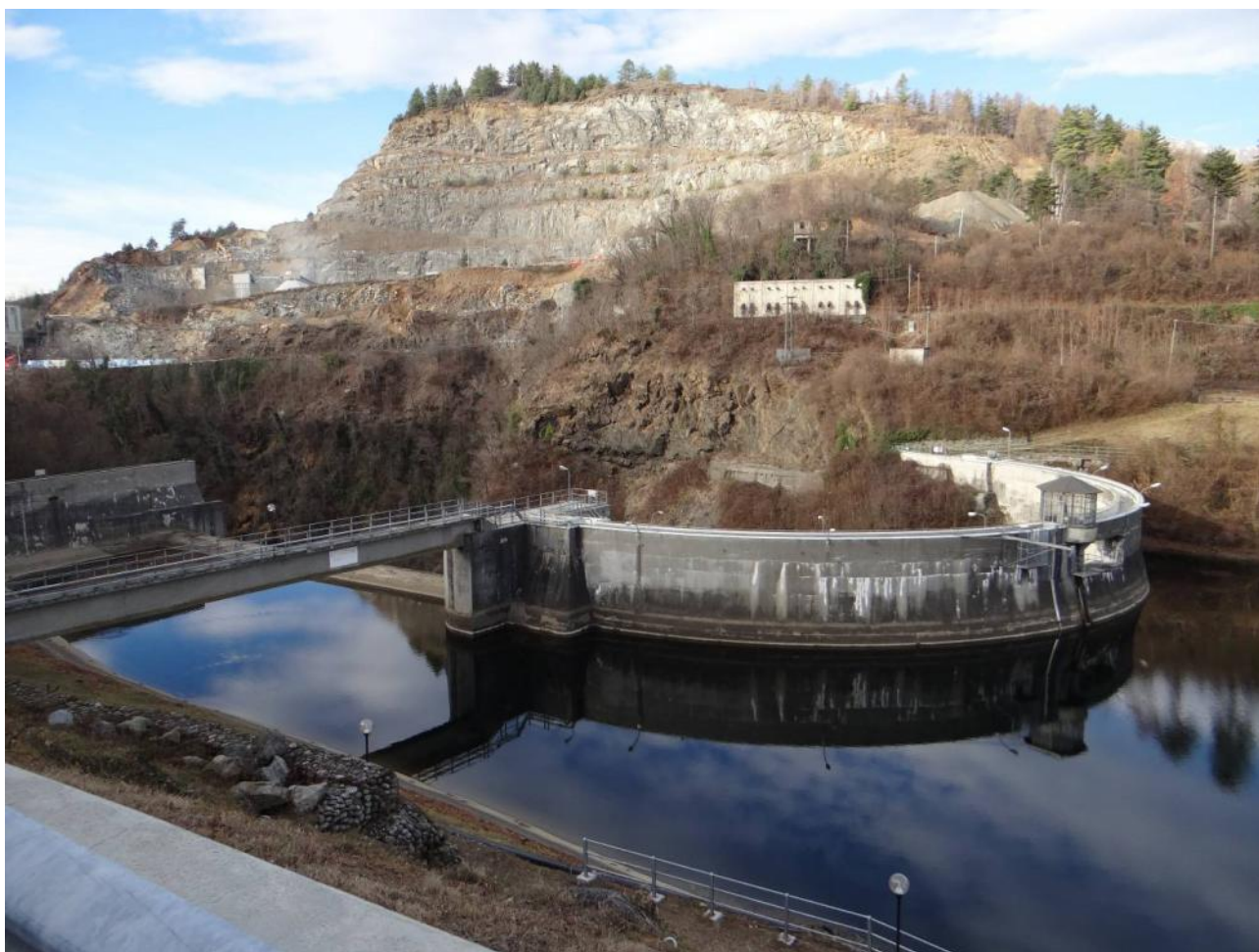
Coronamento della diga Gurzia.
