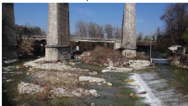
Traversa, piloni della linea ferroviaria e ponte di Via Primo Silvestrini. Vista da Piazzale Ravanet
