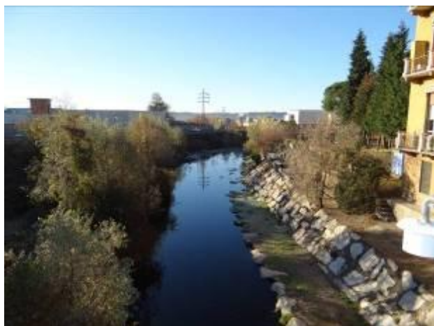
Difesa spondale in destra a valle ponte via Mazzini
