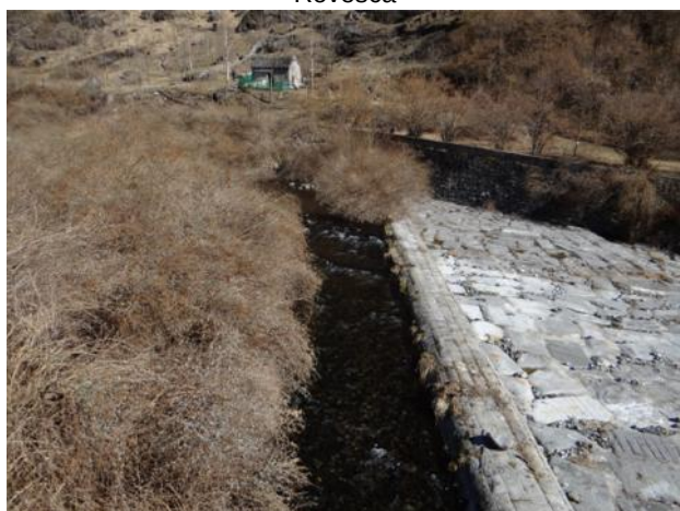
Canalizzazione del fondo alveo nei pressi della centrale di Rovesca
