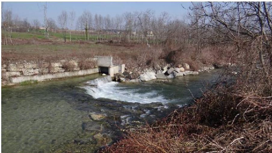
Traversa di derivazione all'inizio del tratto
