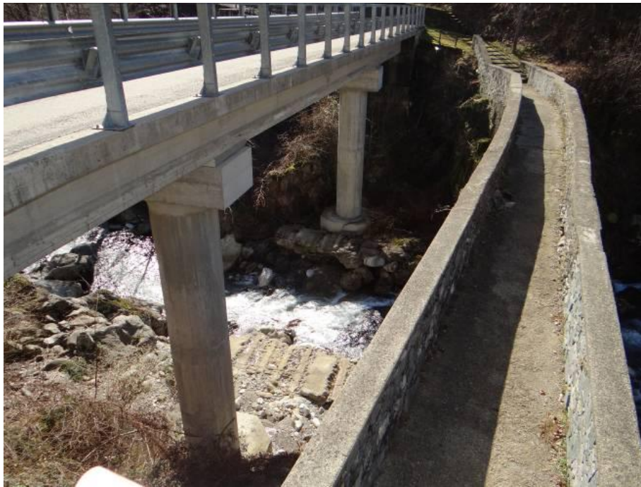
Ponte e passerella per Fornero. Il ponte presenta la soglia a protezione delle pile quasi completamente erosa
