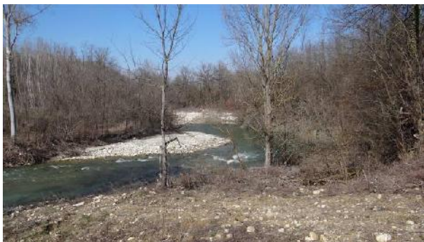
Traversa all'estremità a monte del tratto
