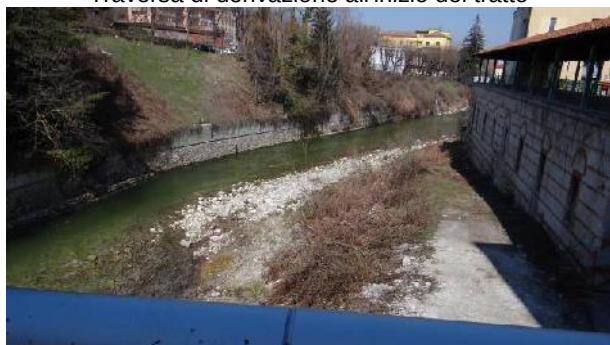
Muri di difesa in sponda sinistra e destra
