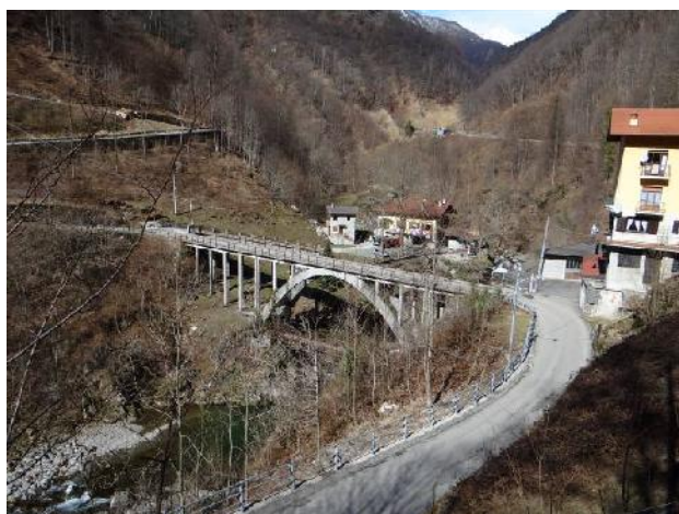
Il ponte per frazione Sanbughetto.
