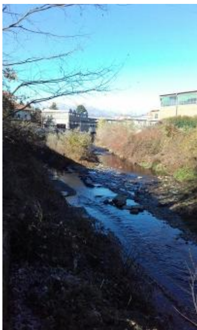
Alveo a valle stabilimento Gaudino
