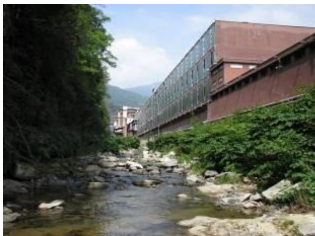
Muri in sponda sinistra - fabbricato Botto Luigi
