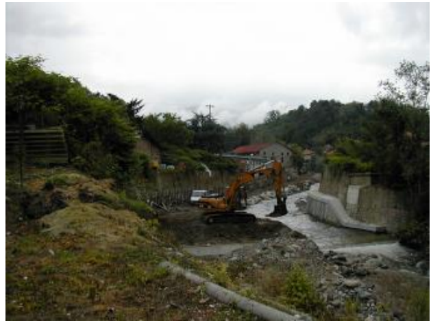
Lavori di ricostruzione soglia a valle ponte in fraz. Campore
