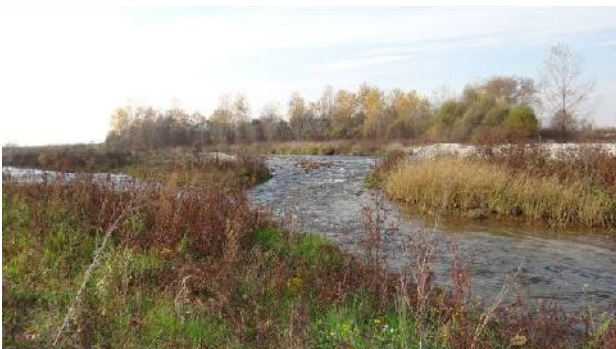
Alveo localmente più ampio e piana inondabile presso C. Pedugio, Loc. Mellea. Le sponde in questa breve porzione del tratto sono state sottoposte a risagomatura e alla realizzazione di opere di protezione.
