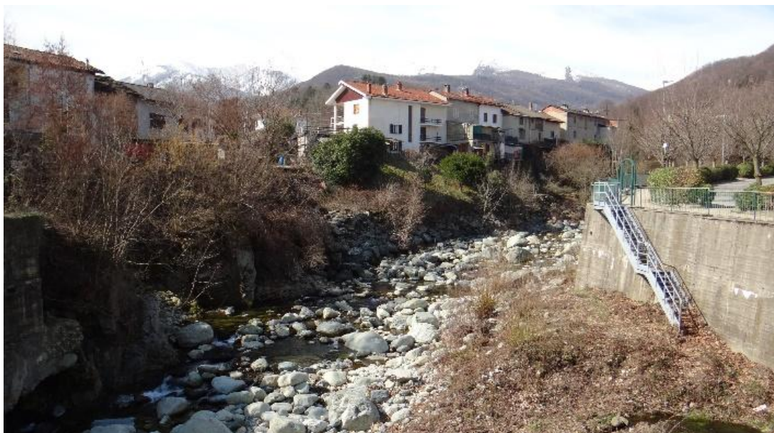
Particolare alveo e difese spondali.
