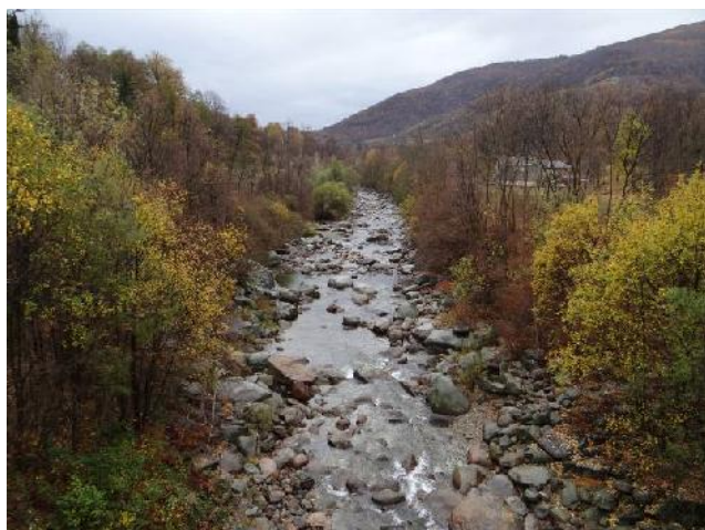
L'alveo a valle dell'opera.
