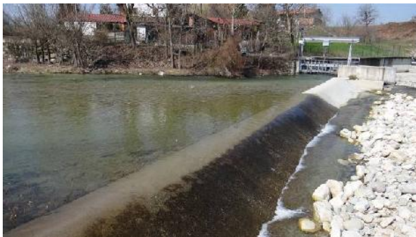
Traversa di derivazione all'inizio del tratto.
