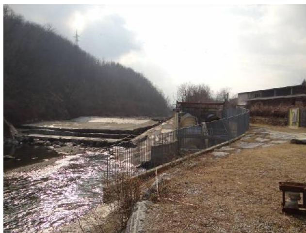
La traversa di derivazione ad uso idroelettrico passante al limite tra il tratto 2 e 3.
