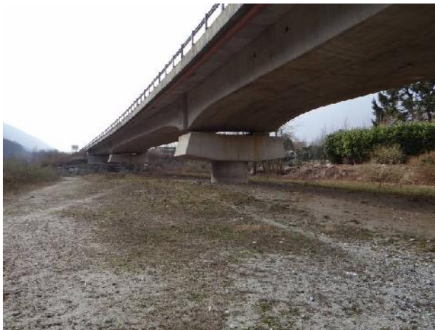
La strada statale 229 ne tratto.
