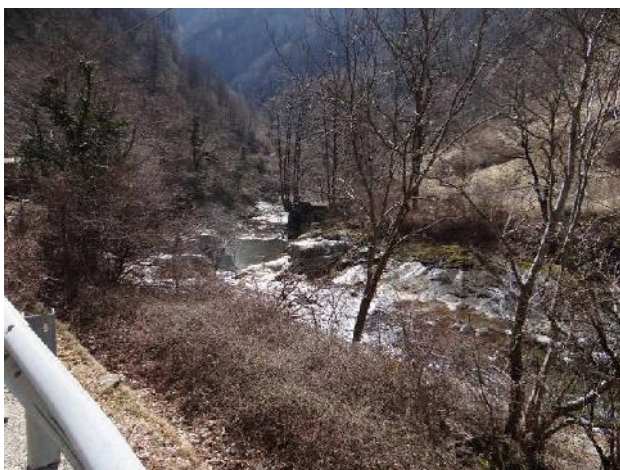
Alveo scavato in roccia.
