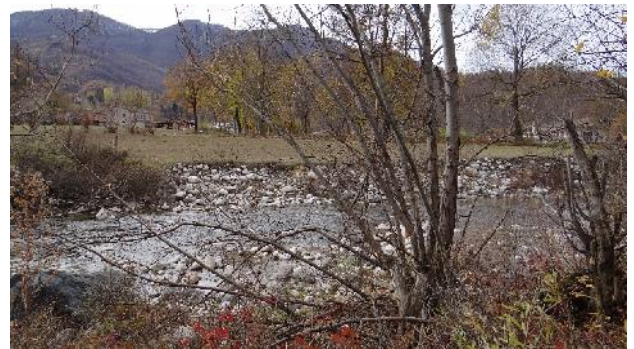
Dettaglio erosione in sponda sinistra.
