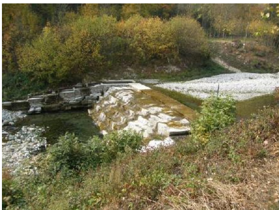
Traversa di derivazione a Pradleves.
