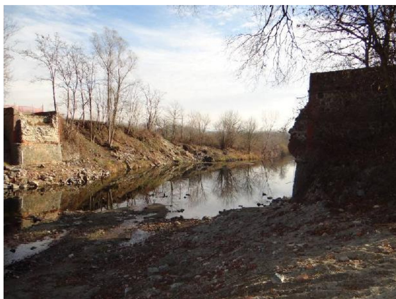
Spalle del vecchio ponte di via Maioletto.
