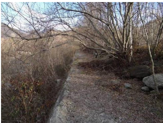
Argine in sponda sinistra.
