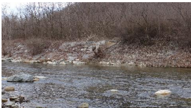
Particolare alveo e difese in sponda destra.
