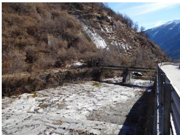
Canalizzazione del fondo alveo nei pressi della centrale di Rovesca
