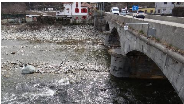
Particolare alveo e ponte interferente.
