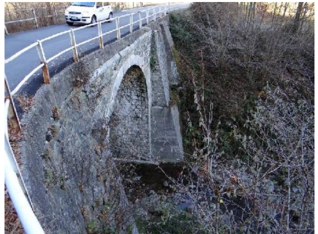
Ponte della SP 106 in fraz. Molino
