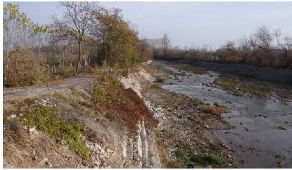
Difese spondali e sponda ricostruita in corrispondenza del ponte della SP25 a San Benigno.
