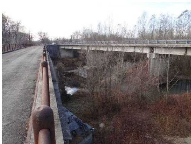
Le pile del ponte della SP 77.
