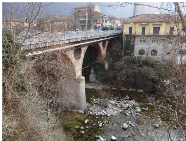
Ponte di via Ernesto de Angeli.
