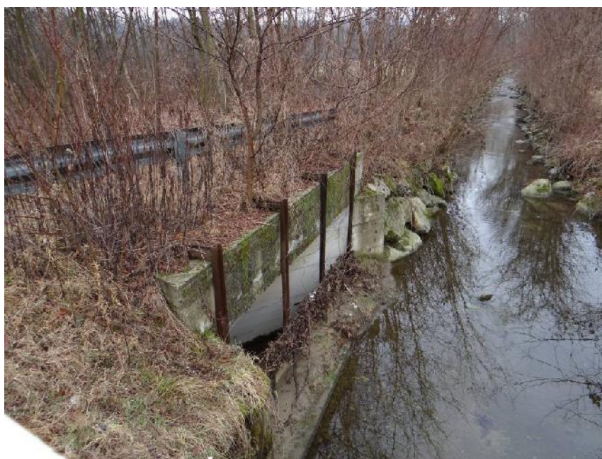
Il canale scolmatore a monte del ponte.
