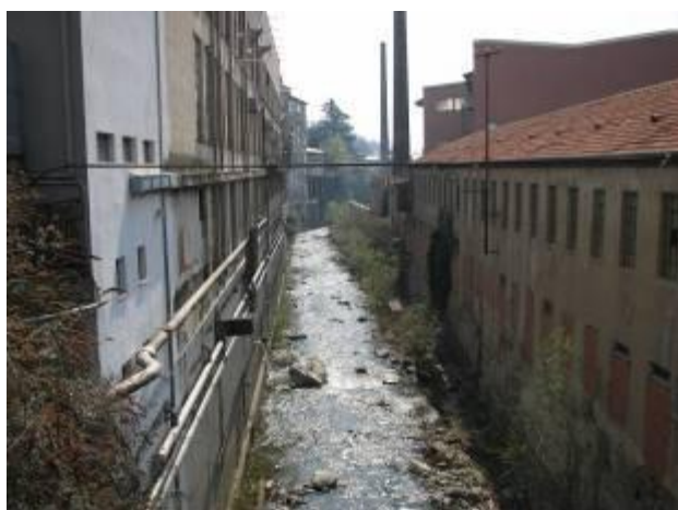
Sezione di deflusso del t. Strona ridotta dalla presenza dei fabbricati industriali
