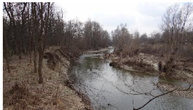
Particolare erosione spondale (evento 11/2016).
