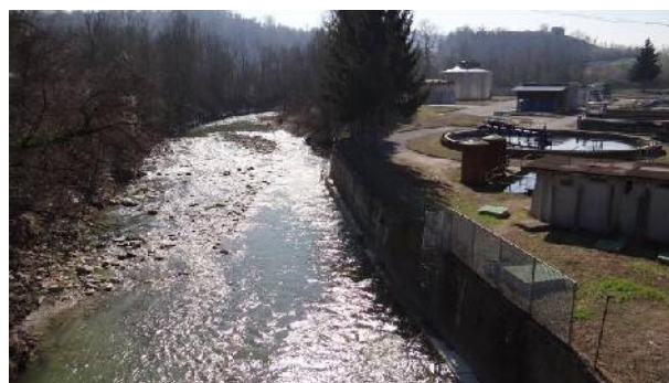
Difese spondali in corrispondenza del depuratore
