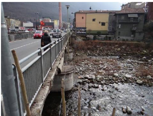
Ponte di via Fratelli di Dio.
