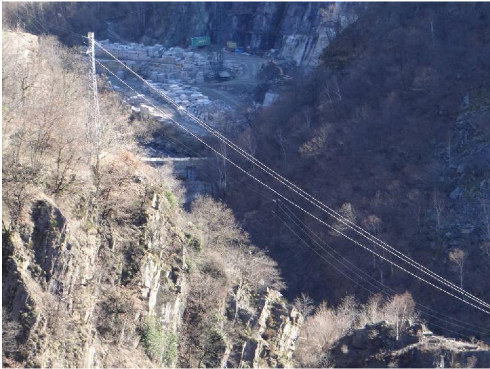
Briglia filtrante sull'Ovesca a monte della cava
