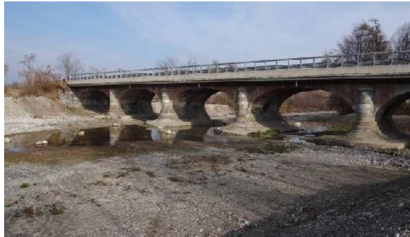
Ponte della Strada Regionale dei Laghi di Avigliana. Visibili i lavori di rimodellamento di sponde e fondo alveo
