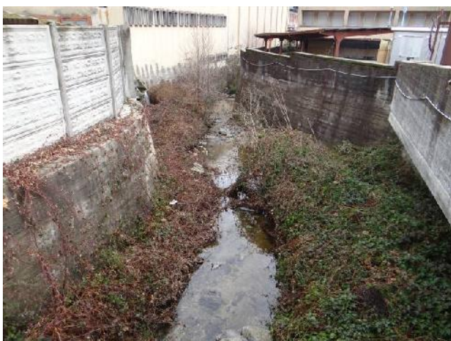
Alveo completamente regimato nei pressi del ponte di Viale Cimitero.
