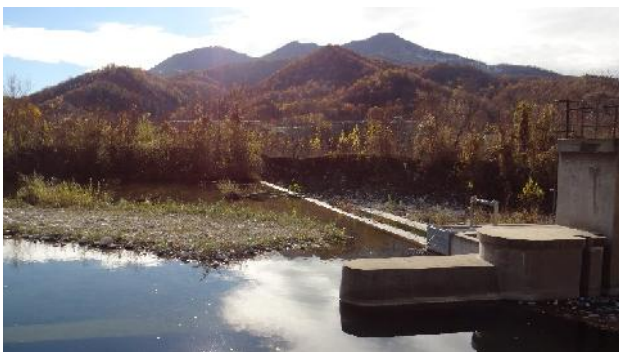
Dettaglio opera di presa Italgen..
