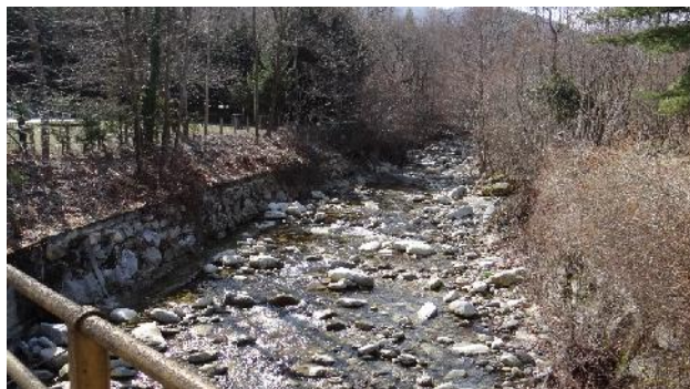
Dettaglio difese spondali
