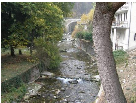
Difese spondali e serie di soglie nella parte a valle dell'abitato di Pradleves.
