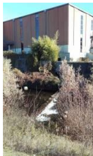
Soglia e difesa spondale nei pressi mercato coperto di Cossato
