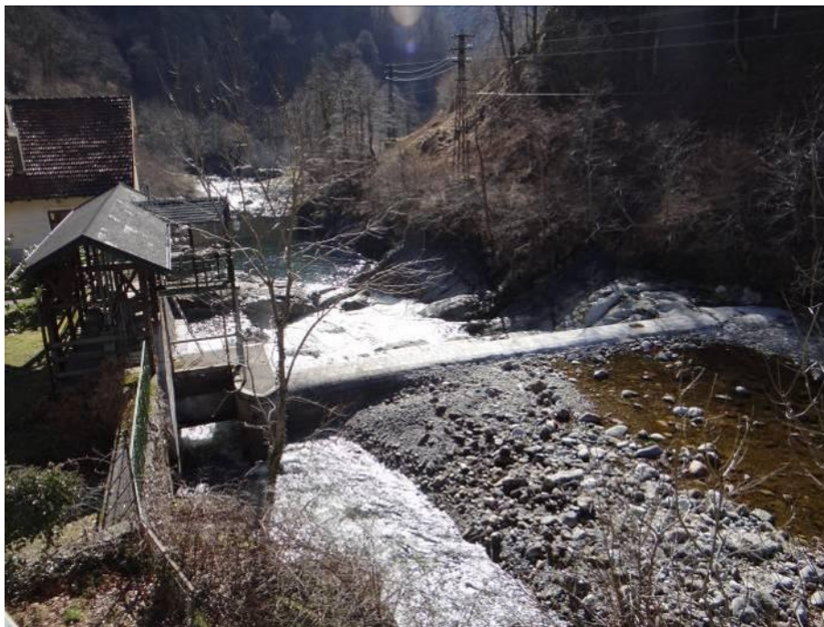
La traversa colmata di Strona
