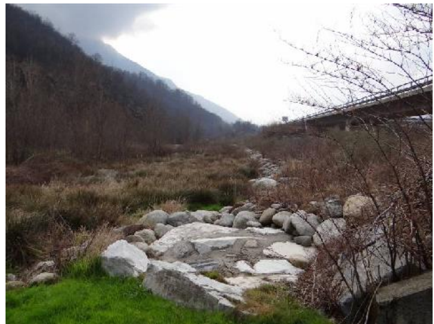
Opere di difesa alla struttura.
