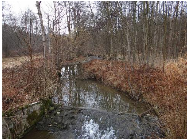
Soglia a monte del ponte della SP 44.
