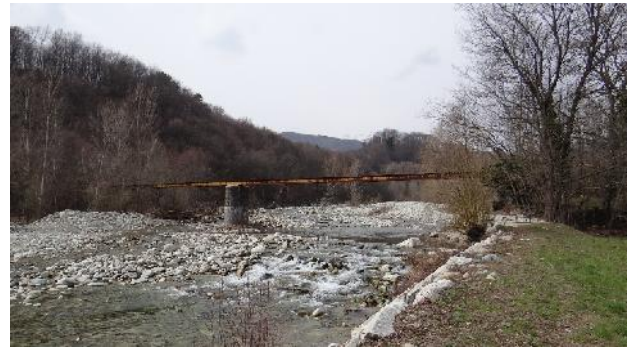
Infrastruttura di servizio interferente.
