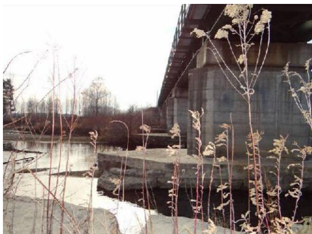
Ponte ferroviario della linea Ivrea -Torino.
