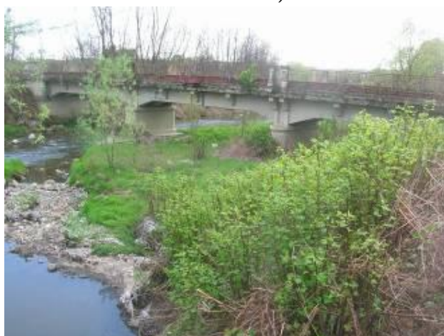
Ponte ferroviario BI-NO a Cossato (Studio Mello Rella & Associati)
