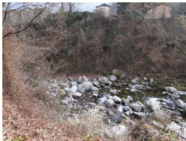
Letto del fiume alla fine del tratto.
