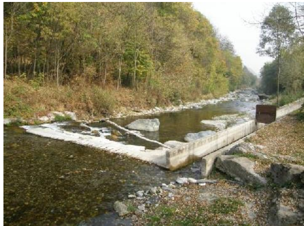
Traversa di derivazione a valle di Monterosso.
