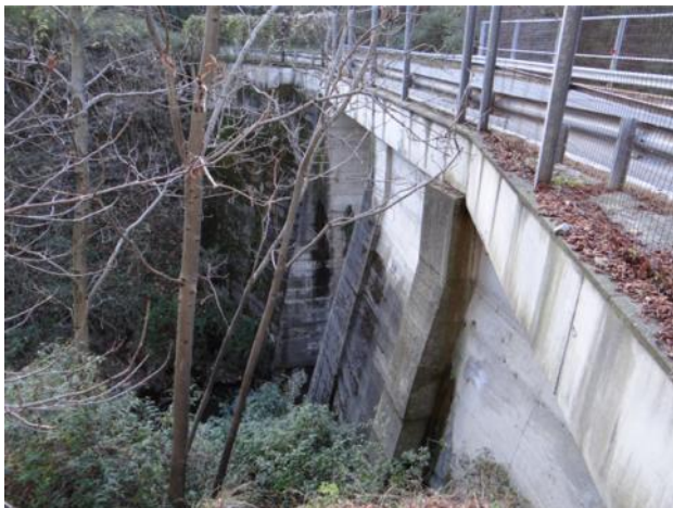
Ponte della SP 105
