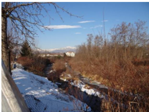
Muri in sponda sinistra - fabbricato Botto Luigi
