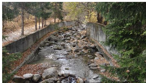
Dettaglio alveo e difese spondali.
