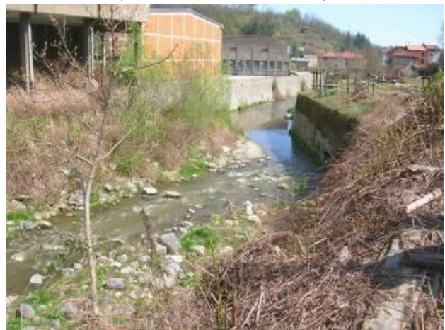
Alveo confinato tra i muri fabbricato industriale ex Albino Botto (Studio Mello Rella & Associati)
