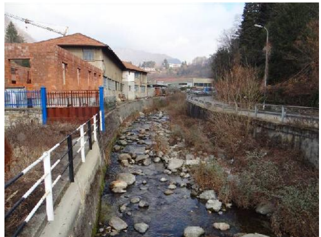
Muri di difesa in calcestruzzo.
