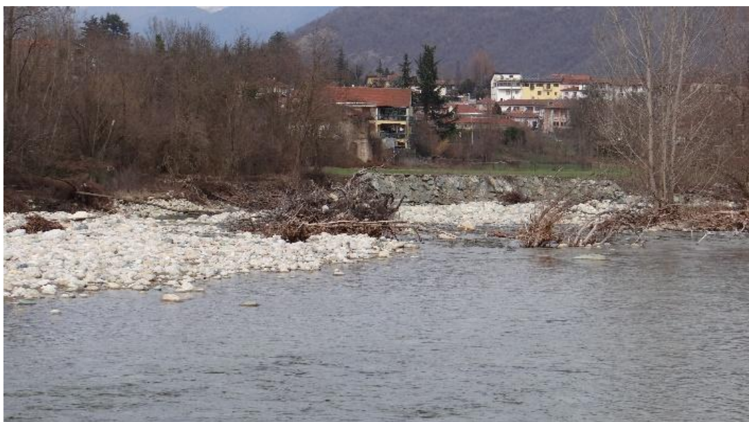
Dettaglio alveo e vegetazione.
