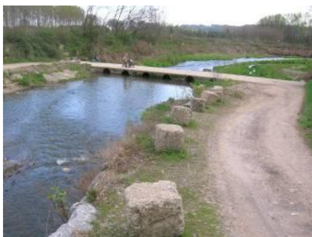
Guado strada vicinale Vandala a Cossato (Studio Mello Rella & Associati)
