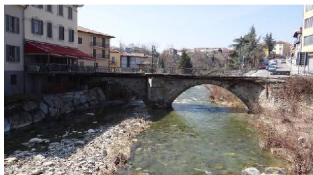
Ponte di Via S. Oderda
