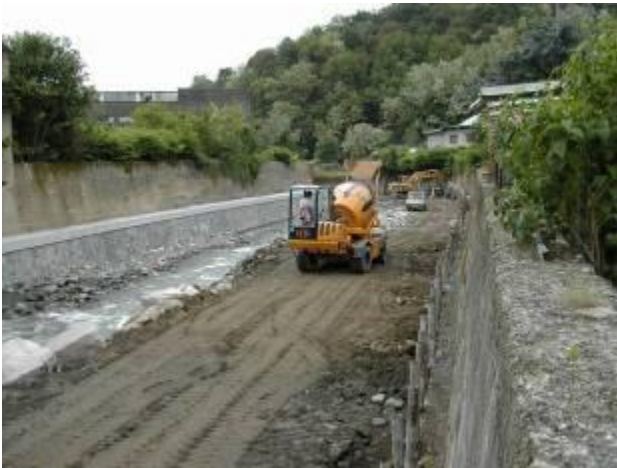
Difese spondali a valle ponte in frazione Campore
