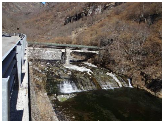
Traversa di derivazione di Rovesca e ponte per la condotta forzata interferente col corridoio fluviale
