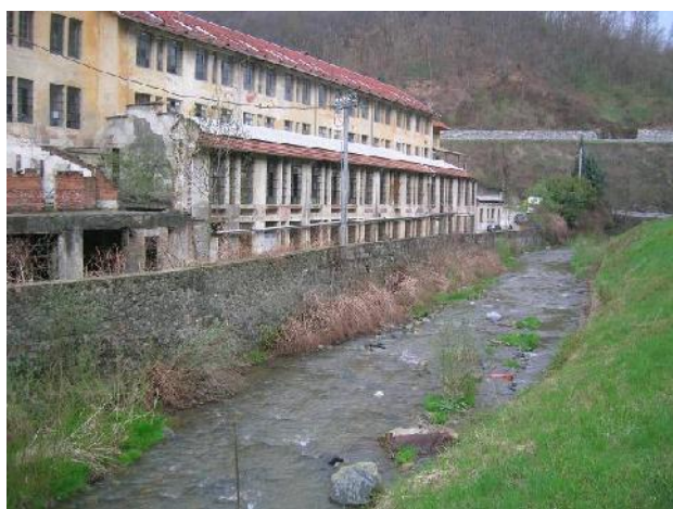
Difese spondali e muro arginale ex lanificio Picco
