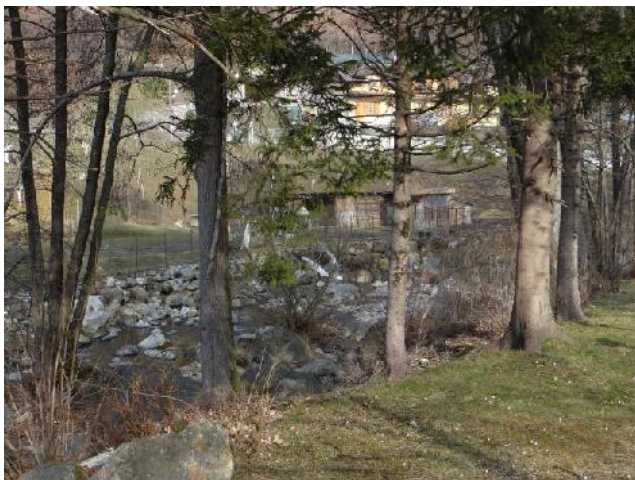
Difese spondali sul torrente.
