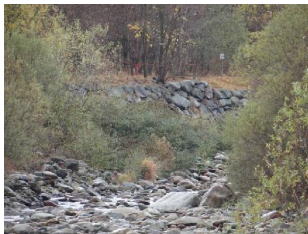
Difese spondali in loc. Novareglia.
