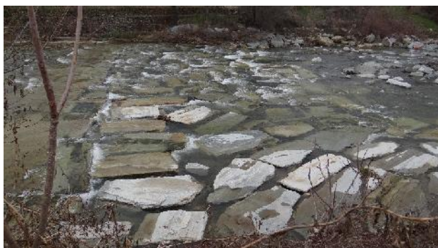
Particolare lastricatura fondo.
