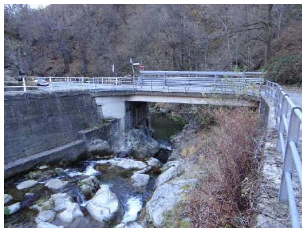
Ponte fraz. Picco (Rovella)
