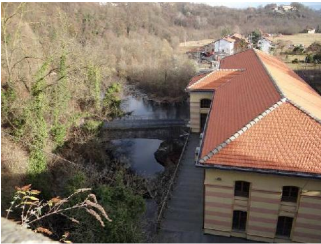
Parte iniziale del tratto.
