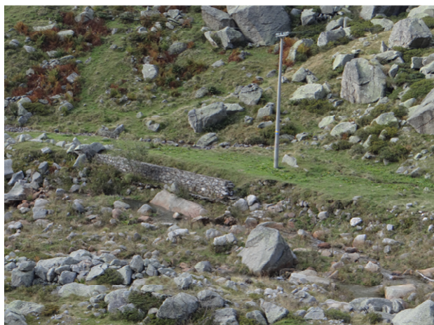
Difesa spondale in destra semidistrutta.
