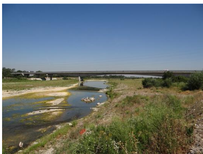
Il ponte della Tangenziale di Tortona.
