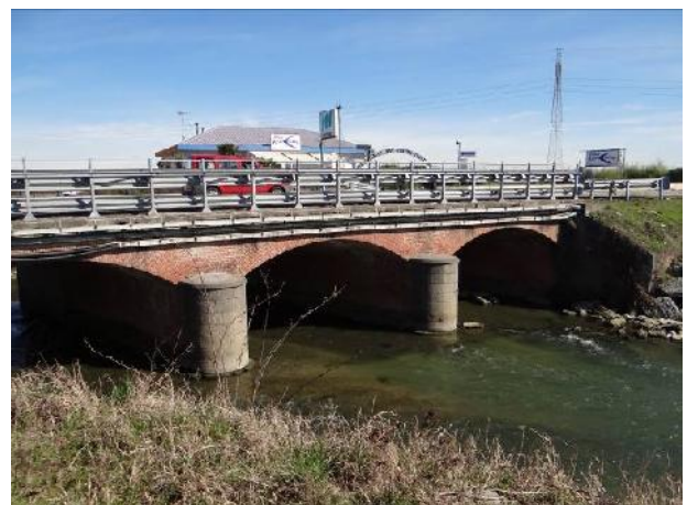
Il ponte di Corso Milano.
