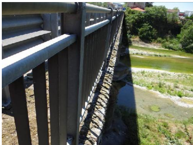
Ponte Ponte SS 35 per Cassano Spinola
