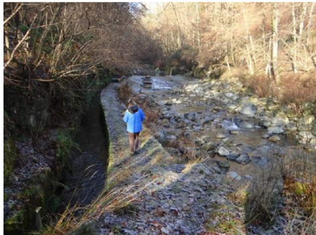
Canale di derivazione della Roggia del Piano
