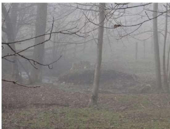
Erosione spondale nei pressi di Via Cervino.
