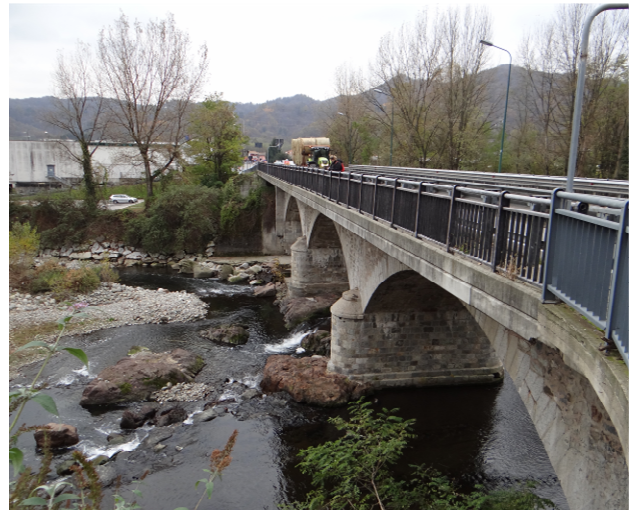
Ponte SP299 a Bornate con affioramento del substrato roccioso
