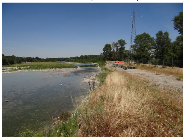
Sponda destra erosa
