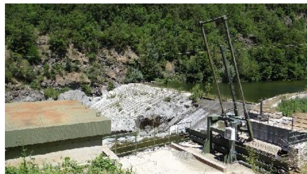
Traversa per prelievo idroelettrico.
