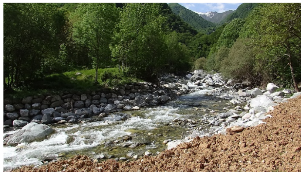
Difese spondali in sponda destra.
