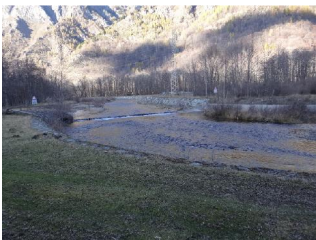
Soglia a monte della traversa di Piazzette
