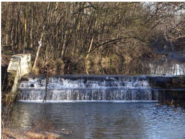
Traversa di derivazione in comune di Momo.
