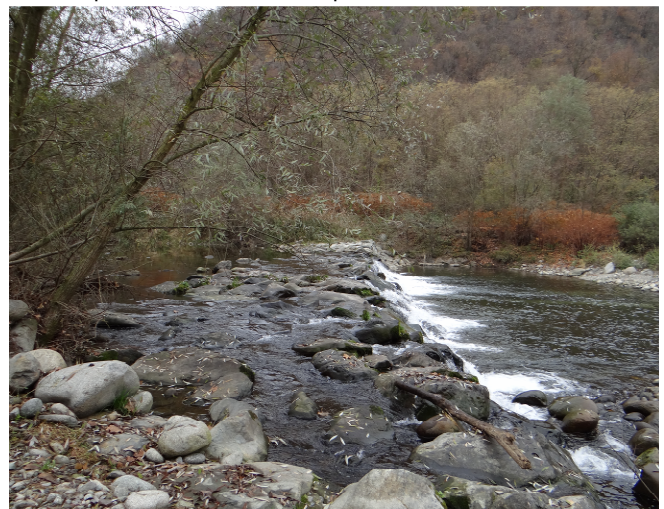
Soglia che produce parziale intercettazione dei sedimenti
