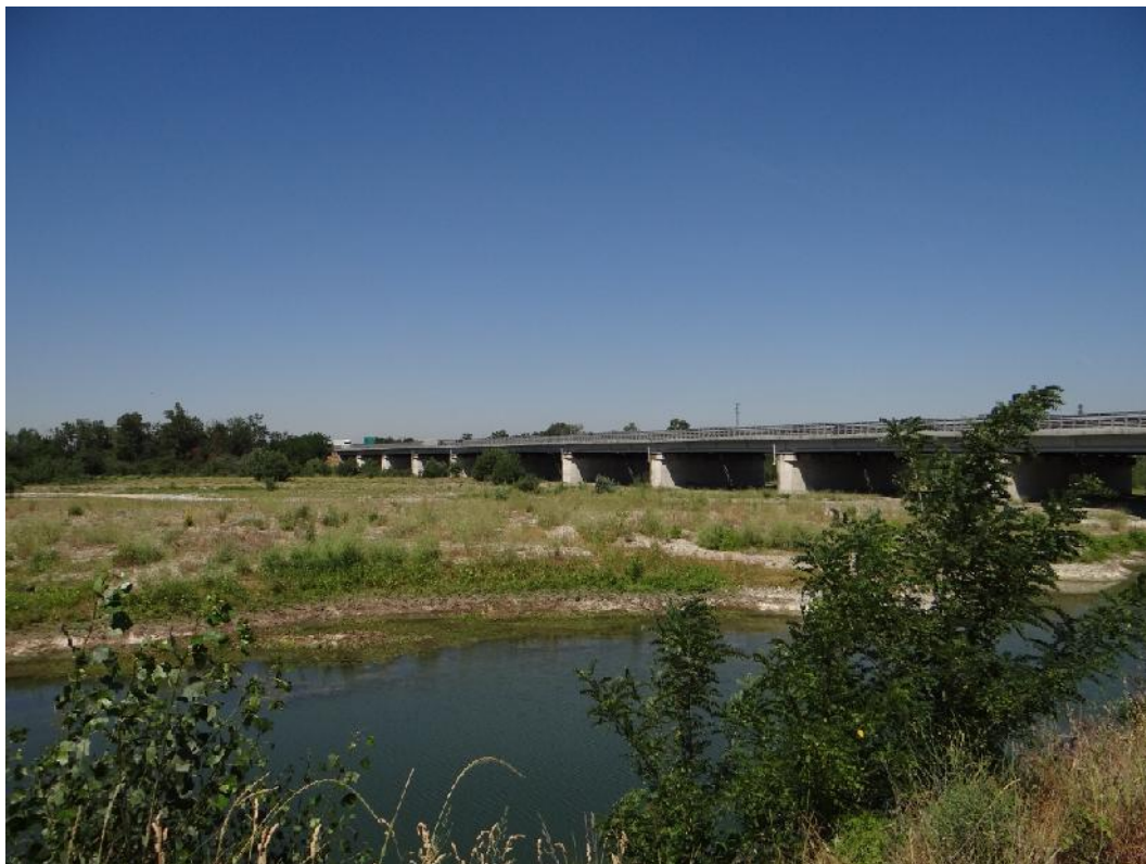
Il viadotto dell'autostrada A21 visto da monte.
