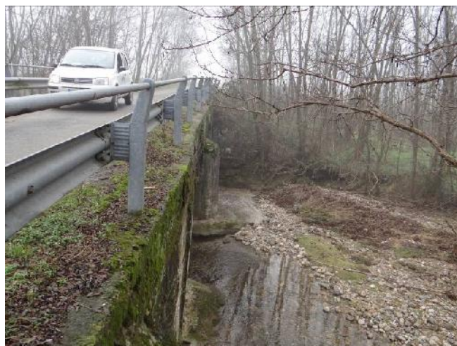
Attraversamento da Vaprio a Mezzomerico.
