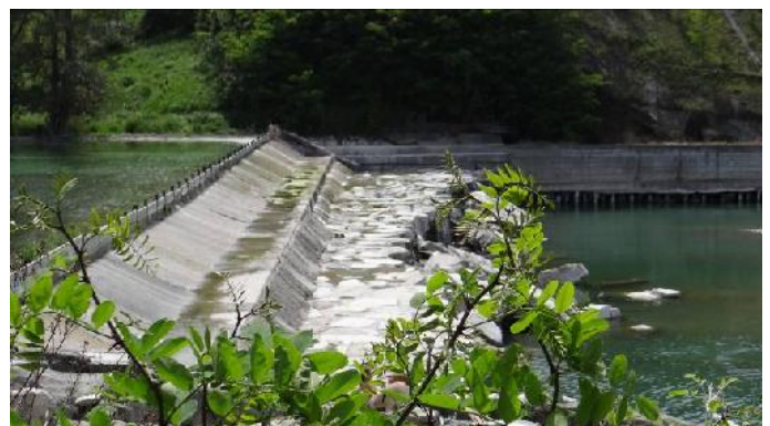
La traversa colmata di Varinella
