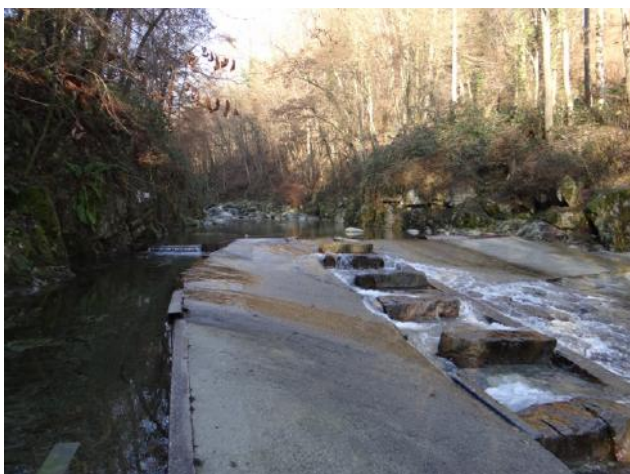
Traversa di derivazione con scala di risalita per pesci
