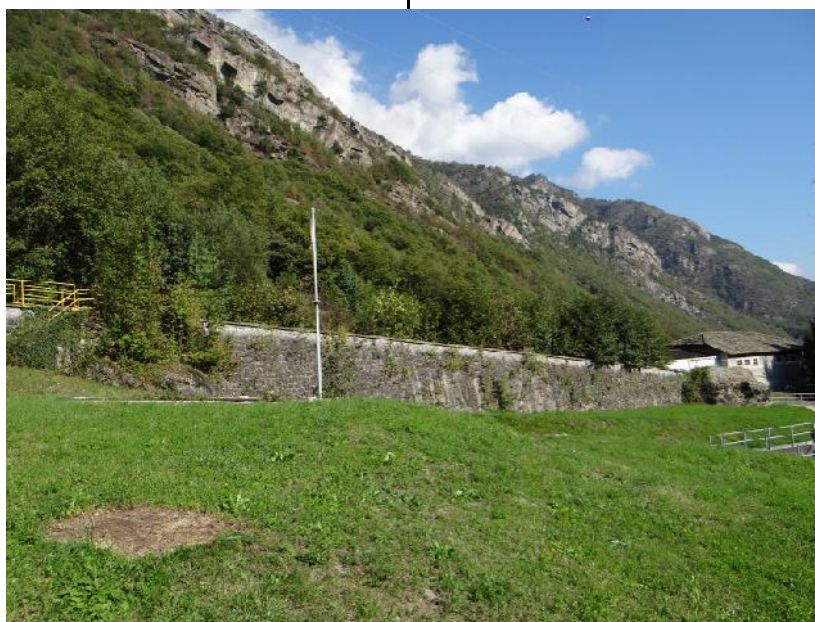
Argine in muratura in apice di conoide.
