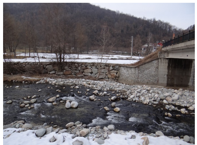
Particolare di un attraversamento stradale.
