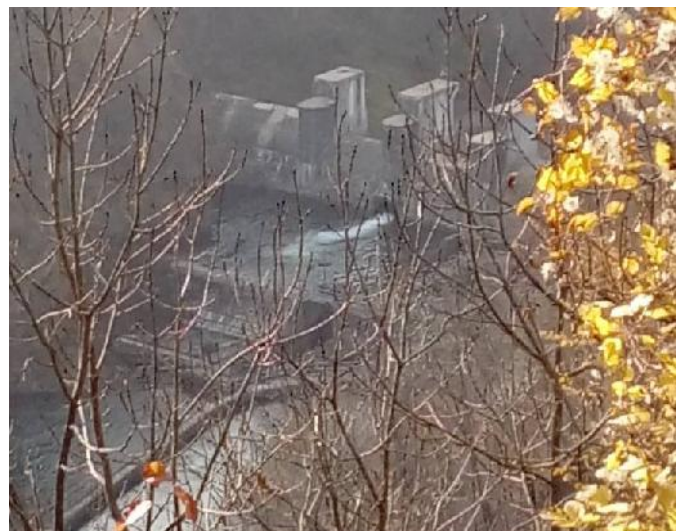
Traversa di Porte
