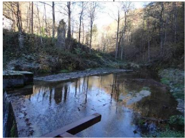
Parte posteriore dell'opera colmata.
