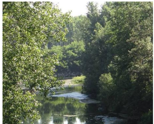
Difese spondali in massi di cava a protezione della sponda concava di un'ansa.
