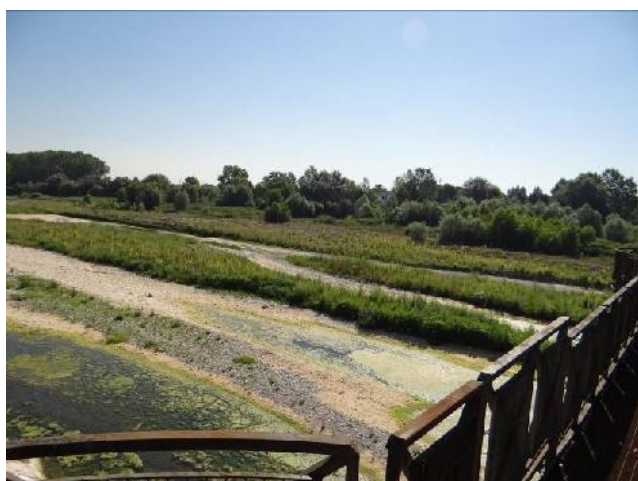
I canali che si aprono a valle del ponte.
