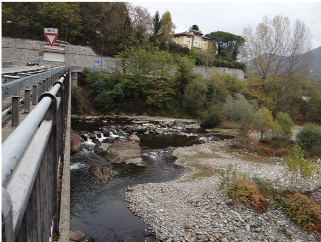
Soglia a valle del ponte SP299 a Bornate
