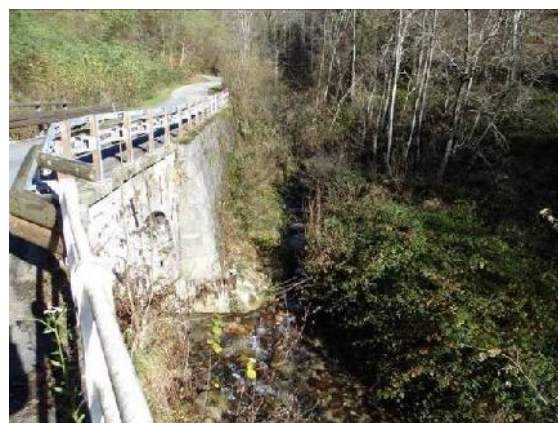
Ponte della strada SP 103.
