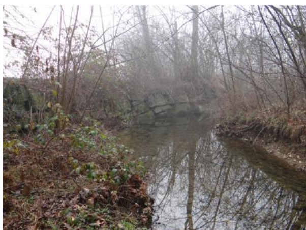
Difese spondali lungo Via Conturbia.
