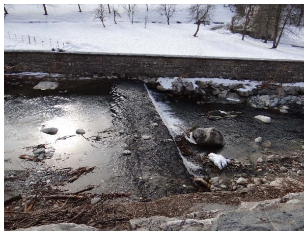
Particolare di un'opera trasversale.
