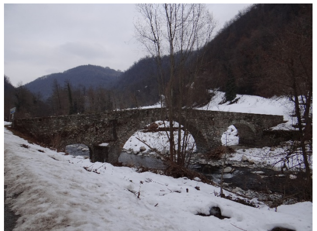
Ponte lungo l'asta.
