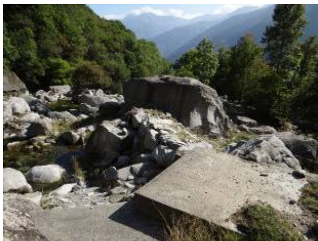
Tratto di argine a chiusura di un ramo laterale del torrente.
