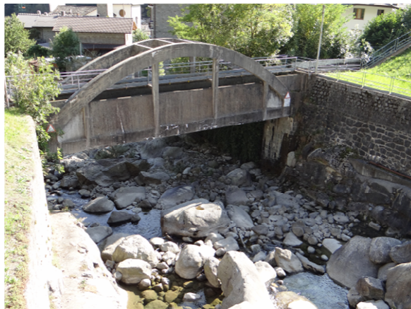
Ponte interferente con corridoio fluviale nella parte mediana del conoide.
