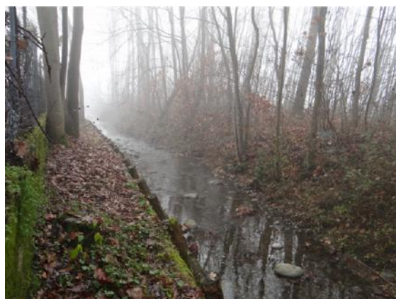
Difese spondali a Cordona.
