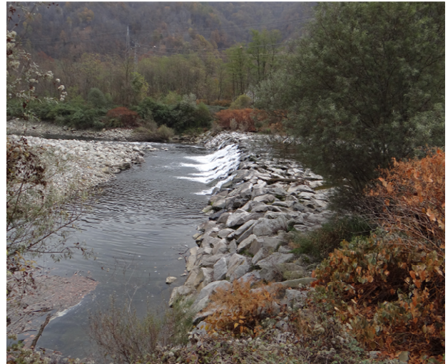
Traversa di derivazione non più attiva in località Guardella
