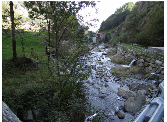
Difese spondali in destra e sinistra idr. a monte dell'abitato Loi.
