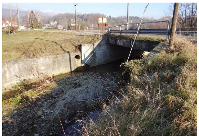
Attraversamento della SP 60 in corrispondenza di un'ansa protetta da muri a difesa delle sponde
