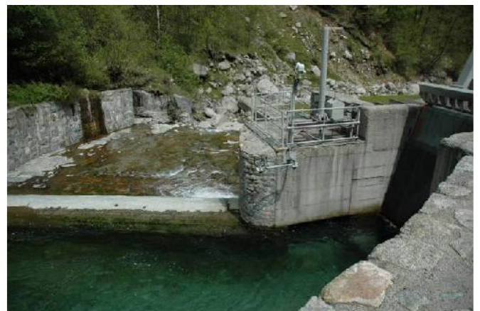
Difese spondali in destra e sinistra idr. a monte dell'abitato Loi.
