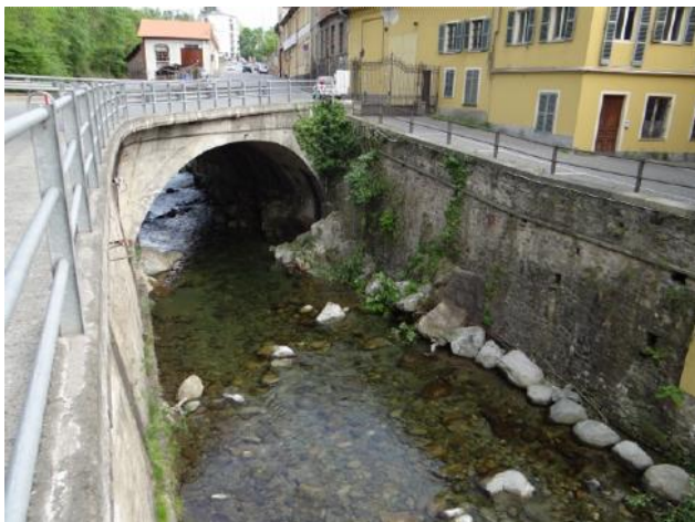
Ponte sul T.Oropa
