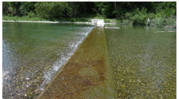
Soglia e fenomeno di corazzamento del fondo
