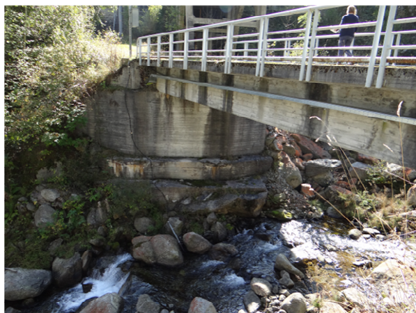
Pila del ponte sul Piantonetto in loc. S. Giacomo interferente col corridoio fluviale.
