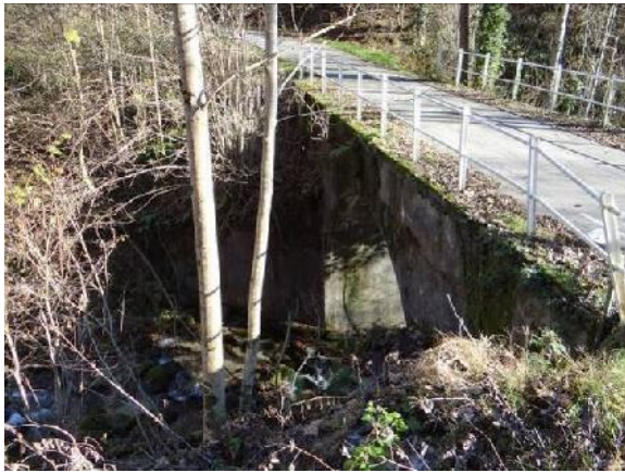
Il ponte per frazione Zagro.
