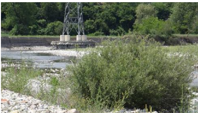
Traliccio con fondazione scalzata dall'intenso approfondimento
