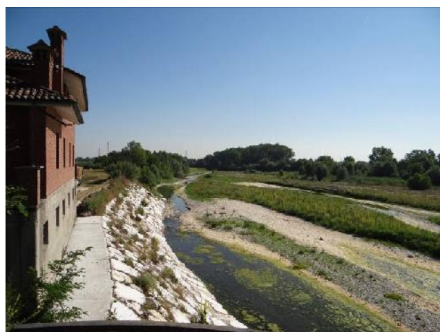
Particolare dell'argine in sponda sinistra.
