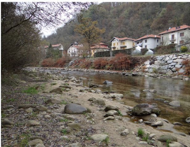
Difesa spondale in sinistra a valle del ponte Pianceri.
