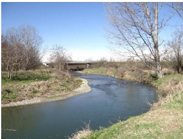
Traversa di derivazione in comune di Momo.
