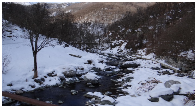
Difese spondali in sponda sinistra
