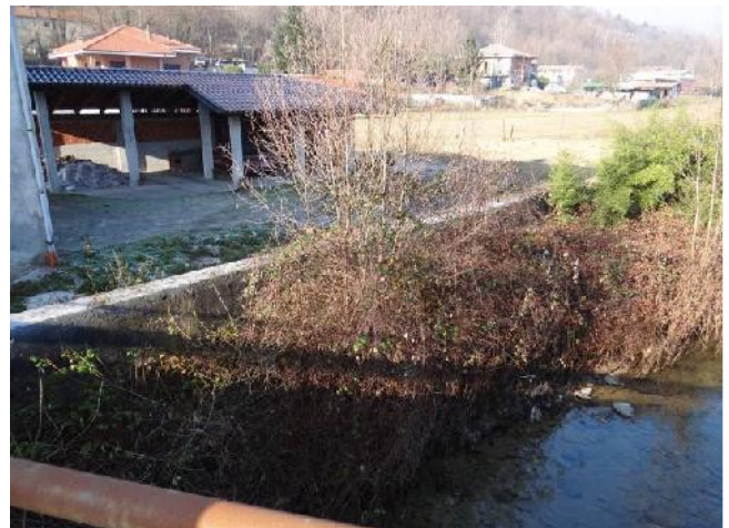
Muro arginale al ponte con Via Ivrea
