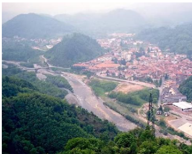
Vista panoramica inizio anni '90. - In sinistra idrografica è ben riconoscibile la difesa spondale, posta a valle del nuovo ponte, che chiude il ramo secondario del T. Sessera
