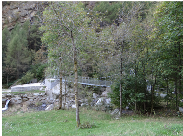
Passerella a monte di Loi.
