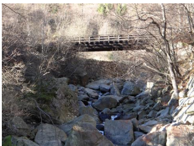
Difese spondali in destra e sinistra
