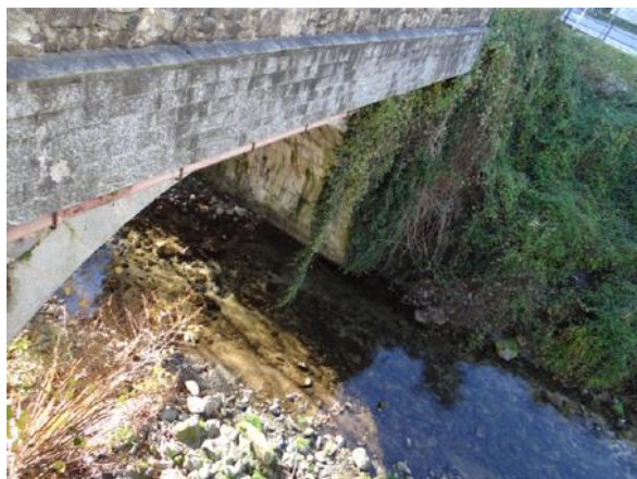
Il ponte della SP 76.
