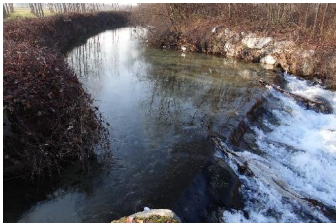
Traversa all'estremità a valle del tratto
