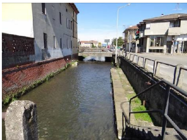
Alveo del torrente nell'abitato di Cerano.
