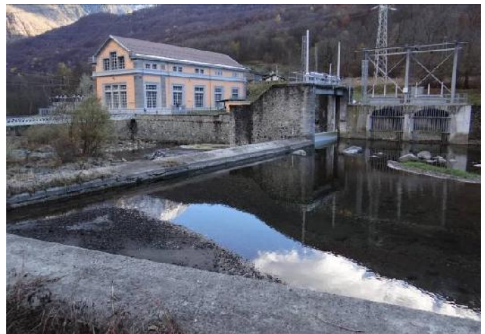
Traversa della centrale di Lemie
