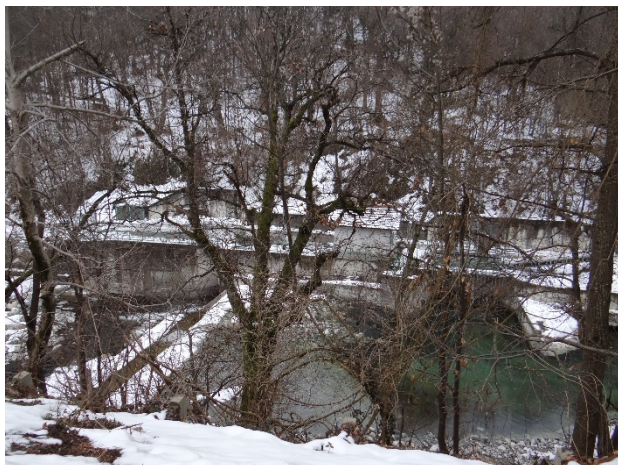
Impianto di derivazione idroelettrica.
