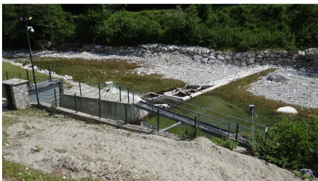
Impianto di derivazione idroelettrica.
