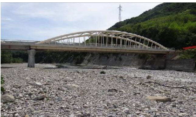
Il nuovo ponte per Vocemola
