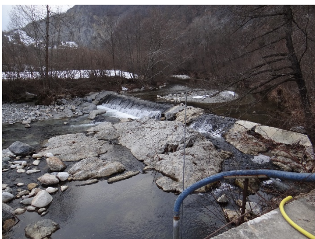
Traversa in corrispondenza di un prelievo.
