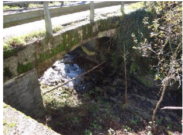
Dettaglio del ponte poco più a valle.
