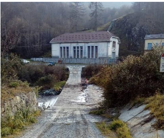
Guado di accesso alla centrale di Porte
