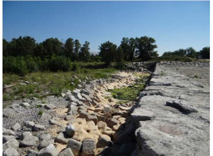
Erosione alla base della soglia.
