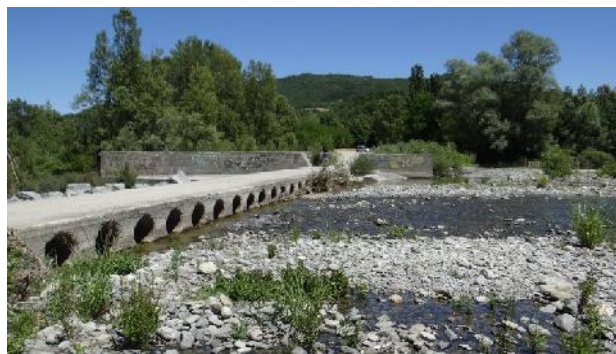
Opera trasversale (guado-traversa) .
