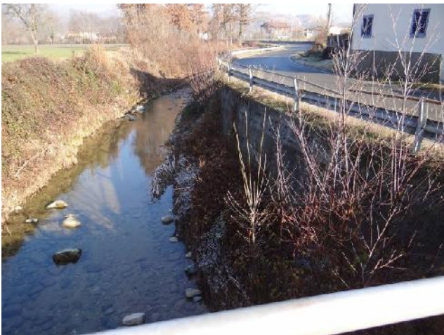
Muro di calcestruzzo a Preparetto
