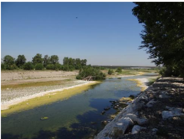
Alveo a monte dell'autostrada A21.
