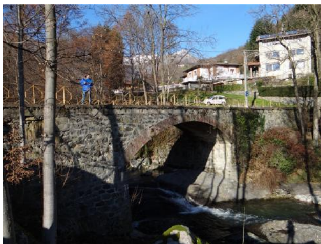
Ponte in loc. Valle , Pralungo
