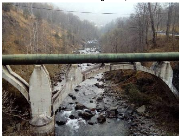
Ponte per condotta forzata con pila in alveo Ponte Barolo
