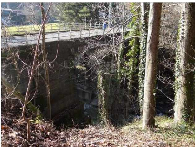
Ponte sul T.Oropa della Str. di Pralungo
