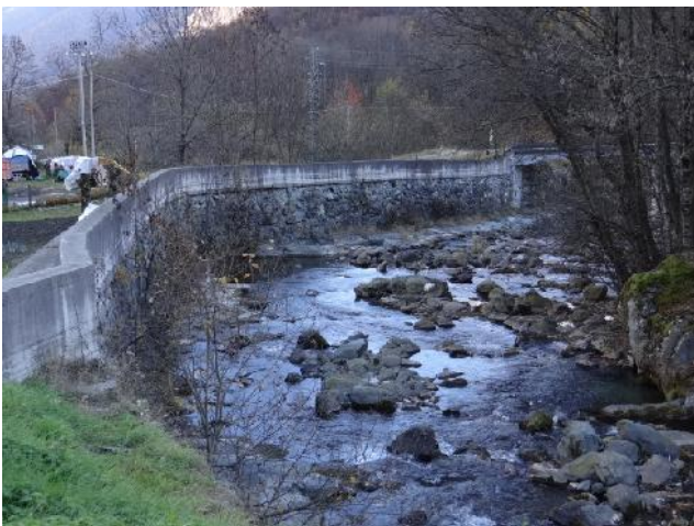
Muro arginale a protezione di Chiandusseglio
