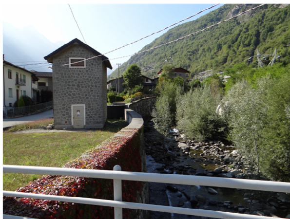
Argine in sponda idr. destra nella parte distale del conoide.
