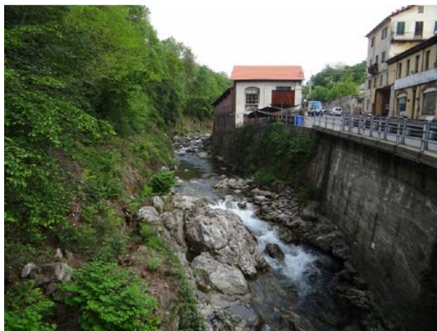
Alveo a monte del ponte
