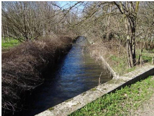
Traversa di derivazione in comune di Momo.
