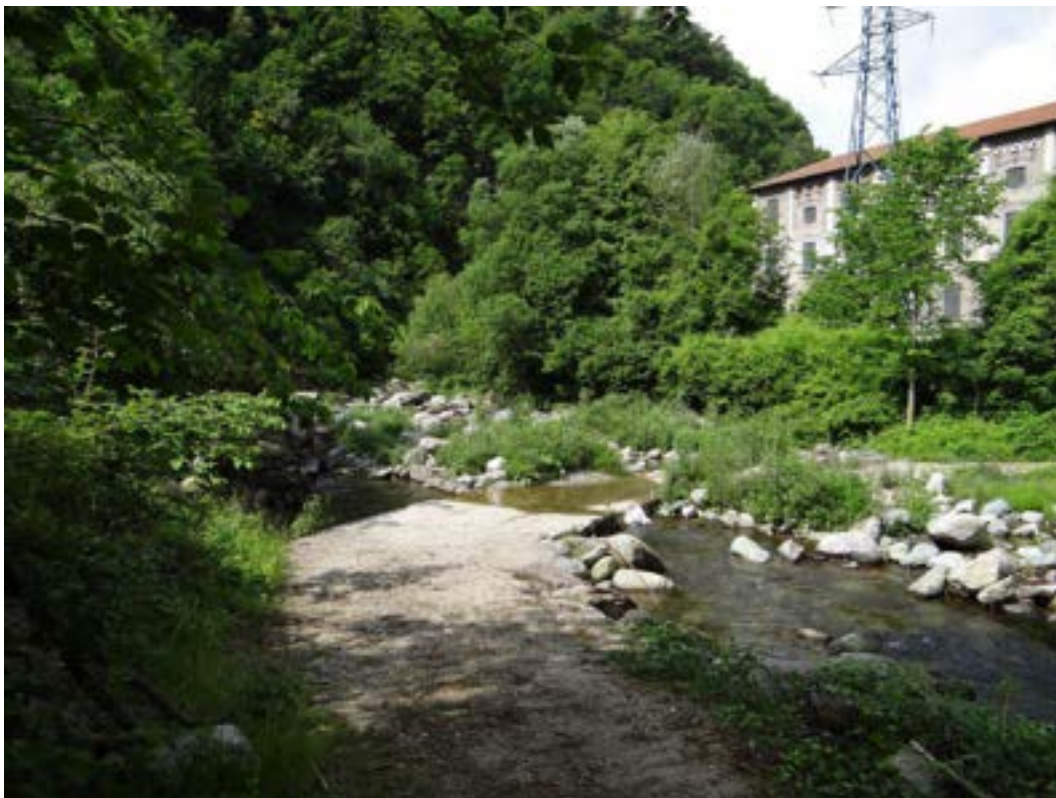
Figura 4 – Guado a valle della centrale idroelettrica
