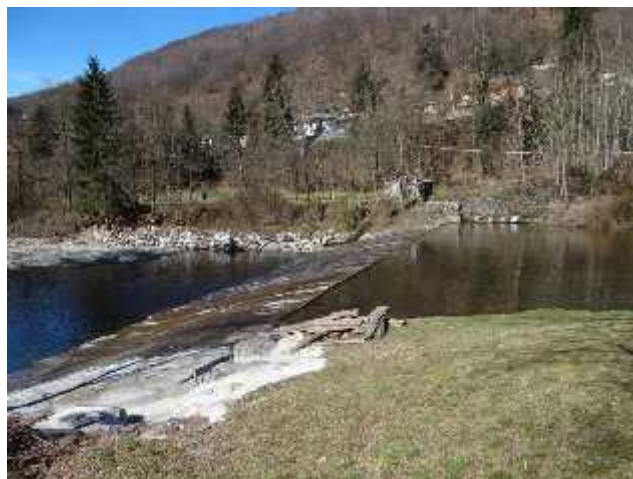
Sbarramento a servizio del canale di gronda.
