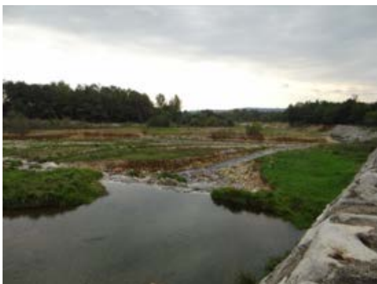
Accumulo materiale a valle della soglia loc. Minazia
