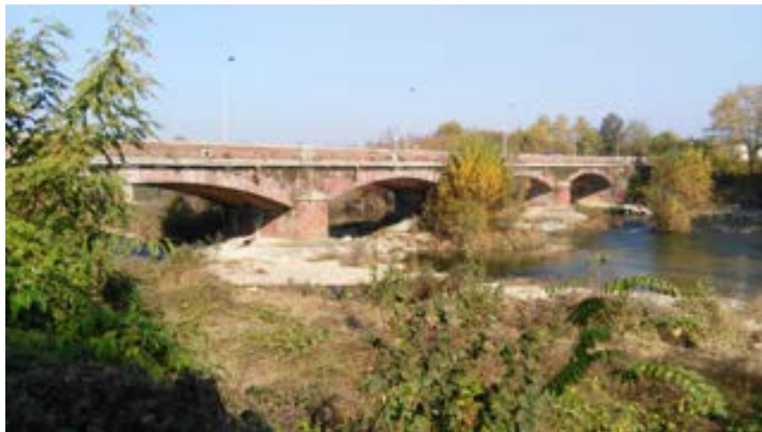
Ponte con pile in alveo dell'attraversamento della SP220
