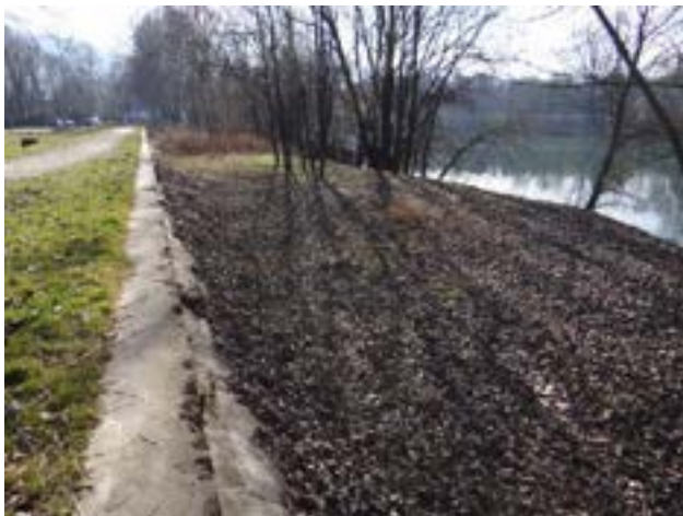
Argine sponda destra
