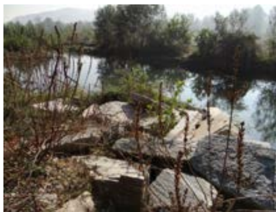
Pennello a difesa della sponda sinistra a Brandizzo. (B) nella figura sottostante
