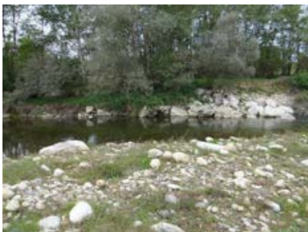
Opere di difesa erose in destra orografica.
