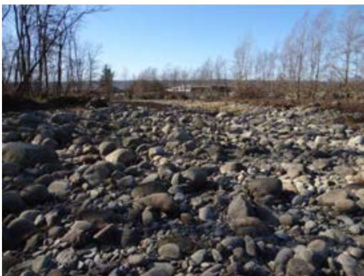
Fenomeno di corazzamento, ossia la presenza di uno strato superficiale di dimensioni significativamente maggiori rispetto a quelle del sottostrato, presente in più punti del tratto.
