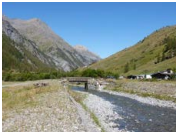
Argini in corrispondenza di Grangia Gacès
