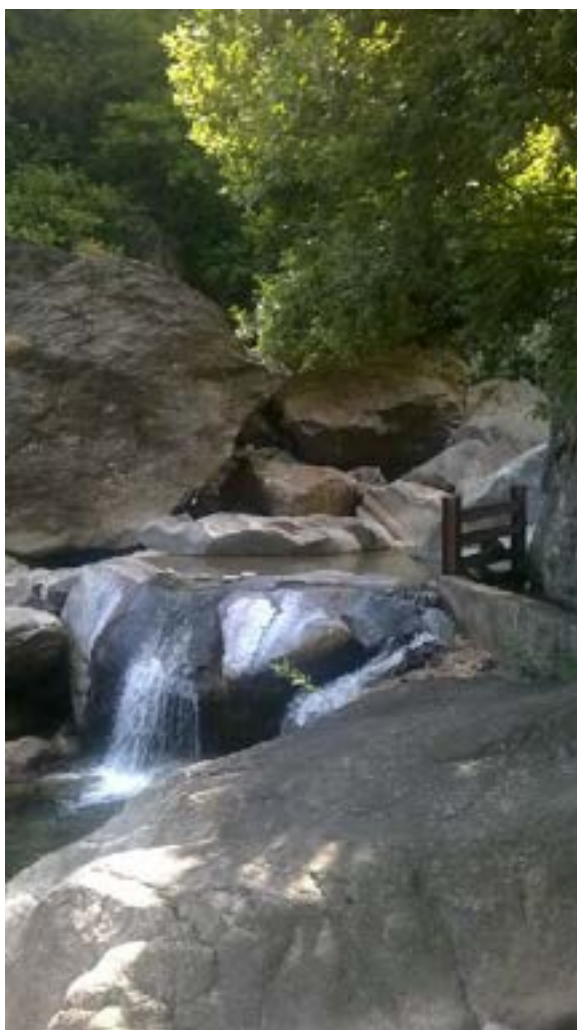
Piccola opera di presa per uso agricolo in loc. Pianette
