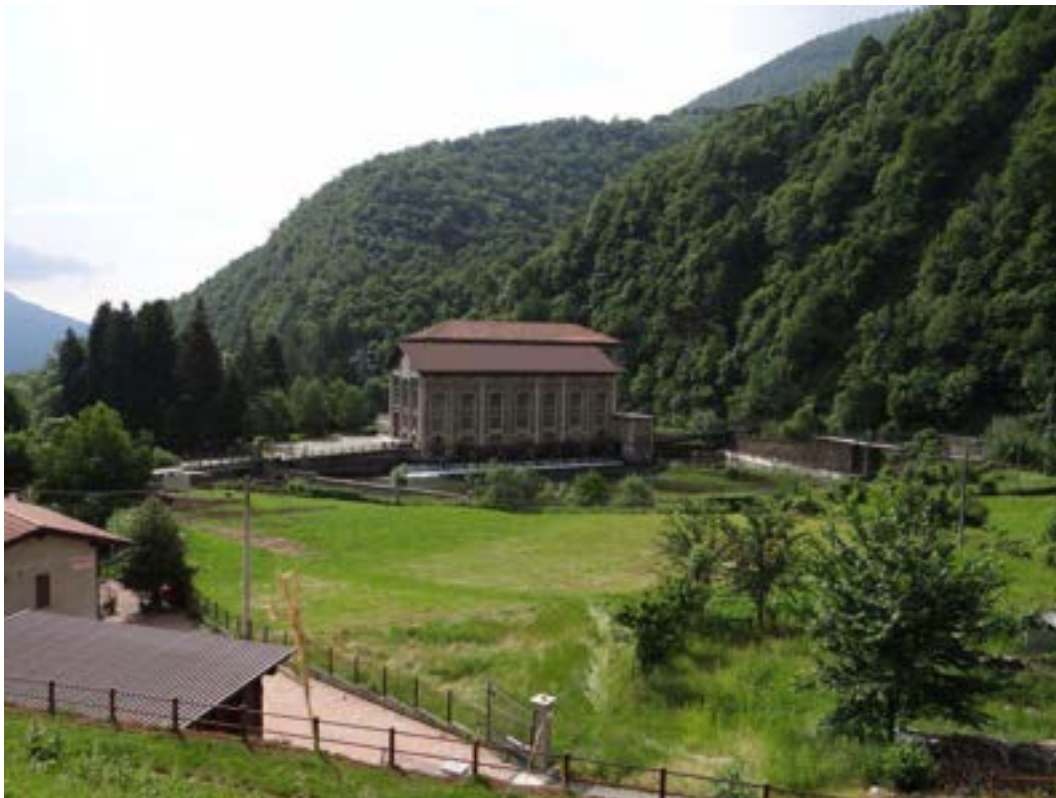
Figura 3 – Centrale idroelettrica di Calcinere
