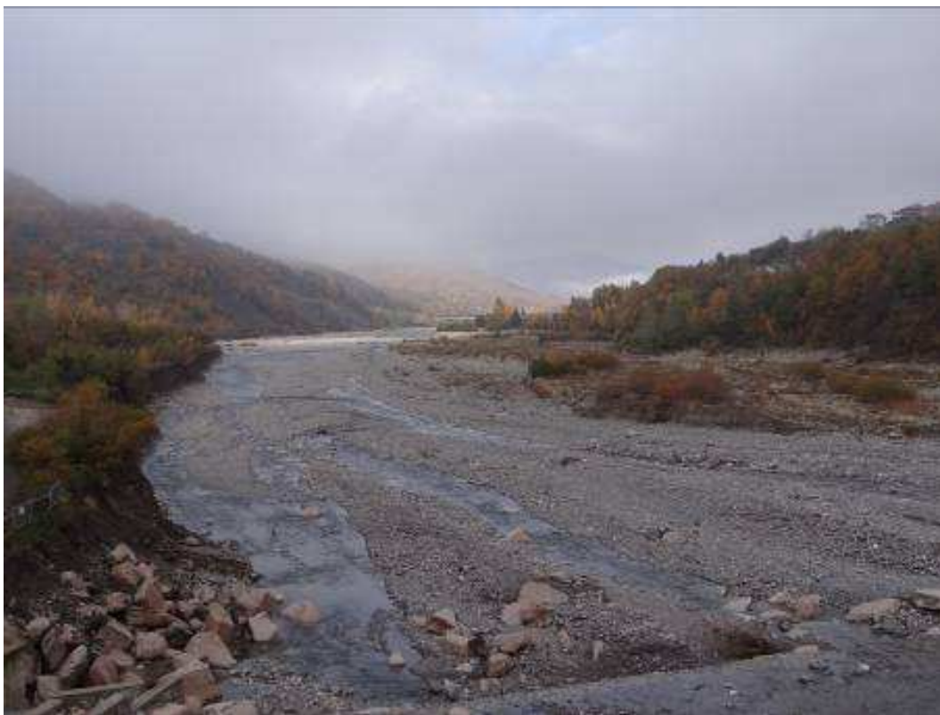
Figura 3 – Seconda metà del tratto; in sponda destra è visibile una serie di pennelli
