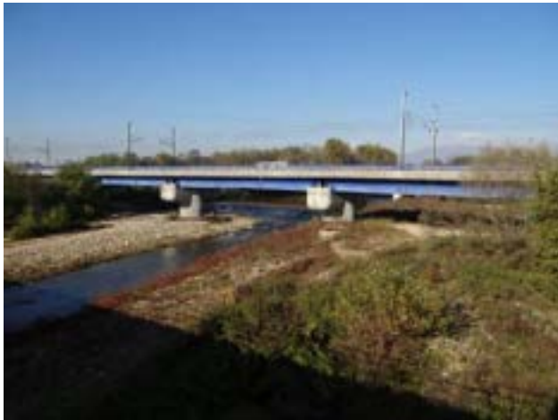
Il ponte dell'alta velocità Milano-Torino.
