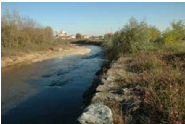
Difesa in sponda destra a protezione della SP39dir1 a San Benigno
