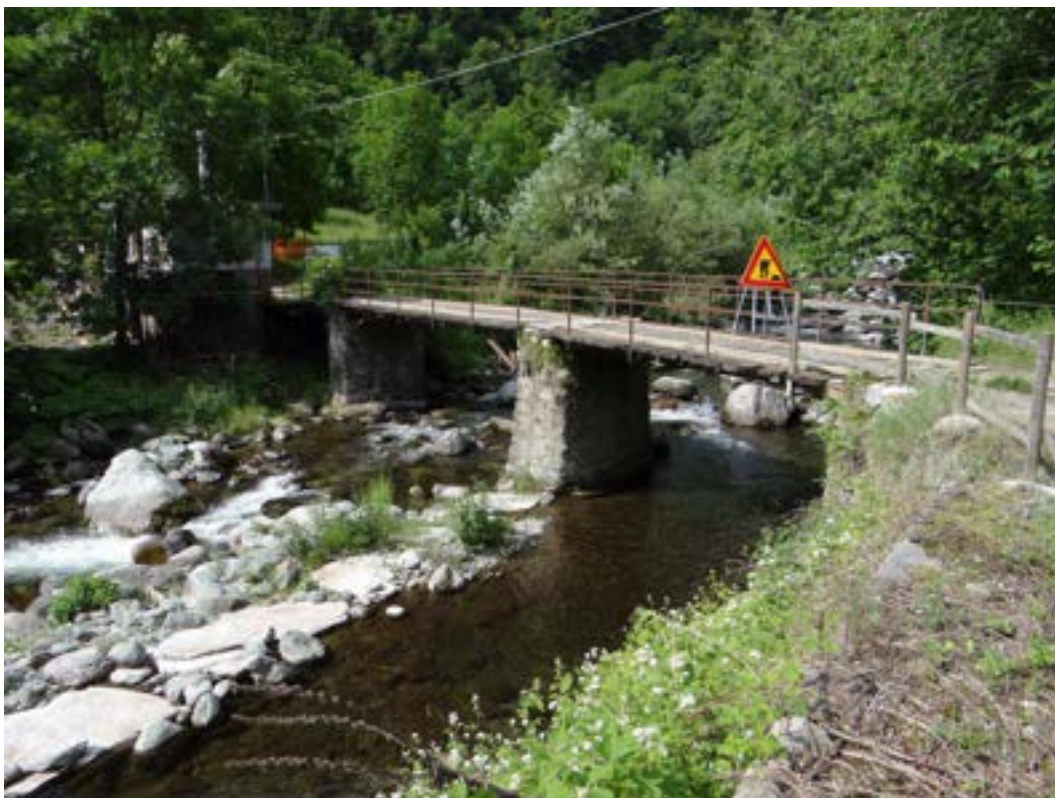
Figura 1 – Attraversamento nella parte iniziale del tratto
