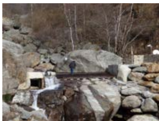
Traversa di derivazione sul torrente Elvo immediatamente a monte della SP512
