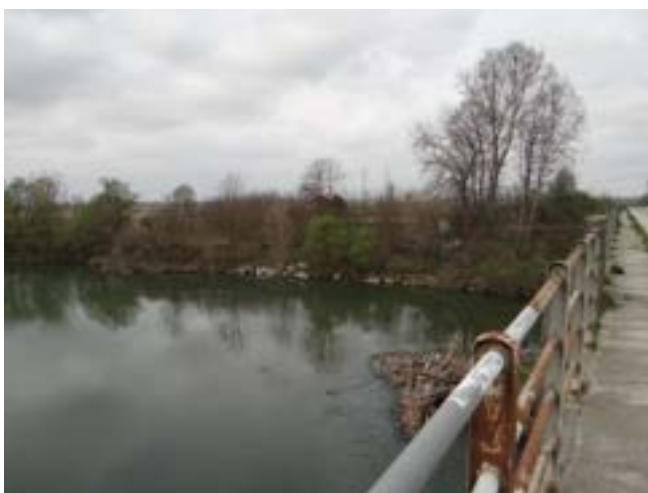
Materiale flottante intrappolato dalle pile del ponte della SS 20.
