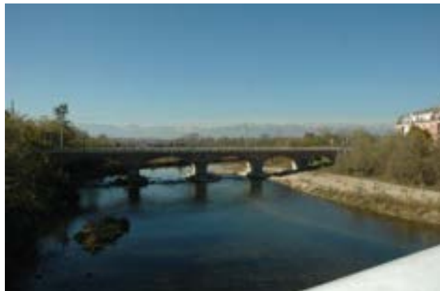
Ponte ferroviario a San Benigno visto dal ponte stradale con adiacente passerella pedonale
