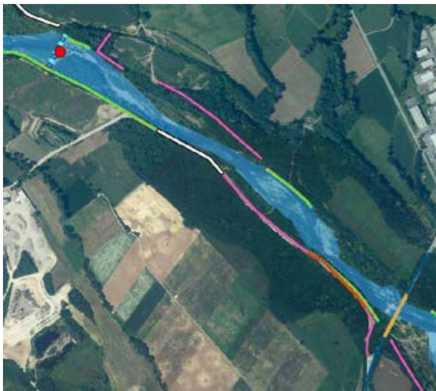
Prima porzione del tratto con in evidenza le opere longitudinali, difese spondali e argini.
