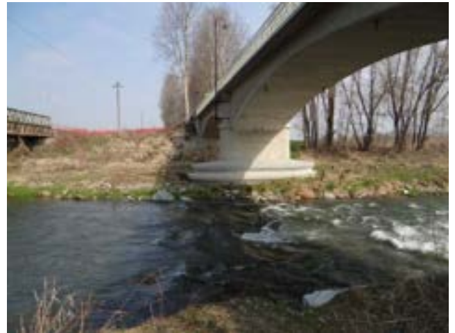
Pila del ponte nuovo di Cardè.
