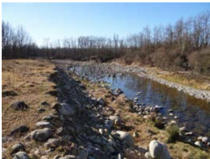
Porzione di piana inondabile in sinistra idrografica
