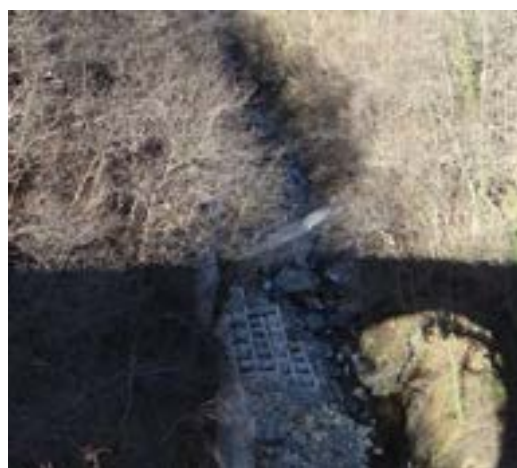
Traversa derivazione con serie di vasche per la risalita dei pesci
