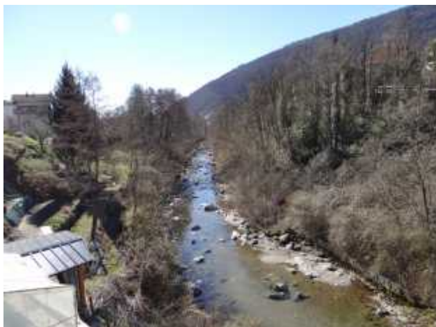
Il San Giovanni all'inizio de quinto tratto, sia in destra che in sinistra opere di protezione al piede dei versanti.
