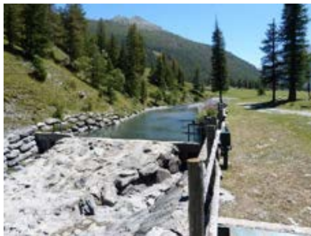
Opera di presa all'estremità a valle del tratto
