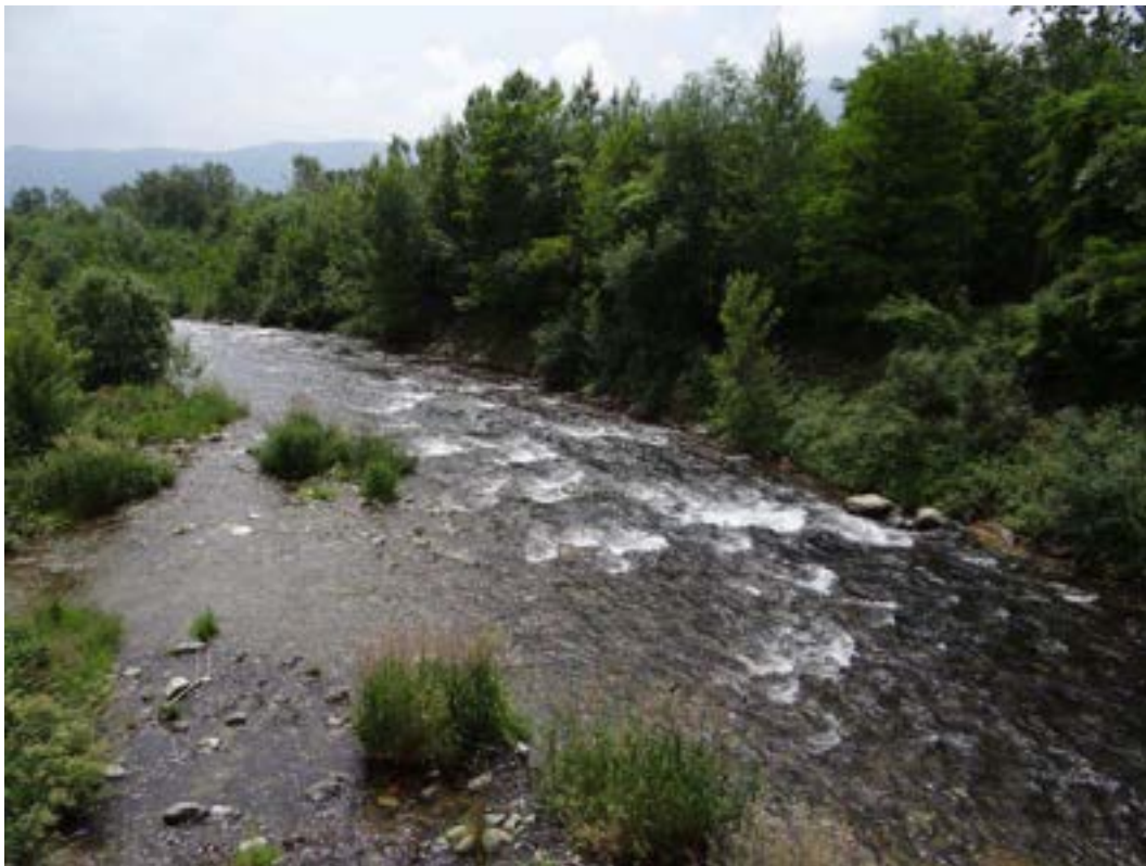
Figura 11 – Parte iniziale del tratto
