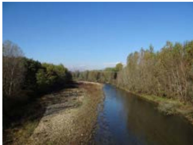
L'alveo del torrente a monte del ponte stradale.
