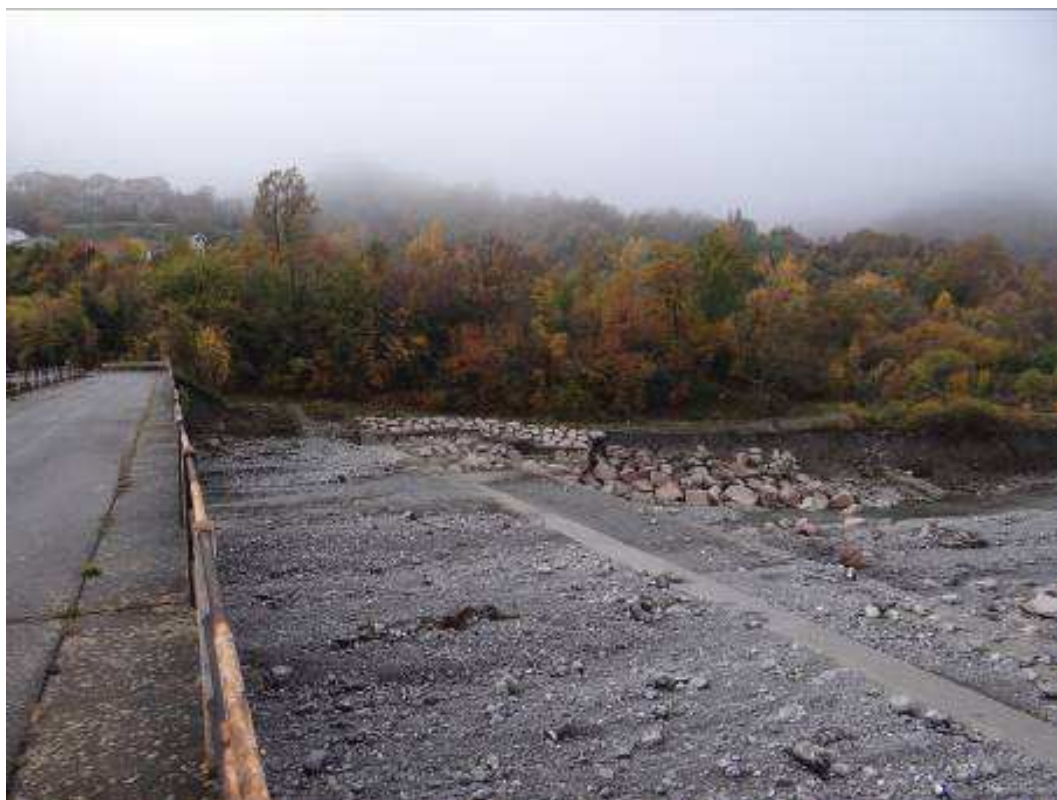
Figura 2 – Soglia in corrispondenza del ponte che consente l’accesso alla località Rosano
