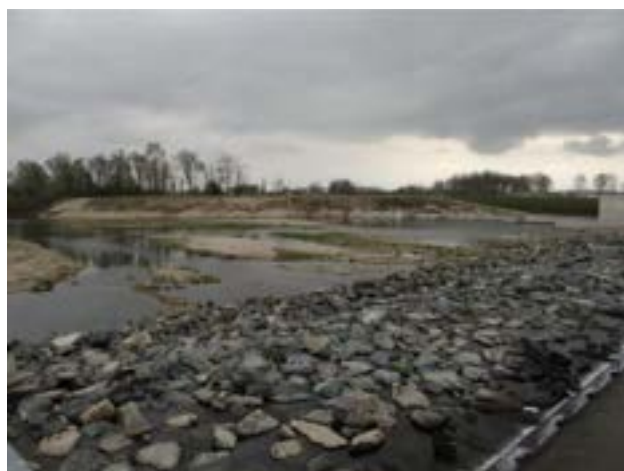
Sbarramento a servizio del canale di gronda.
