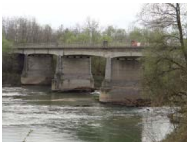
Le pile del ponte viste da valle.
