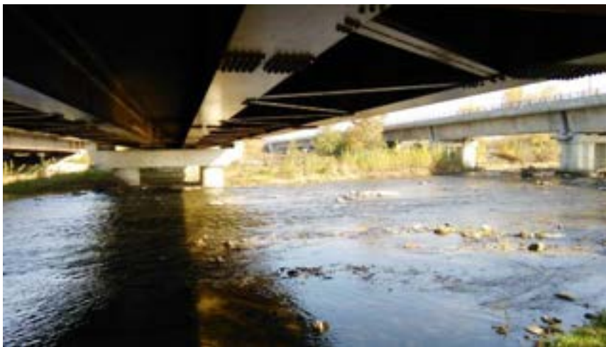
Alveo del T. Malone in corrispondenza degli attraversamenti autostradali della A4 Torino-Milano e ferroviario
