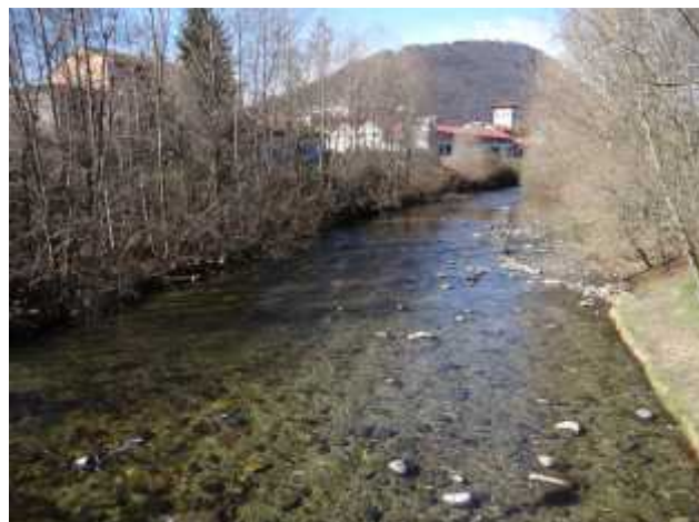
Vista a monte del ponte di Via Vigne Basse .
