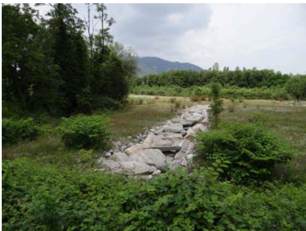
Figura 14 – Opera longitudinale a livello del piano campagna a difesa della SP 260
