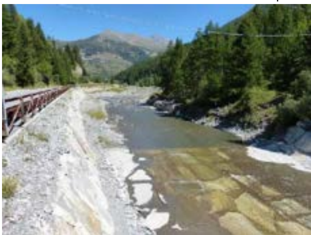
Alveo in corrispondenza dell'attraversamento a Rollieres
