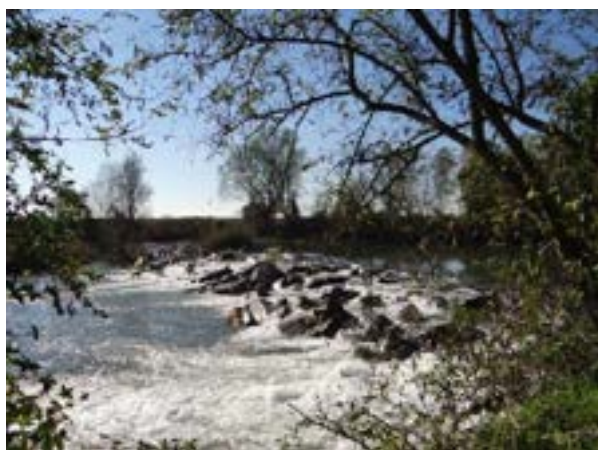
Soglia in massi nel tratto.
