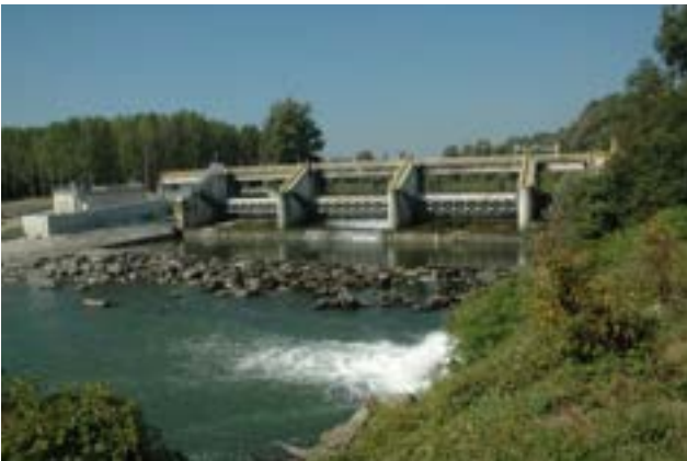
Traversa idroelettrica Iren
