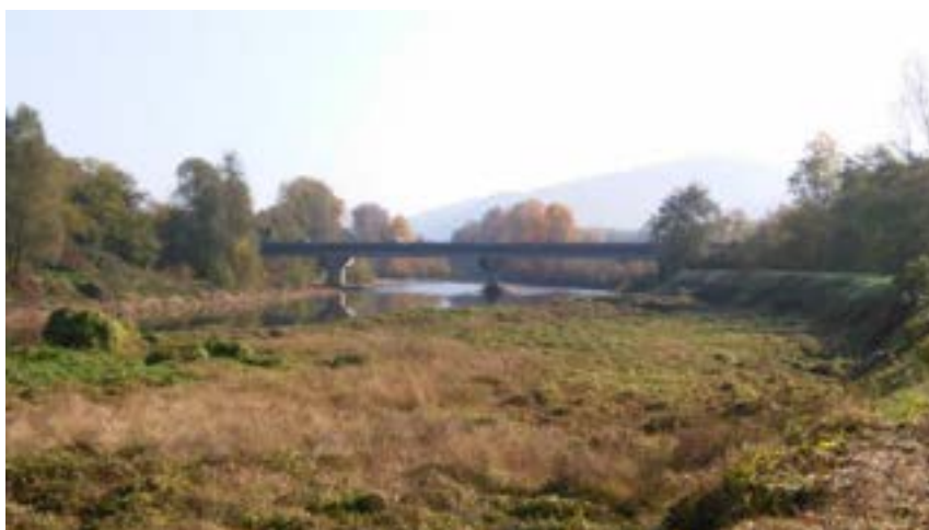
Argine in sponda destra, piana inondabile e attraversamento della SR11 a monte della confluenza del Malone nel Po
