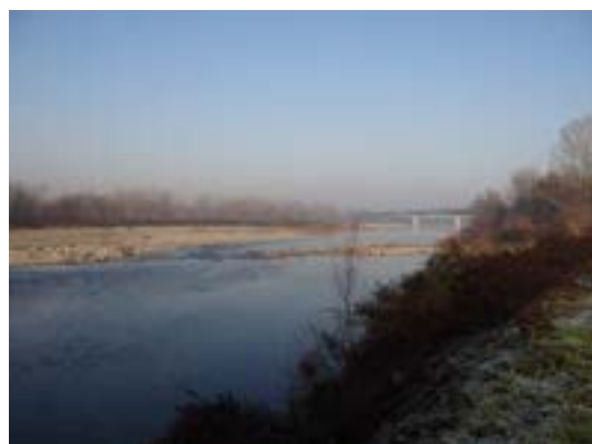
Vista del corso d'acqua a monte del ponte SP 500.
