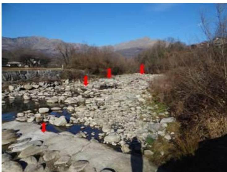
Serie di soglie (frecce in rosso) e difesa spondale in desta idrografica a monte del ponte della SS338
