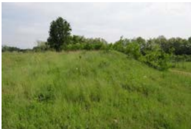
Argine a protezione dell'area industriale di Lombardore
