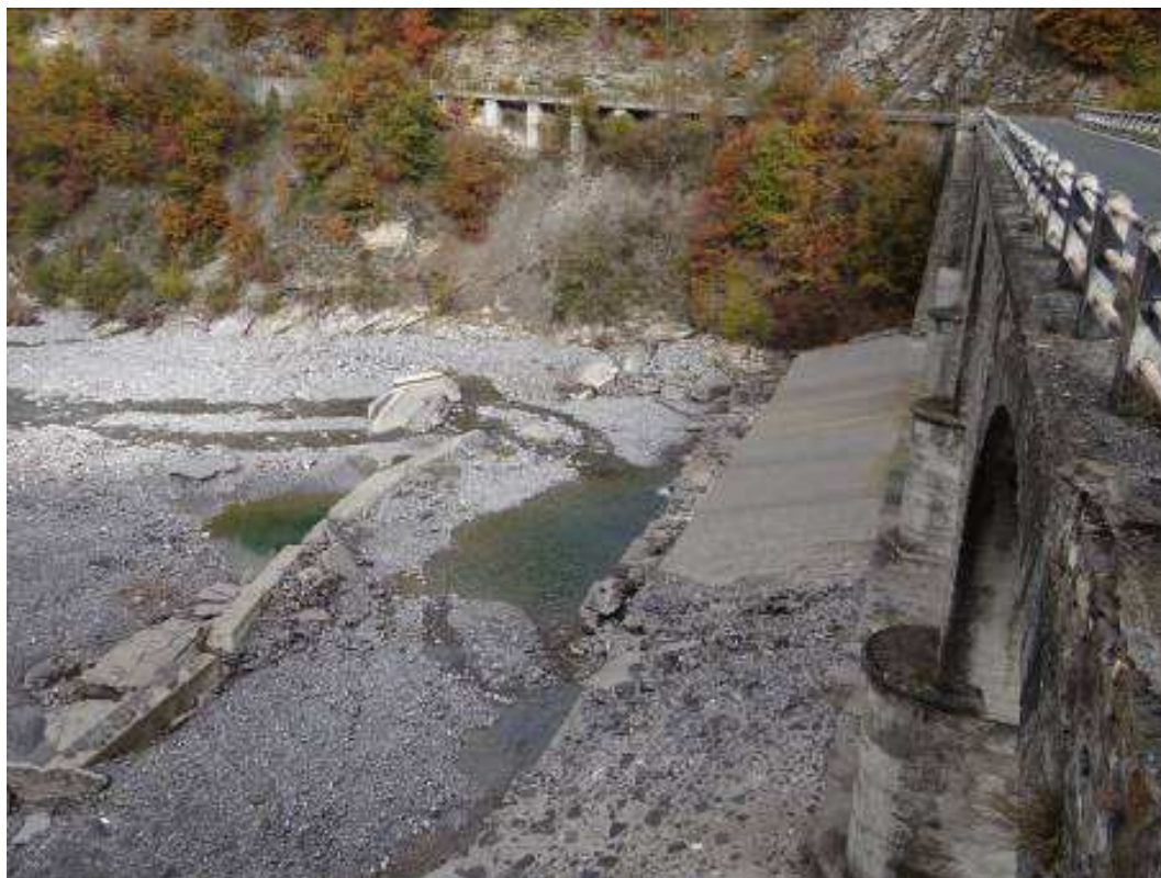
Figura 1 – Soglia in corrispondenza del ponte posto immediatamente a valle dell’inizio del tratto
