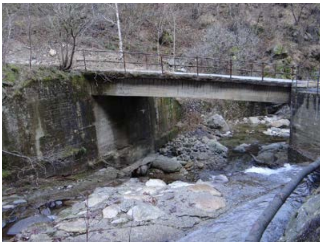
Ponte della strada comunale (via Bagneri) di Muzzano e soglia
