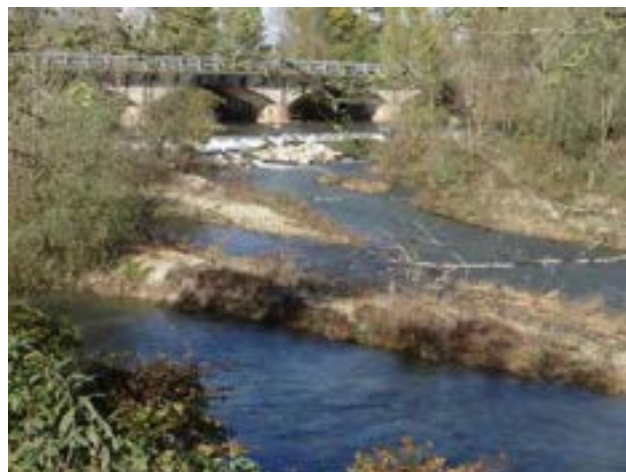
Il ponte stradale.
