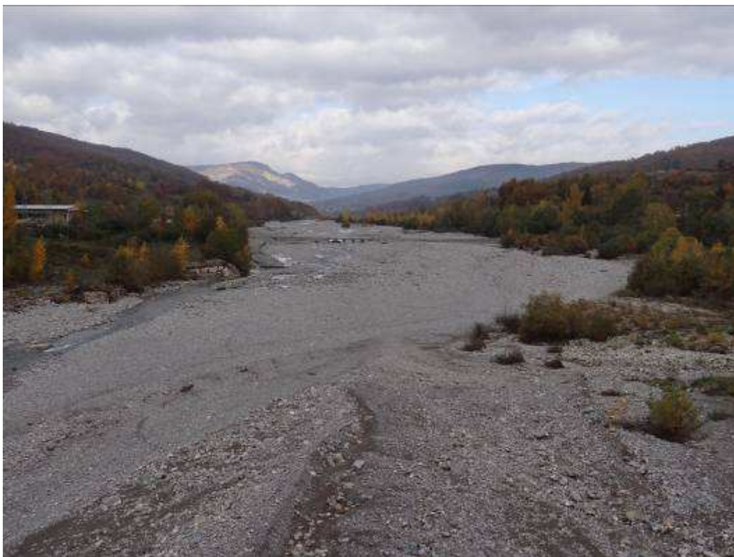
Figura 5 – Parte iniziale del tratto
