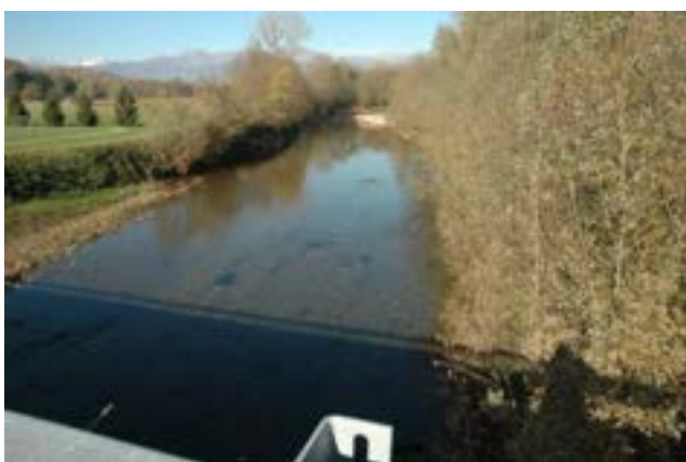
Vista verso monte dell'alveo dal ponte di Rivarossa
