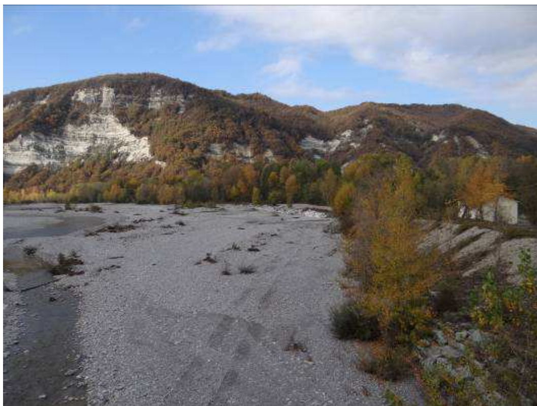
Figura 5 – Opere di difesa spondale nella parte terminale del tratto
