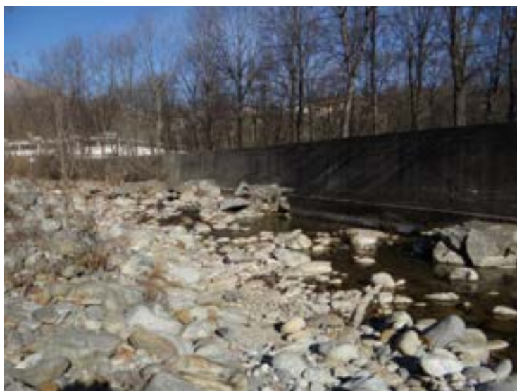
Muro arginale in sinistra idrografica con serie di pennelli
