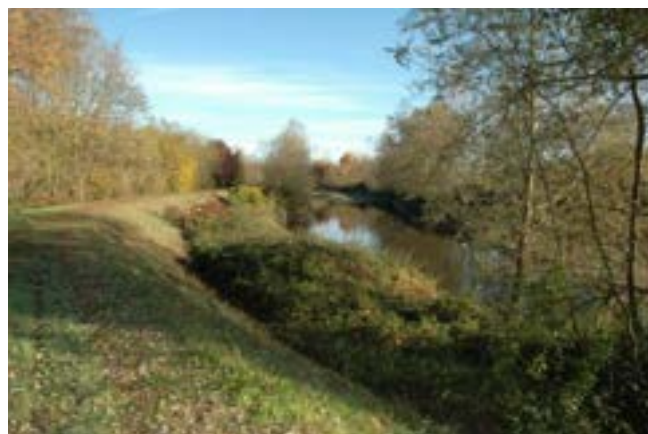
Argine in sponda destra a monte del ponte di Front.
