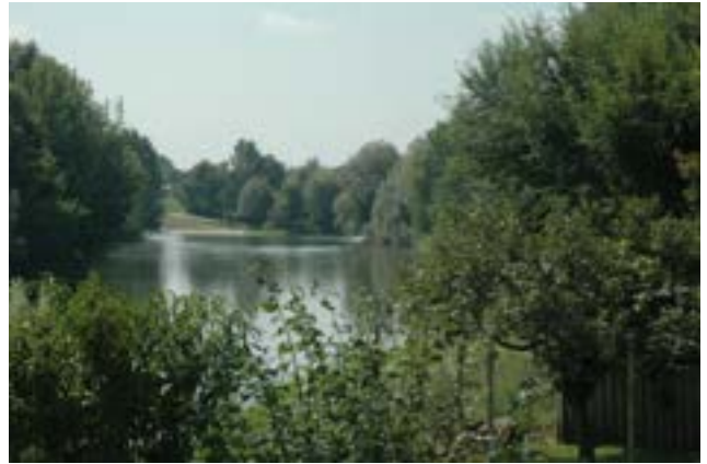
Confluenza del Chisola e restituzione canale Iren
