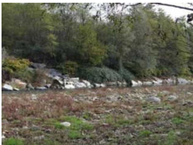
Opere di difesa in massi ciclopici in sponda sinistra.
