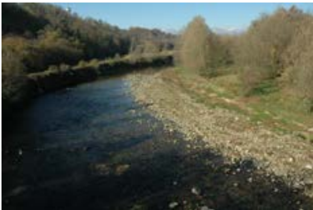
Difesa in sponda destra a protezione della curva a monte del ponte della SP267
