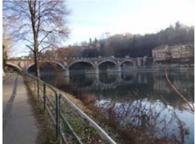
Ponte Isabella visto dalla sponda sinistra
