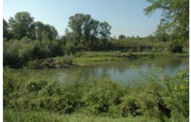
Alveo a valle della traversa
