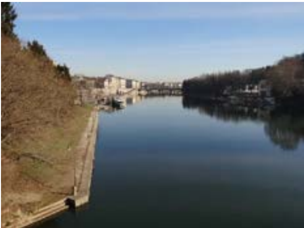
Vista verso valle dal Ponte Umberto I
