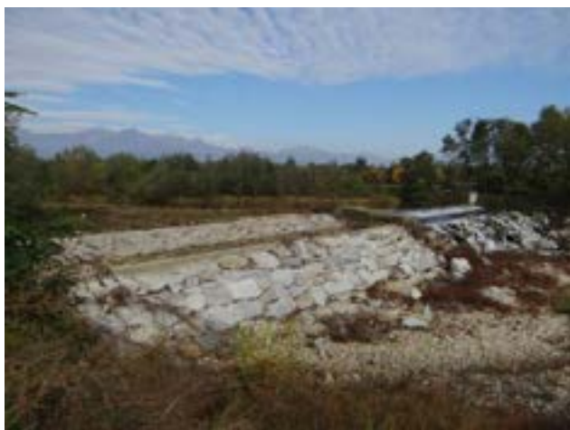
Traversa di derivazione in loc. Carpo.
