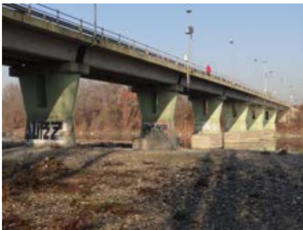
Il ponte sul fiume della SP N.92.
