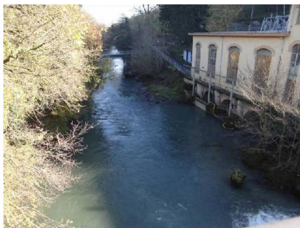
Alpignano, centrale con presa per uso energetico
