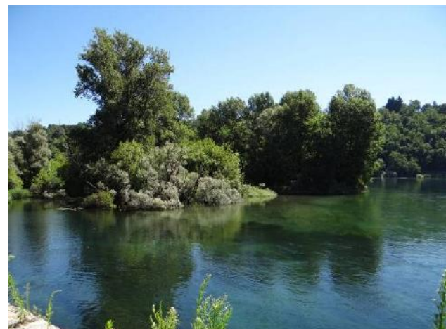
Vista verso monte della traversa.
