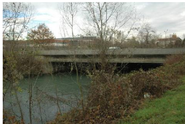
Ponte di C.so Regina Margherita (Torino)
