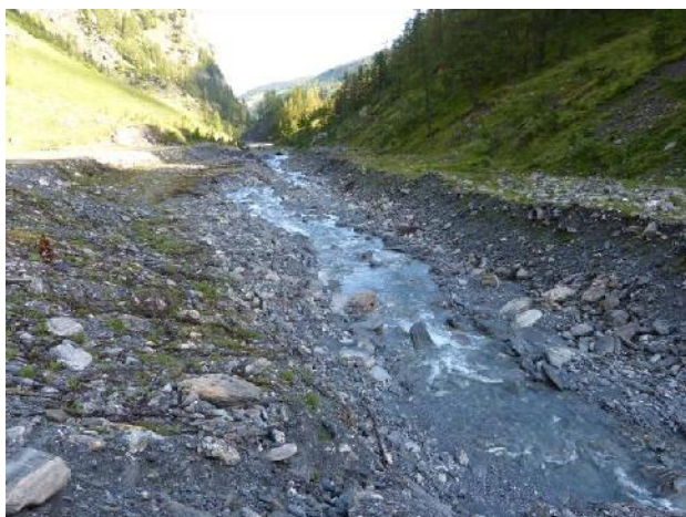
Vista verso monte del tratto
