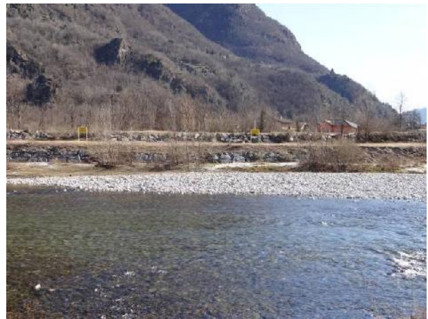
Difese spondali e argine in sponda sinistra.
