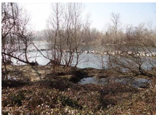
Vista dell'alveo con alcune erosioni di sponda.
