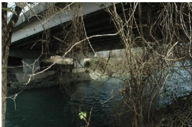
Ponte C.so Sacco e Vanzetti (Collegno)
