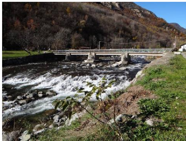
Ponte in loc. Castel del Bosco
