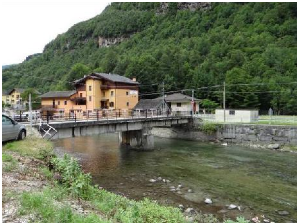
Ponte sul Toce a Piedilago
