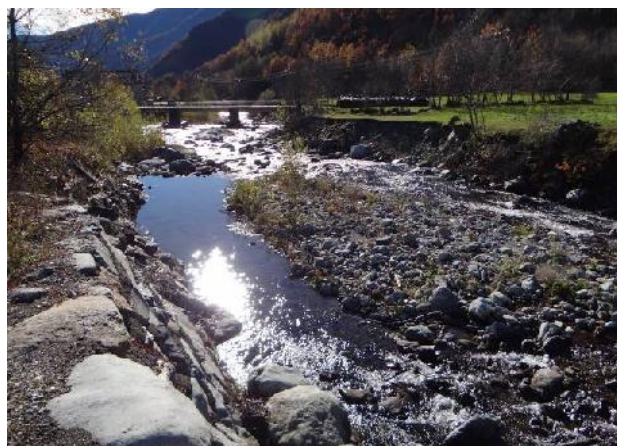
Sponda destra in erosione, difesa in sponda sinistra in fondo il ponte di Balma
