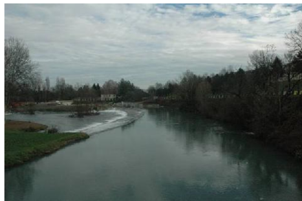
Grossa traversa all'estremità del tratto
