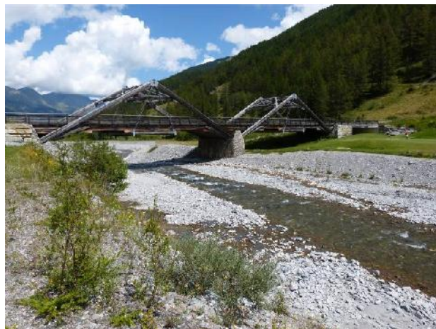
Nuovo ponte in corrispondenza di Traverses
