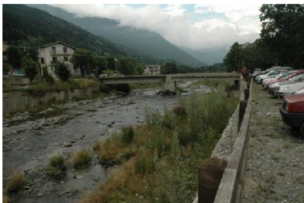
Ponte per località Chambons, vista verso valle
