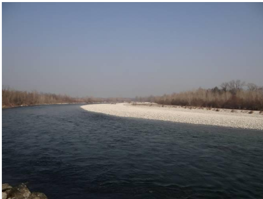
Ultima parte del tratto visto da valle.
