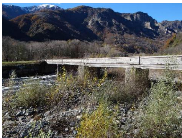
Ponte per loc. Selvaggio
