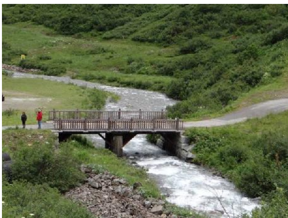
Ponte sul Toce
