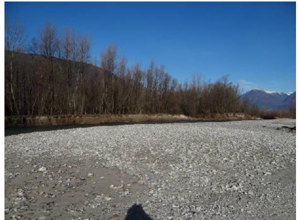
Estesa erosione spondale
