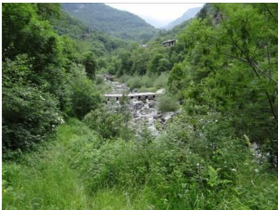
Figura 4 – Guado a sbarramento dell'alveo
