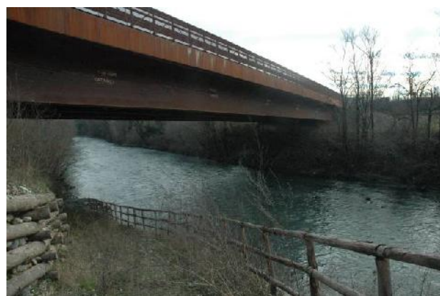
Ponte della bretella SS24-Viale Certosa (Collegno)
