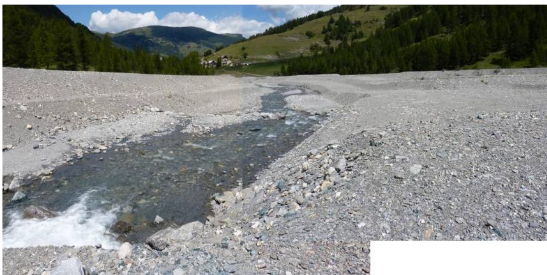
Risagomatura dell'alveo a monte di Laval
