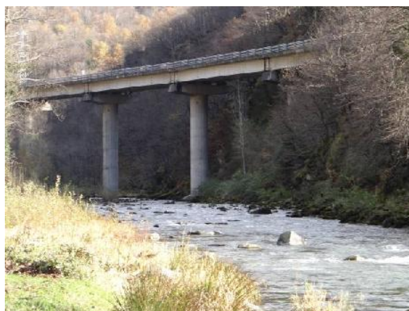
Viadotto superstrada prima dell'entrata in galleria
