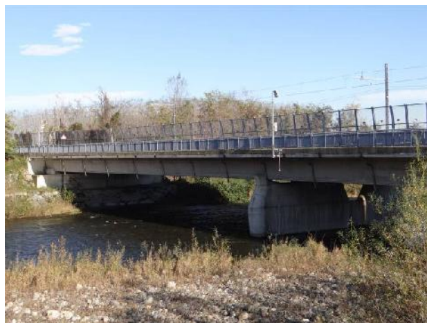
Doppio attraversamento stradale e ferroviario
