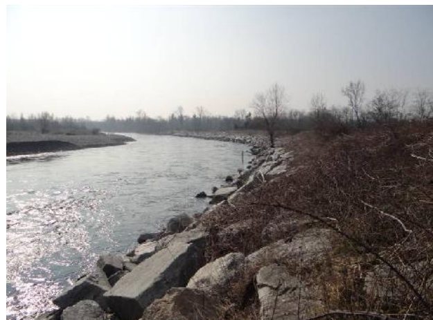
Difese spondali in località M.o Vecchio.
