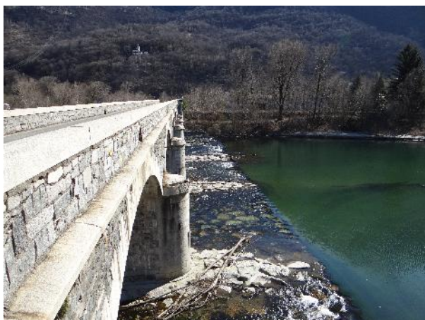
Ponte del Migliandone
