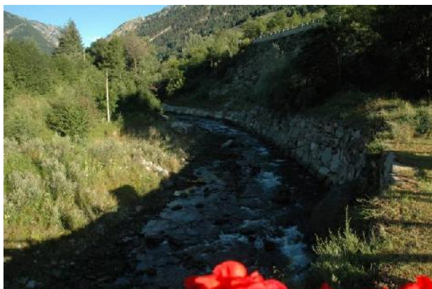
Dal ponte di Granges, vista verso monte
