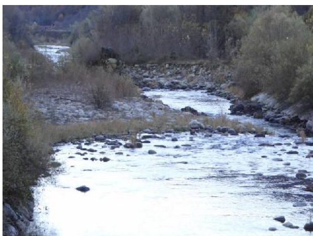
Sponde in erosione a monte di Pinasca
