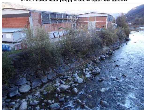
Difese di sponda al ponte per Pinasca
