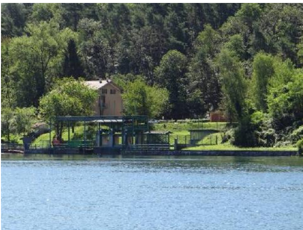
Imbocco del canale Regina Elena.
