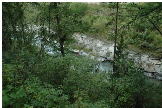
Sponda sinistra con difesa di sponda
