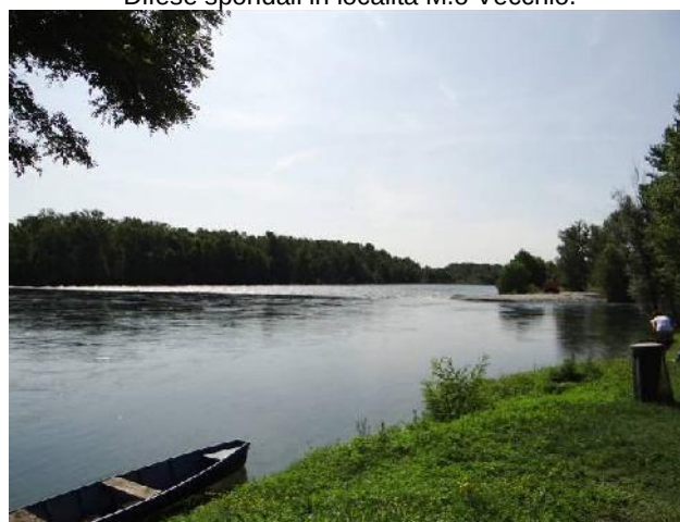
Sbarramento sommerso in ciottoli da cui prende origine il Naviglio di Langosco, portata 24 mc/s.
