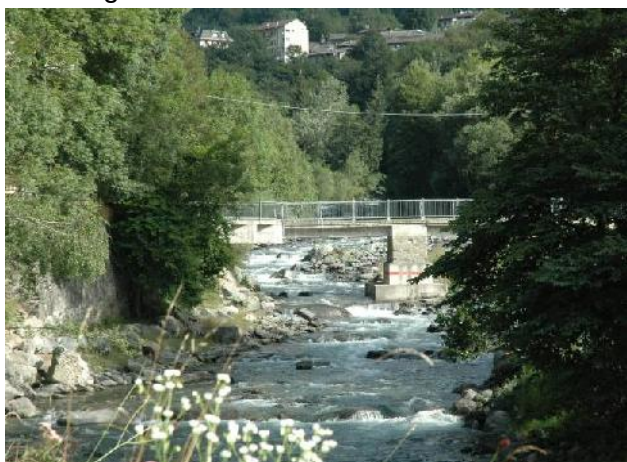
Ponte di loc. Gleisolle (Villaretto)
