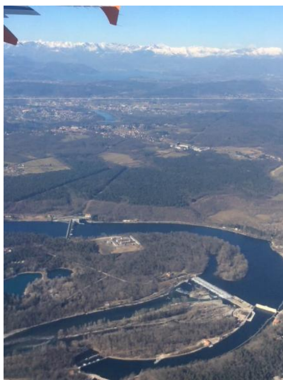
Vista area della traversa del Panperduto.
