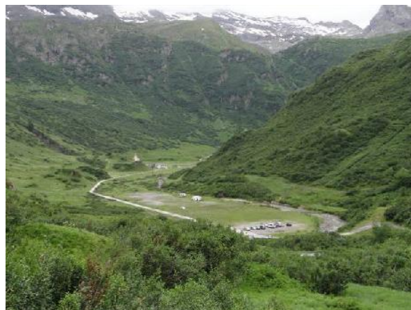
Piana alluvionale a valle della diga
