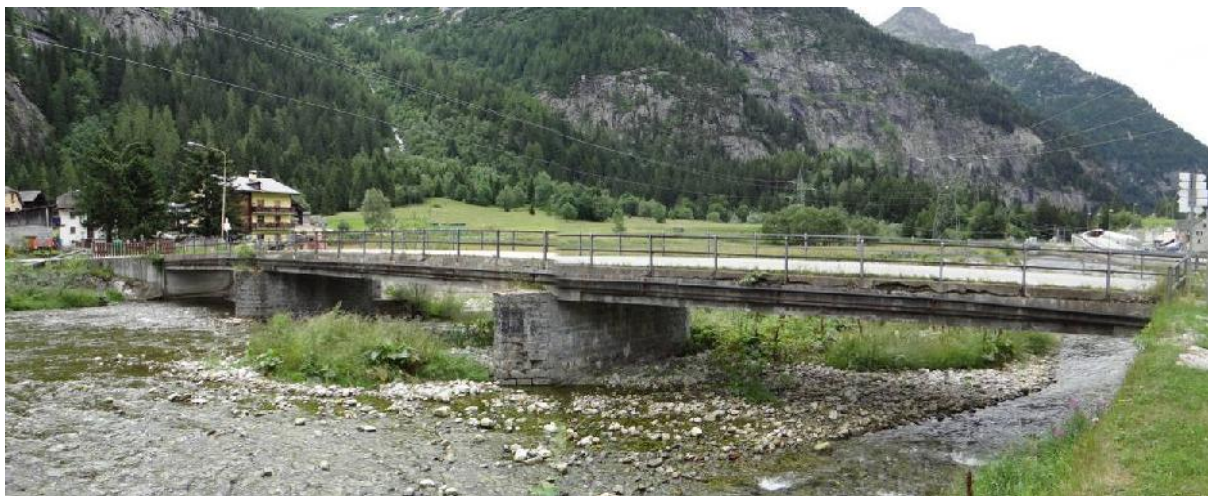
Ponte a Fondovalle
