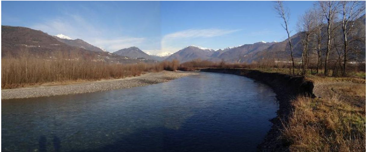
Estesa erosione di fronte alla barra
