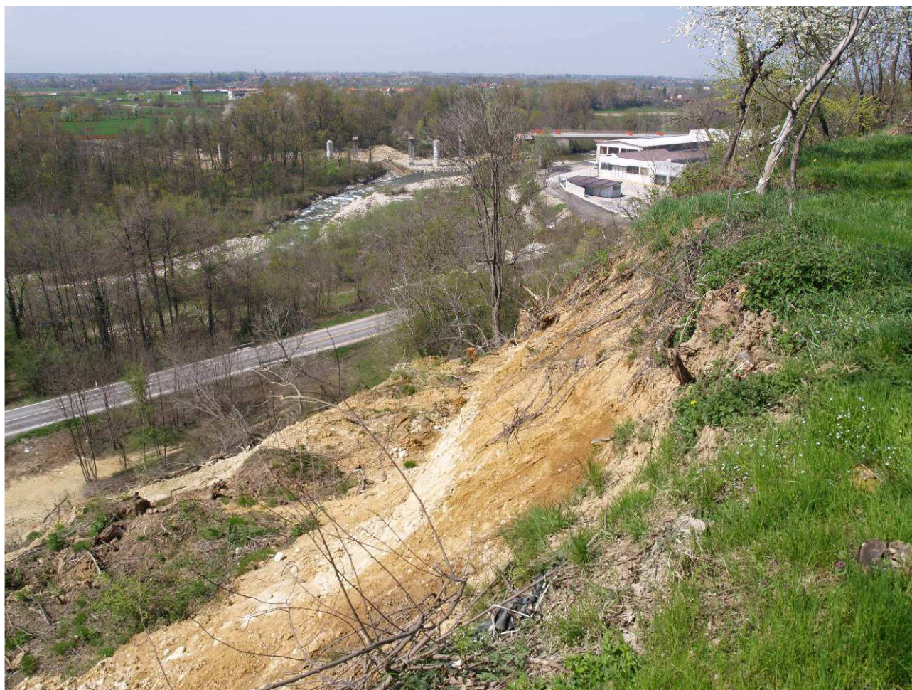
Settore destro del coronamento di frana e parte del corpo del fenomeno. Foto scattata il 20/04/2010
