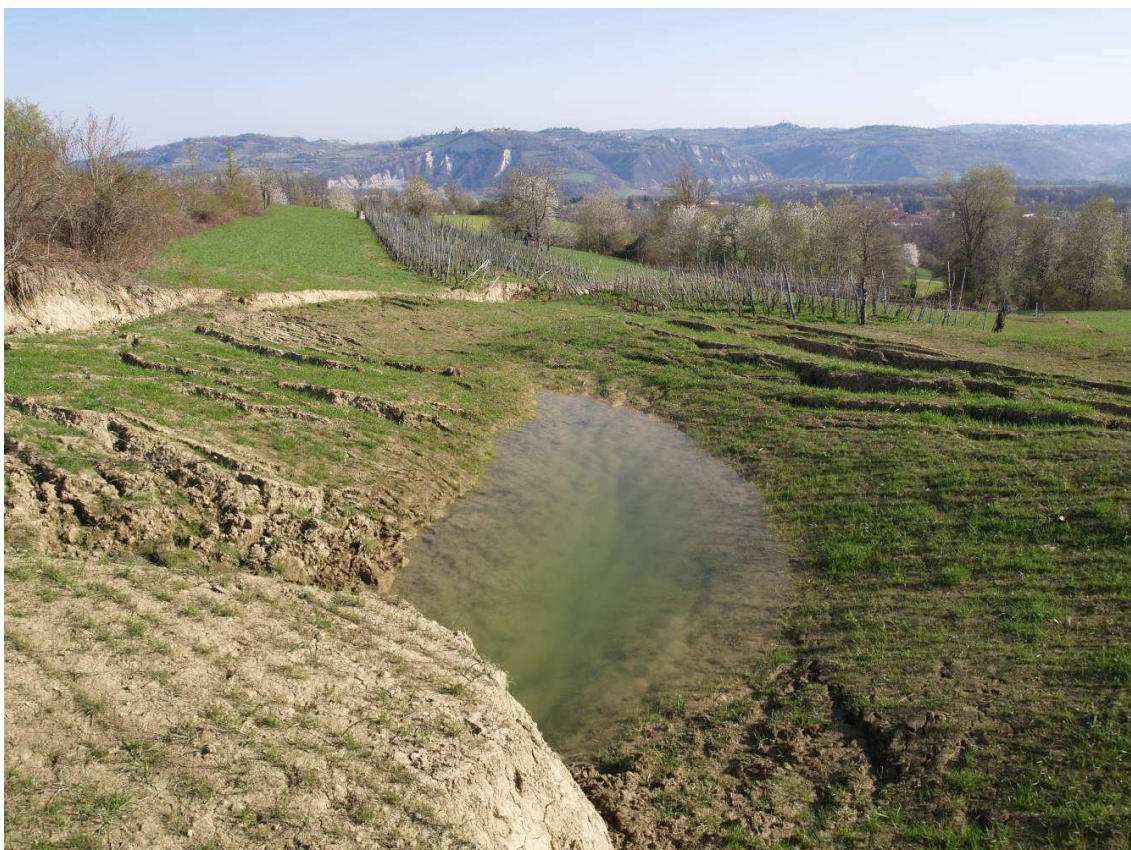
Ristagno idrico alla base del settore sinistro del coronamento; risultano evidenti i danni subiti dalla vigna. Foto scattata il 14/04/2010
