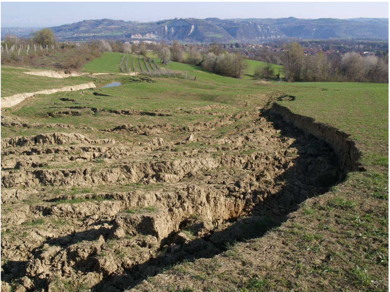
Il corpo di frana ripreso dall'apice destro del coronamento. Foto scattata il 14/04/2010
