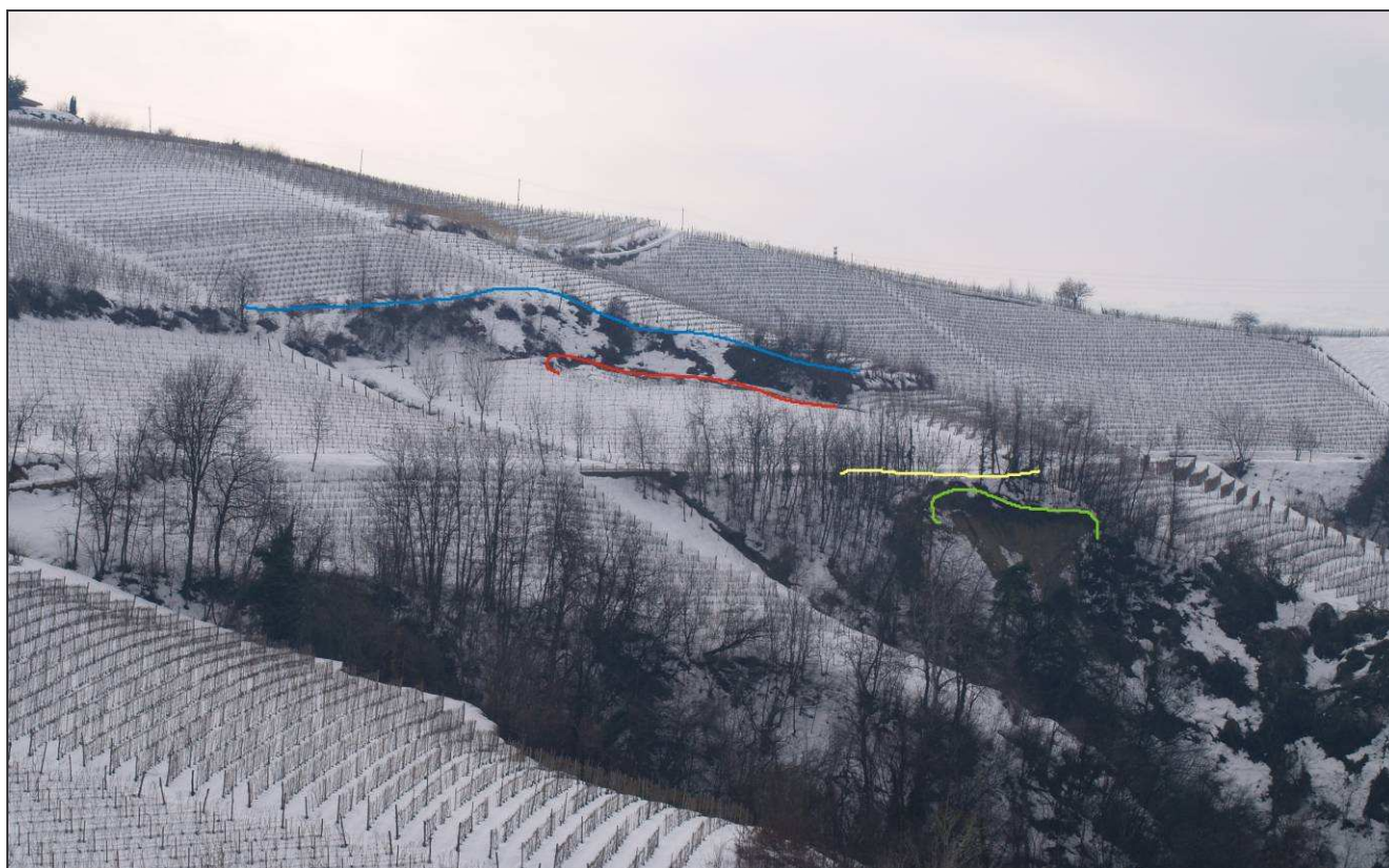
Figura 10 - Panoramica del versante coinvolto. In blu la scarpata preesistente, in rosso la scarpata principale dello scivolamento del dicembre 08, in giallo il tratto di strada coinvolto, in verde il coronamento dei colamenti superficiali al piede del versante.
