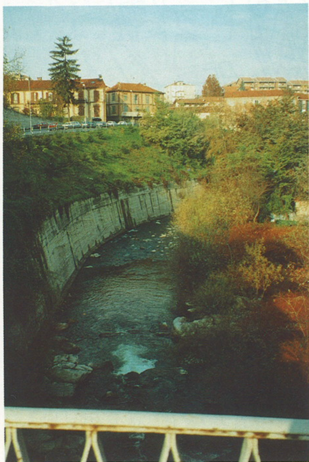
Fig. 1 - Particolare della riva sinistra del T. Ellero nel suo attraversamento dell'abitato. Le opere di difesa spondale, realizzate posteriormente agli anni '60, hanno disattivato il pericolo di un coinvolgimento degli edifici e della viabilità soprastanti.
