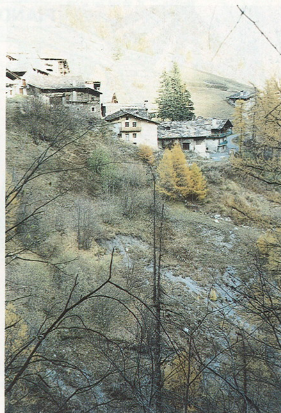
Fig. 1 - Particolare del versante a livello dell'abitato. Al centro della fotografia è l'ex Municipio, in alto a destra una casa isolata seriamente lesionata da movimenti locali della parte di accumulo più prossima all'alveo torrentizio. Tra la fitta vegetazione in primo piano, si distinguono le lacerazioni della coltre erbosa che evidenziano la fine pezzatura del materiale costituente l'accumulo della frana.
