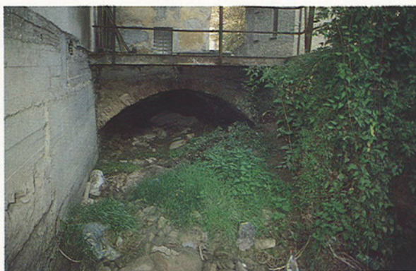
Fig. 3 - Luce del Rio Acquafredda all'inizio del canale sotterraneo che attraversa l'abitato, come appariva nel maggio 1990. Sarebbe sufficiente un'ordinaria ed accurata pulizia dell'alveo per evitare disastrosi disallineamenti (1948, 1951 e 1968) durante notevoli eventi pluviometrici.
