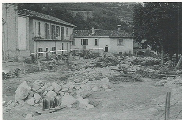
Figg. 3 e 4 - Piazza di Rocchetta Belbo, situata in sinistra del Rio Annunziata, dopo l'alluvione del settembre 1948 (a sinistra) e così come appare oggi. Il rio, invadendo l'abitato, danneggiò gravemente 14 abitazioni lasciando sulla piazza detriti per uno spessore di circa 1,5 m (linee bianche). La situazione da allora è di poco mutata: la luce del ponte, nell'attraversamento dell'abitato, potrebbe rivelarsi insufficiente se rapportata all'area del bacino sotteso e soprattutto ai volumi di materiale detritico a monte del manufatto, trasportati e depositi dal rio durante i maggiori eventi di piena.
