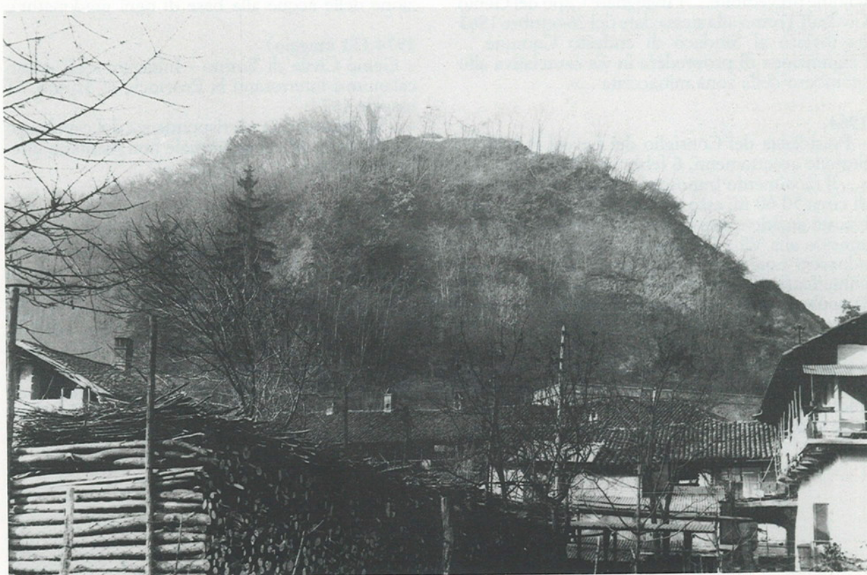
Fig. 1 - La fotografia mostra la situazione creatasi dopo la frana avvenuta nel dicembre 1960. La scarpata assunse una inclinazione media di 70^\circ con tratti anche verticali, per cui si crearono condizioni di ulteriore instabilità legate al rischio di arretramento del ciglio per frana (Archivio C.N.R.-I.R.P.I. Torino).
