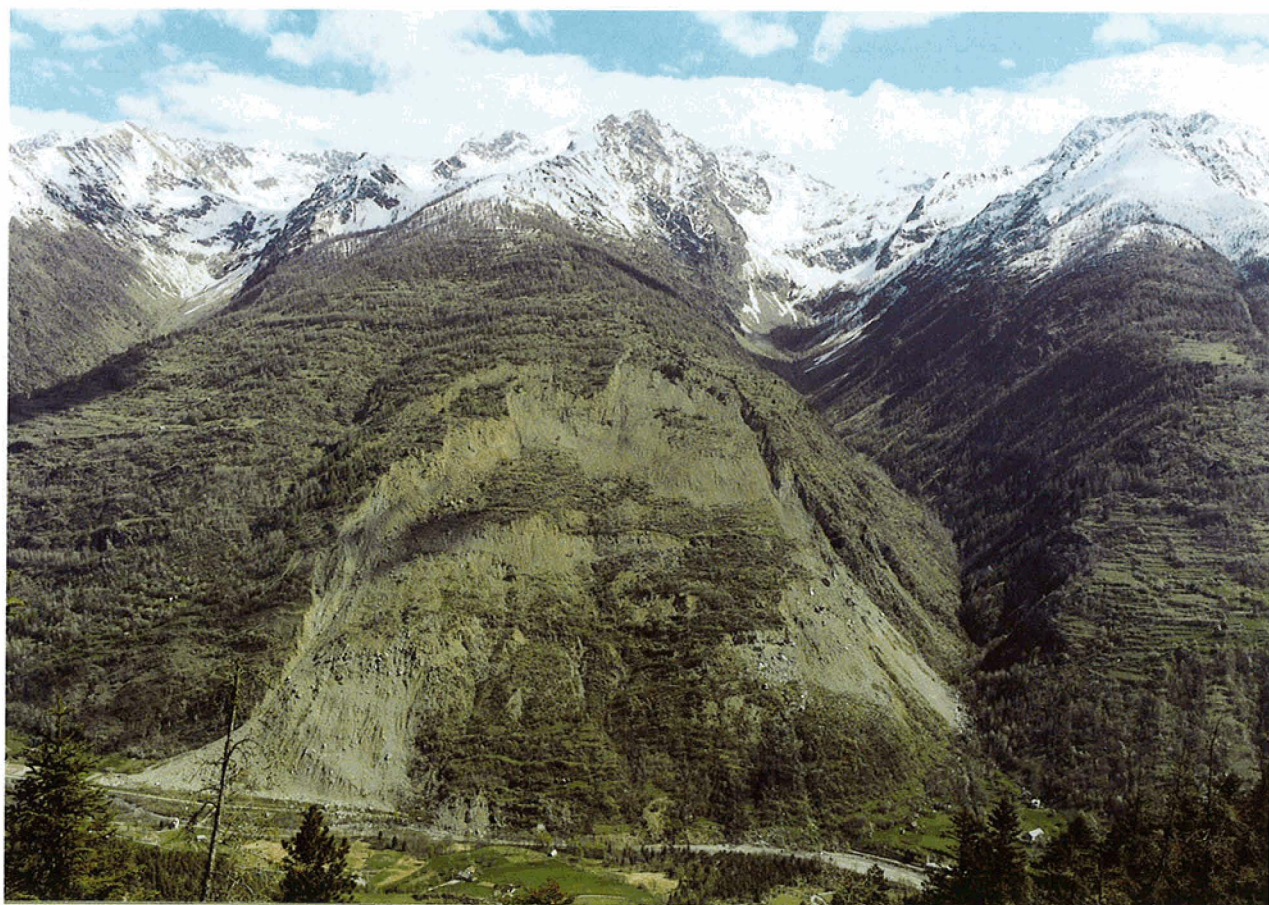
Vue générale du glissement de la Clapière (1995).
