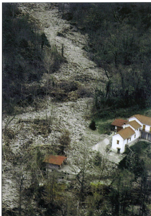
Fig. 20.4 Colata detritica superficiale nel comune di Prunetto
