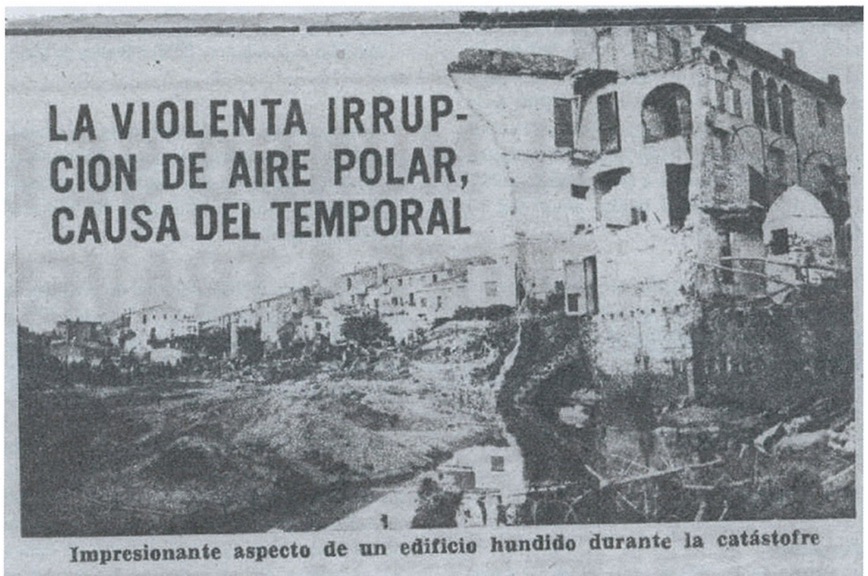
Fig. 25.5 Aspecto de un edificio hundido durante la catástrofe
