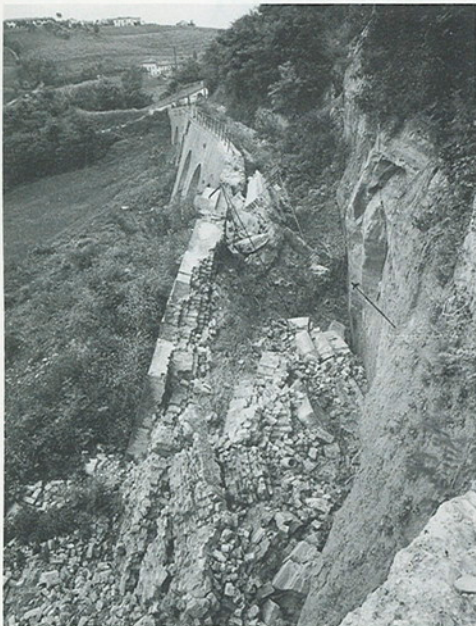
Figg. 3 e 4 - Il muro di sostegno sottostante Via Fantolino e il Pensionato Serratrice-Dafarra nel luglio 1941 subì gravi lesioni, con seria minaccia per le abitazioni soprastanti.
