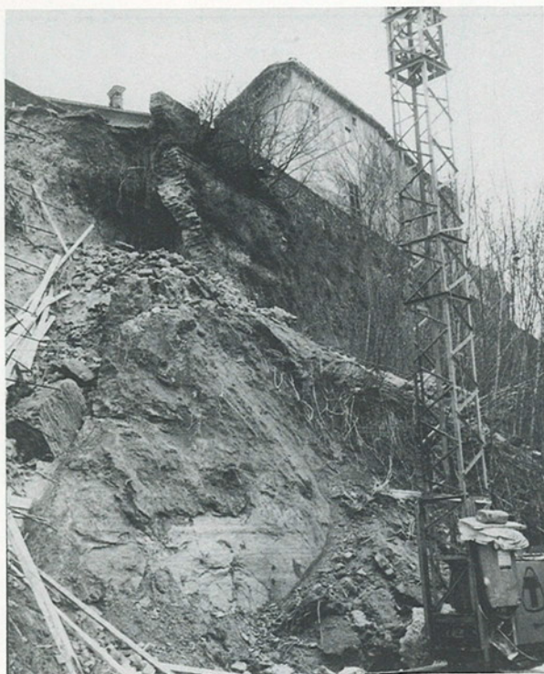
Figg. 3 e 4 - Crollo di un alto muro di sostegno (16 febbraio 1961), con interruzione di Via al Castello e pericolo per alcune abitazioni poste sul ciglio della scarpata.
