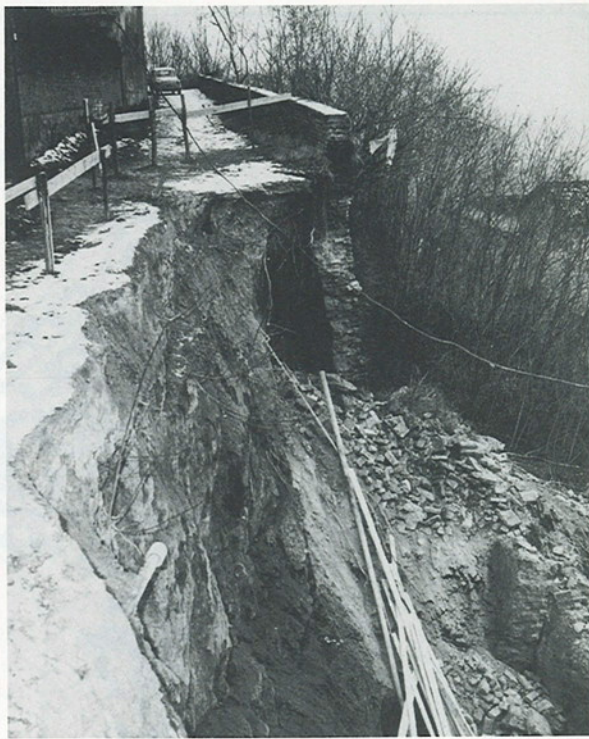
Figg. 3 e 4 - Crollo di un alto muro di sostegno (16 febbraio 1961), con interruzione di Via al Castello e pericolo per alcune abitazioni poste sul ciglio della scarpata.
