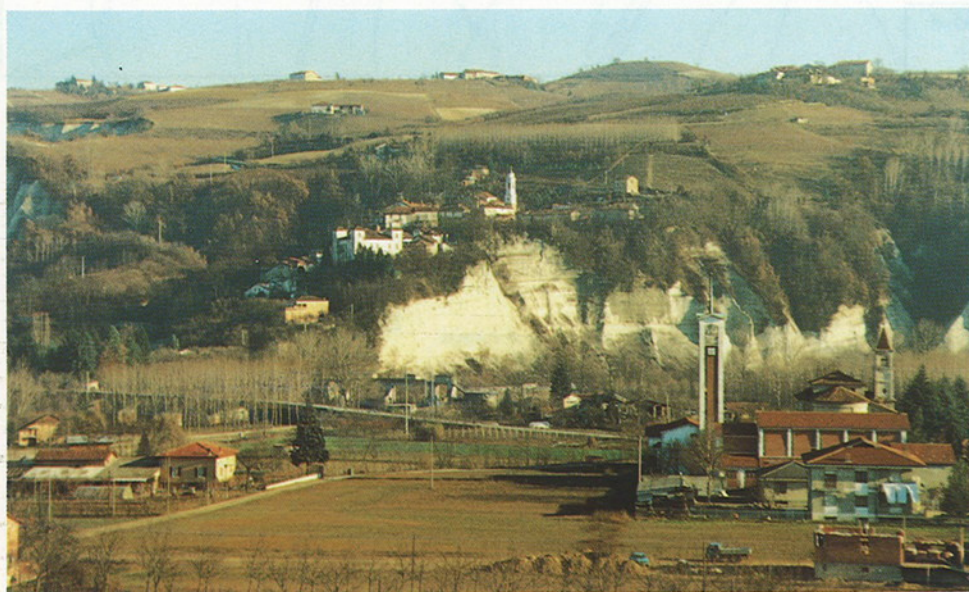
Fig. 1 - La parte antica del capoluogo sorge su alta scarpata in riva destra di un meandro del F. Tanaro. L'arretramento della sponda, per erosione fluviale, crea condizioni di disequilibrio nel ciglio superiore con conseguente caduta delle porzioni rocciose già isolate da fratture preesistenti.
