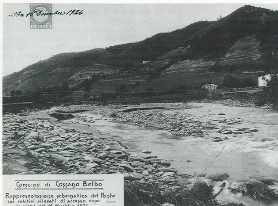
Fig. 3 - La ripresa dell'epoca testimonia i danni provocati dal T. Belbo durante l'alluvione del maggio 1926, quando la furia delle acque asportò il ponte in ferro, provocando una profonda erosione nella sponda sinistra.
