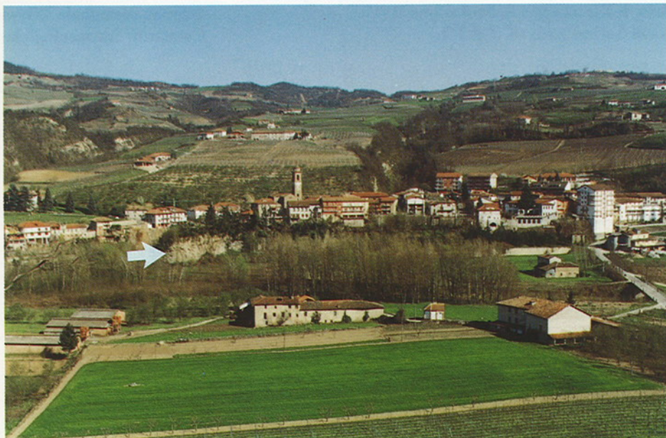
Fig. 1 - Abitato di Cossano Belbo fotografato dal versante sinistro del T. Belbo. Con la freccia è indicata la parete verticale dell'altezza di una quindicina di metri, sede in passato di numerosi crolli coinvolgenti alcune abitazioni situate sul margine della scarpata rocciosa. Sullo sfondo è visibile la profonda incisione nella quale scorre il Rio S. Maria che, per il tratto terminale, attraversa il paese in condotta sotterranea.
