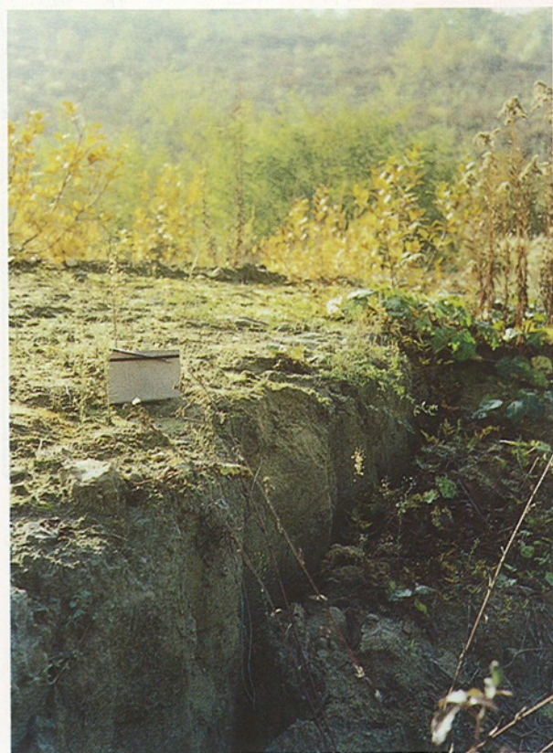
Fig. 6 - Particolare del vecchio corpo di frana: emergenza di un piano di scorrimento di neo-formazione. Nella parte medio-bassa del versante la superficie dell'accumulo, che ha subito notevoli movimenti di terra a fini sistematori, è interessata da una locale ripresa di movimento prevalentemente di tipo scorrimento rotazionale legata a movimenti di assestamento delle porzioni di accumulo aventi maggior acclività.
