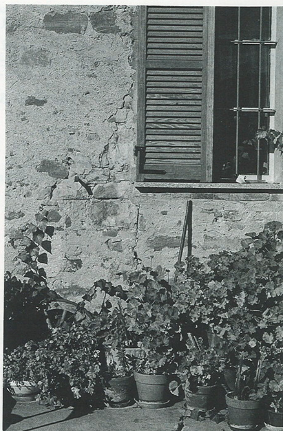
Figg. 2 e 3 - Lesioni nei muri perimetrali dei fabbricati di C.na Bormiotti, fotografati nel maggio 1990.
