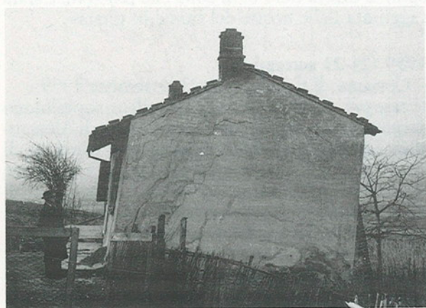
Fig. 5 - Abitazione di Brusaschetto, posta presso la strada comunale omonima, fotografata a metà degli anni '50. Malgrado gli speroni di rinforzo realizzati contro il muro di destra, rivolto a valle, la casa fu abbandonata e successivamente demolita.
