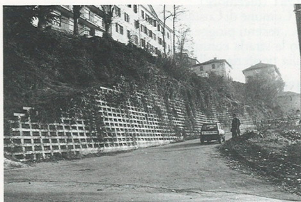
Fig. 2 - Muro di contenimento ad elementi componibili in c.a., costruito nel 1976 presso Via Fantolino.
