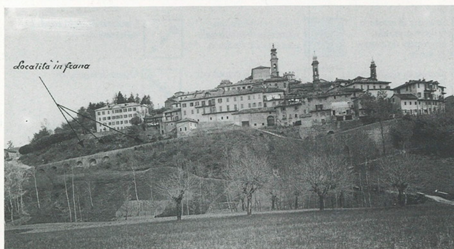
Fig. 1 - Settore occidentale dell'abitato fotografato nell'aprile 1941 quando parte del versante (indicata dalle frecce) fu coinvolta da uno scorrimento rotazionale.
