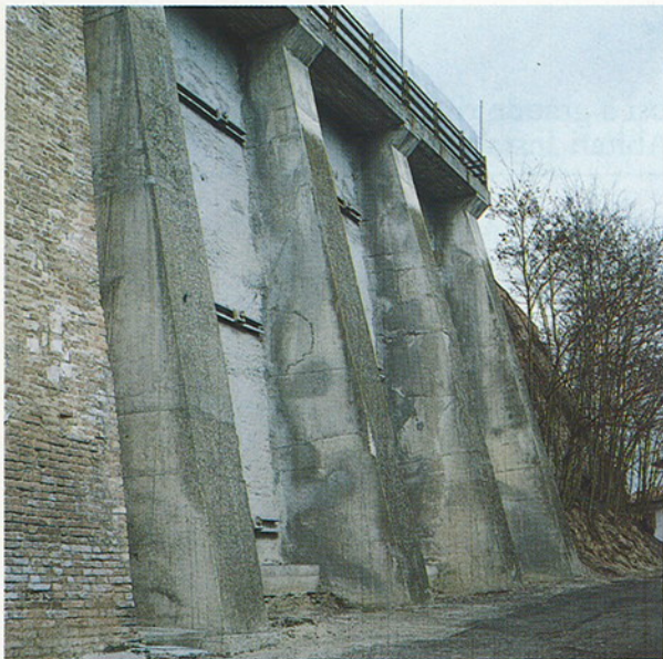
Fig. 2 - Muro in cemento armato con 4 barbacani, realizzato verso la metà degli anni '80 in Via al Castello.
