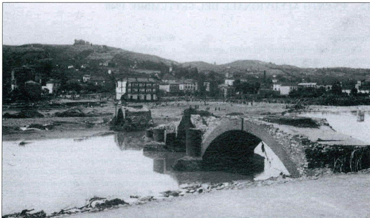
Fig. 11.5 Ovada: il ponte del Borgo dopo la catastrofe
