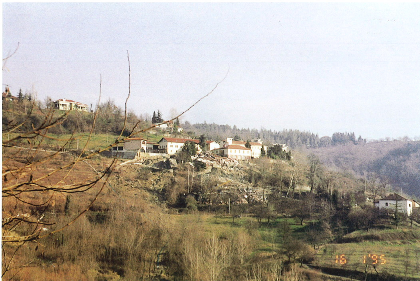
Fig. 26. Comune di S. Raffaele Cimena, località Suore del Sacro Cuore. Panoramica dell'area in dissesto.
