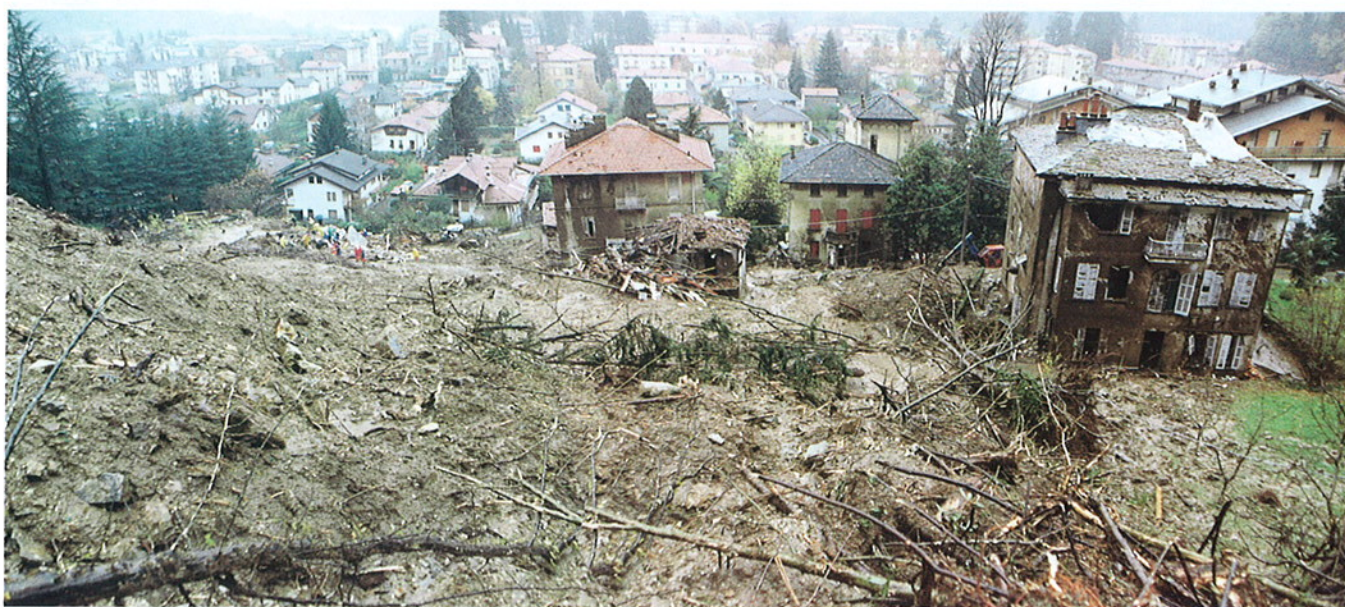
Fig. 38. Comune di Varallo, loc. concentrico (via Oberdan): vista da monte della zona devastata dalla frana; sulla sinistra i primi soccorsi nel punto dove la frana ha distrutto la casa e provocato le 14 vittime; in fondo e sulla destra le altre case danneggiate.
