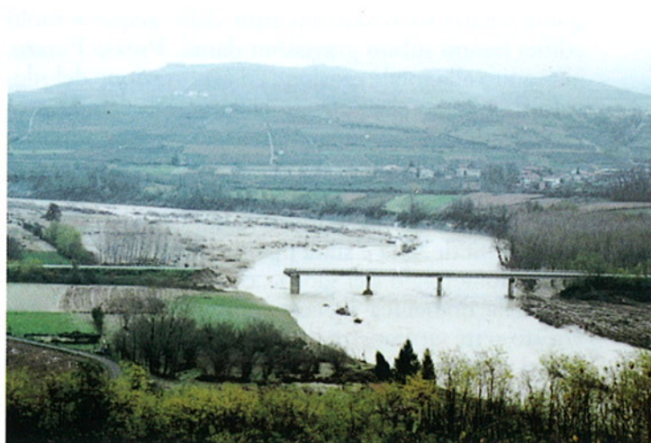
Fig. 4. Comune di Piozzo. La completa erosione del rilevato di sinistra del ponte Macagno, sul fiume Tanaro, ha provocato, la sera del 5 novembre 1994, la morte di 7 automobilisti.
