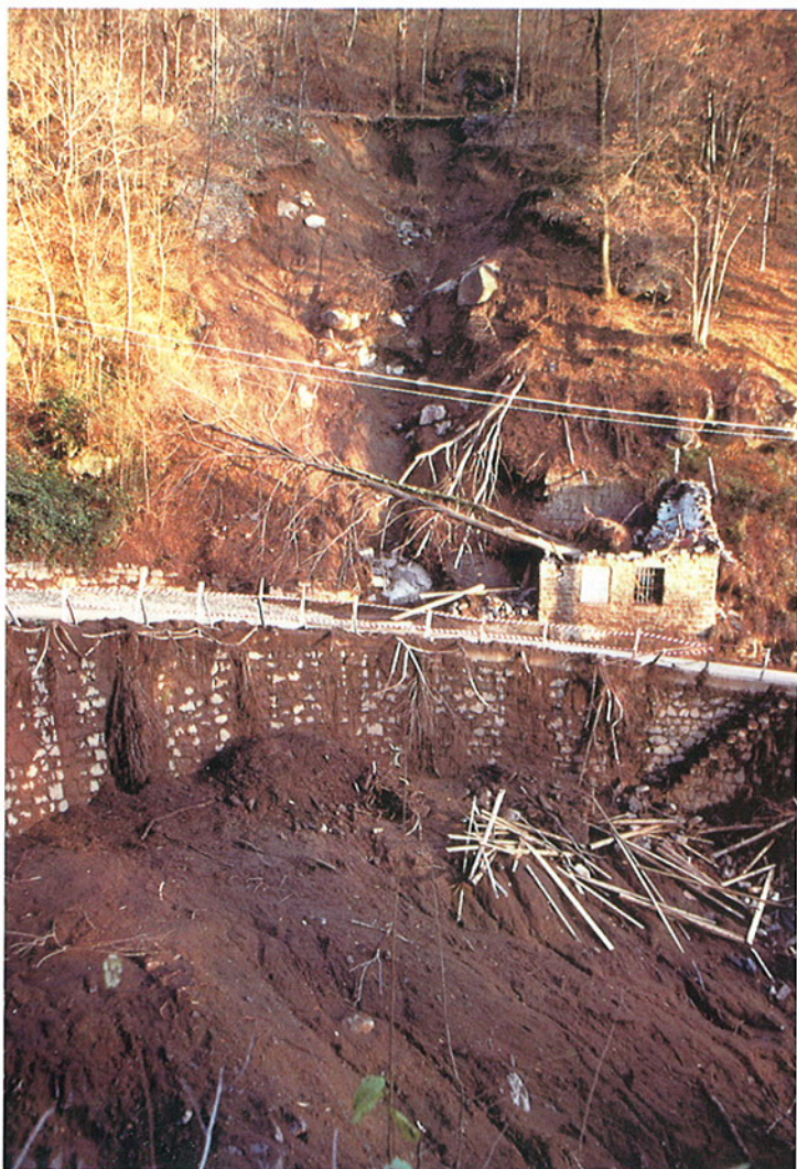
Fig. 37. Comune di San Paolo Cervo, loc. Riabella-Cattoino: la foto mostra la zona di distacco della frana che, distrutta una casa e danneggiata la strada, è defluita lungo la valle del rio Cattoino trasformandosi in colata detritica.
