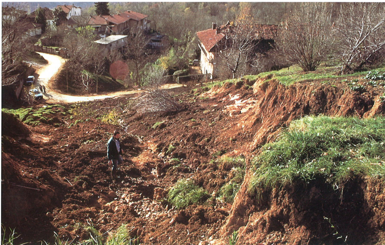
Fig. 29. Comune di Graglia, loc. Casale Zina: frana in materiali sciolti di alterazione che, scesi a valle molto fluidificati, hanno danneggiato la strada e sfiorato le case visibili sulla destra.
