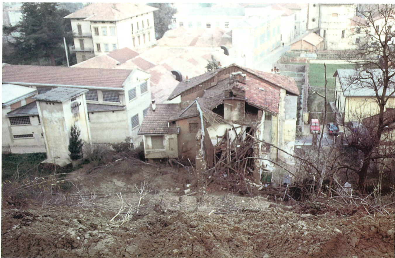
Fig. 34. Comune di Mongrando, fr. Ceresane: vista da monte dell'accumulo di frana costituito da materiale limo-sabbioso che ha raggiunto e distrutto la parte posteriore dell'edificio.
