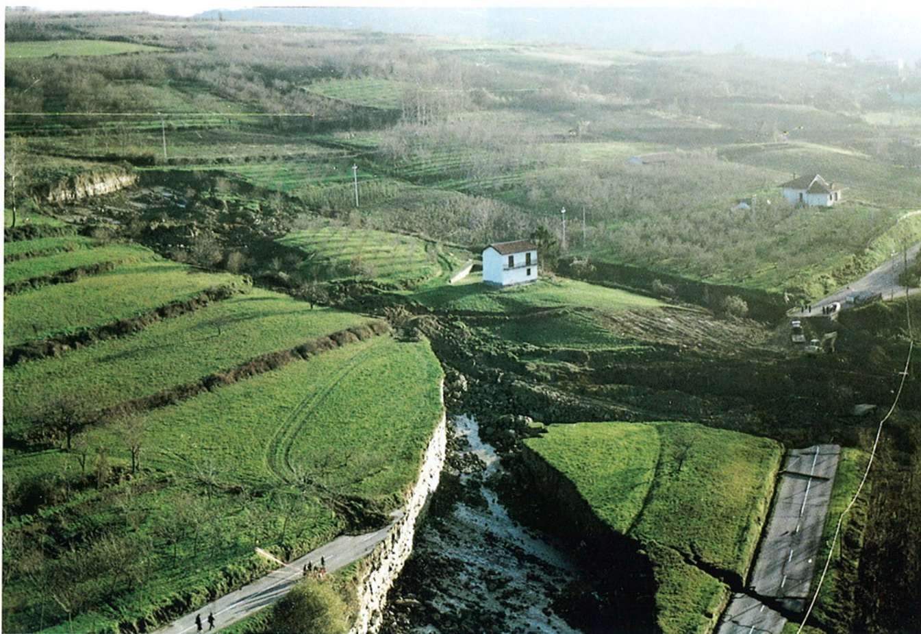
Fig. 5. Comune di Feisoglio. La strada di accesso all'abitato e l'edificio al centro della foto hanno subito traslazione a causa di una frana per scivolamento planare.
