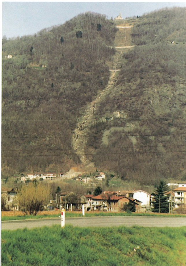
Fig. 17. Comune di Lessolo, località Ronchi. La foto, nella quale compaiono già alcuni interventi realizzati per la sistemazione del rio e a difesa dell'abitato, riprende l'intero tracciato percorso dai materiali in frana, a partire dal cimitero presso il Santuraio di Brosso, sino alle abitazioni in Località Ronchi nel comune di Lessolo.
