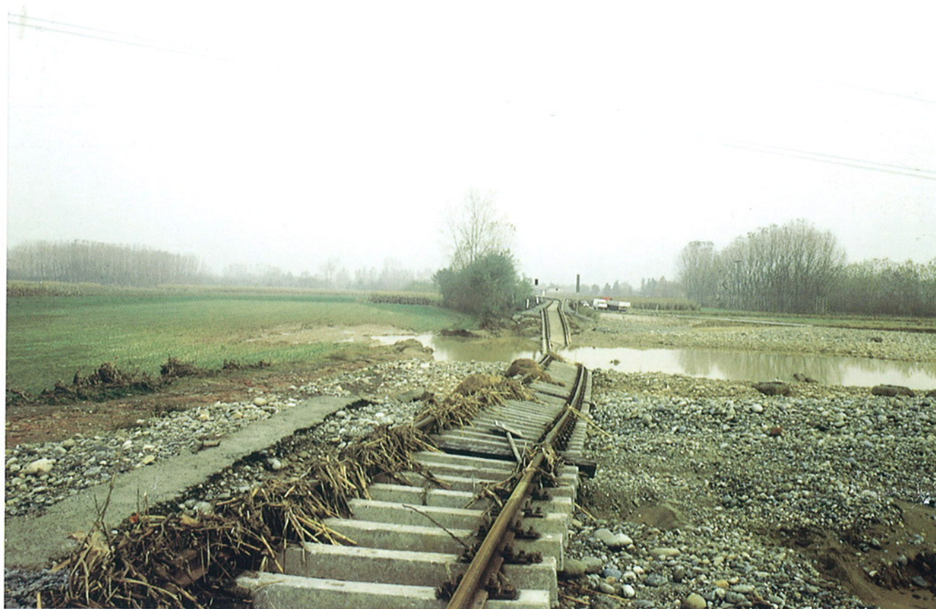
Fig. 25. Comune di Volpiano. Ripresa lungo la ferrovia canavesana; evidenti i danni causati dalle acque di esondazione del T. Malone straripate in destra idrografica a monte dell'abitato di S. Benigno (direzione delle acque da sinistra verso destra foto).
