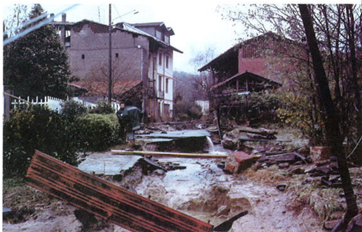
Fig. 41. Comune di Mongrando, loc. Tana: in primo piano, visti da valle, i gravi danni arrecati alle strade e infrastrutture di servizio dalle acque del T. Viona fuoriuscito a monte della frazione.
