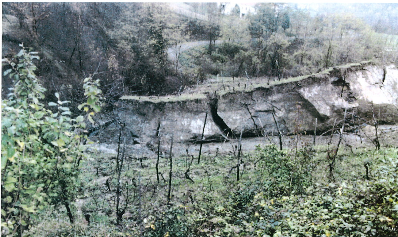
Fig. 14. Prasco, novembre 1994. Scivolamento planare che ha interessato la strada provinciale n. 206 "della Cavalla".
