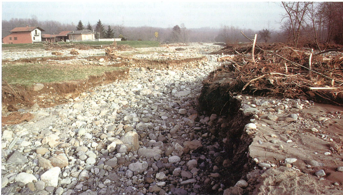
Fig. 39. Comune di Cerrione, loc. M. Vianzé: vista da monte del nuovo canale creato dal disallineamento del rio della Sorda; sullo sfondo a sinistra i depositi di materiale grossolano e la cascina evacuata durante l'evento.
