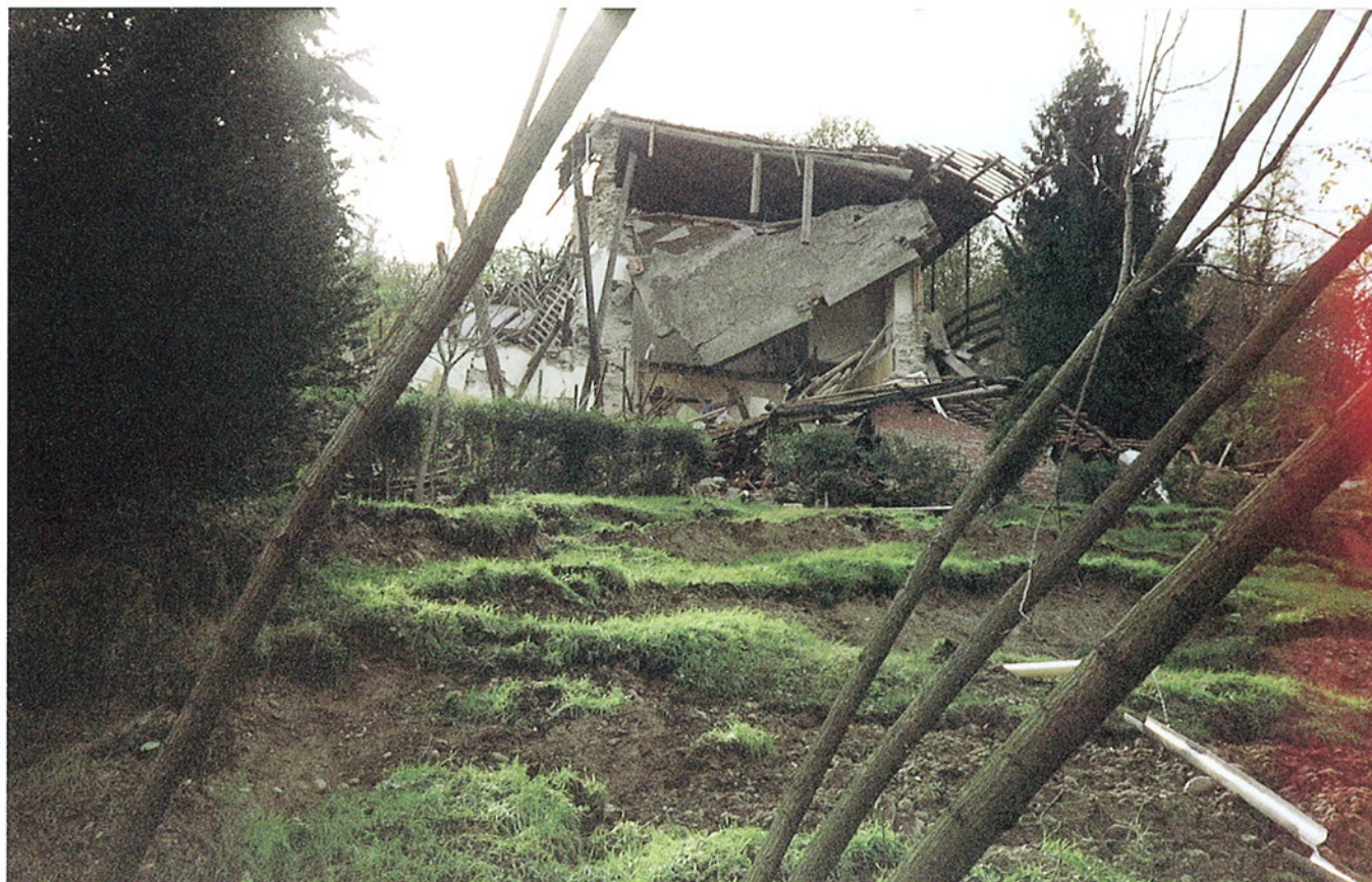
Fig. 20. Comune di S. Martino Canavese, località Canton Lavo. Ripresa dei settori di testata del movimento franoso che ha parzialmente distrutto Cascina Rivalta.
