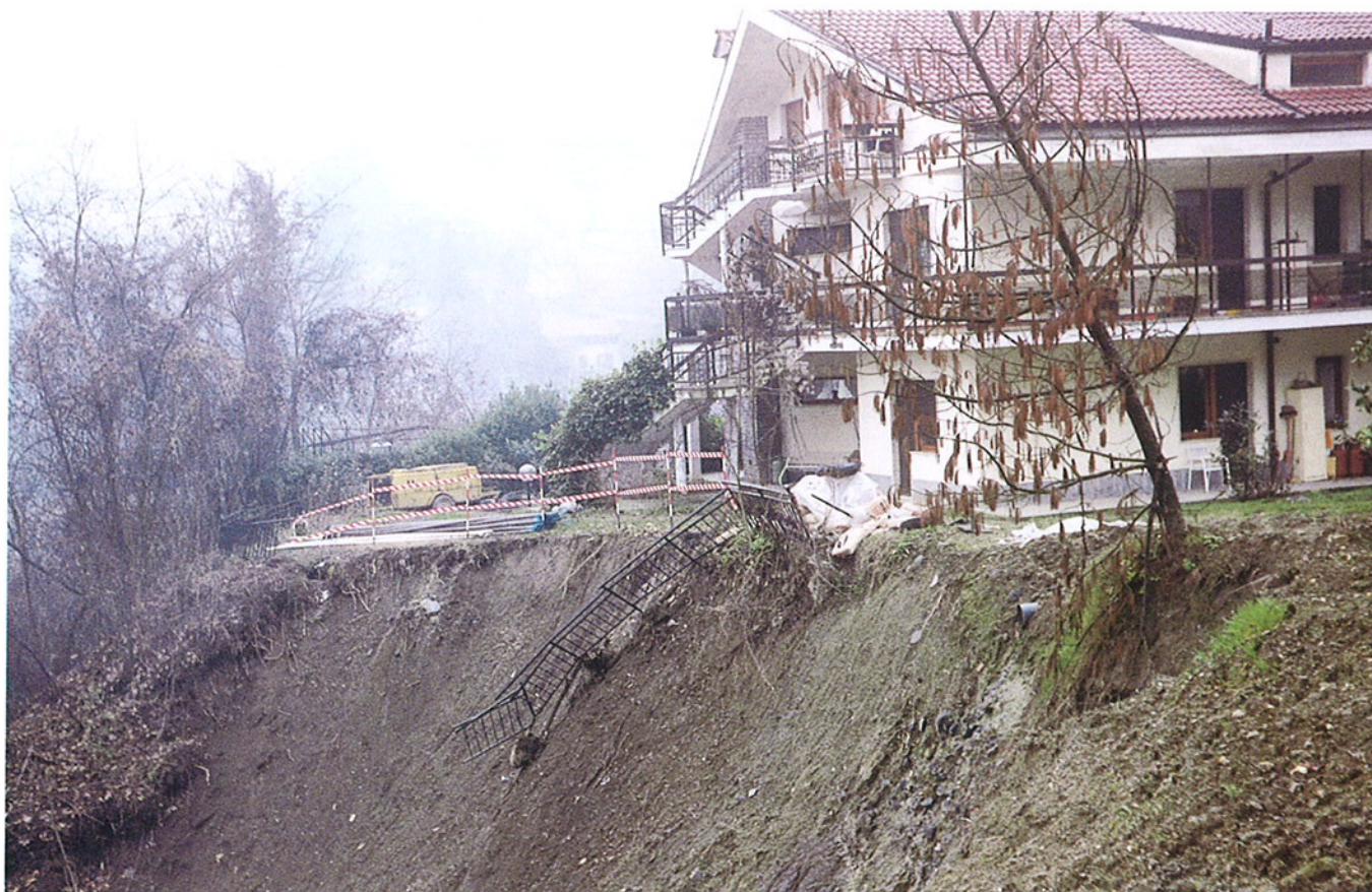
Fig. 28. Comune di Torino, loc. Val San Martino: il Poggio Particolare della frana che ha coinvolto le coltri eluvio-colluviali di copertura.
