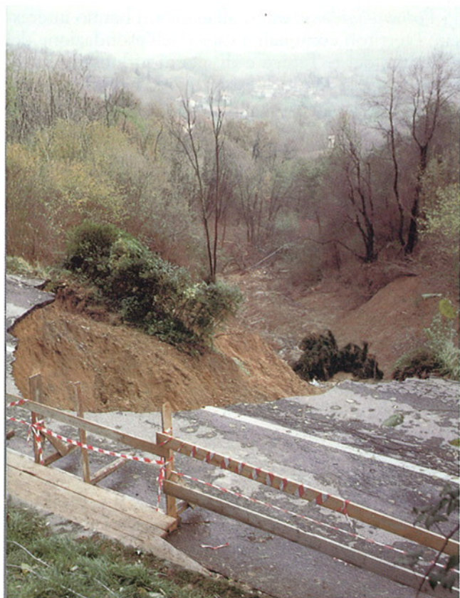
Fig. 30. Comune di Netro, loc. case Bianchin: vista della frana che ha interrotto le comunicazioni tra Netro e Graglia; in primo piano il danno alla strada; sullo sfondo si nota il percorso verso valle della colata di materiale fluidificato.
