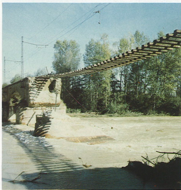
Fig. 13 - Crollo di un ponte, lungo la linea ferroviaria Bra-Ceva, presso Cherasco (CN) sul T. Stura di Demonte durante l'evento di piena dell'ottobre 1979.
