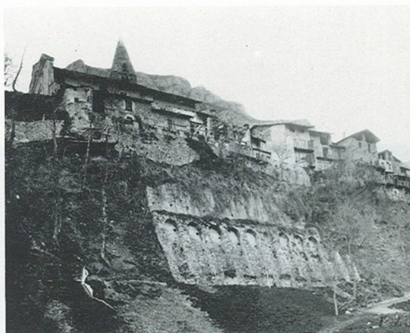
Fig. 4 - In questa foto del 1930 la scarpata sottostante l'abitato appare solo parzialmente interessata da interventi di sostegno (Archivio C.N.R.-I.R.P.I. Torino).
