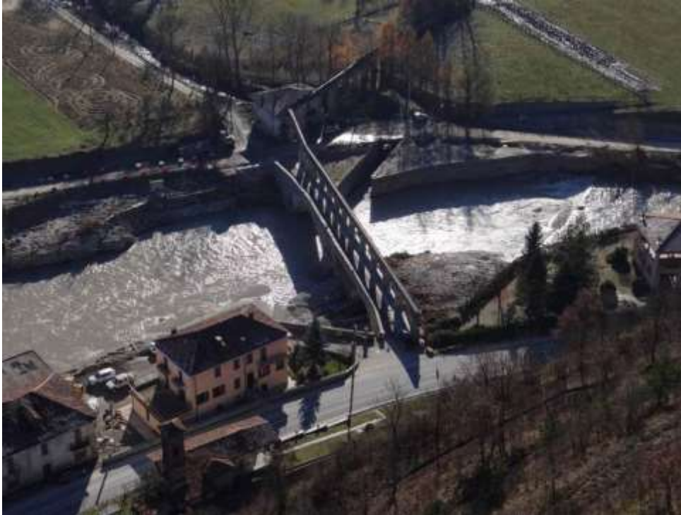
Figura 16. Edifici in sinistra idrografica coinvolti dalla piena del Tanaro, in corrispondenza del ponte Romano, Bagnasco
