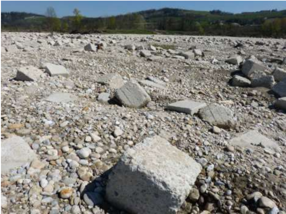
Figura 57. Neive - Blocchi in cemento costituenti vecchie difese spondali antierosione trasportate dalla piena e depositate in area golenale
