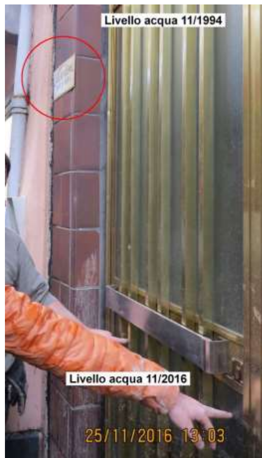
Figura 6. Confronto tra il livello raggiunto dalle acque esondate in occasione dell'evento di novembre 1994 e quello di novembre 2016 nell'abitato di Gressio (foto dott. Aldo Acquarone)
