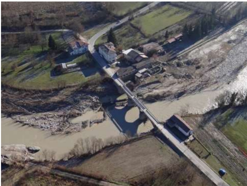
Figura 17. Bagnasco, edifici in destra idrografica coinvolti dalla piena del Tanaro
