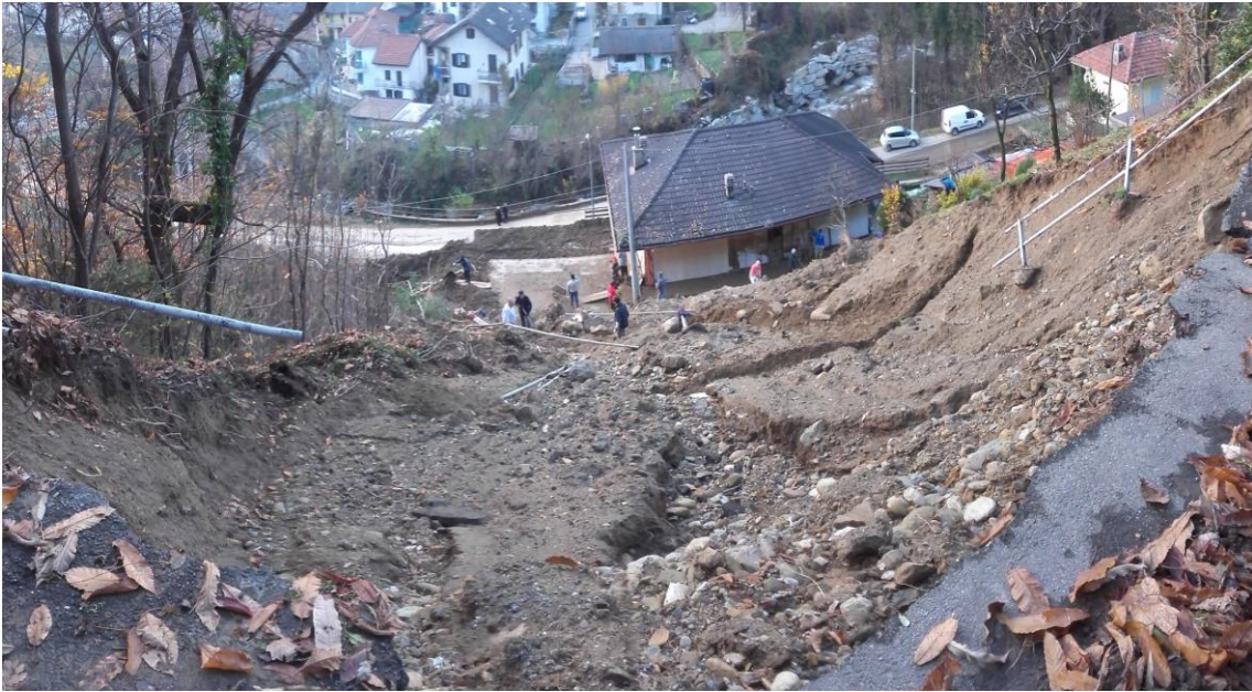
Figura 15. Frana della coltre superficiale in comune di Perosa Argentina con coinvolgimento di abitazione e viabilità.
