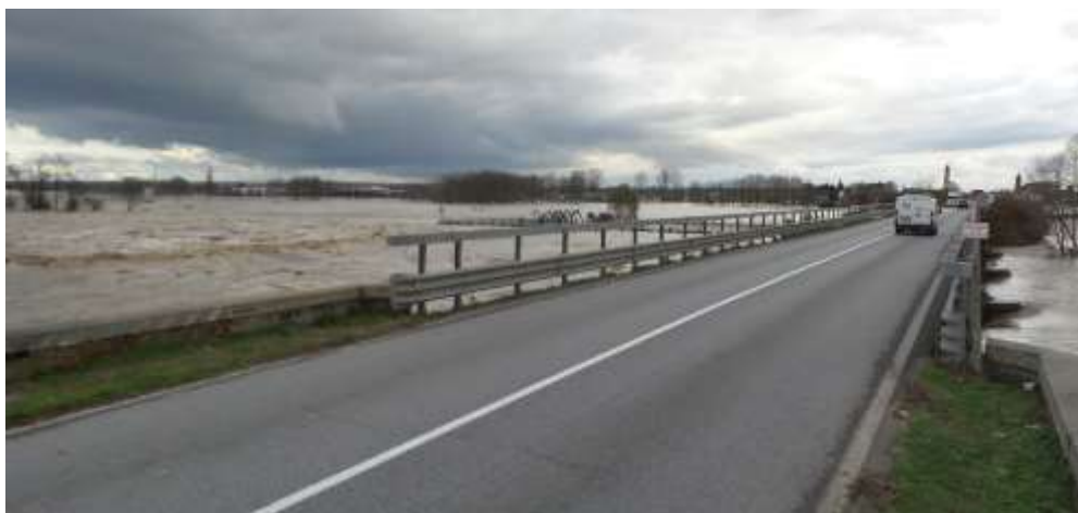
Figura 5. Ponte sul Po a Casalgrasso
