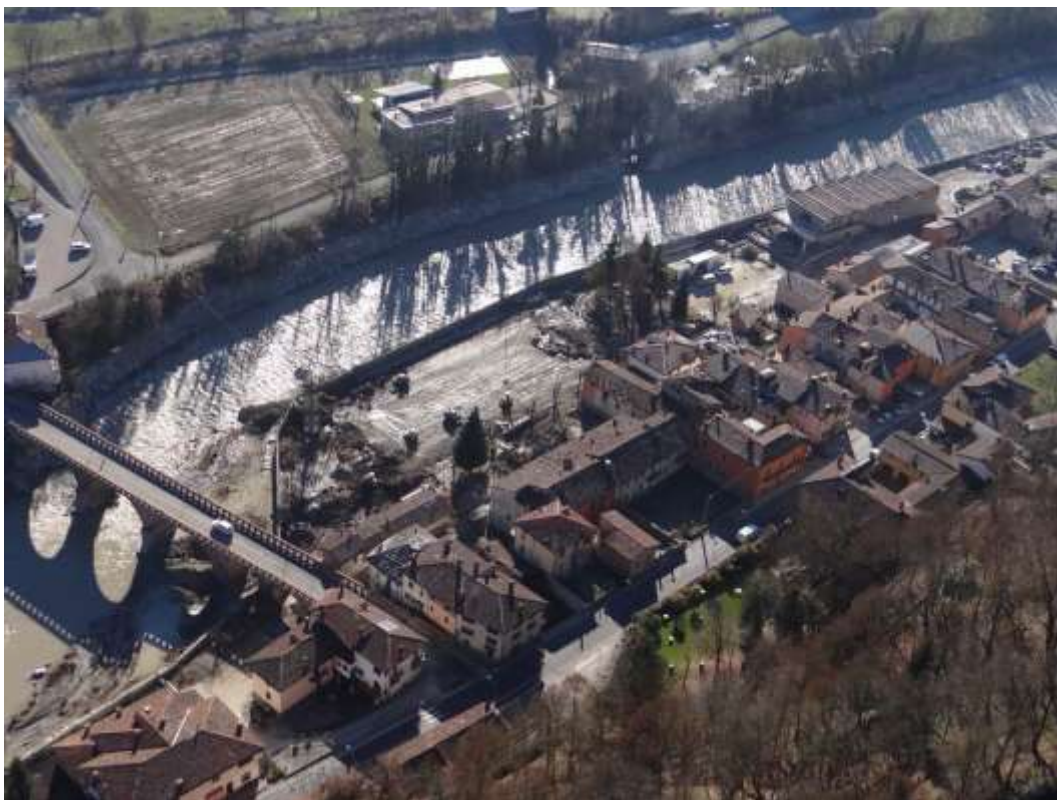
Figura 21. Nucetto, effetti della piena del 24-25 novembre 2016 in corrispondenza del campo da calcio
