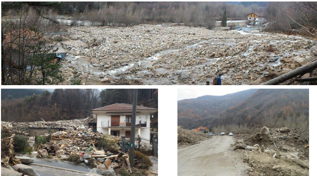
Figura 11. Rio Briera. Forte accumulo di detriti sul fondovalle con danni a infrastrutture e opere antropiche (Foto CNR-IRPI Torino, Regione Piemonte)
