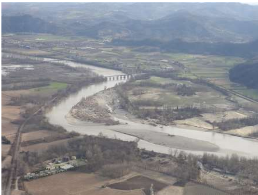
Figura 27. In primo piano le aree golenali a monte del ponte ferroviario tra Chivasso e San Sebastiano da Po interessate (Foto CNR IRPI)
