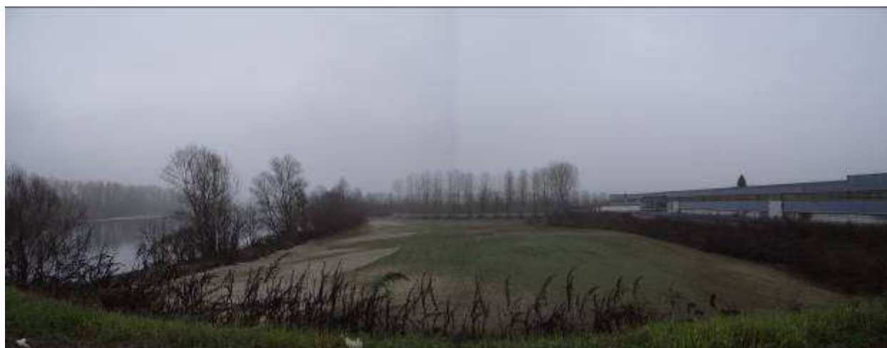
Figura 28. A valle del ponte della SP94 in comune di San Sebastiano da Po
