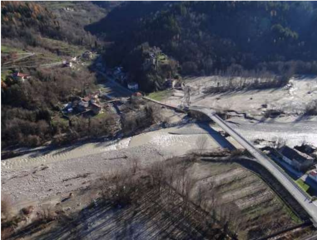
Figura 10. L'abitato di località Borgo, in destra idrografica, interessato dall'esondazione del rio San Giusto
