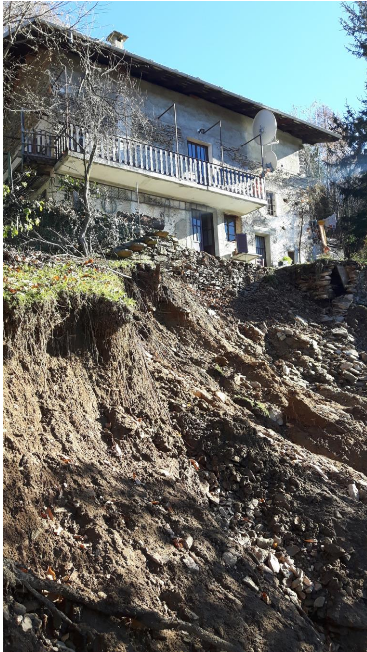
Figura 17. Comune di Pinasca. Frana superficiale che ha lambito edifici e confluita poi nel rio delle Combe
