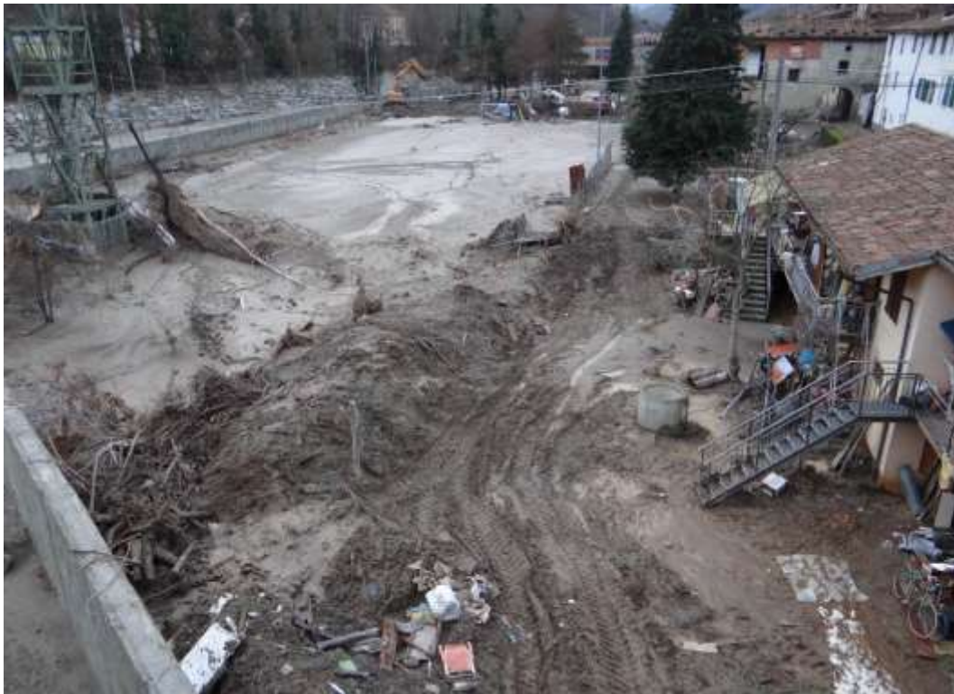
Figura 20. Nucetto, effetti della piena del 24-25 novembre 2016 in corrispondenza del campo da calcio
