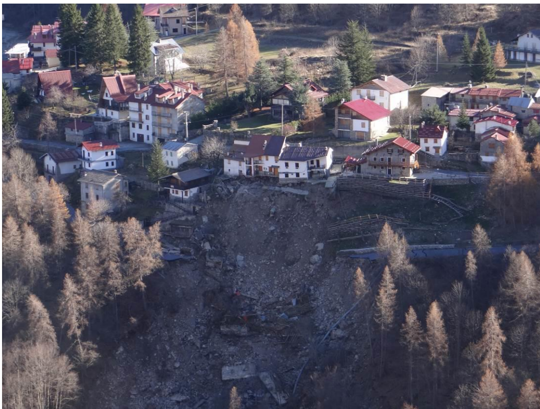
Figura 17. Settore frontale della frana di Monesi con evidenza della distruzione della strada e delle opere di sostegno al versante; fotografia scattata il 29 novembre 2016
