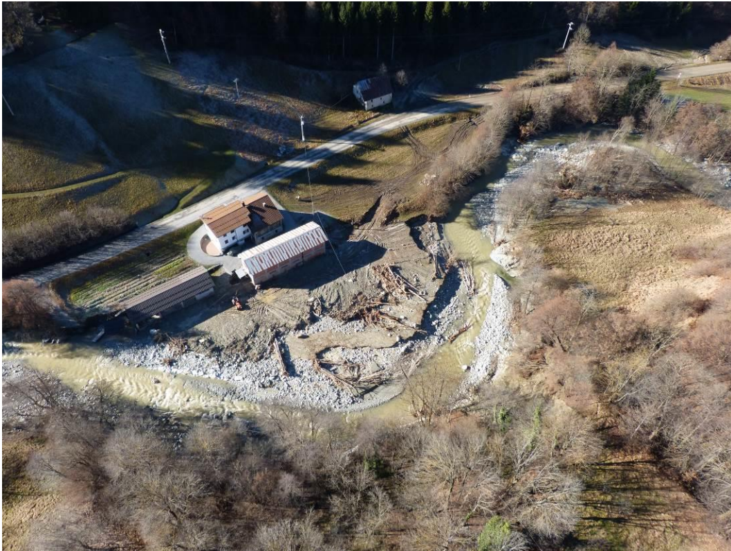
Figura 10. Torre Mondovì, loc. Melu-Merizzo; violenta attività torrentizia con coinvolgimento di una piccola azienda agricola. Fotografia scattata il 30 novembre 2016
