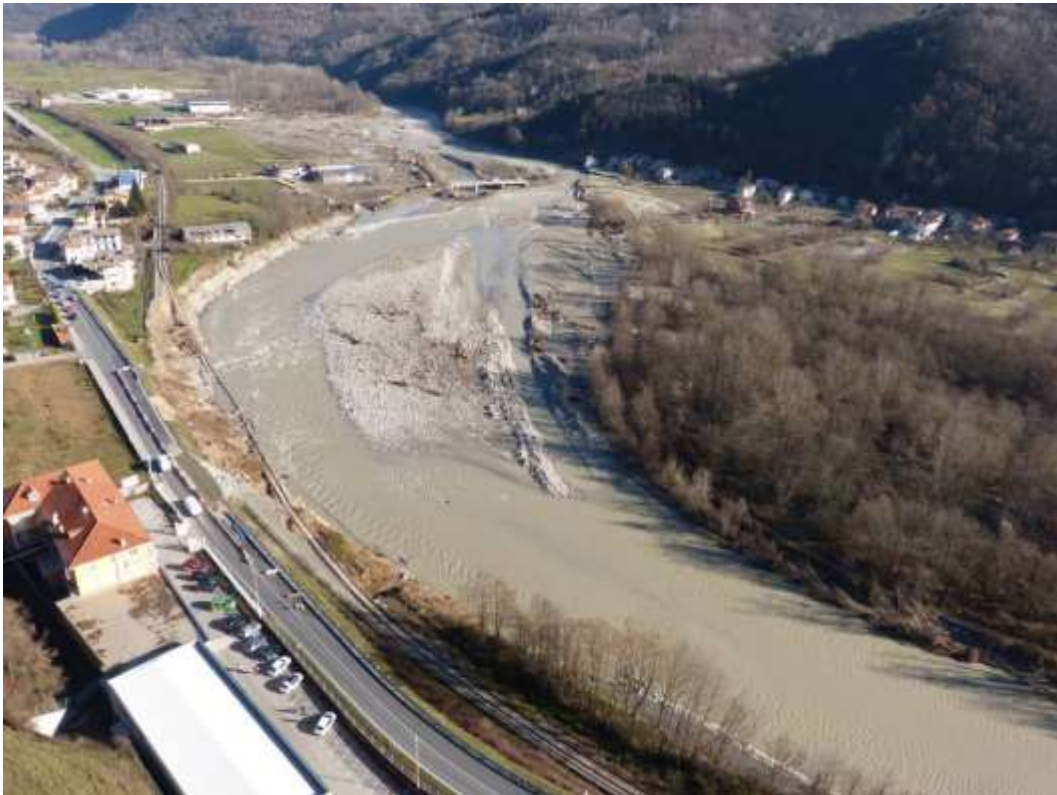
Figura 12. Erosione in sponda sinistra con asportazione ferrovia e parte SS28; sullo sfondo il ponte per Pianchiosso e la frazione parzialmente in ombra; Tanaro visto da monte
