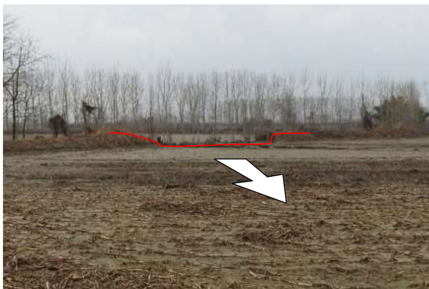
Figura 4. Rotta arginale a Faule evidenziata dalla linea rossa
