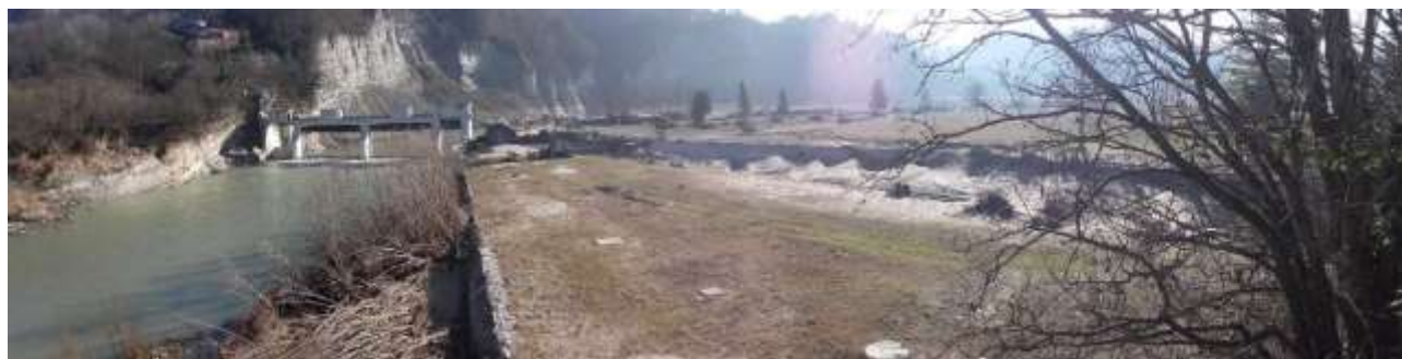
Figura 35. Clavesana - Effetti dell'evento di piena del 2016 in corrispondenza della traversa fluviale nei pressi della località La Generala
