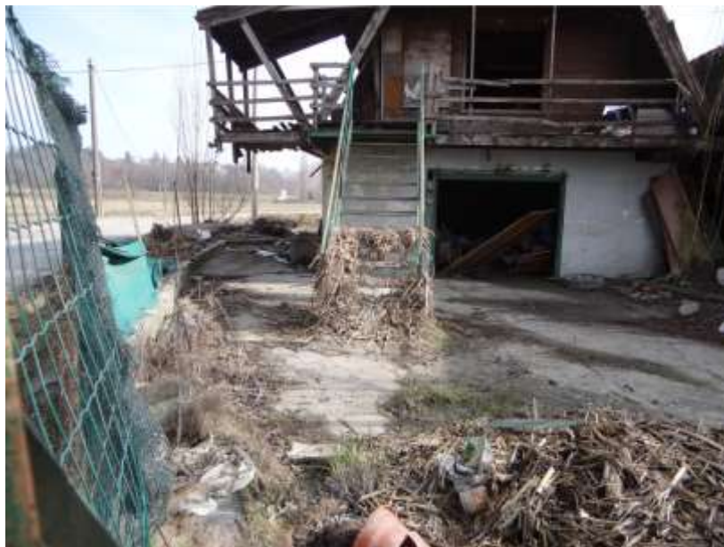
Figura 3. Effetti dell'esonazione nell'area del cementificio abbandonato di via Almese, in comune di Alpignano. (Foto Arpa del 21/02/2017)
