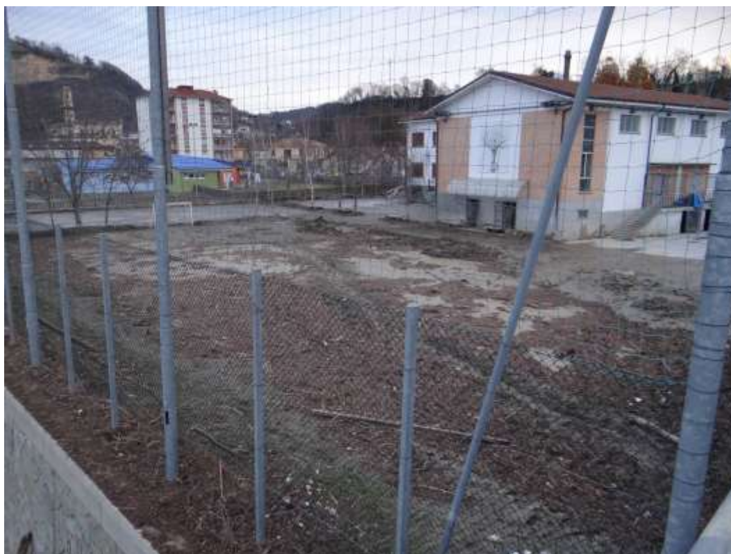
Figura 23. Ceva, deposito fine e di materiale fluitato nel campo sportivo a tergo del cinema, in prossimità del F. Tanaro
