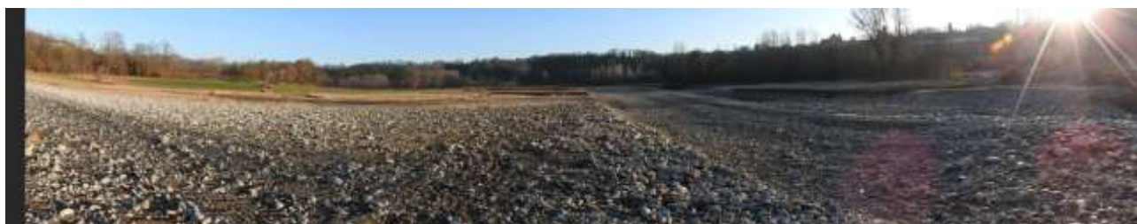
Figura 33. Niella Tanaro (loc. Madonna della Neve - C.na Lucchi) - Canale d'erosione in destra idrografica (vista d'insieme)
