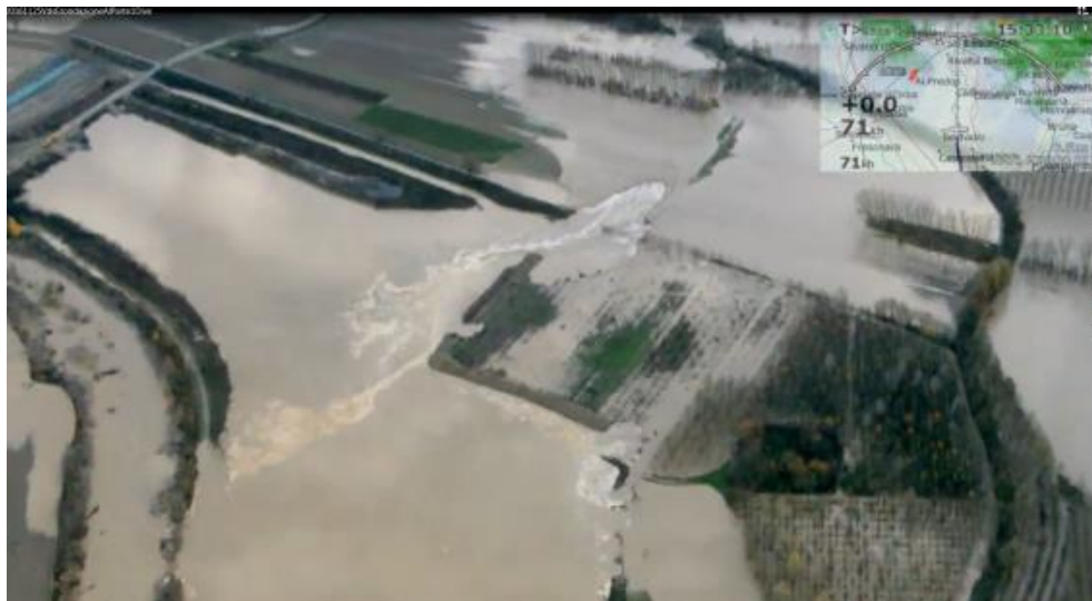
Figura 16. Comune di Sezzadio fotogramma di una ripresa aerea effettuata alle 15.30 del 25/11, in corso d'evento. Erosione operata dal F. Bormida che ha asportato uno strato di sedimenti di spessore anche superiore a due metri su un'area superiore all'ettaro. Le riprese da cui è tratto il fotogramma effettuate e rese disponibili da Mauro Olivotti sono state un supporto preziosissimo per la realizzazione delle cartografie relative all'evento di piena e per la comprensione delle sue dinamiche
