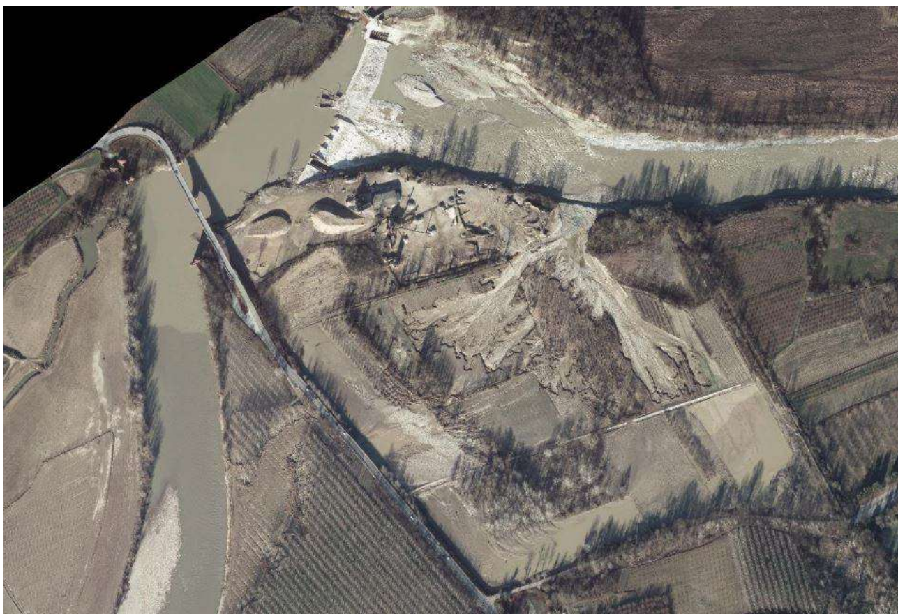
Figura 51. Ponte di Pollenzo - Ripresa aerea del volo effettuato a seguito dell'evento. Erosioni e depositi a valle della SP7
