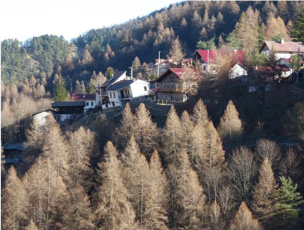
Figura 18. Perdita totale della verticalità degli edifici posti al coronamento della frana frontale di Monesi; fotografia scattata il 9 dicembre 2016
