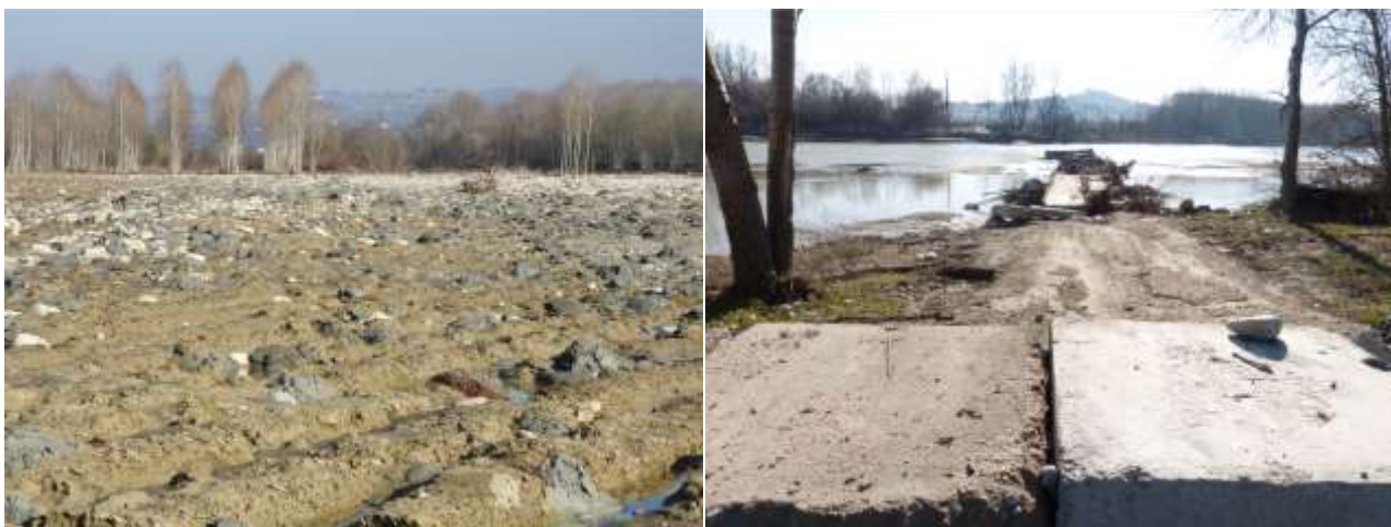
Figura 52. A sinistra, Alba - Blocchi di substrato marnoso erosi dal fondo alveo e depositati in sinistra idrografica, a monte della città di Alba; a destra asportazione di un guado in alveo a ridosso dei comuni di Roddi, Monticello e Alba
