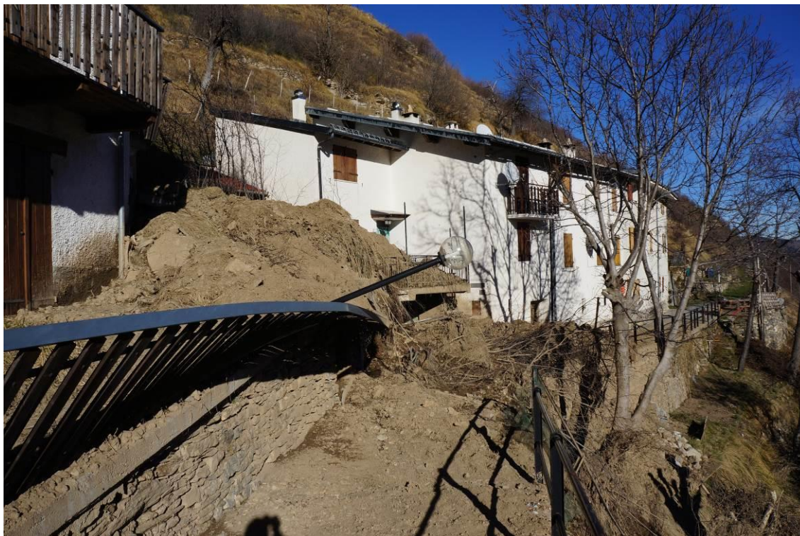
Figura 4. La principale colata che ha investito l'abitato di Piaggia
