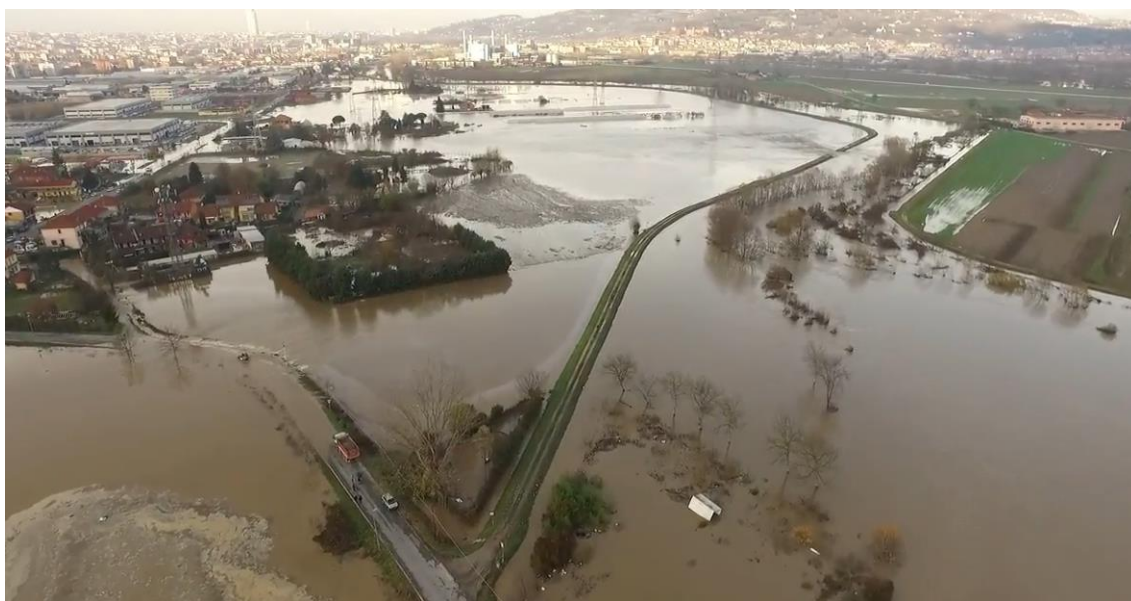
Figura 11. Comune di Moncalieri, Borgata Tetti Piatti; argine sormontato e rotta arginale a nord di Strada Barauda. (www.youtube.com, Giorgio Ferraris)
