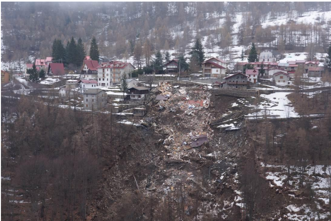
Figura 19. Ulteriore evoluzione della frana frontale di Monesi con avvenuto crollo degli edifici più colpiti; fotografia scattata il 3 marzo 2017
