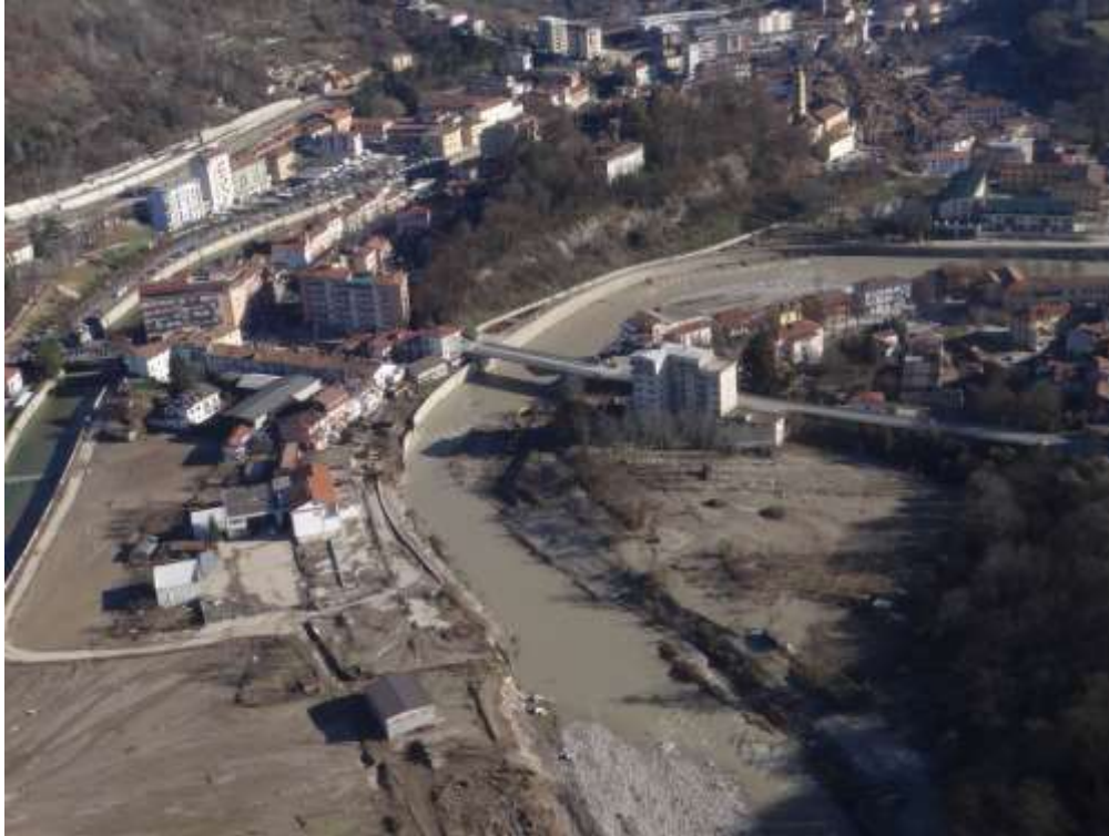
Figura 25. Ceva, aree in prossimità del ponte della SS28. Vista verso monte
