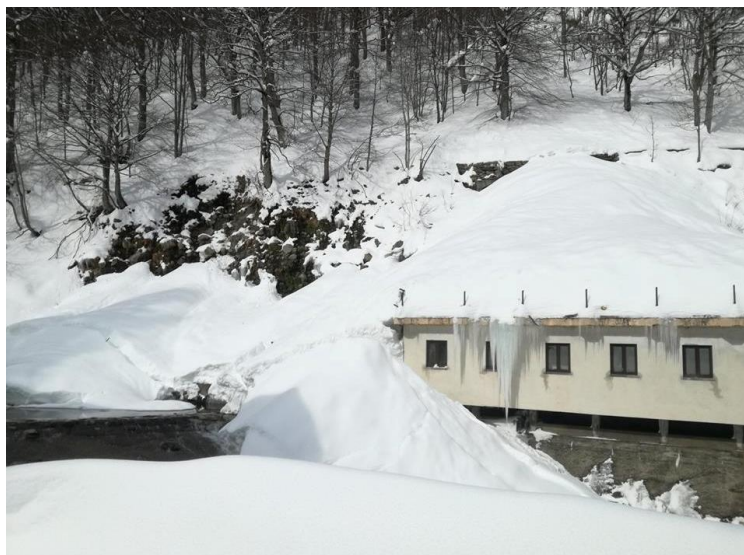
Figura 4.31: Parte della zona di arresto della valanga detta "delle Acque calde" che ha superato i limiti noti andando ad impattare sulla Casa Savoia (Foto di Andrea Cismondi - gestore del rifugio).
