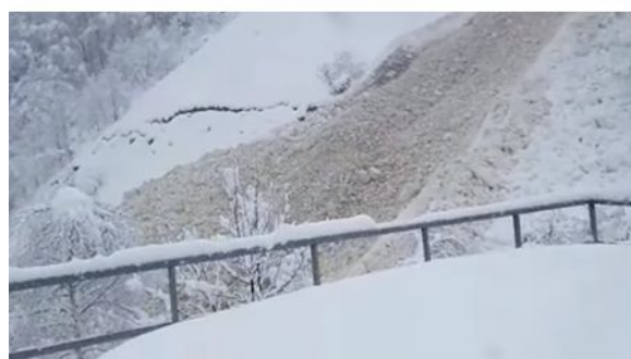
Figura 4.38: valanga di rio freddo che lambisce la costruzione Enel e prosegue fino a raggiungere il fondo valle (fotogrammi estratti dal video inviatoci dal guardiano della diga)
