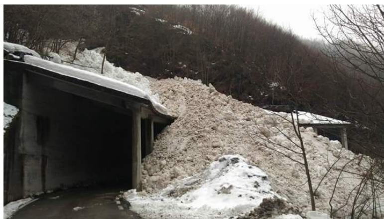
Figura 4.41: dettaglio della zona di accumulo della valanga detta del “vallone Franco” dove si può notare come la galleria paravalanghe abbia svolto a pieno il compito di protezione (Foto PAM).
