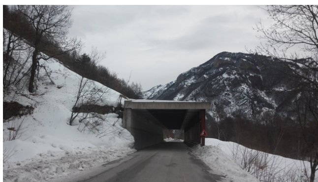
Figura 4.2: paravalange sulla strada per le terme di Valdieri ormai sgombero dall'accumulo della valanga (foto della CLV scattata il 18 dicembre)
