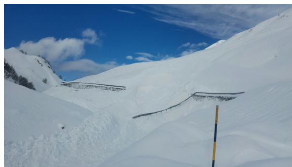
Figura 4.6: valanga sul Colle della Maddalena che ha divelto oltre 60 m di guardrail (Foto della CLV).
