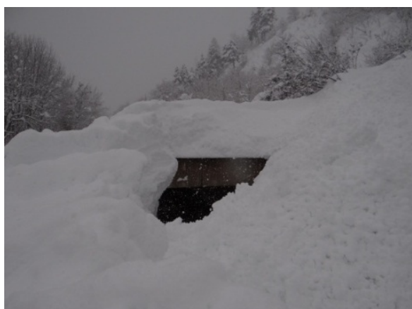
Figura 4.9: paravalanghe sepolto dall'accumulo della valanga.
