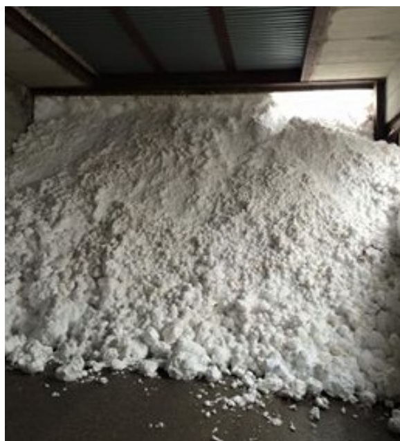
Figura 4.14: accumulo della valanga visto dall'interno del paravalanghe.
