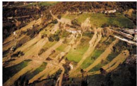
Figura III-3. Rete stradale intercettata da frane (Langhe piemontesi, novembre 1994, foto CNR-IRPI)
