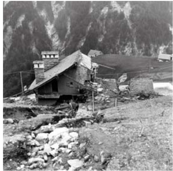
Figura III-2. Edificio travolto da una colata rapida nel bacino del Torrente Melezzo Orientale, con una vittima (agosto 1978, foto CNR-IRPI)
