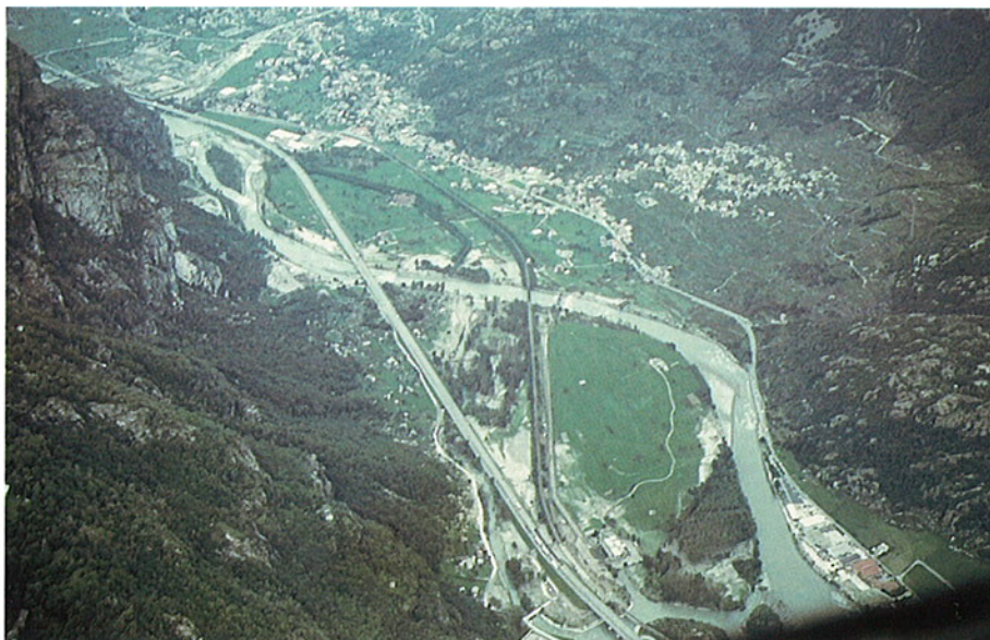
FOTO 19 - Fiume Dora Baltea a nord di Quincinetto: canale laterale attualmente regimato attraversato dal rilevato autostradale. In primo piano si osserva il tratto di rilevato ferroviario asportato.
