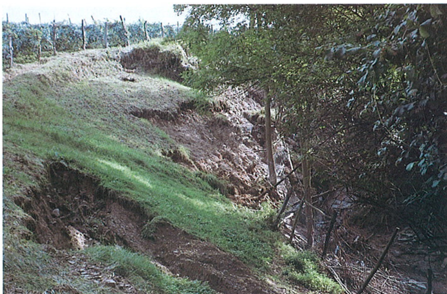
FOTO 83 - Roccaverano, smottamenti lungo la S. P. 56.
