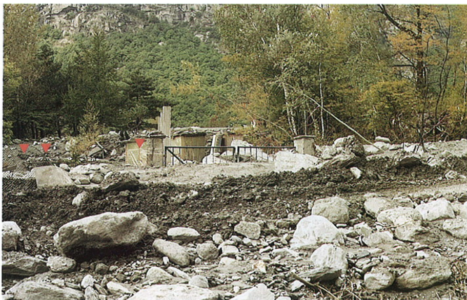
FOTO 74 - Particolare del materiale depositato, poco a valle del ponte sulla provinciale Novalesa-Venaus; da osservare il cancello completamente sommerso dai sedimenti, ma non lesionato ed, in primo piano, verso sinistra (evidenziata), la rete metallica piegata ma non divelta, a testimonianza di lente velocità di propagazione della colata (deflusso verso sinistra).
