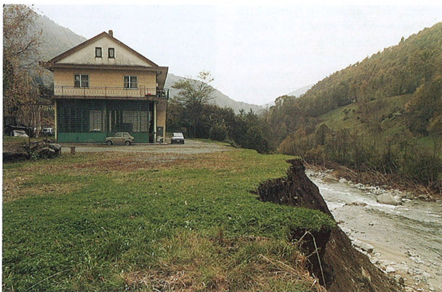
FOTO 63 - Comune di Ceres (TO). Edificio di civile abitazione prossimo al ciglio di una scarpata di erosione del T. Stura.
