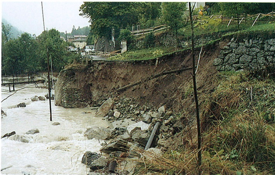
FOTO 59 - Comune di Chialamberto: località Mottera. Frana per erosione al piede del rilevato della Strada Provinciale. L'interruzione della strada ha isolato la parte alta della Valgrande per alcuni giorni.
