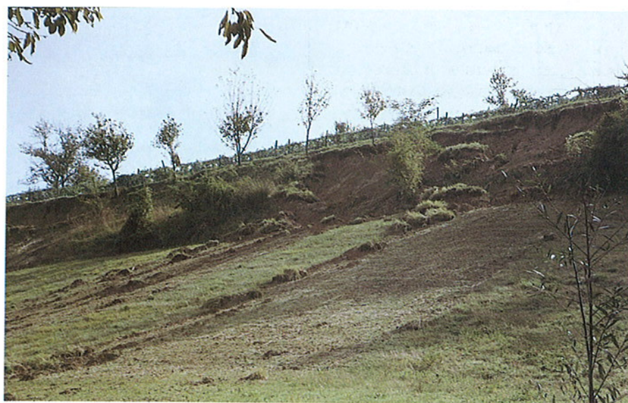
FOTO 82 - Roccaverano (AT), smottamenti e ruscamenti lungo la S.P. 56.
