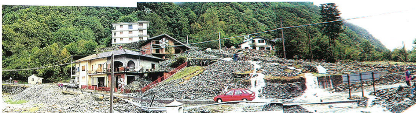
FOTO 44 - Attivazione del conoide di Bardonetto Superiore (Locana). Gli asterischi indicano le abitazioni danneggiate; la freccia indica il manufatto di attraversamento della Strada Statale, completamente ostruito.
