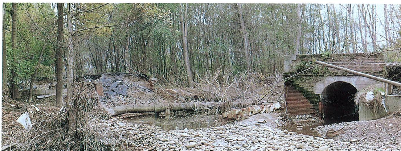
FOTO 56 - Particolare del rilevato della provinciale San Benigno-Fogizzo, sfondato in prossimità di un sottopasso idraulico.
