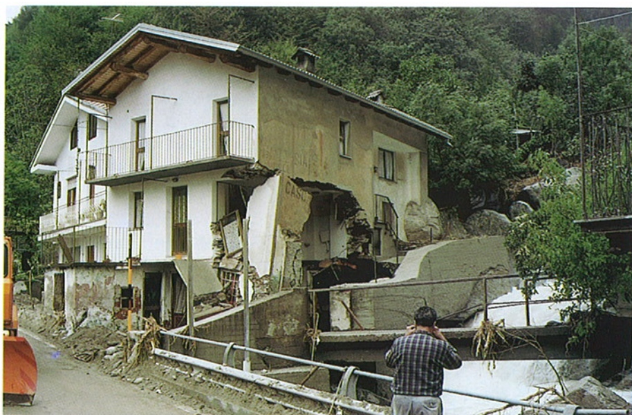
Foto 45 - Noasca (TO), abitazione danneggiata per attivazione del conoide alluvionale del Rio Noaschetta. Lo stesso fenomeno ha provocato, nel settembre 1994 la completa distruzione dell'abitazione.
