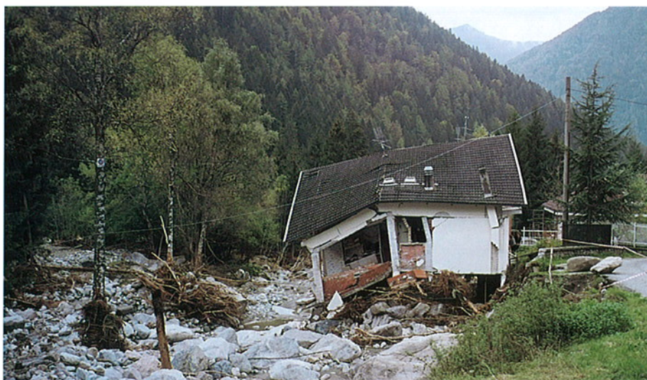
FOTO 33 - Abitazione distrutta di cui alla foto precedente.
