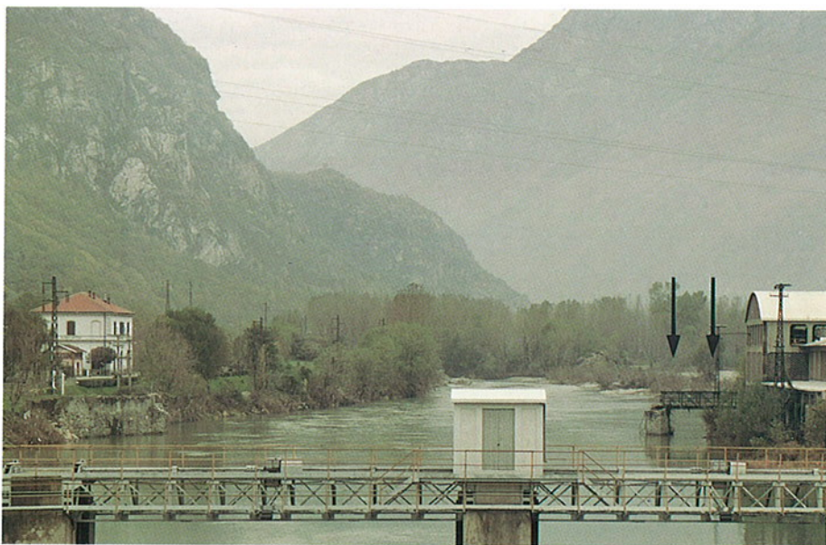
FOTO 17 - Quincinetto (TO): in secondo piano si osserva (indicata dalle frecce) la struttura restante del ponte crollato durante la piena.
