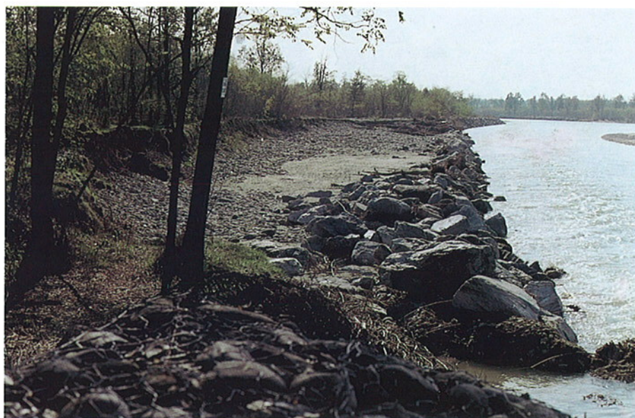
FOTO 48 - Esempio di erosione a tergo di difese spondali.
