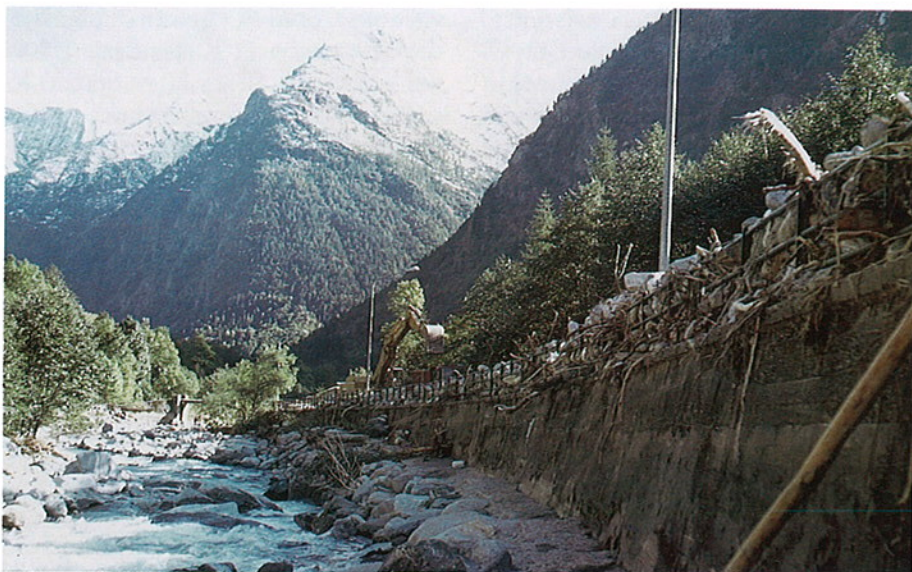
FOTO 11 - Particolare della fotografia 9, che mostra la ristretta e non adeguata sezione dell'alveo. Sulla destra il muro-argine della Strada Statale di circonvallazione invasa dai detriti.
