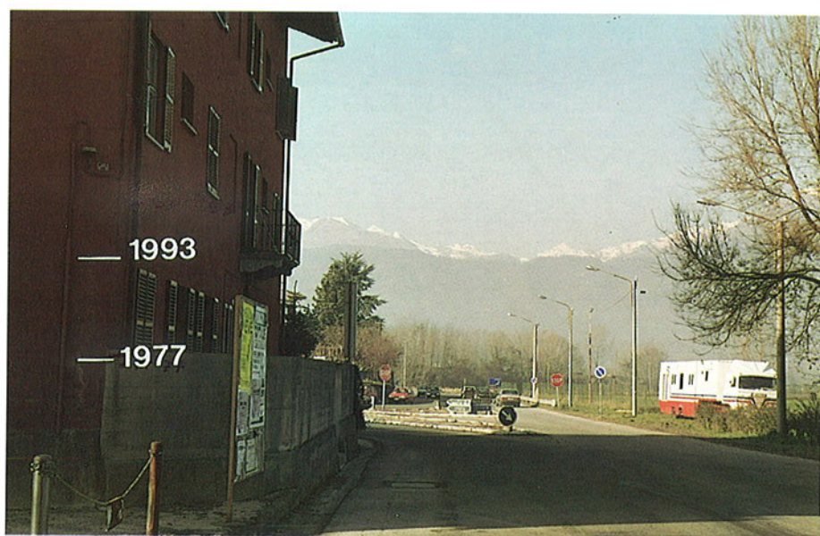
FOTO 22 - Banchette (TO): altezze delle acque di inondazione durante gli eventi del 1977 e del 1993.
