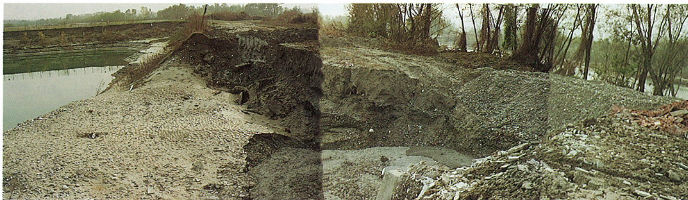
FOTO 21 - Particolare del punto B della Foto 20.
