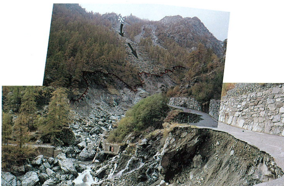
FOTO 40 - Valprato, zona Madonna della Neve a monte della frazione Pianetto. In primo piano un tratto di strada asportato unitamente al ponte (la cui posizione è tracciata con asterischi). In secondo piano l'ampia frana innescata dall'erosione in isponda destra, al piede di un'ampia deformazione gravitativa profonda. Le frecce nere indicano un canalone soggetto a fenomeni di crollo.
