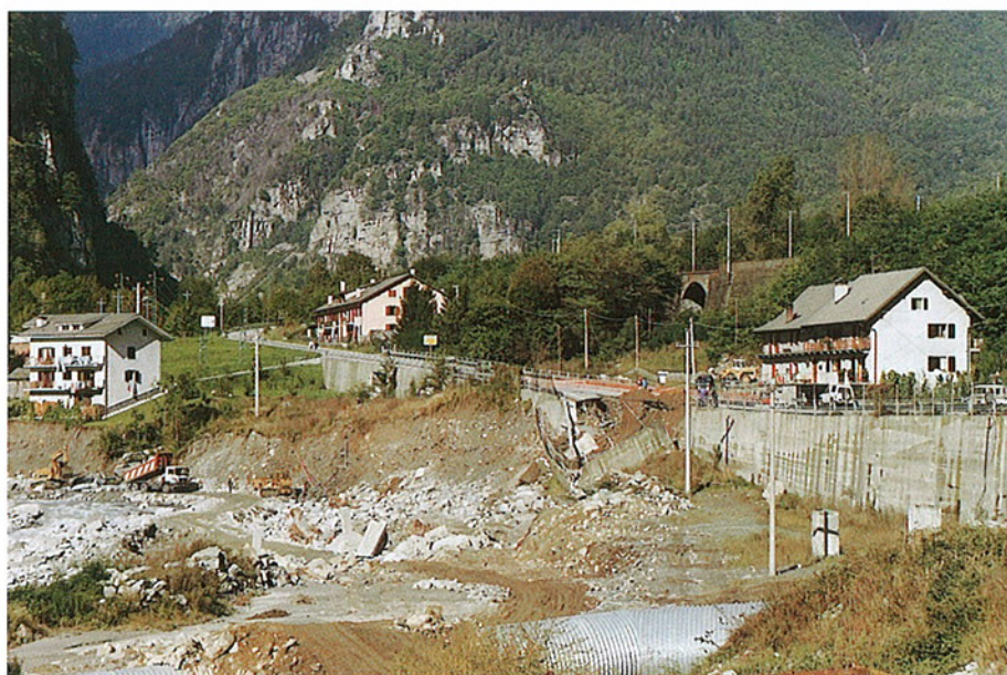
FOTO 2 - Varzo (VB), località Spagna. L'attività erosiva ha distrutto la scogliera esistente e le infrastrutture retrostanti (impianti fognari, traliccio ENEL) sino ad abbattere il piano di sostegno dell'ampliamento della Strada Statale 33 (al centro). Sulla sinistra l'erosione della scarpata minaccia l'abitazione.
