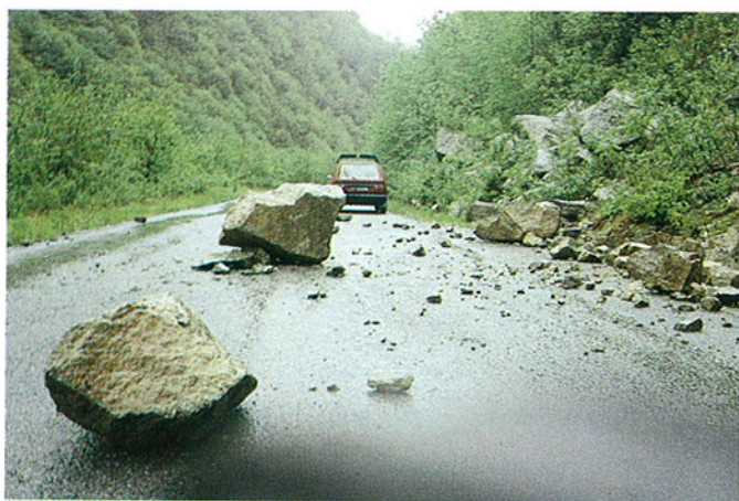
Fig. 31. La pericolosità della caduta di masse rocciose di limitate dimensioni è connessa in tal caso all'esistenza di una strada che si sviluppa immediatamente a ridosso di una parete rocciosa instabile ed alla mancanza di adeguate opere di protezione.
