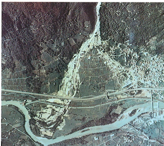
Fig. 4. La conoide del Torrente Renancio, presso Quincinetto, nella bassa Valle d'Aosta; si nota l'alluvionamento prodotto dal violento fenomeno di trasporto in massa verificatosi il 22 settembre 1981. (Fot. Alifoto).
