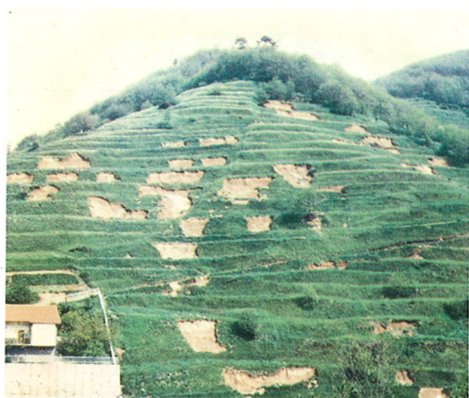
Fig. 41, 41 bis. La foto e la figura pongono in evidenza alcuni fenomeni franosi che si sono innescati, durante eventi piovosi particolarmente intensi, per saturazione e successiva fluidificazione dei terreni superficiali. I motivi morfologici caratteristici delle due zone hanno fortemente condizionato lo sviluppo dei dissesti. I movimenti si sono verificati infatti lungo le scarpate di terrazzi (artificiali e naturali) le cui superfici superiori, piane, hanno certamente favorito la concentrazione e la penetrazione nel terreno di elevate quantità d'acqua.
