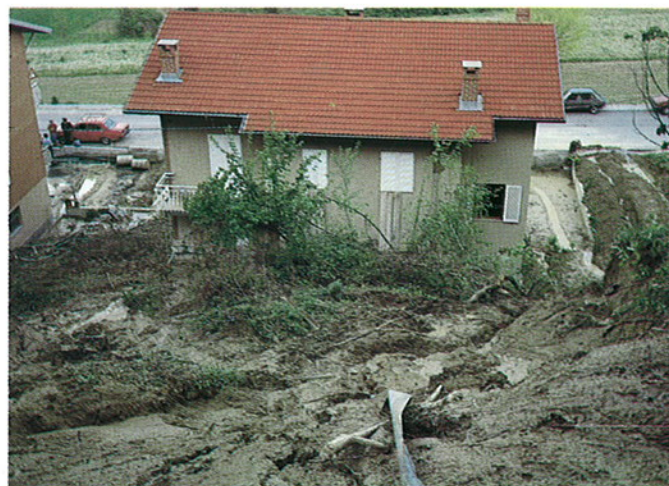
Fig. 40, 40 bis. Nella foto e nella figura sono illustrate due situazioni connesse a fenomeni franosi per fluidificazione dei terreni superficiali che si sono verificati lungo avvallamenti o deboli depressioni del pendio provocando seri danni agli edifici ivi presenti.
