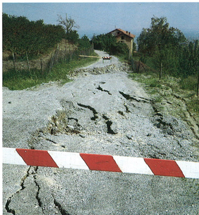
Fig. 35 bis. Limitato ma significativo esempio di frana composta con meccanismi combinati per movimenti di tipo rotazionale passanti a colata.
