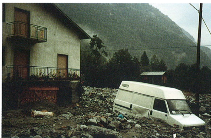
Fig. 43. Danni ad un centro abitato provocati dalla violenta attività torrentizia in conoide. Si notino le dimensioni dei materiali trasportati e depositati durante l'episodio di piena.
