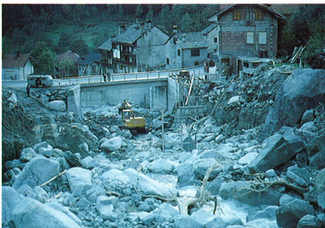
Fig. 53. Danni ai centri abitati: l'aspetto di un corso d'acqua minore successivamente ad un evento alluvionale.
