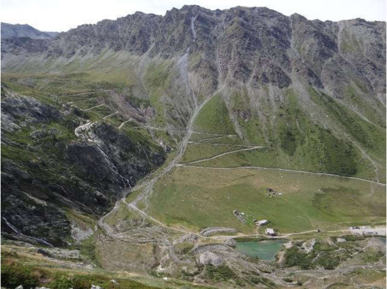
Figura 31. Vista d'insieme del versante settentrionale del Gran Becco interessato dal fenomeno di crollo del 10 agosto 2019. Visibile la zona di distacco e transito, il conoide di accumulo alla base del canalone, la strada di accesso al Colle Sommeiller e gli edifici sul fondovalle raggiunti dai blocchi (l'edificio vicino al lago è il rifugio CAI Scarfiotti).
