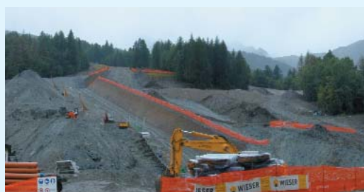
Figura 1.15 - Cantiere pista Half Pipe
