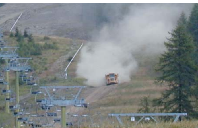
Figura 1.3 - Polverosità determinata dai mezzi di cantiere
