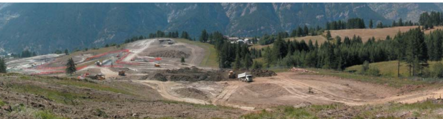
Figura 1.1 - Cantiere pista Bob
