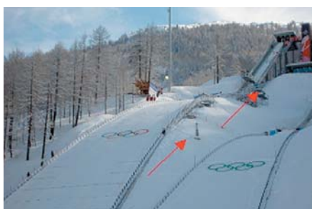
Figura 2.54 - Anemometri sonici installati lungo la dorsale tra i due trampolini
