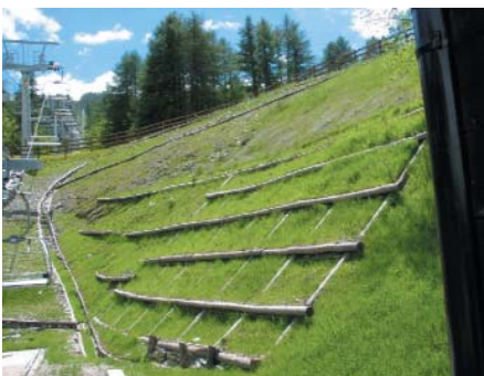
Figura 1.19 - Intervento di ripristino
