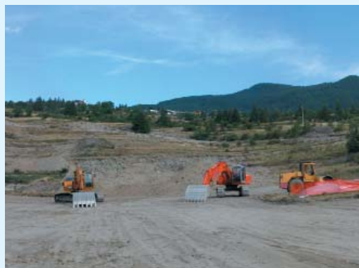
Figura 1.11 - Primi scavi al cantiere per la pista Freestyle
