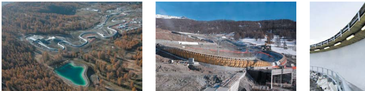
Figura 5.2 - Impianto sportivo di Cesana Pariol per gare di bob, slittino e skeleton
