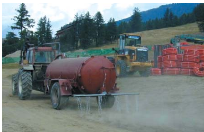
Figura 1.4 - Interventi di mitigazione della polverosità a Sansicario
