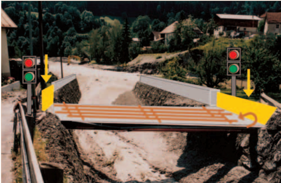
Figure 4.1.1.A/1.9 Traffic light regulation at Pians. Figur 4.1.1.A/1.9 Verkehr-Management durch Ampel in Pians. Figura 4.1.1.A/1.9 Regolazione del traffico con l'ausilio di un semaforo a Pians.
