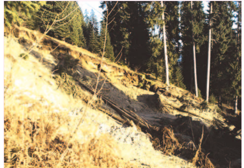
Figure 3.1.2.B/4.2 Incipient crack of a shallow landslide in the Schlans/Trun region. Figur 3.1.2.B/4.2 Anriss einer flachgründigen Rutschung im Gebiet Schlans/Trun. Figura 3.1.2.B/4.2 Frattura incipiente di una frana superficiale nella regione di Schlans/Trun.
