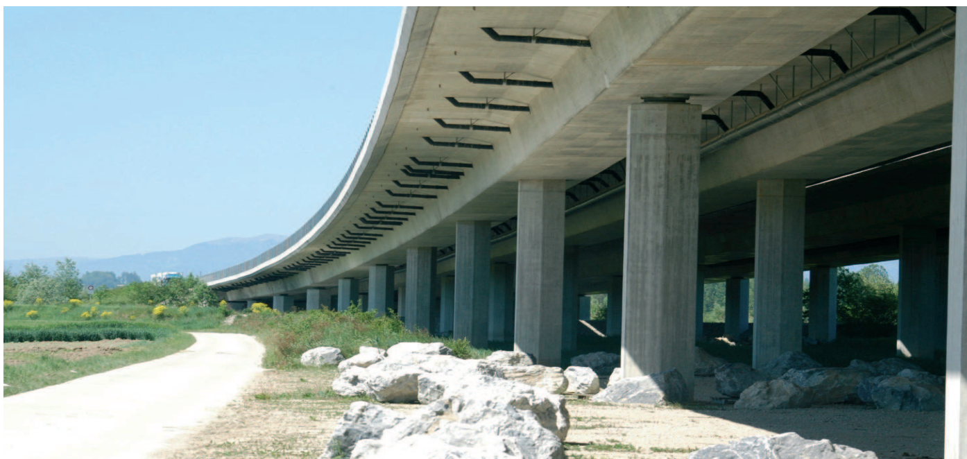
Fig. 27 - Allungamento del ponte sul fiume Broye a scopo di mantenimento di un importante corridoio ecologico (zona di confluenza di due corsi d'acqua di importanza regionale). Si noti la disposizione di file di cumuli di massi sotto il ponte per favorire il passaggio di microfauna
