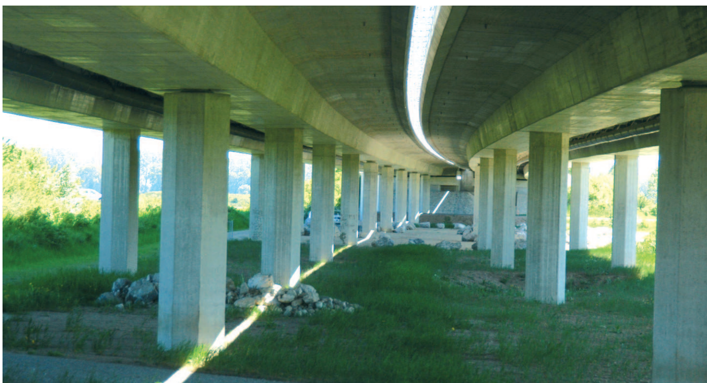
Fig. 28 - Particolare della sistemazione sotto il ponte per favorire il passaggio della microfauna
