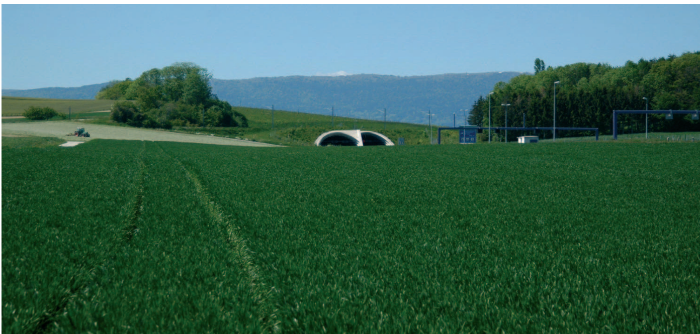
Fig. 15 - Copertura a galleria artificiale di tratto previsto in trincea per consentire la continuità degli spostamenti faunistici da una grossa compagine forestale sulla sinistra (non visibile nella foto. ndr) e la zona lago sulla destra
