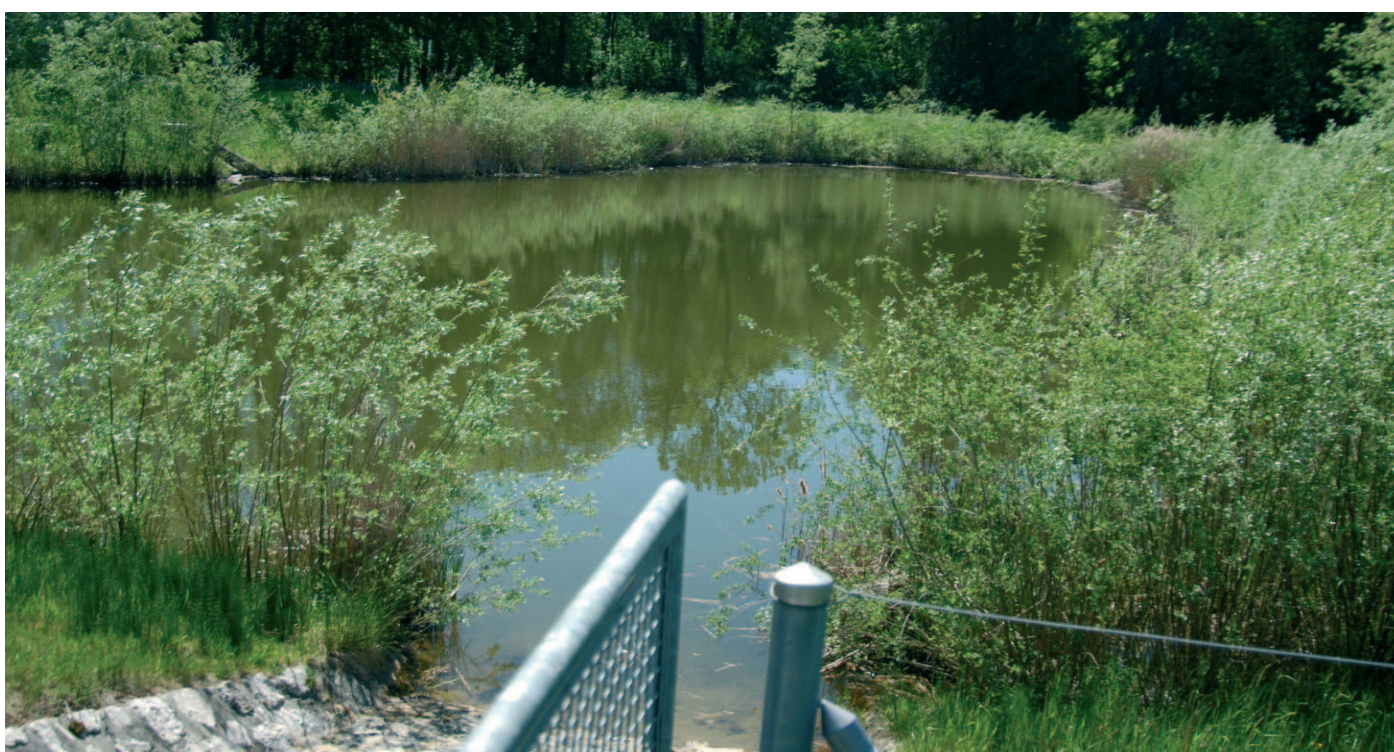
Fig. 20 - Particolare delle sponde rinaturalizzate di un bacino di trattamento delle acque di piattaforma
