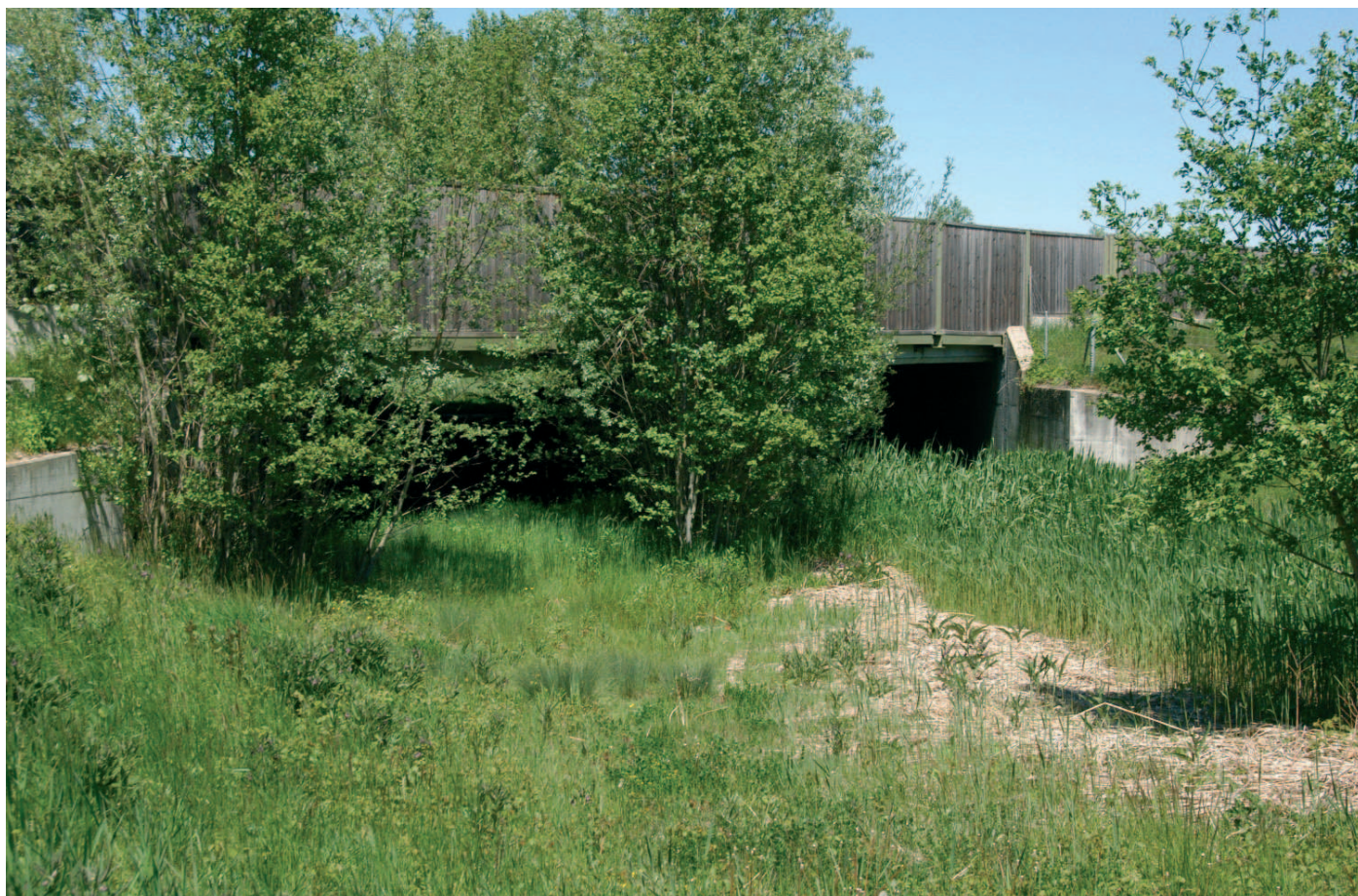
Fig. 23 – Imbocco del sottopasso. Si notino la vegetazione a canneto nella depressione creata a monte dell'imbocco, la disposizione di barriere acustiche in legno per non disturbare gli animali in transito e la disposizione di arbusti al piede del rilevato autostradale per favorire l'avvicinamento degli animali all'imbocco
