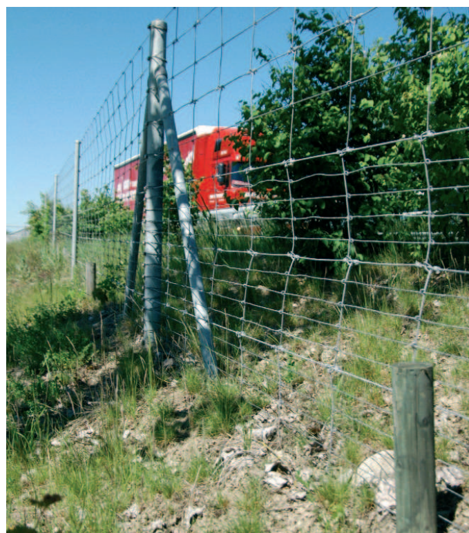
Fig. 16 - Particolare della recinzione antiscafcamento ungulati con maglia fitta in basso per la microfauna e con maglia larga nella porzione superiore.
