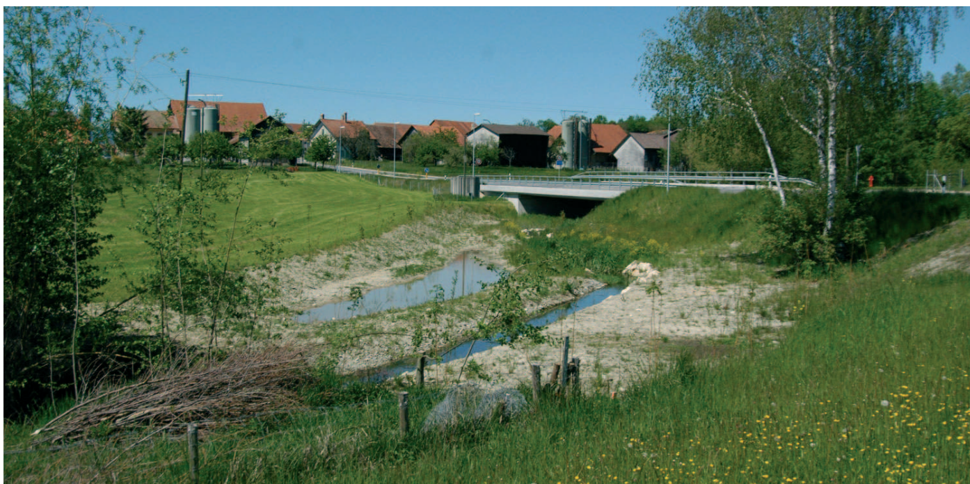
Fig. 19 - Rinaturalizzazione del rio con espansione golenale in prossimità dell'allargamento a scopo faunistico di uno scatolare idraulico preesistente su una strada della rete locale
