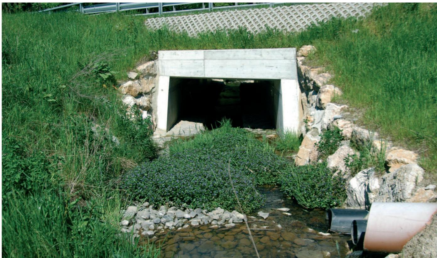
Fig. 14 - Particolare rinaturalizzazione del rio nel punto dello scarico del bacino di trattamento e sottopasso idraulico attrezzato per il passaggio della fauna (si notino le due banchine laterali a lato del rio)
