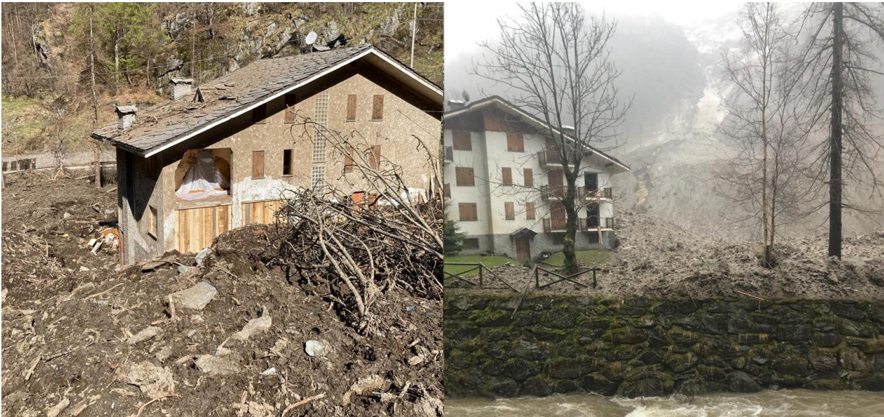
Figura 26: due foto del condominio danneggiato dalla valanga di "Fontanetta", Nella Foto di sinistra del 23 aprile sono visibili i danni sul lato posteriore della struttura, inoltre è ben visibile la grande componente detritica inglobata dalla massa nevosa, meno apprezzabile perché già fusa in superficie, Sulla destra un'immagine dello stesso condominio la mattina di giovedì 17 aprile, (Foto Arpa Piemonte)
