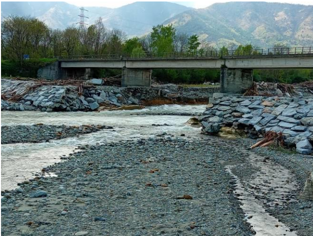
Figura 41 - Asportazione della soglia del ponte di Villanova, con dettaglio dei fenomeni erosivi in corrispondenza di uno dei piloni in alveo,
