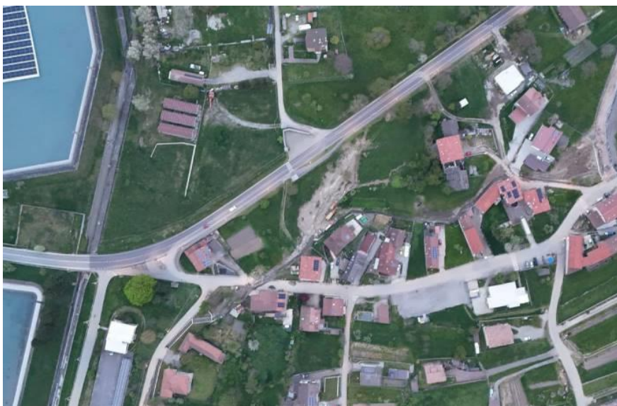
Figura 37 – Venaus, colamento di materiale detritico innescatosi a valle della SS 25 e che ha raggiunto l'abitato di Venaus. Segnalazioni e foto di Gabriele Savio,
