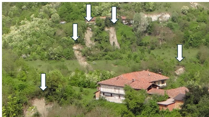
Figura 6 – Alcuni fenomeni di dissesto rilevati durante i sopralluoghi speditivi condotti sulla collina torinese. In alto, è visibile uno scivolamento planare localizzato in località Maroero, nel Comune di Cocconato d'Asti. Al centro, una frana di tipo soil slide lungo la SP 71 tra Casalborgone e Lauriano. In basso, si evidenzia una serie di colamenti rapidi nel settore collinare prospiciente l'abitato di Tonengo.
