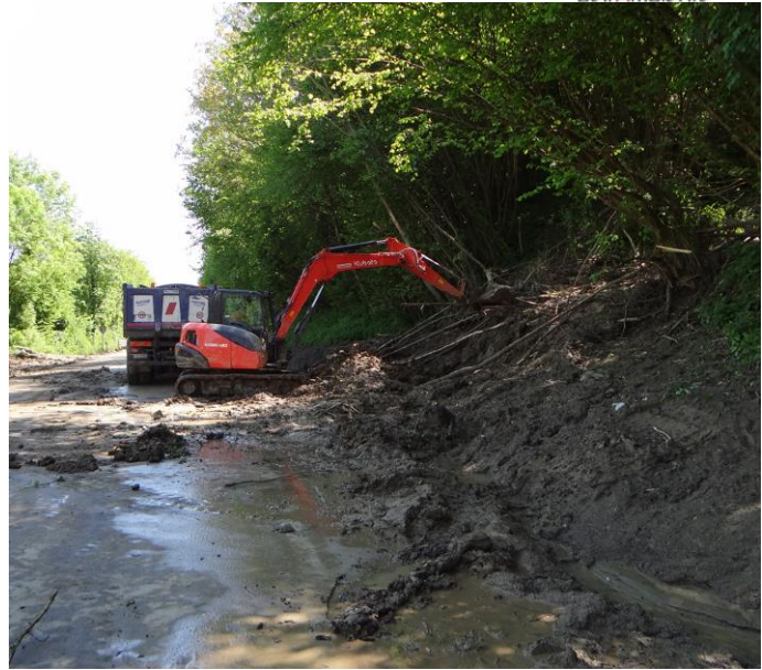
Figura 45 – La SP 590 della Val Cerrina è stata interessata in più punti da fenomeni franosi, Il materiale si è propagato verso valle, danneggiando in alcuni tratti i guardrail e depositando ingenti quantità di materiale in corrispondenza e a valle della sede stradale. Le immagini riguardano i tratti in corrispondenza della deviazione per la località Delfino (foto di sinistra) e il tratto di Castagneto Po, tra loc Baraccone e deviazione per Chivasso (foto a destra).
