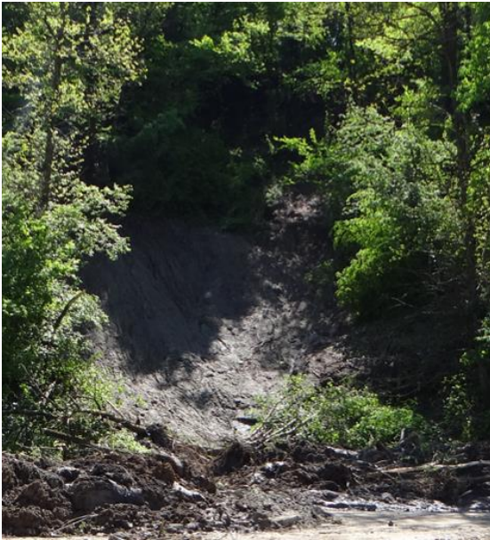
Figura 45 – La SP 590 della Val Cerrina è stata interessata in più punti da fenomeni franosi, Il materiale si è propagato verso valle, danneggiando in alcuni tratti i guardrail e depositando ingenti quantità di materiale in corrispondenza e a valle della sede stradale. Le immagini riguardano i tratti in corrispondenza della deviazione per la località Delfino (foto di sinistra) e il tratto di Castagneto Po, tra loc Baraccone e deviazione per Chivasso (foto a destra).
