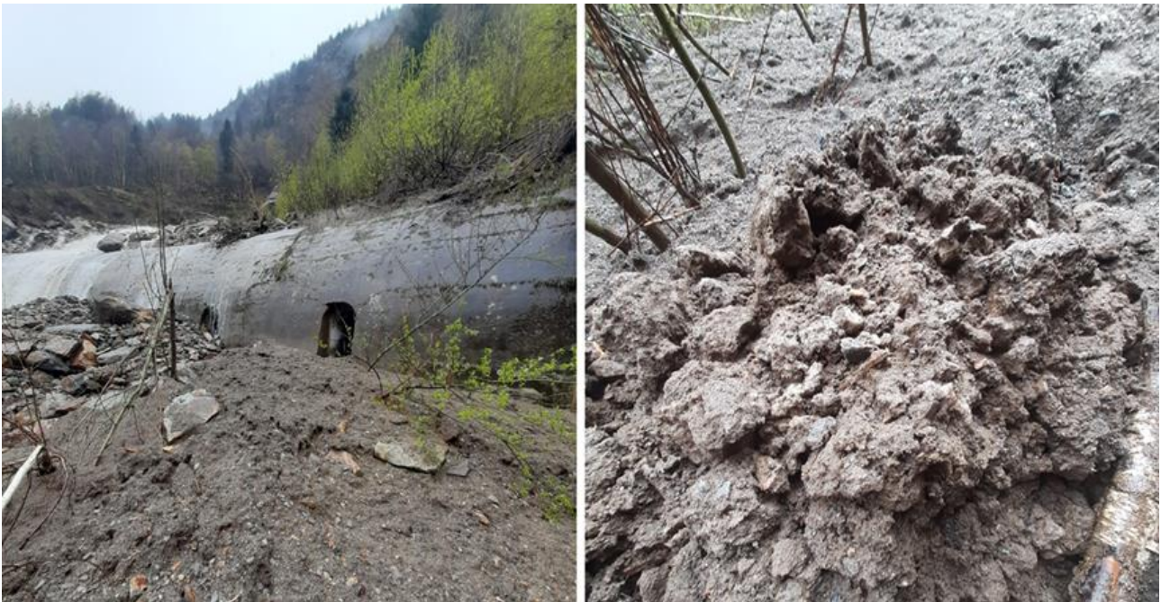
Figura 24: accumulo della valanga mista a detrito che ha interessato il paravalanghe sulla statale che porta a Macugnaga, Sulla destra un particolare dell'accumulo dove è ancora ben visibile la parte nevosa mista a detrito, (Foto CLV valle Anzasca)
