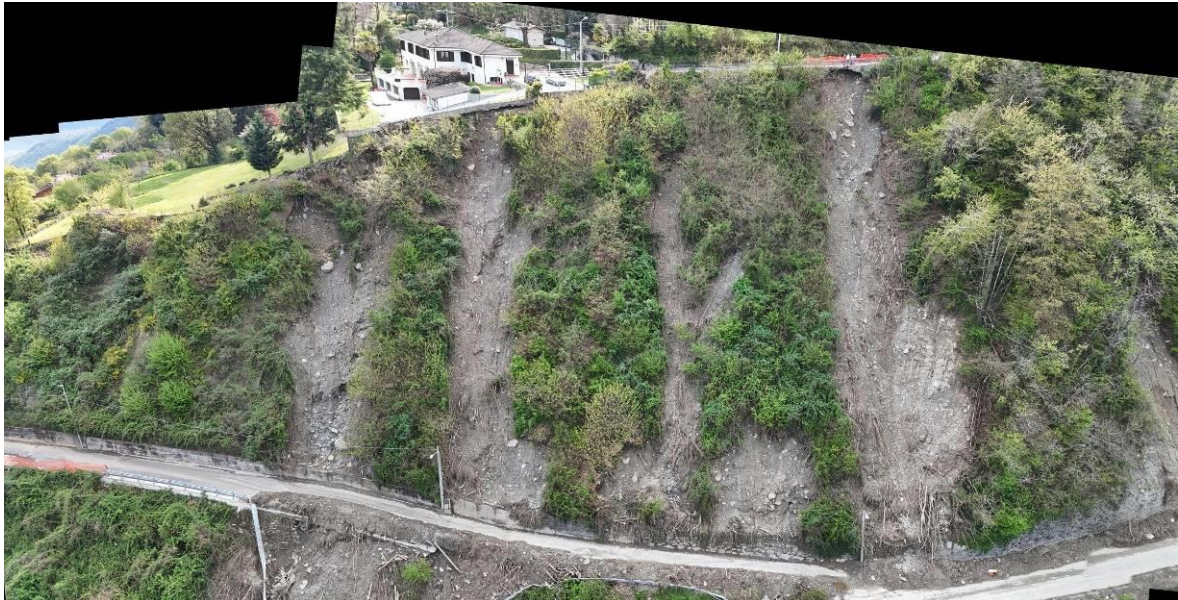
Figura 36 – Frane di colamento superficiale che hanno coinvolto la SP197 (Foto: dott. Paolo Baggio)
