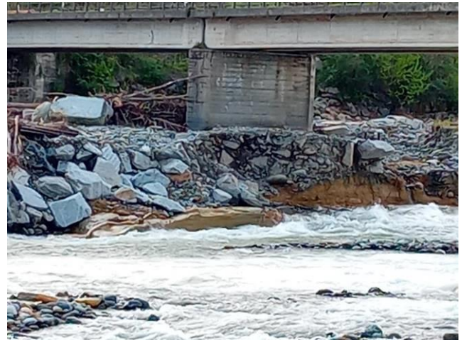
Figura 41 - Asportazione della soglia del ponte di Villanova, con dettaglio dei fenomeni erosivi in corrispondenza di uno dei piloni in alveo,
