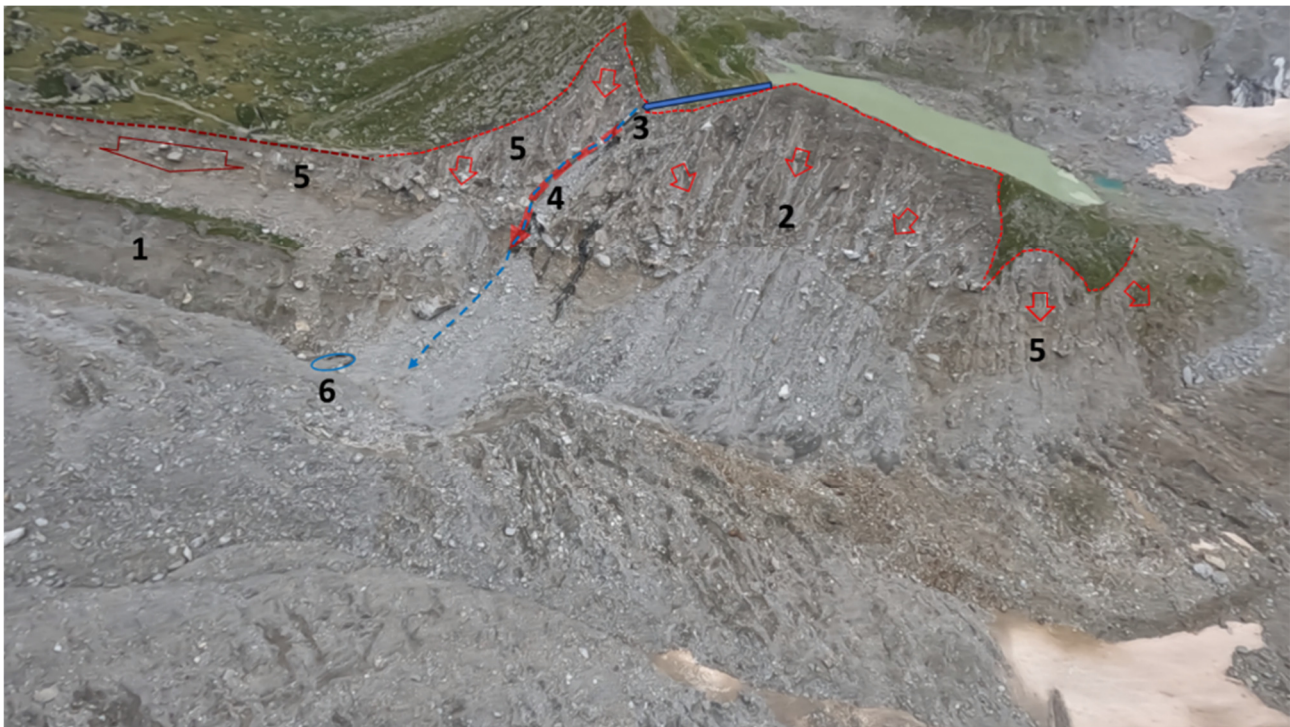
Figura 65 – Processi di instabilità in atto all'intersezione tra la morena del Belvedere e la morena delle Locce:
