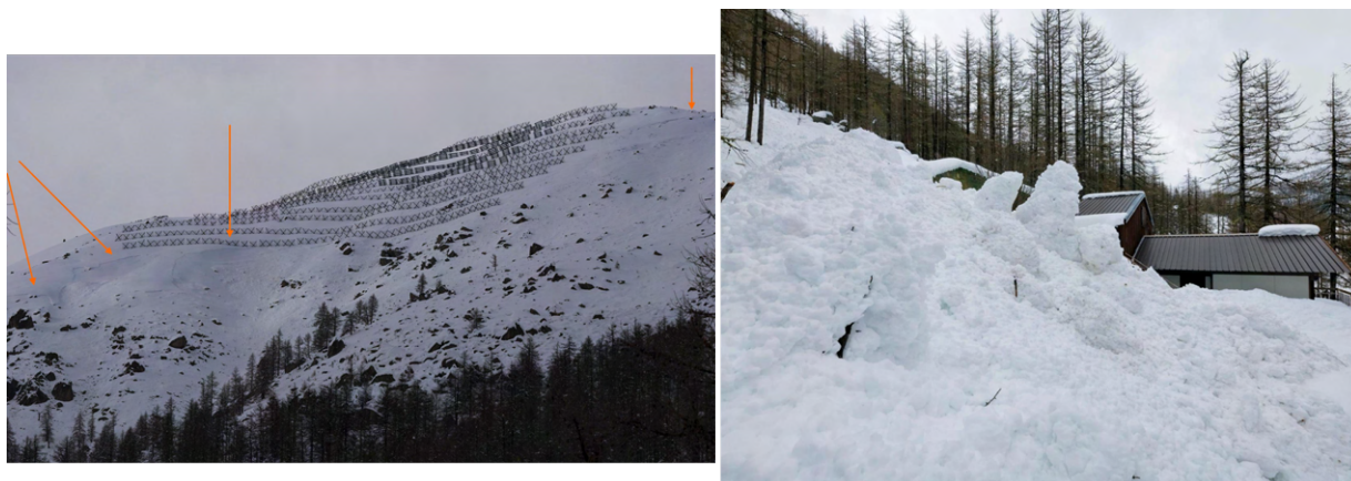
Figura 4.11: A sinistra le frecce arancioni indicano i numerosi distacchi nei pressi degli ombrelli ferma-neve sopra alla Borgata Capoluogo, zona cimitero - Valle Orco, comune di Ceresole Reale (Foto del 28/02 Parco Naturale Gran Paradiso). A destra Un distacco ha lambito due chalet nella frazione di Borgiallo - Valle Orco, comune di Ceresole Reale (Foto del 28/02, Parco Naturale Gran Paradiso)
