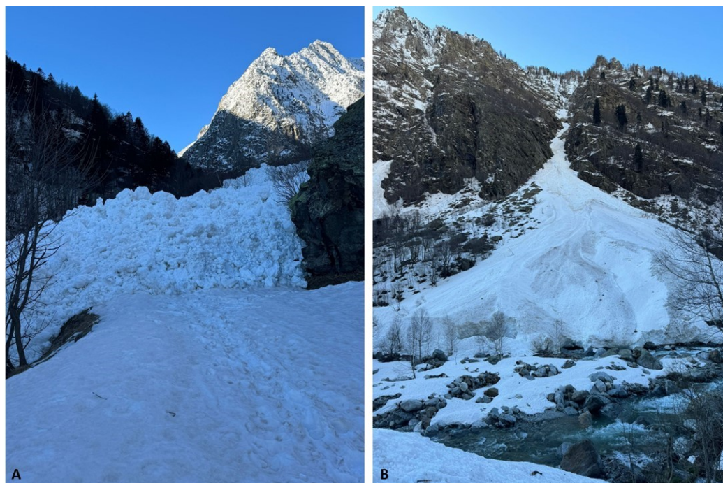
Figura 4.39: Nella foto di destra l'accumulo di una valanga scesa in sinistra orografica che ha raggiunto la strada per le Terme di Valdieri (CN), nella foto di sinistra si vede l'accumulo di una valanga scesa in destra orografica nel tratto tra Tetti Gaina e Terme di Valdieri (CN). Foto di Marco Ghibaudo
