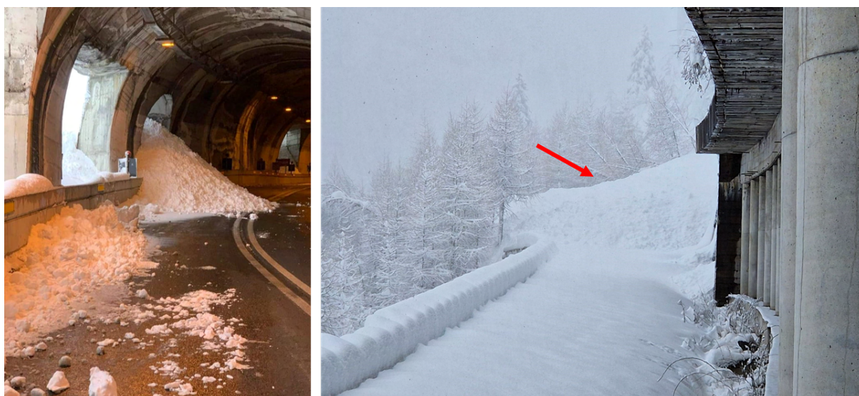
Figura 4.23: Accumulo della valanga di “Balme Fiorant” (codice SIVA 31 E TO) vista da dentro (a sinistra) e da fuori (a destra) della galleria paravalanghe (foto del Parco Nazionale del Gran Paradiso)
