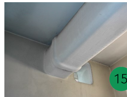
11 Pannelli in cemento-amianto con funzione di frangisole
