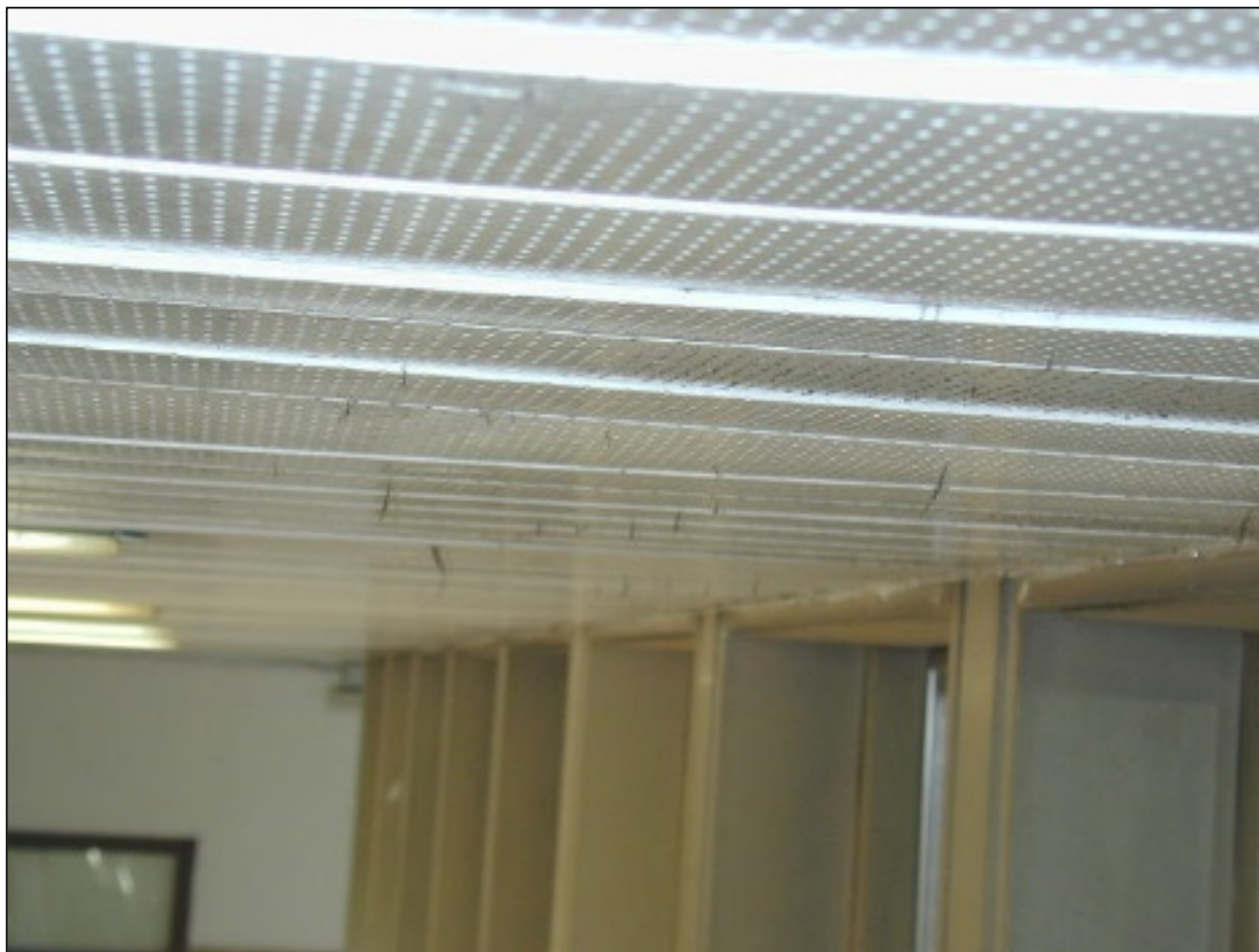
Controsoffitto in doghe forate con materassini in lana minerale posti sopra
