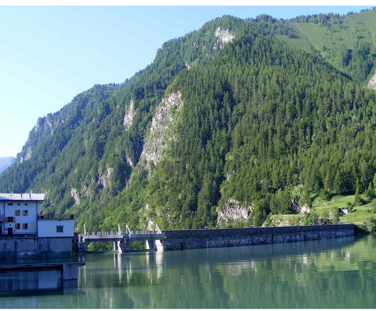
Diga di Castello – Pontechianale (CN)
