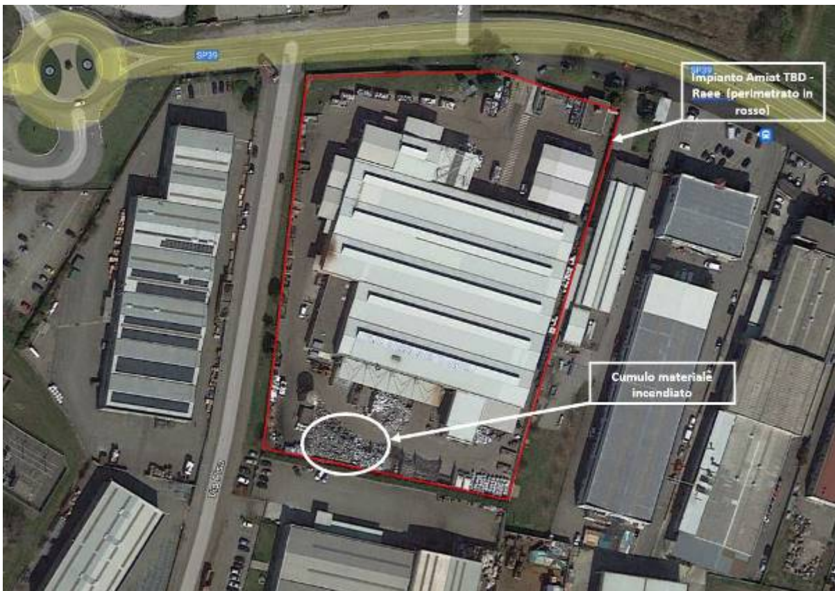
Figura 1: inquadramento dell'area e posizionamento del cumulo coinvolto nell'incendio
