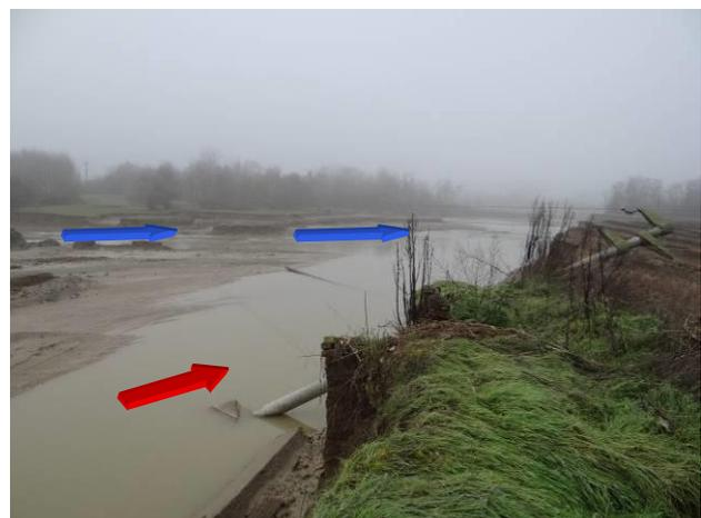
Figura 67. A sinistra erosione regressiva del paleo canale per svuotamento, a destra sullo sfondo canale di erosione apertosi a seguito della tracimazione delle acque del lago.
