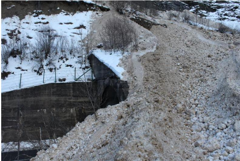
Figura 52 Opere di difesa passiva sommerse dal deposito della valanga sulla SS21 in Valle Stura tra l'abitato di Pianche e Sambuco (CN) sopralluogo del 26.11.2019.
