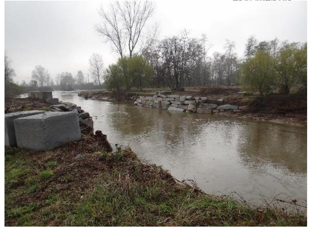
*Figura 78. Comune di None: meandro nei pressi di San Ponzio con tracce di sormonto delle acque; a destra le spalle de la passerella divelta dalla piena di ottobre 2019.*
