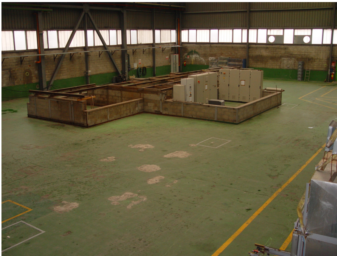
Figura 1: L'interno del capannone dove era installato l'impianto di decontaminazione ora smontato.
