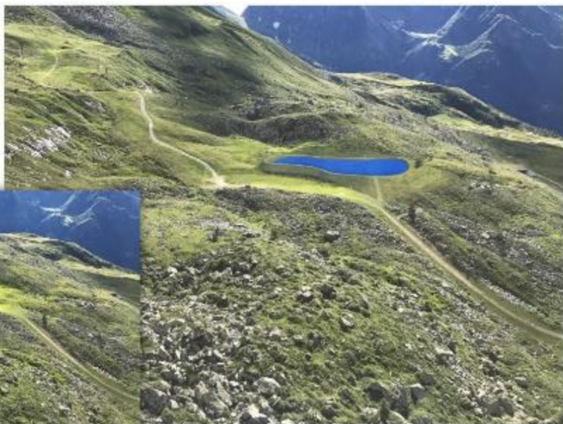
Bacino Mullero in corso di realizzazione
