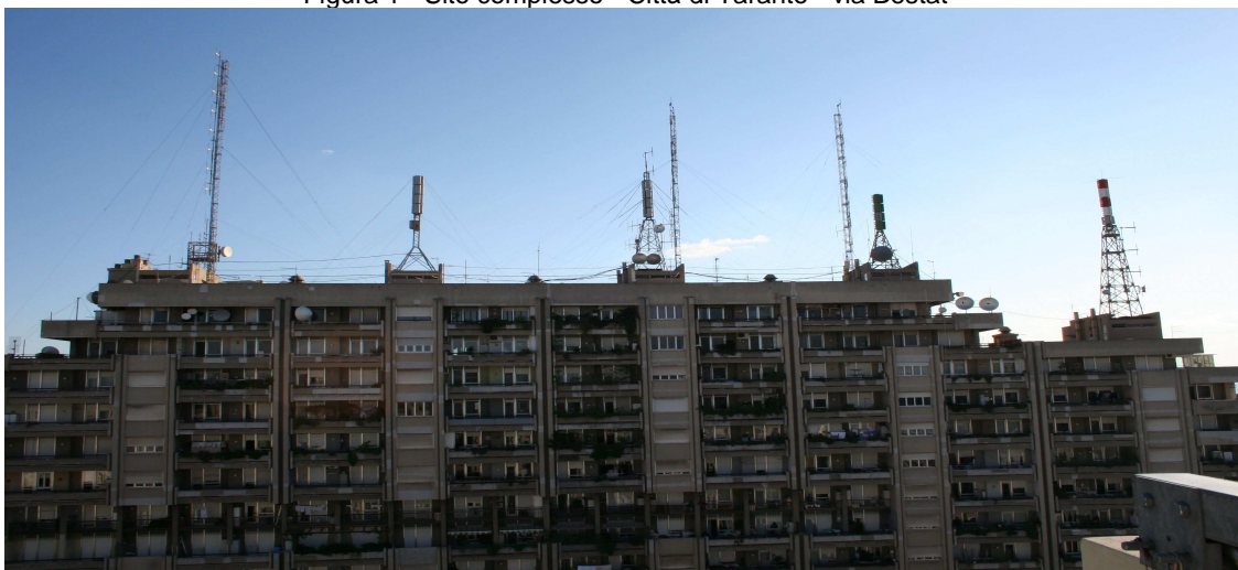
Figura 1 - Sito complesso - Città di Taranto - via Bestat
