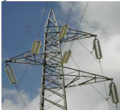
Testa del sostegno A dopo la compattazione
