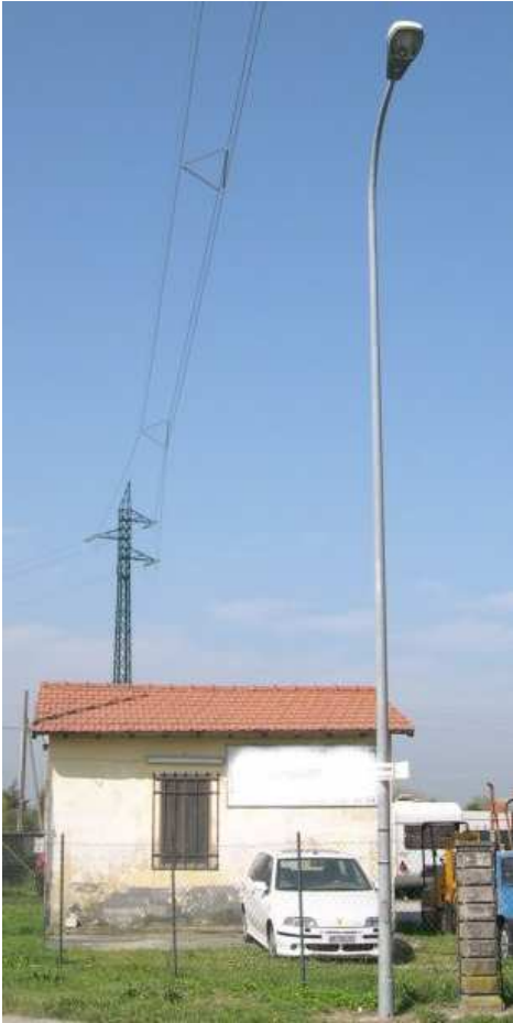
Figura 6 – Esempi di campate con conduttori compattati mediante distanziatori
