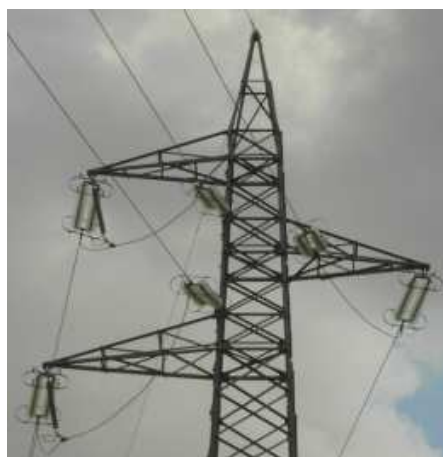
Testa del sostegno B dopo la compattazione
