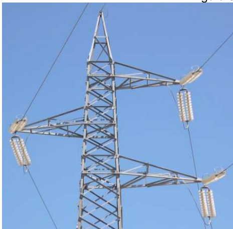
Testa del sostegno A prima della compattazione
