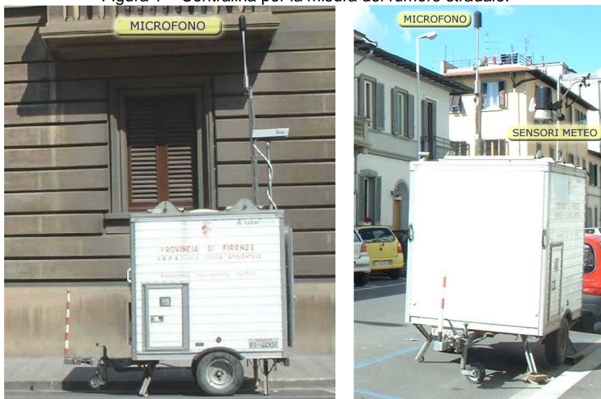
Figura 1 – Centralina per la misura del rumore stradale.
